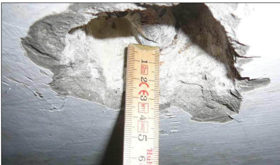
Obrázek 16 – krytí podélné výztuže 30 mm
