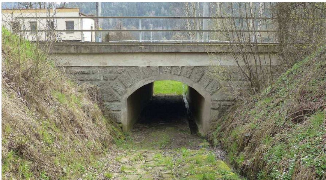
kamenný klenbový most v km 3,523
