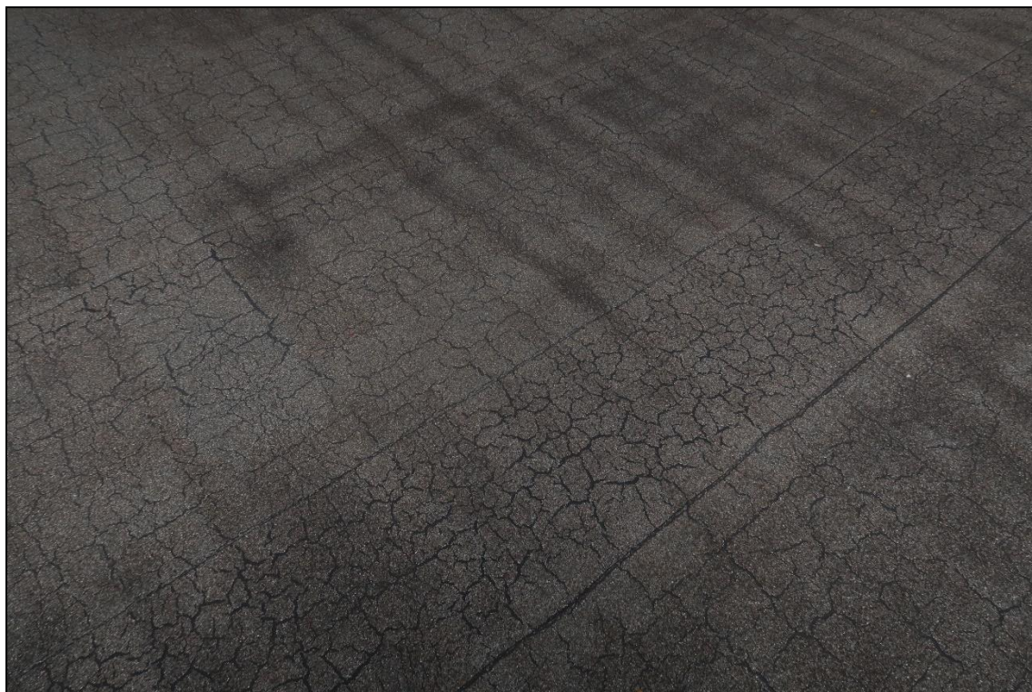
Foto 64: Pohled na střešní rovinu, stav hydroizolačního souvrství není dobrý, hydroizolace postupně degraduje, zpuchřelý povrch - detail
