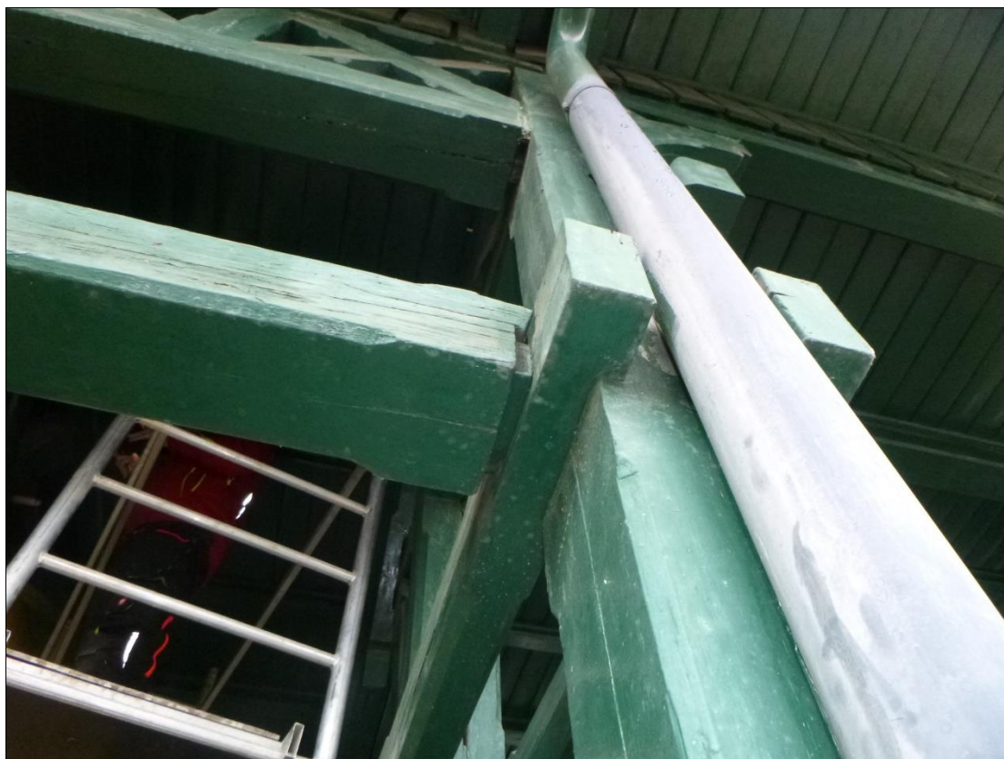
Foto 22: Vnější plná vazba G-H - rozestoupení spojů
