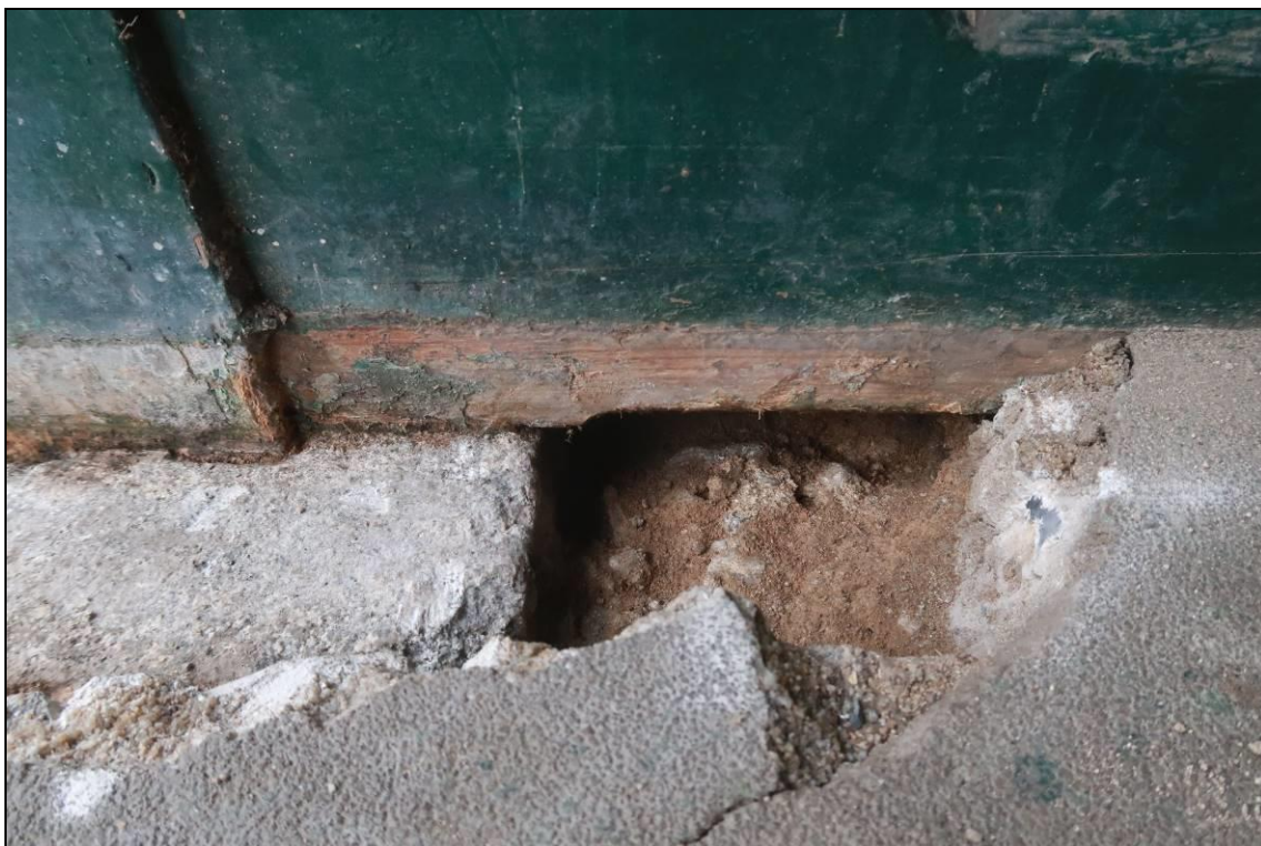
Foto 41: Pohled na vzpěru mezi sloupy v sondě 2, vzpěra byla částečně podkopána, pod terénem je dřevo vlhké
