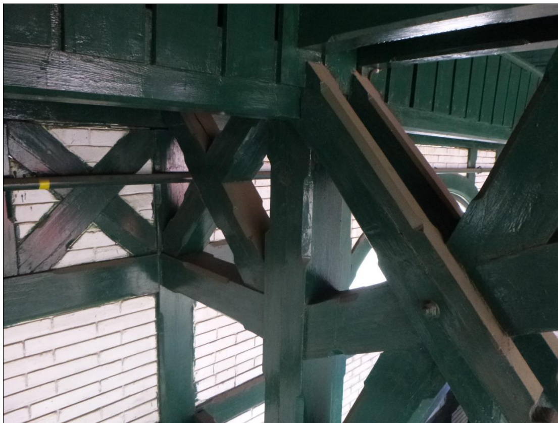
Foto 6: vnitřní plná vazba A-B – bez poškození
