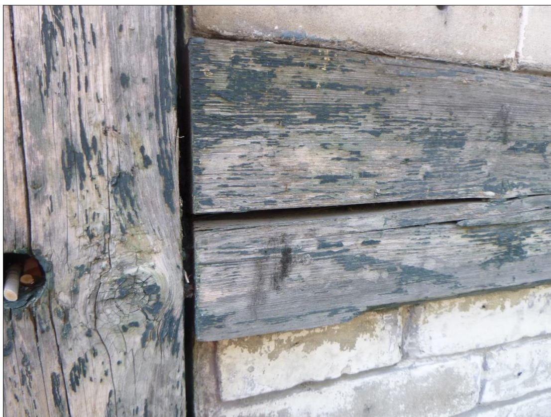
Foto 42: Severní strana – vodorovná výsušná spára (detail)
