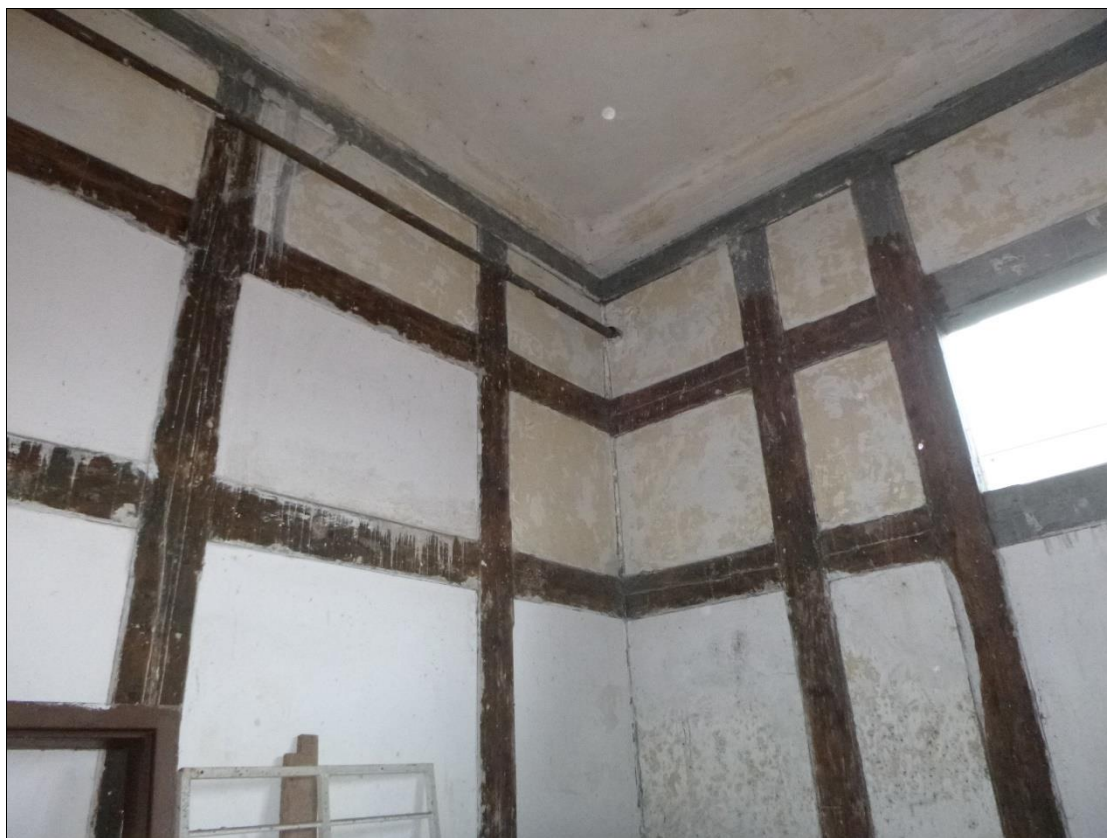
Foto 33: Interiér zděné části – místy bez nátěru, především ve spodních částech přítomny rozsáhlé výměny dřeva
