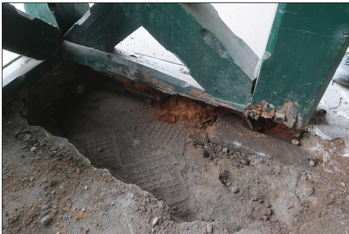
Foto 27: Fotografie po odstranění svrchní vrstvy asfaltového krytu a betonu, v hloubce cca 80-100 mm je otisk původní dlažby
