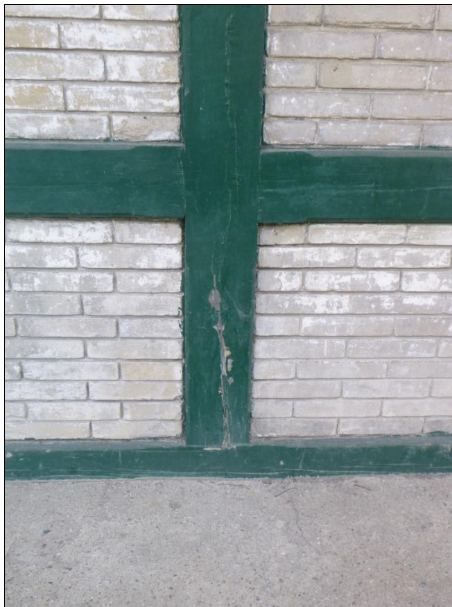
Foto 51: Svislá výsušná trhлина nevhodně opravená, částečně zaplněná
