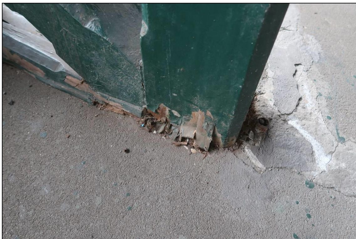
Foto 25: Detail paty sloupu v místě kopané sondy 1, sloup na úrovni terénu vykazuje znaky degradace
