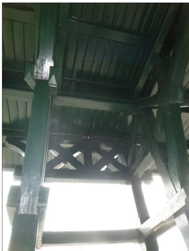
Foto 12: Vnější plná vazba C-D – bez poškození
