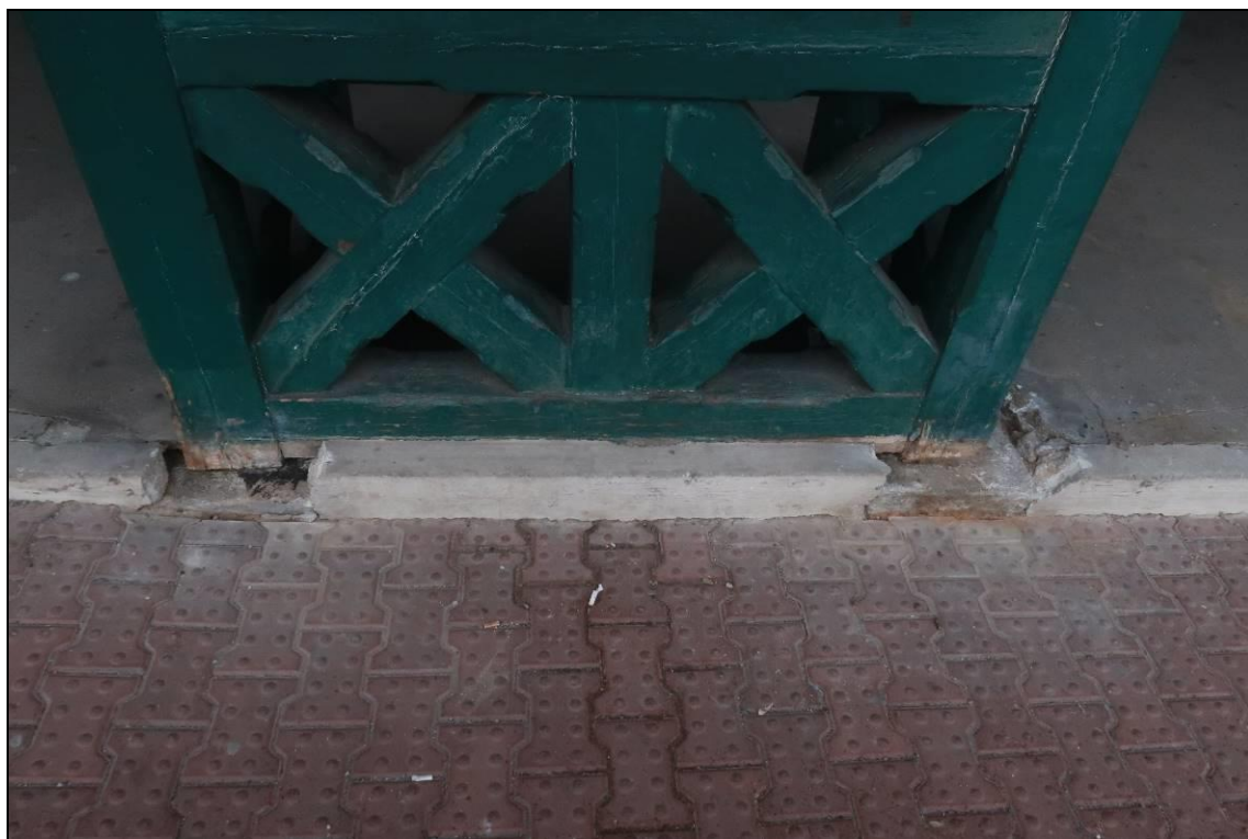
Foto 38: Pohled na provedenou sondu 2, obnaženy dvě paty sloupů směrem ke koleji
