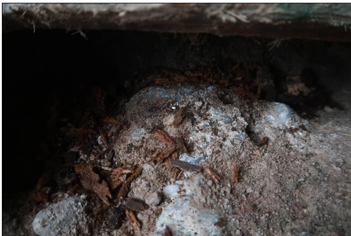
Foto 43: Vydrolené kusy dřeva ze spodního líce vzpěry, dle změny barvy se jedná o napadení dřevokaznou houbou, intenzitu napadení nelze bez vizuálního hodnocení stanovit, dle kvalifikovaného odhadu pokročilá
