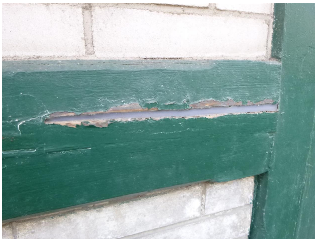
Foto 60: Vodorovná výsušná trhlina – nevhodná oprava (zaplnění pružným tmelem) detail
