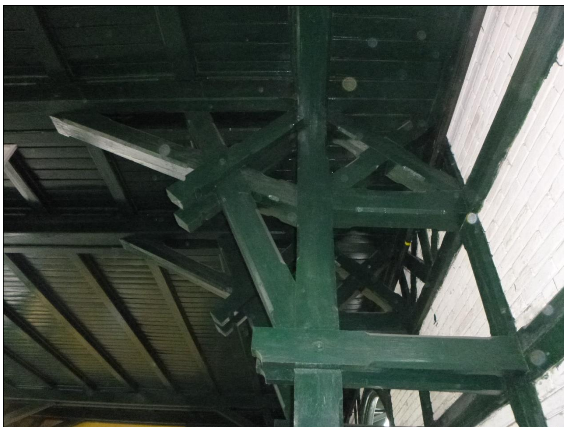
Foto 20: Vnitřní plná vazba E-F – bez poškození
