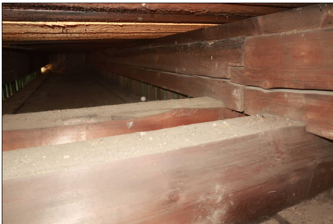
Foto 6: Pohled do sondy S1, dřevo suché, bez viditelného poškození H či DH
