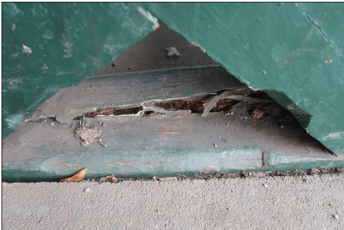
Foto 26: Detail vzpěry mezi sloupy v místě kopané sondy 1, vzpěra je prasklá, dřevo duté, pravděpodobně degradované D a DH
