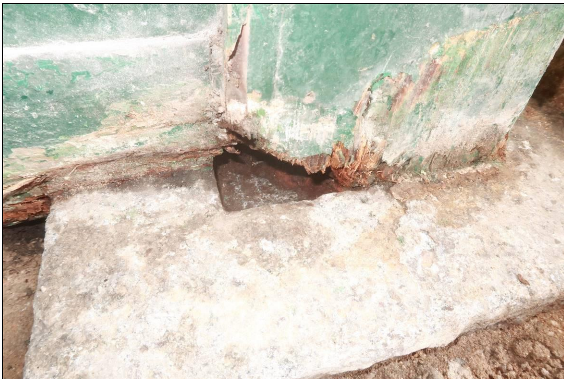
Foto 34: Pohled na patu sloupu z přecházející fotografie, pata sloupu je opět narušena, významně je tak oslabena plocha průřezu
