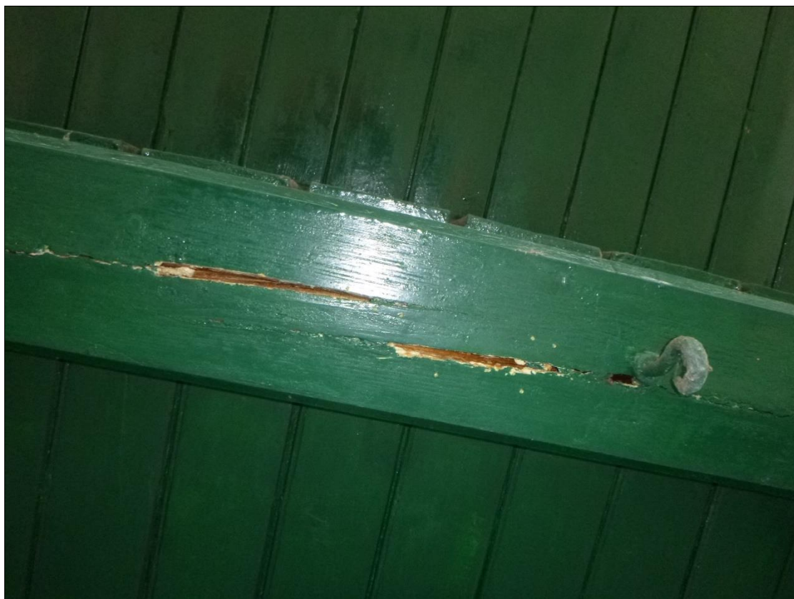
Foto 8: Výsušná trhлина mezi vazbami B-C v detailu (až 20 mm)
