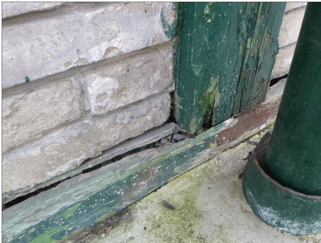
Foto 55: Zatékání do vazného trámu (detail), trám zcela rozpadlý cca 1,5 m
