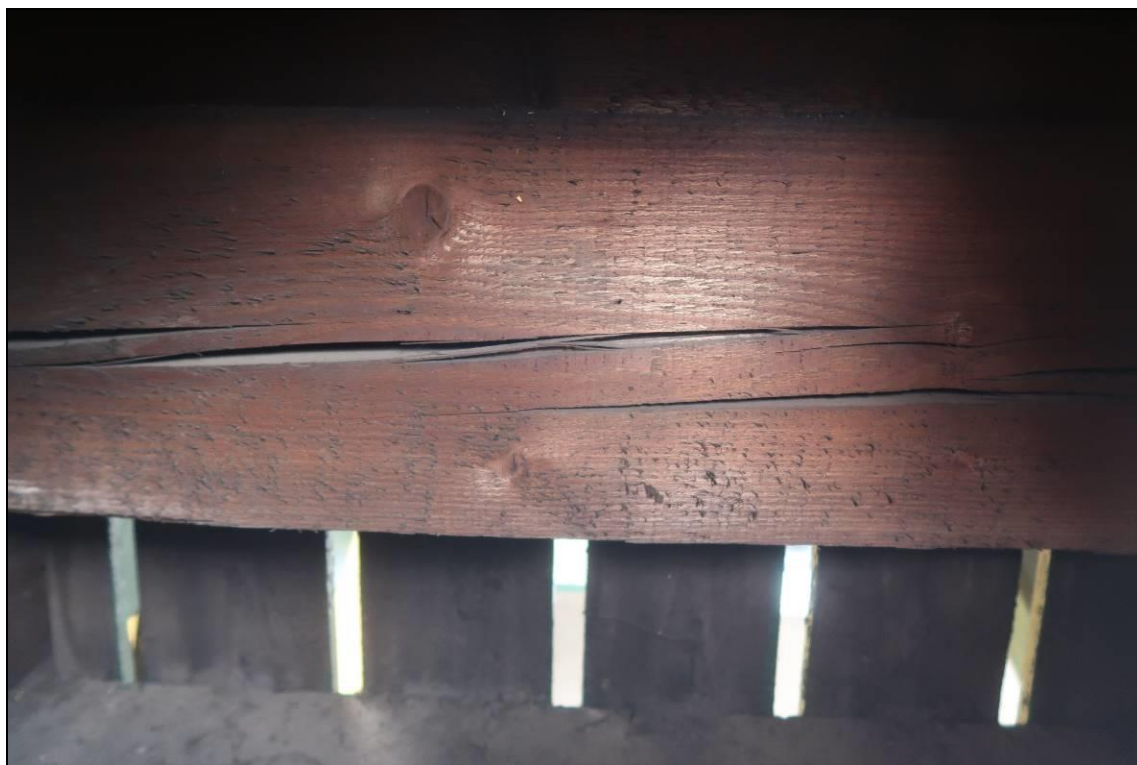
Foto 5: Pohled do sondy S1, dřevo suché, mírné známky začouzení dřeva, bez viditelného poškození H či DH
