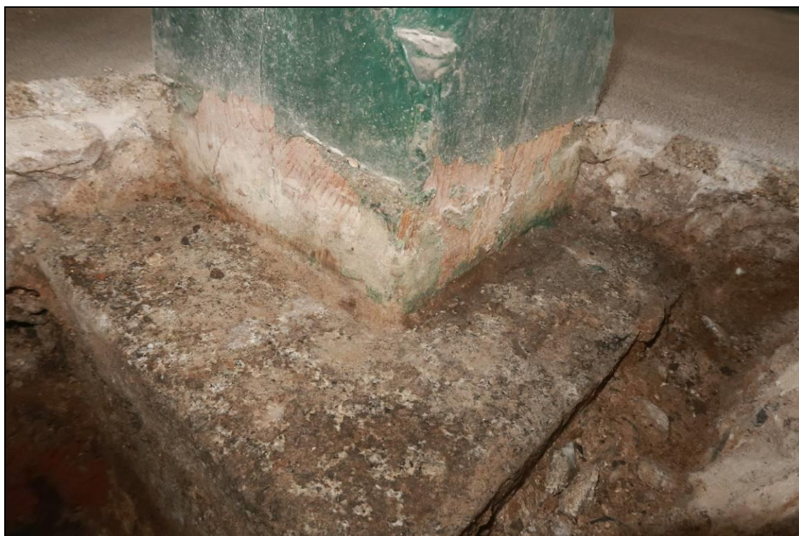
Foto 45: Pohled na sondu 3 provedenou v patě vnitřního sloupu – detail, pata sloupu bez degradace, rozhraní mezi kamennou patkou a dřevěným sloupem je však vlhké, detail není vhodný
