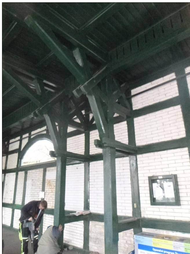
Foto 13: Vnitřní plná vazba C-D – sonda založení počáteční poškození vlivem vlhkosti
