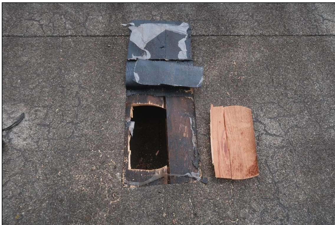
Foto 14: Pohled na provedenou sondu S3 po otevření hydroizolační vrstvy a dřevěného záklopu
