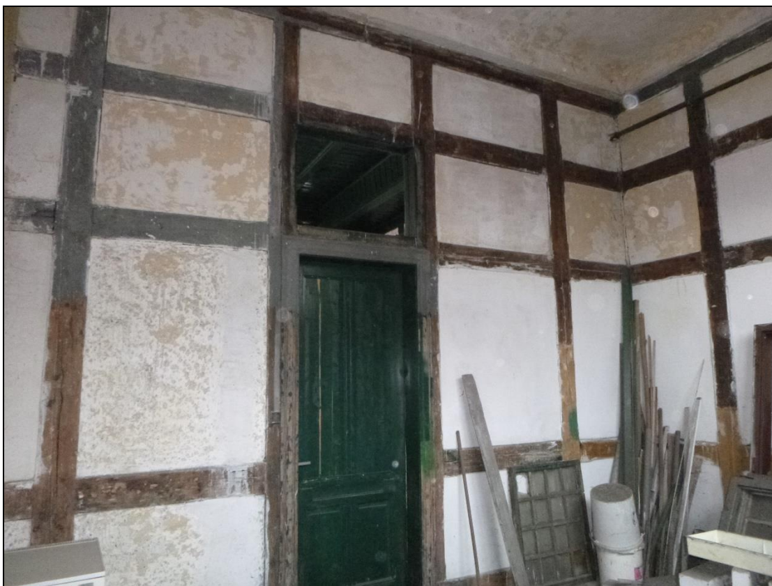
Foto 34: Interiér zděné části – místy bez nátěru, především ve spodních částech přítomny rozsáhlé výměny dřeva
