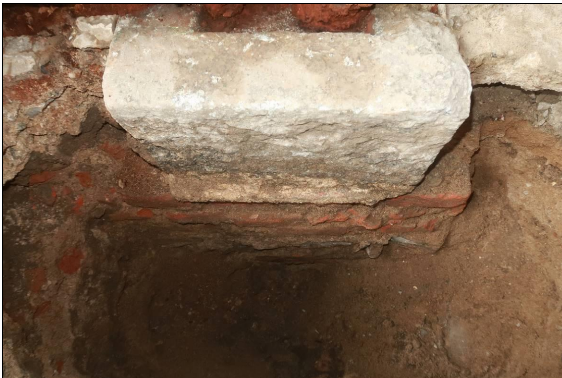
Foto 32: Pohled do sondy kolem kamenné patky, kamenná patka spočívá na zděném základu, maximální hloubka sondy cca 1 až 1,1 m
