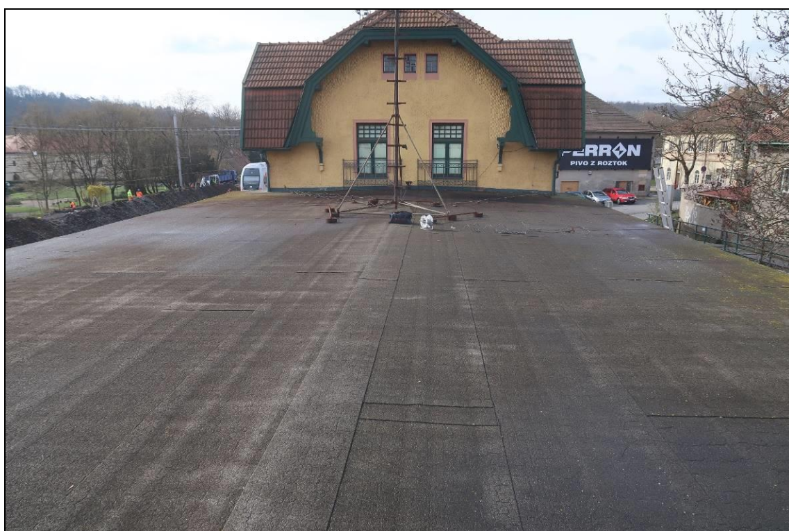
Foto 1: Pohled na střechu čekárny, svrchní vrstva je tvořena asfaltovými hydroizolačními pásy, pohled směrem k výpravní budově
