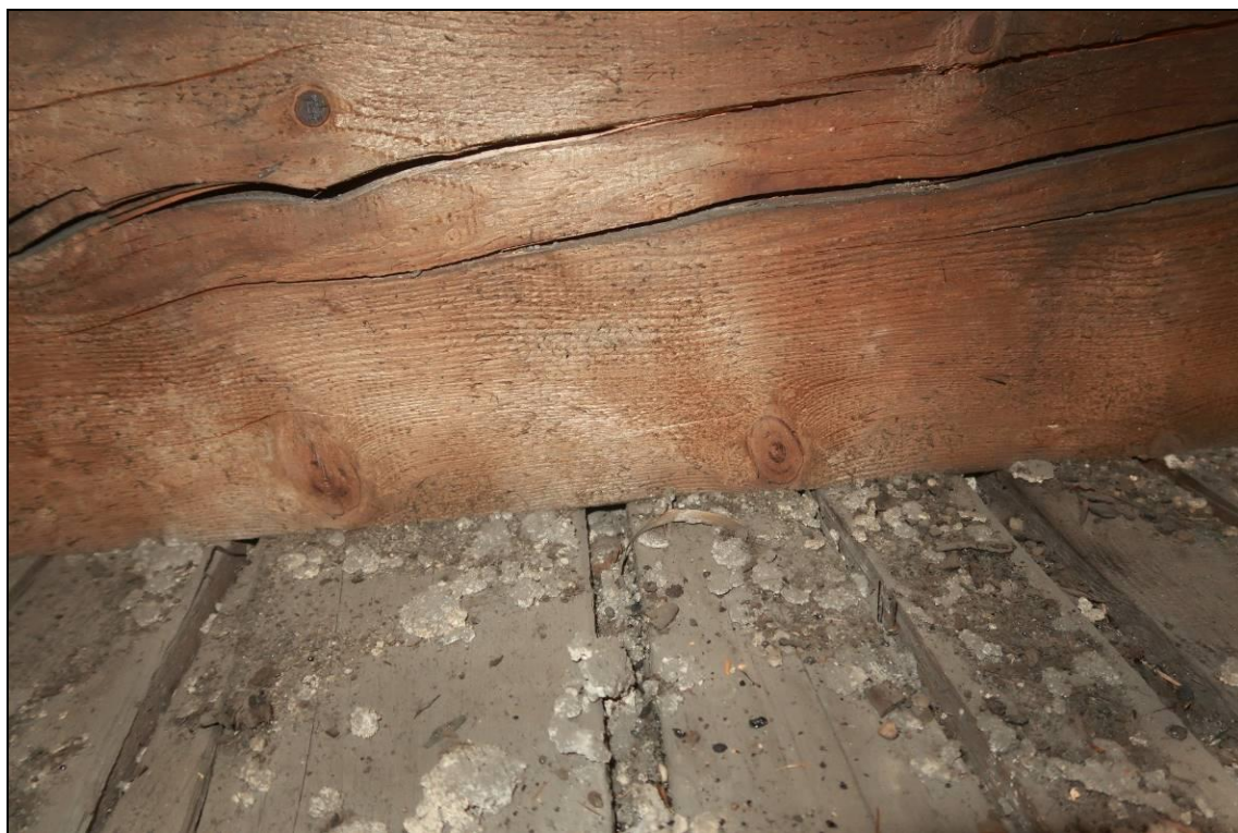
Foto 20: Pohled do sondy S4, dřevo trámu suché, bez viditelného poškození H či DH
