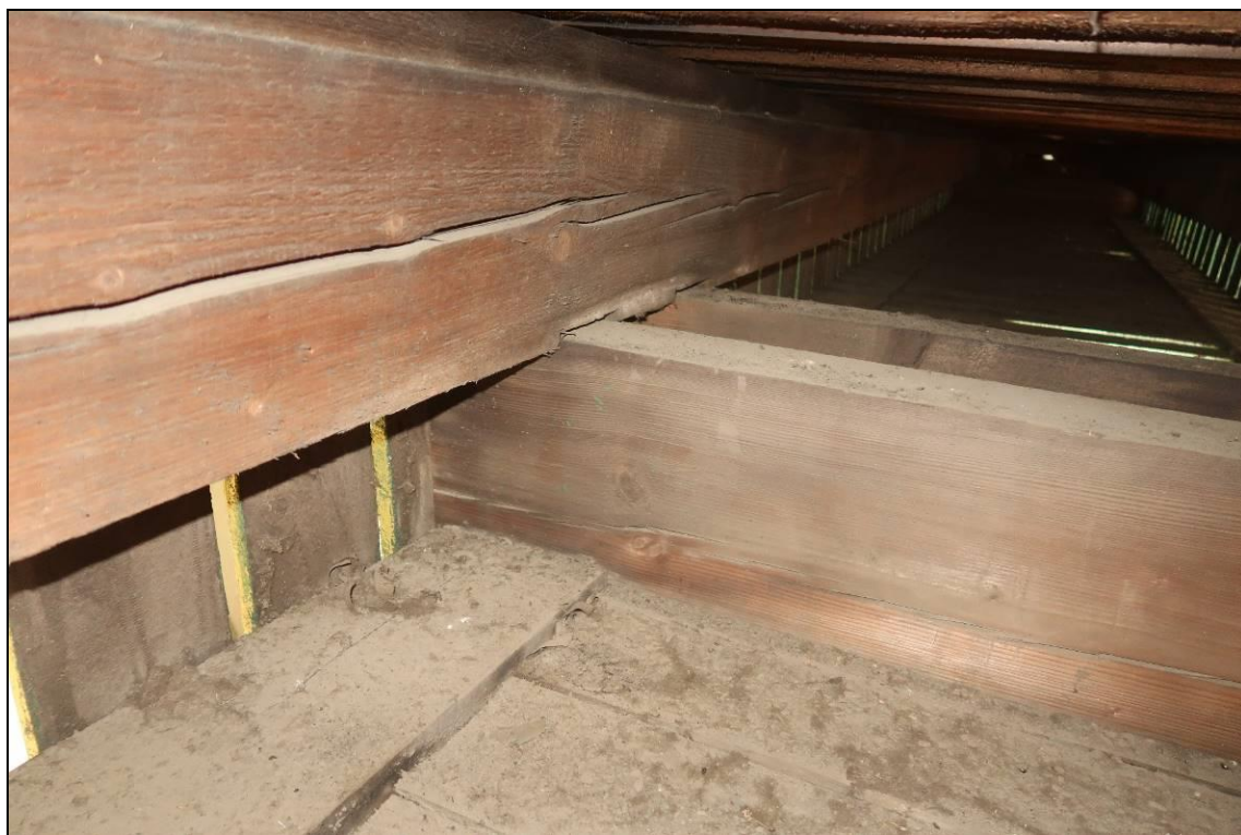
Foto 3: Pohled do sondy S1, dřevo suché, bez viditelného poškození H či DH
