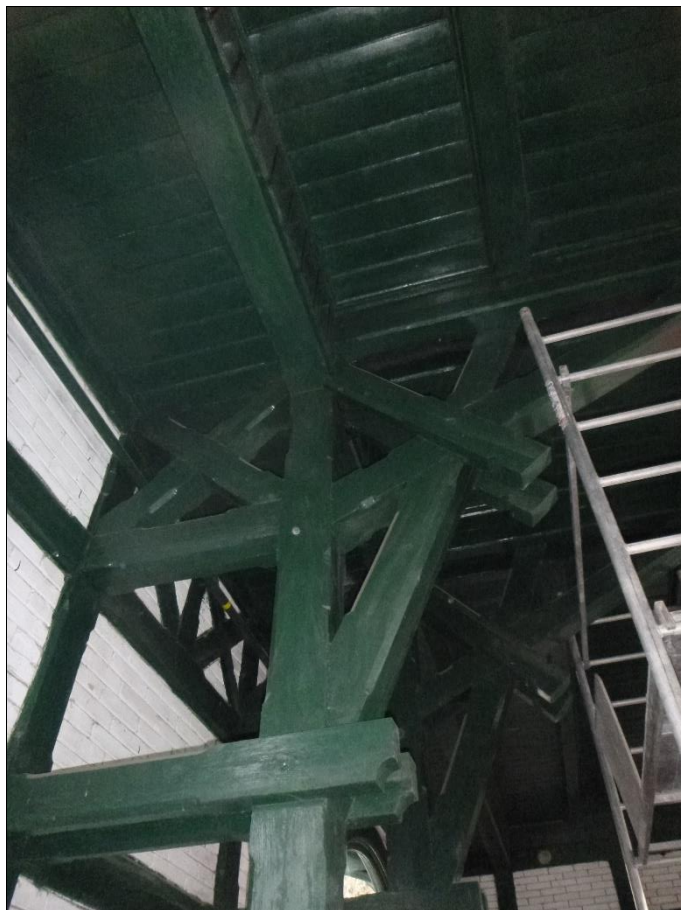
Foto 5: Vnitřní plná vazba A-B – bez poškození
