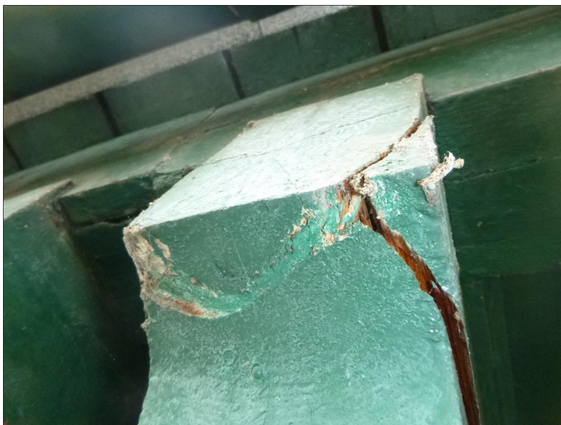
Foto 28: Vnější sopouch E-F F – degradace dřeva zatékáním (detail)
