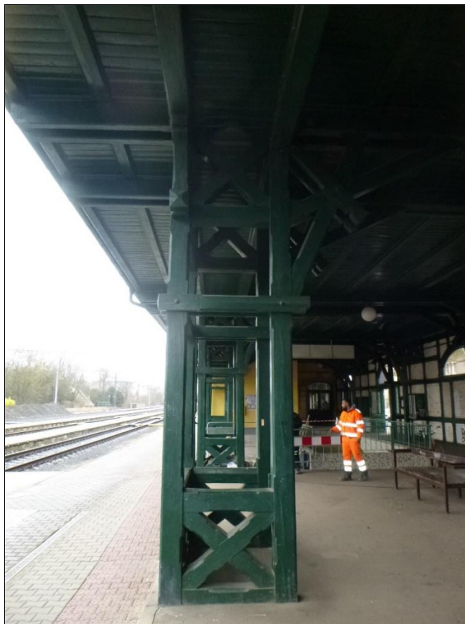
Foto 1: Vnější plná vazba A-B – bez poškození
