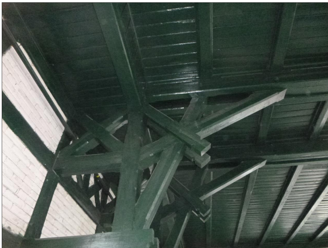
Foto 19: Vnitřní plná vazba E-F – bez poškození
