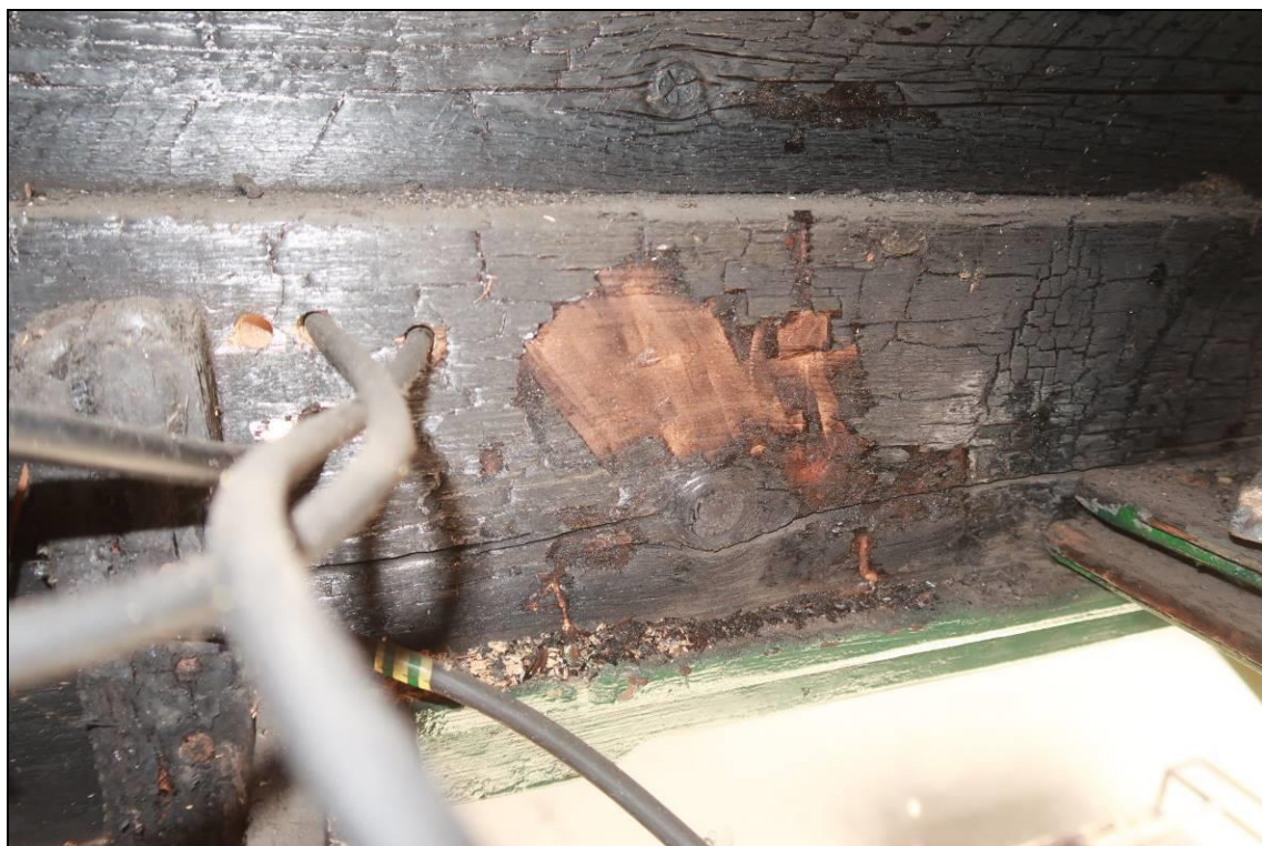
Foto 9: Pohled na zuhelnatění nosného trámu, hloubka 3 až 5 mm
