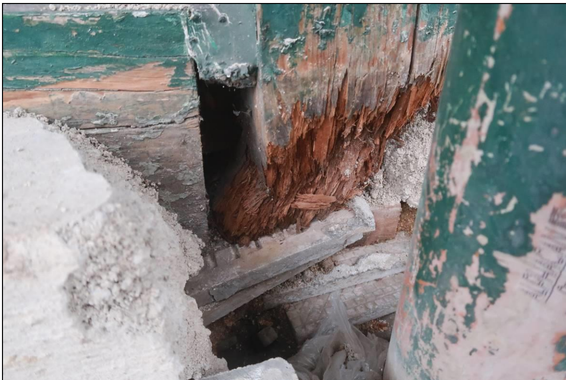
Foto 51: Detailní pohled na patu sloupu, důvodem rozestoupení vazby je degradace dřeva v patě těsně pod úrovní terénu, jedná se o vysokou intenzitu poškození dřevokaznou houbou, ale nelze vyloučit ani dřevokazný hmyz
