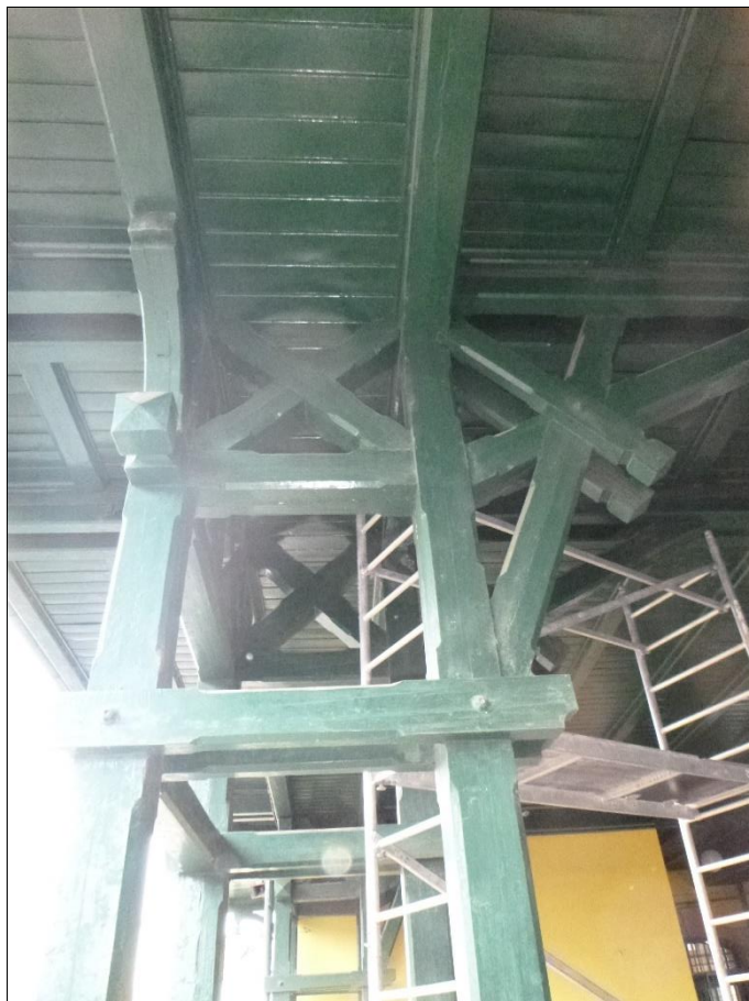
Foto 17: Vnější plná vazba E-F – bez poškození
