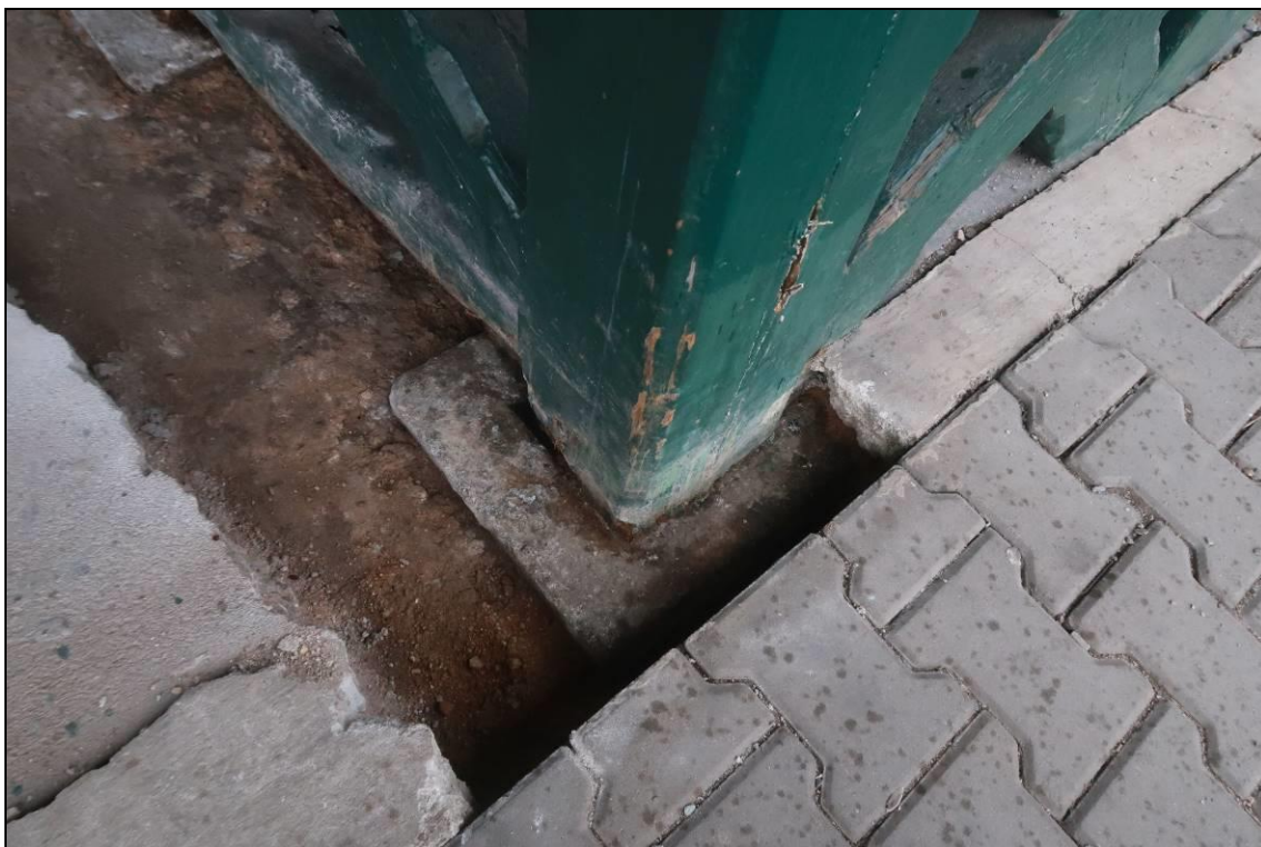
Foto 33: Pohled na druhou obnaženou patu sloupu v sondě 1, sloup opět v kamenné patce
