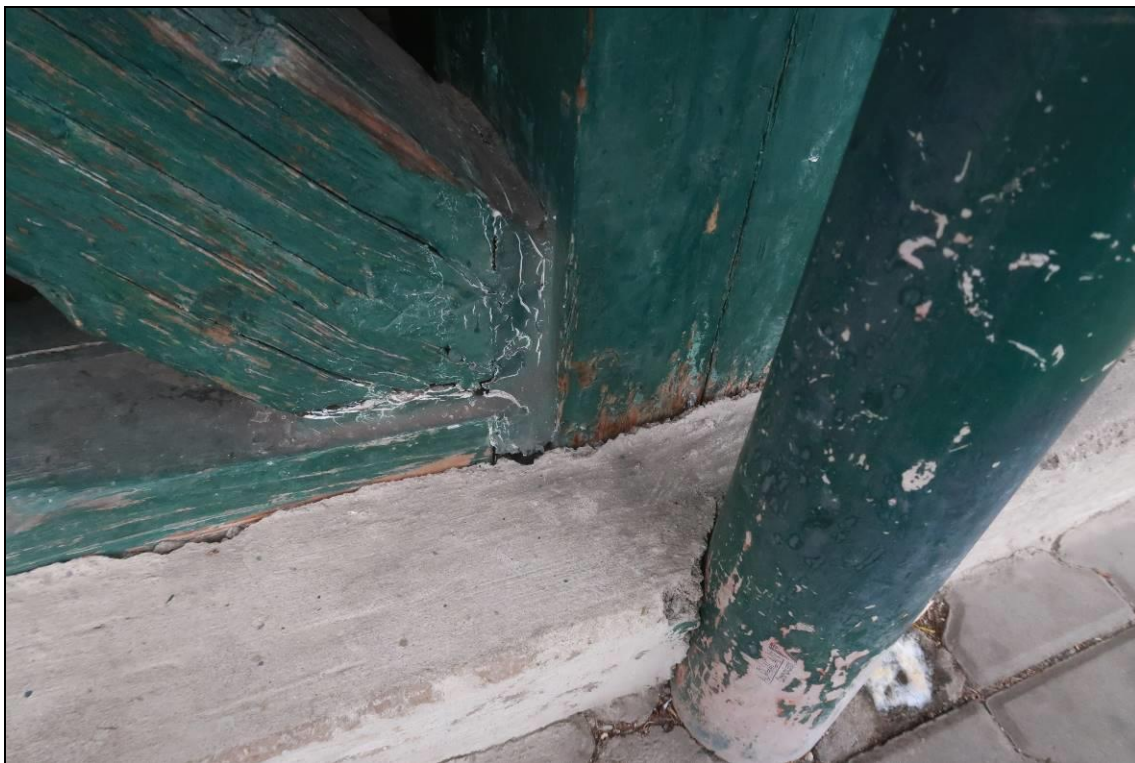
Foto 49: Pohled na sloup ještě před provedením sondy 5, vazba mezi prvky je v místě rozestoupená
