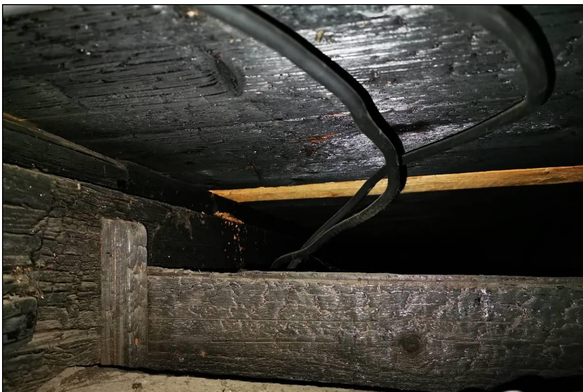
Foto 13: Pohled do sondy S2, pohled na zuhelnatěný záklop
