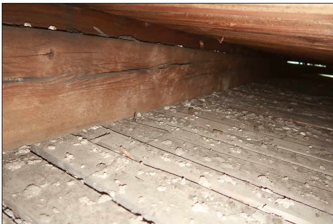
Foto 21: Pohled do sondy S4, dřevo nosných prvků i základu suché, bez viditelného poškození H či DH
