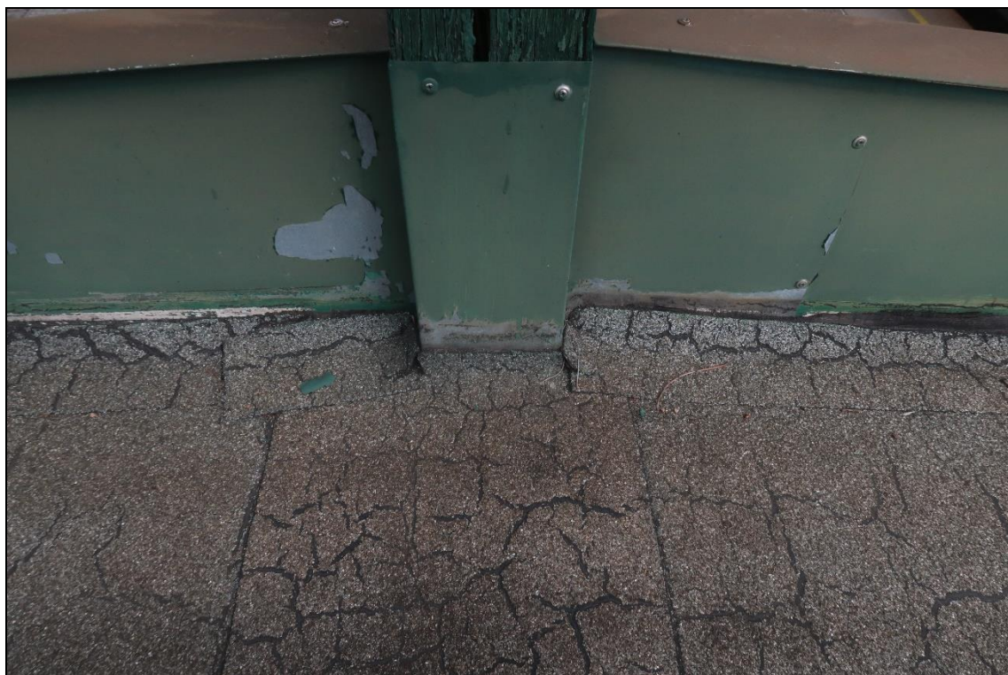
Foto 65: Detail napojení hydroizolace na oplechování u kraje střechy
