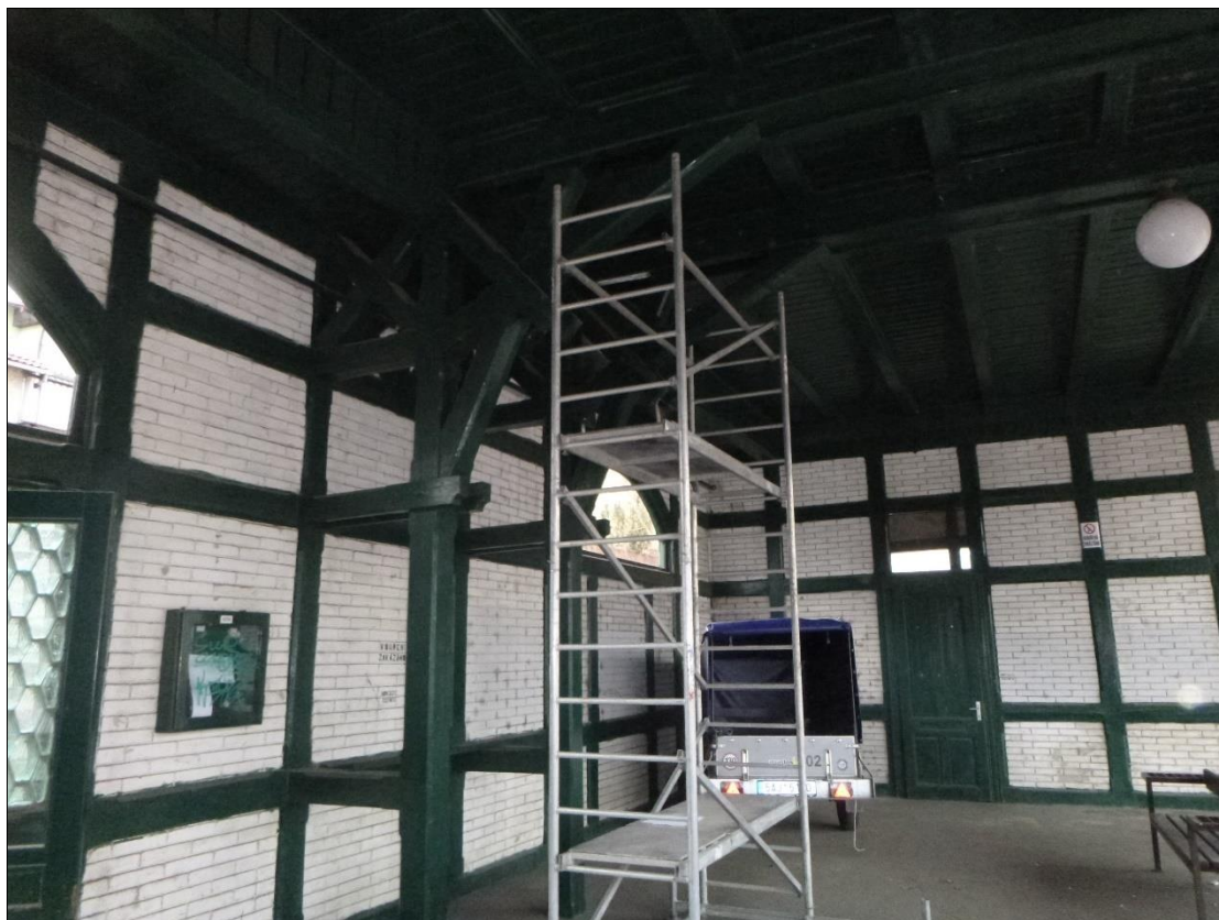
Foto 4: Vnitřní plná vazba A-B – bez poškození
