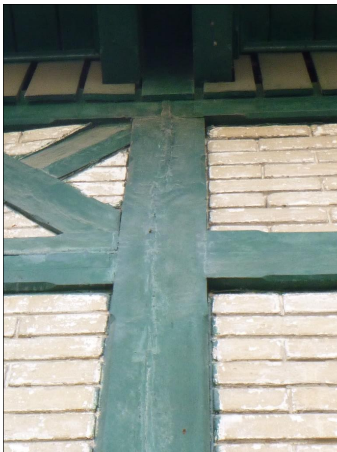
Foto 48: Zaplněná a přetřená svislá výsušná trhlina
