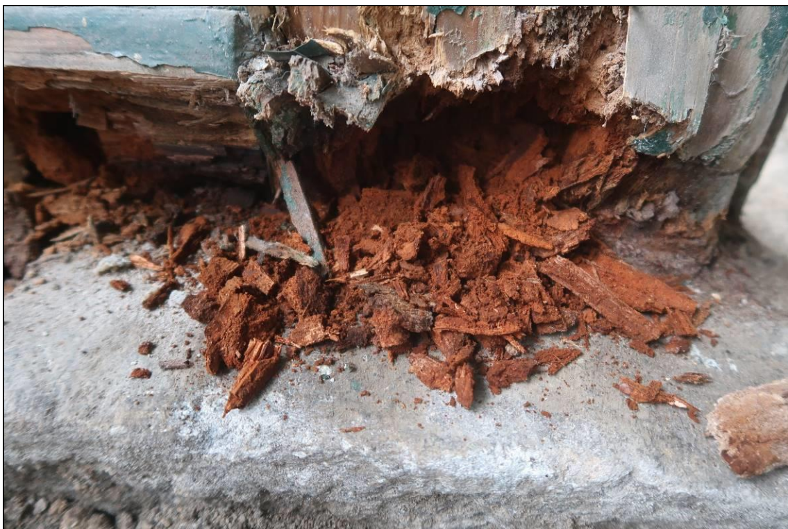
Foto 29: Detail sloupu v patě, sonda 1, významné oslabení průřezu sloupu, probíhá degradace dřeva těsně pod úrovní terénu, stupeň poškození vysoký, viditelná změna barvy a struktury (z prvku odebrán vzorek VZ2)
