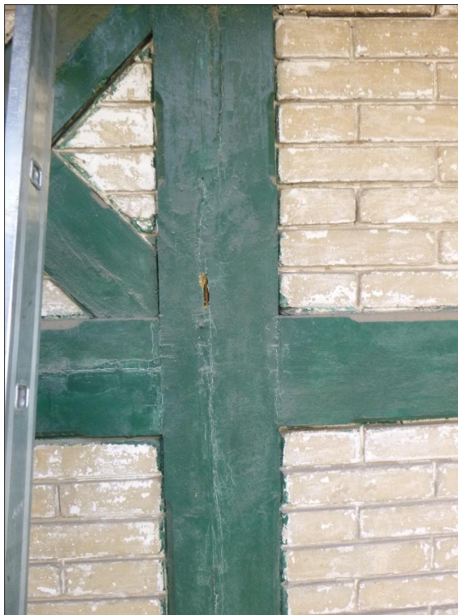
Foto 57: Svislá výsušná trhлина s malou sondou
