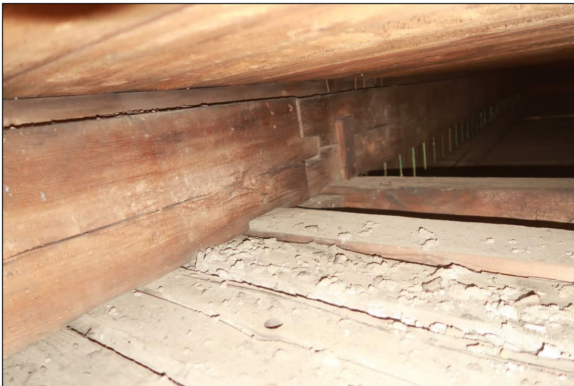
Foto 22: Pohled do sondy S4, dřevěné nosné prvky i záklop suché, bez viditelného poškození H či DH
