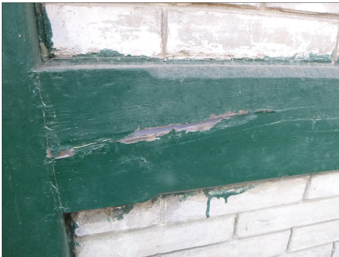
Foto 59: Vodorovná výsušná trhlina – nevhodná oprava (zaplnění pružným tmelem)
