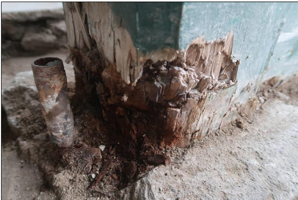
Foto 28: Detail sloupu v patě, sonda 1, významné oslabení průřezu sloupu, probíhá degradace dřeva těsně pod úrovní terénu, pravděpodobně se jedná o dřevokaznou houbu a vlhkost
