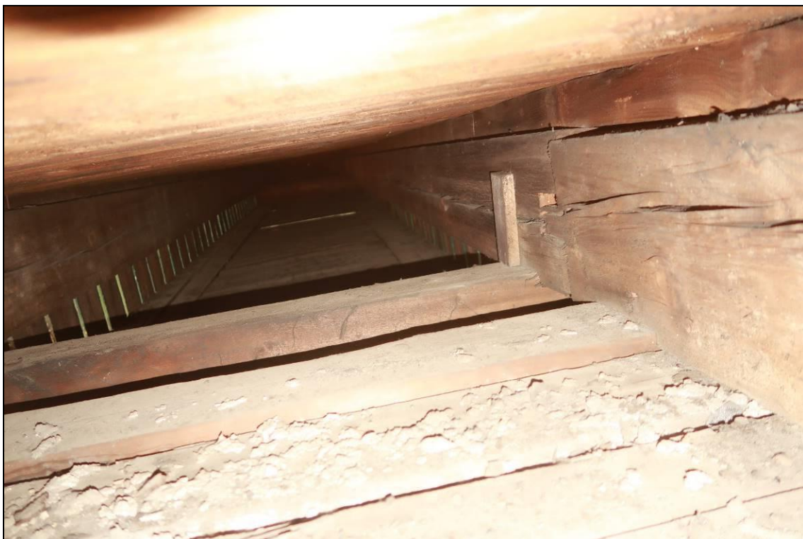
Foto 23: Pohled do sondy S4, dřevěné nosné prvky i záklop suché, bez viditelného poškození H či DH
