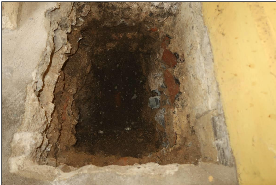
Foto 47: Pohled do sondy 4, hloubka sondy cca 650 mm, dlažba nezjištěna
