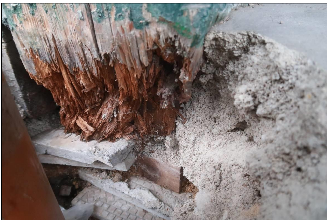
Foto 52: Pata sloupu byla již dříve zjevně podložena zbytky dlažby, dle stupně poškození lze stav považovat za havarijní
