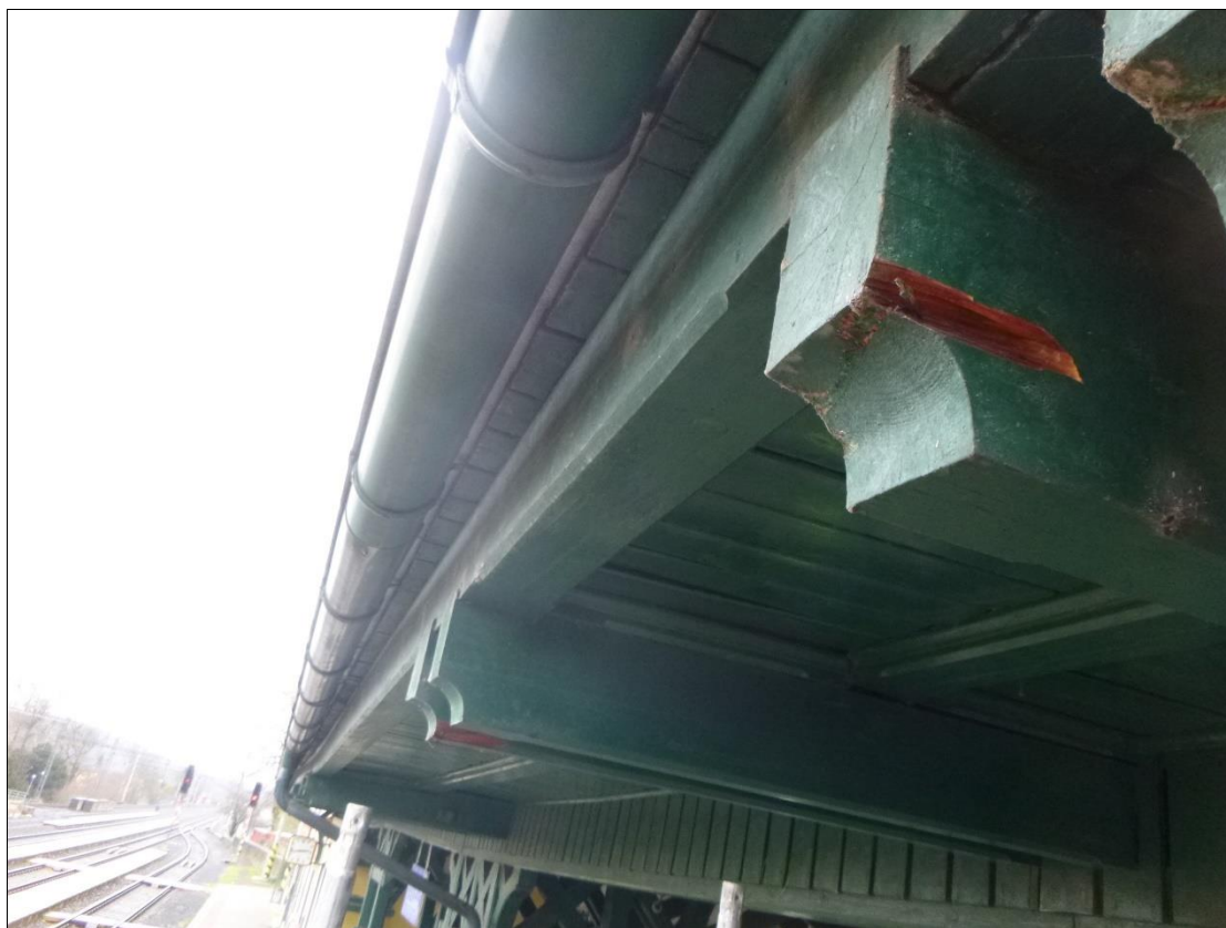
Foto 27: Vnější sopouch (přesah) E-F – degradace dřeva zatékáním
