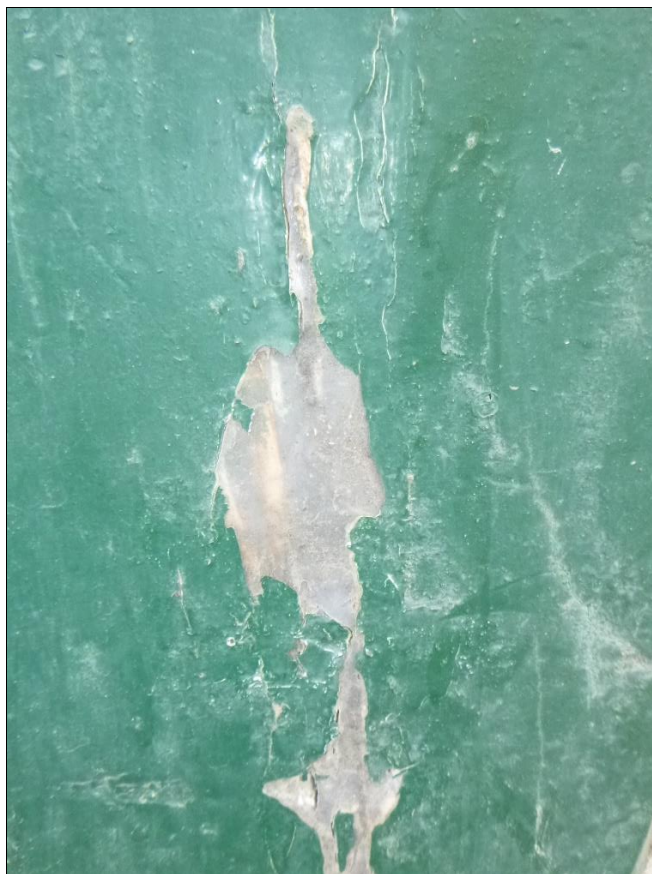
Foto 52: Svislá výsušná trhлина – nevhodná oprava detail
