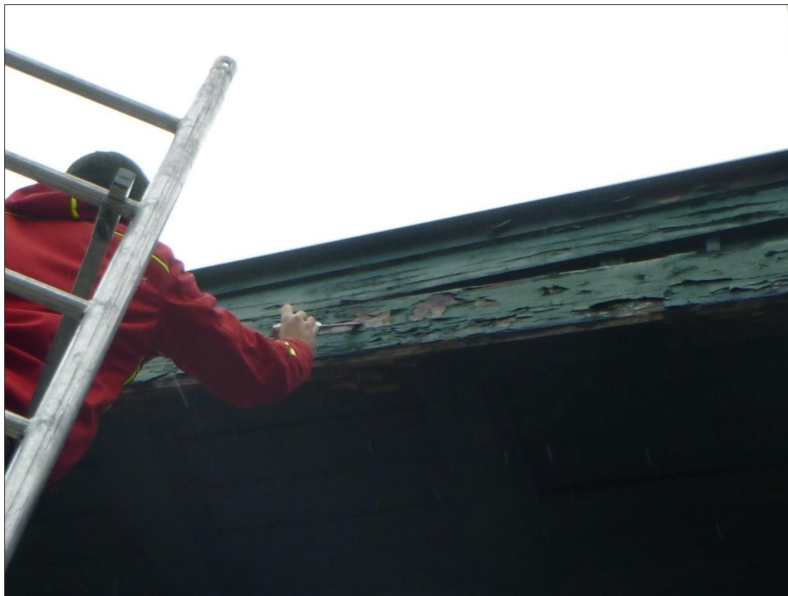
Foto 37: Krokev na severní straně - odlupující se nátěr
