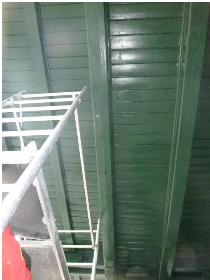
Foto 7: Výsušná trhлина mezi vazbami B-C (až 20 mm)
