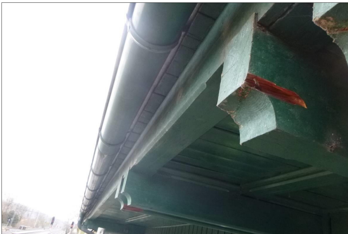
Foto 8: Lokalizace odběru VZ4, sopouch neboli přesah krokve na úrovni střešní roviny
