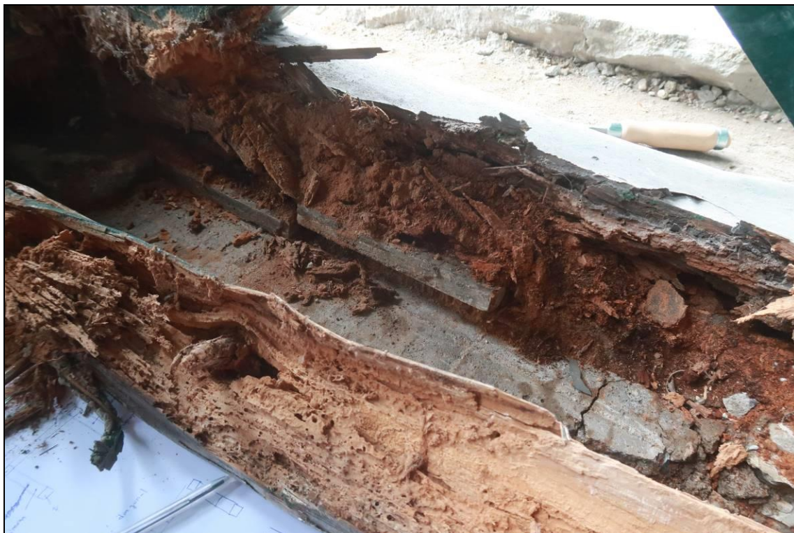
Foto 6: Lokalizace odběru VZ3, vzpěra mezi sloupy na úrovni terénu
