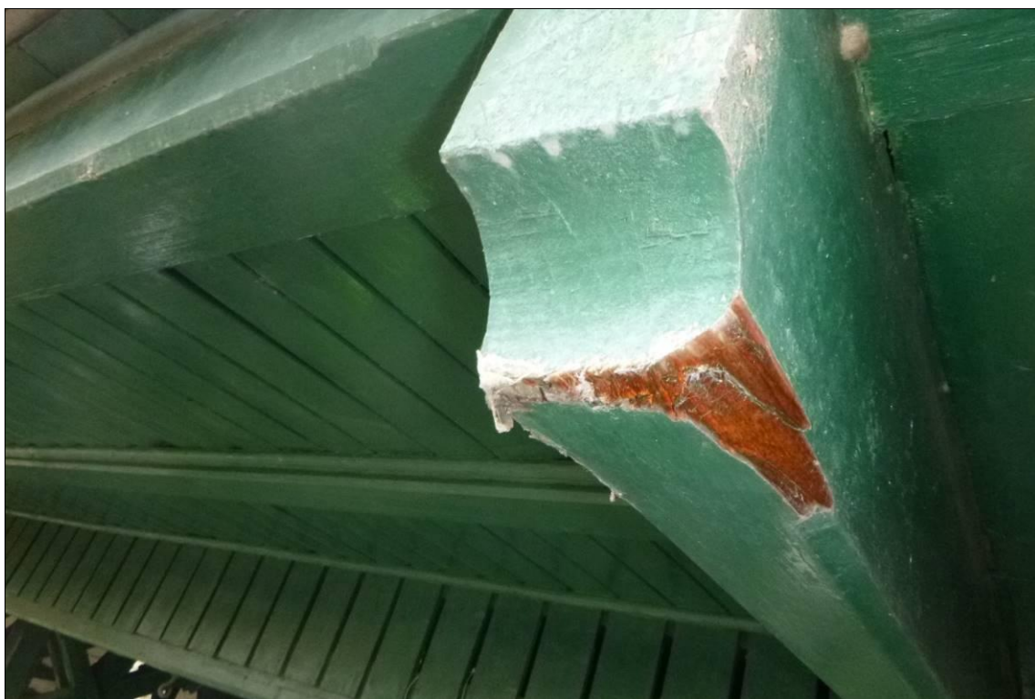
Foto 9: Detail prvku po odběru vzorku VZ4
