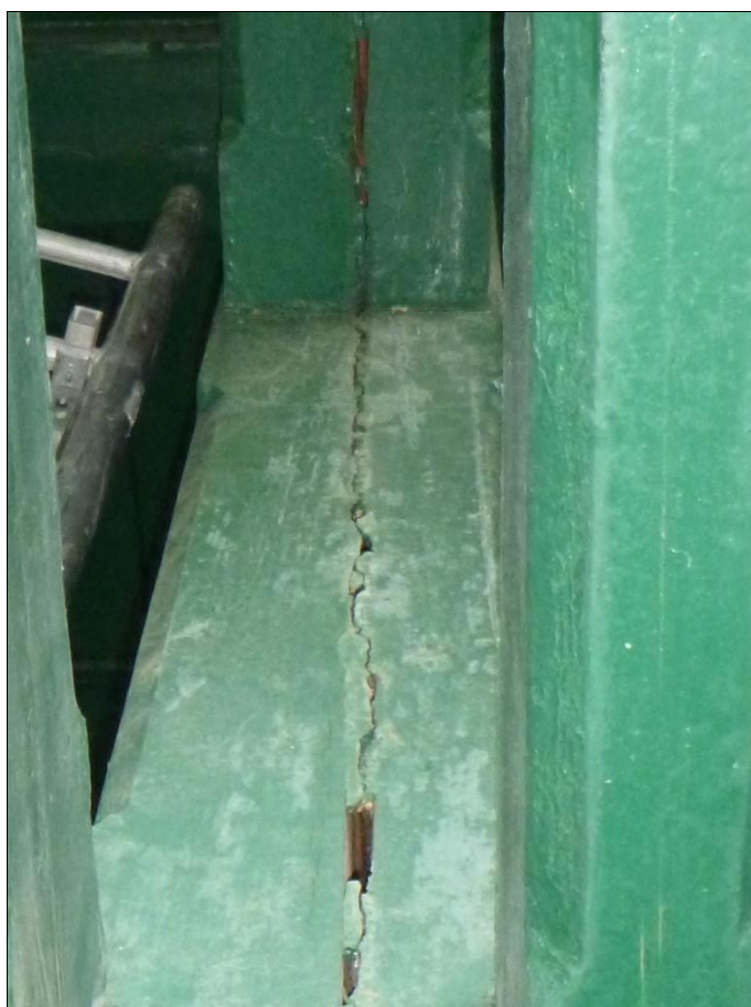
Foto 24: Vnější plná vazba G-H – svislá výsušná trhlina (zaplněná + přetřená)
