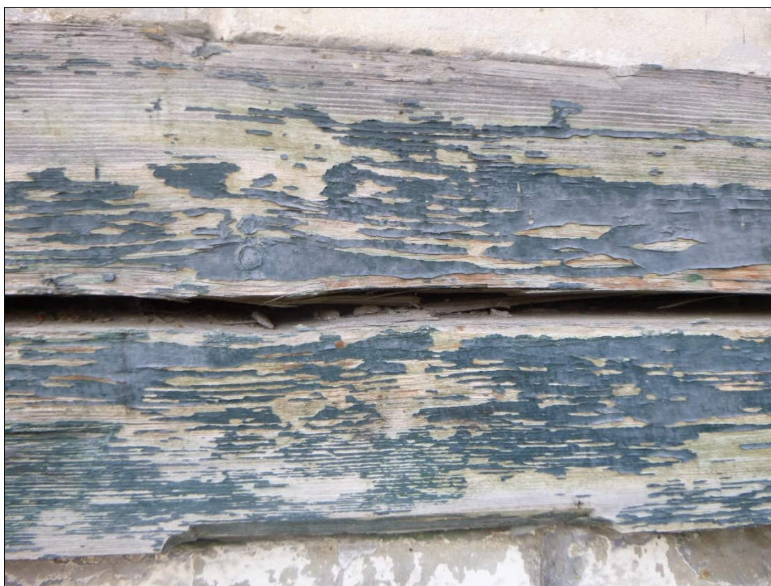
Foto 44: Severní strana – vodorovná výsušná trhлина mezi sloupy (detail)
