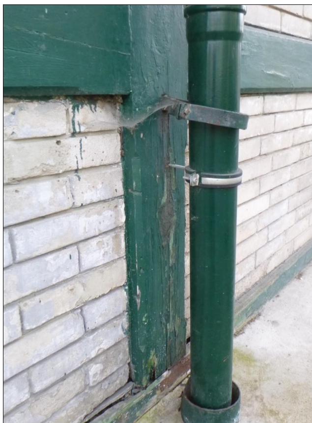
Foto 54: Svislá výsušná trhлина – nevhodná oprava, na úrovni terénu rozpad vazného trámu dlouhodobým zatékáním vody
