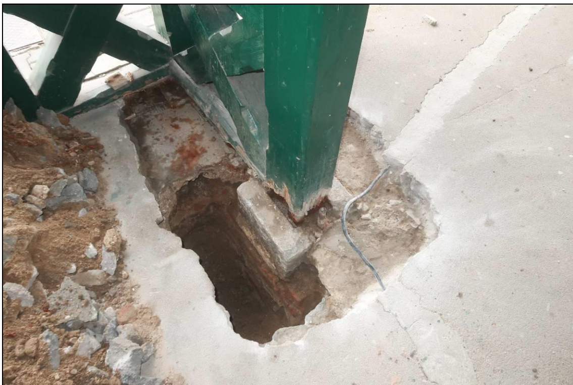
Foto 35: Celkový pohled na kopanou sondu 1, oba sloupy rozsáhlá degradace v patě těsně pod úrovní terénu, havarijní poškození
