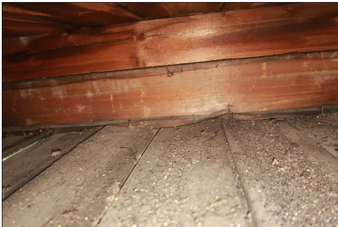
Foto 15: Pohled do sondy S3, dřevo aktuálně suché, na nosném trámu jsou patrné známky staršího zatečení, bez viditelného poškození H či DH
