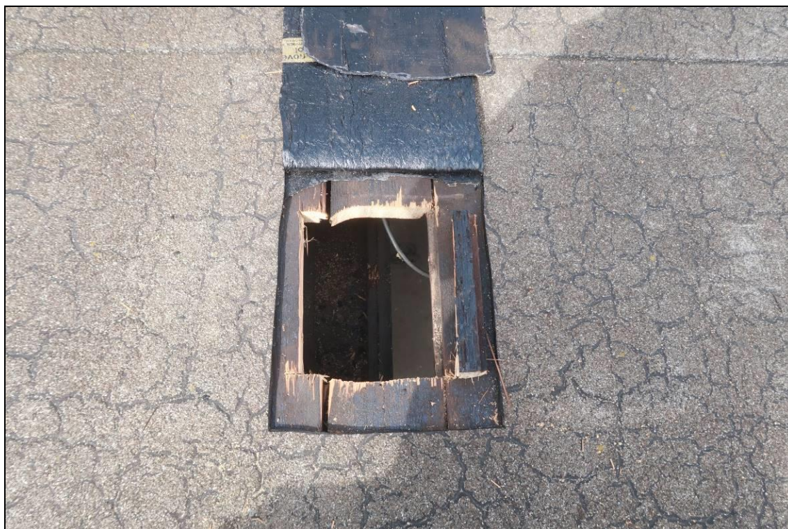
Foto 7: Pohled na provedenou sondu S2 po otevření hydroizolační vrstvy a dřevěného záklopu
