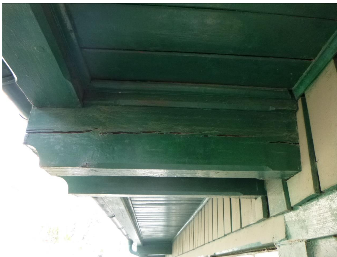
Foto 62: Plná vazba G – vodorovná výsušná trhlina
