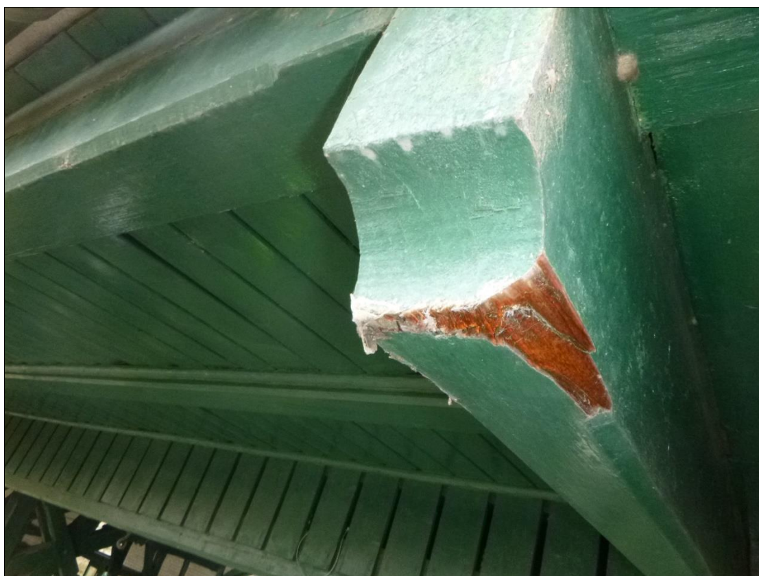
Foto 30: Vnější sopouch E-F F – degradace dřeva zatékáním
