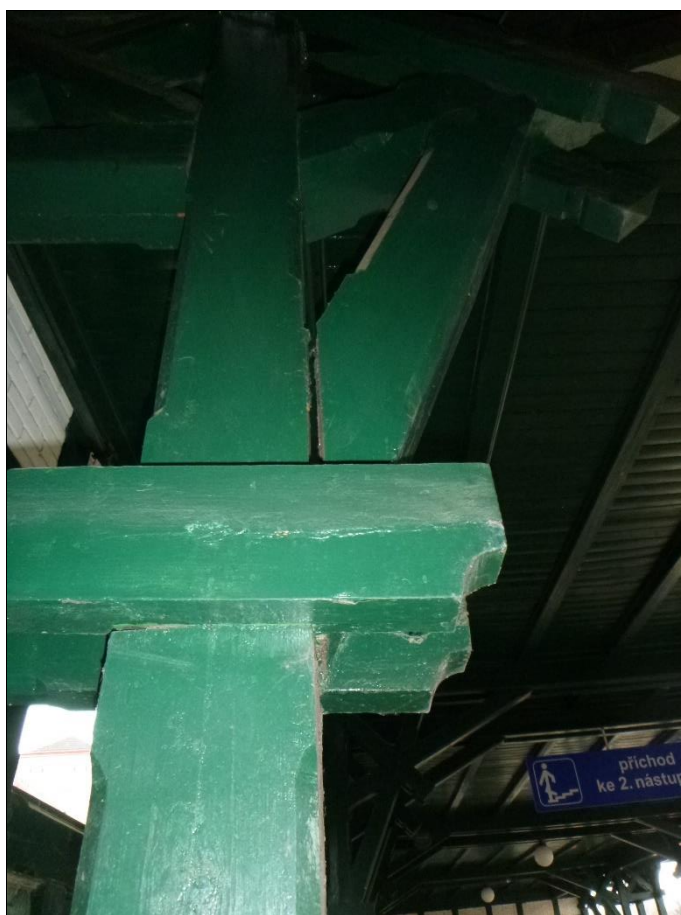
Foto 26: Vnitřní plná vazba G-H - rozestoupení spojů
