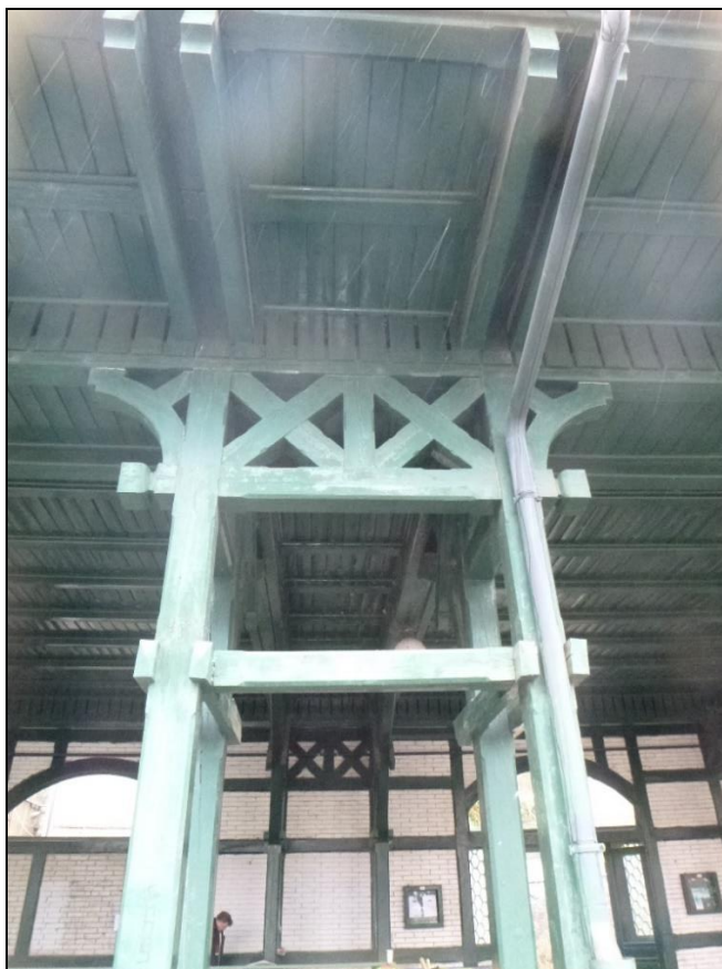
Foto 2: Vnější plná vazba A-B – bez poškození
