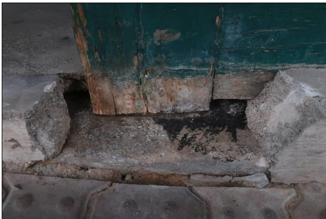
Foto 39: Pata sloupu vlevo, osazena v patce, dřevo sloupu pevné, bez známek většího poškození, mírně vlhké z důvodu absence izolační vrstvy
