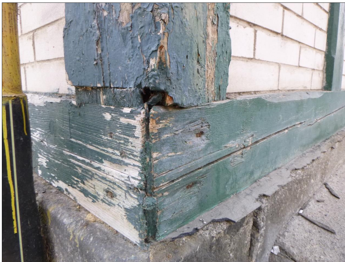
Foto 45: Napojení trámů a sloupu na rohu severní a západní stěny
