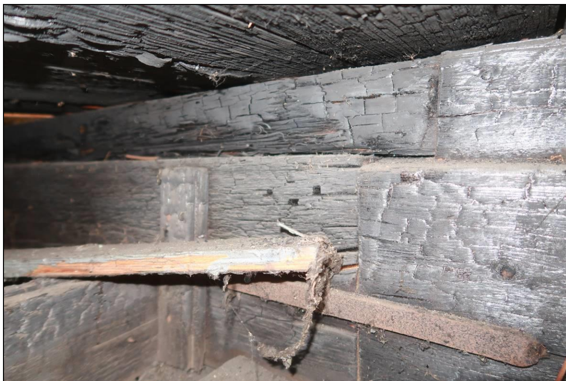
Foto 10: Pohled do sondy S2 směrem k výpravní budově, trámy zuhelnatěné vlivem požáru do hloubky cca 3 až 5 mm, lokálně až 8 mm
