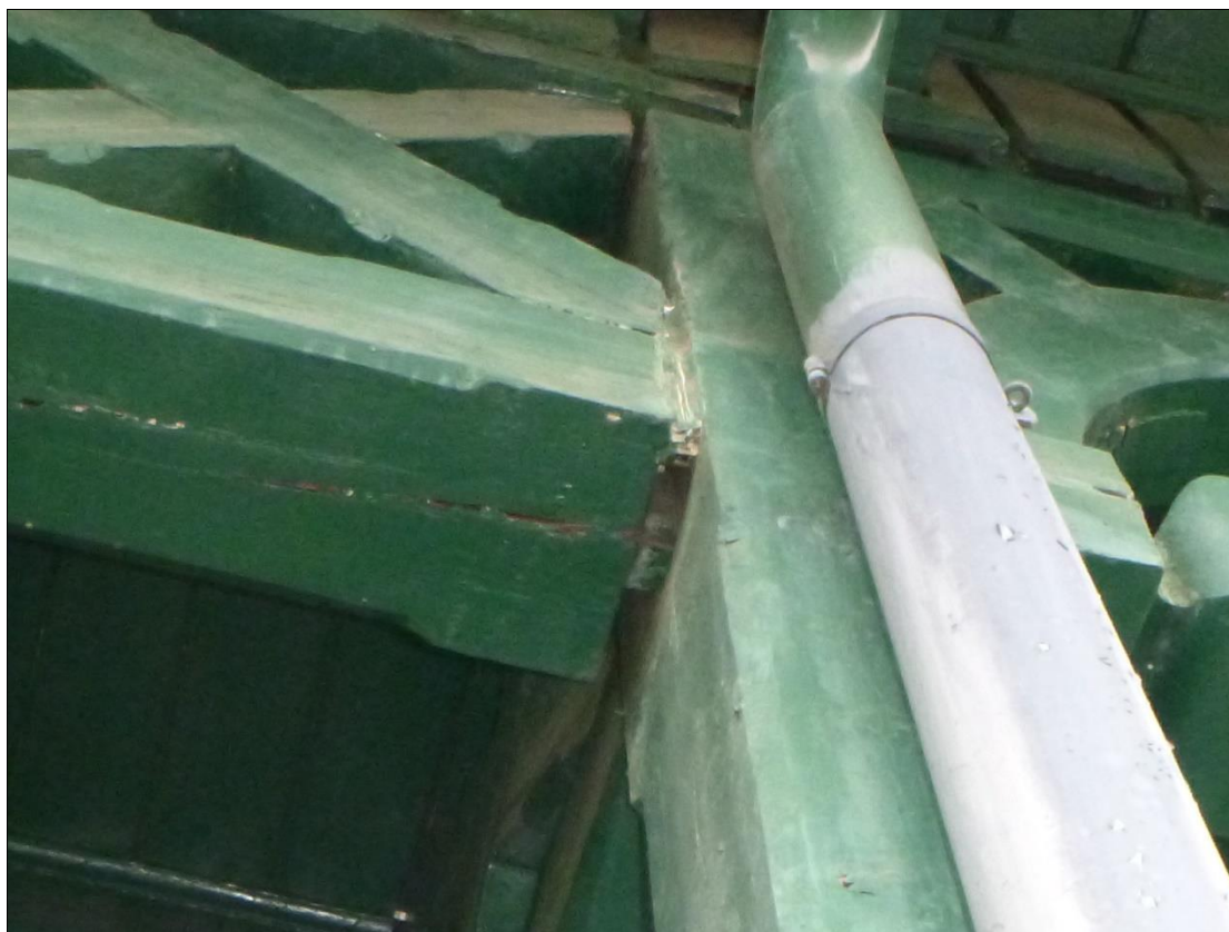
Foto 23: Vnější plná vazba G-H - rozestoupení spojů detail
