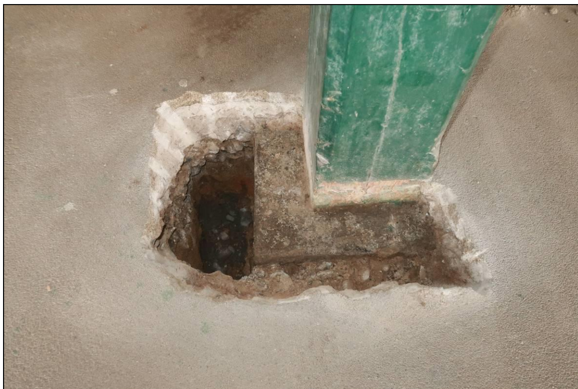
Foto 44: Pohled na sondu 3 provedenou v patě vnitřního sloupu, kamenná patka začíná cca 80 mm pod okolním terénem
