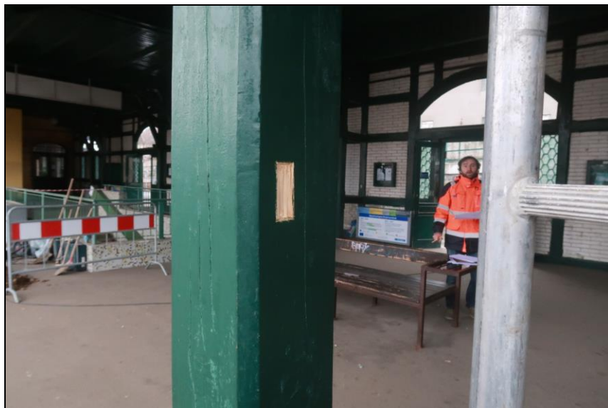
Foto 1: Místo odběru vzorku N1, sloup ve výšce cca 1,6 m
