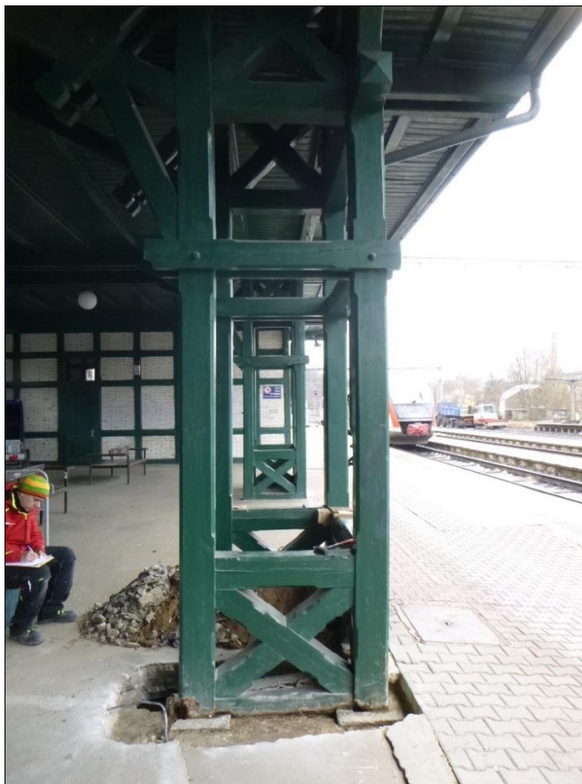
Foto 11: Vnější plná vazba C-D – sonda založení, vysoké poškození (H i DH) na úrovni terénu i těsně pod ním
