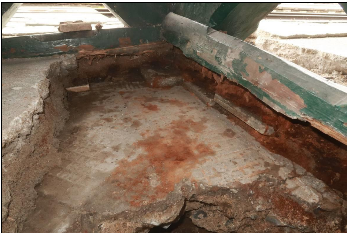
Foto 31: Detail sloupu vzpěry mezi sloupy v patě, vysoký stupeň poškození dřeva dřevokaznou houbou, ale i dřevokazným hmyzem
