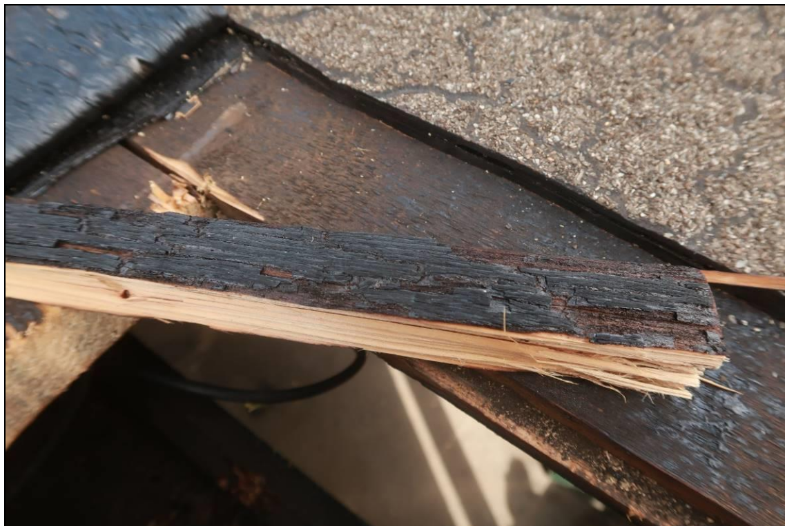
Foto 8: Dolní hrana záklopu je zuhelnatěná do hloubky cca 3 mm
