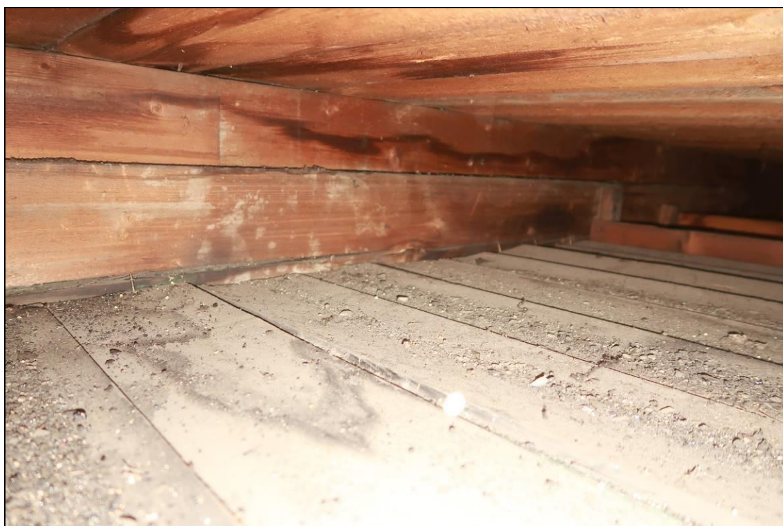
Foto 16: Pohled do sondy S3, dřevo aktuálně suché, na nosném trámu a záklopu jsou patrné známky staršího zatečení, bez viditelného poškození H či DH
