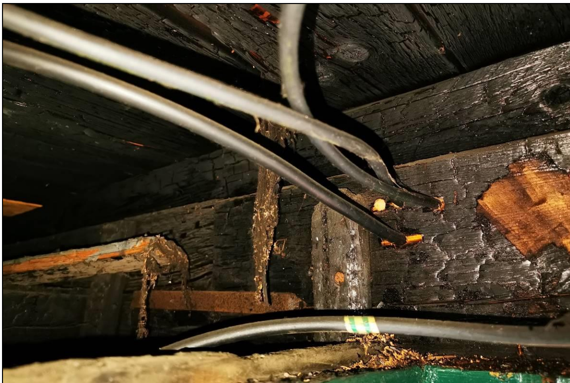
Foto 12: Pohled do sondy S2, detail průchodu kabelů skrz trámy, hloubka zuhelnatění nosných prvků cca 5 až 8 mm
