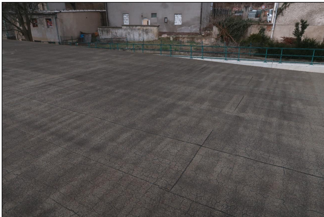
Foto 63: Pohled na střešní rovinu, stav hydroizolačního souvrství není dobrý, hydroizolace postupně degraduje, zpuchřelý povrch
