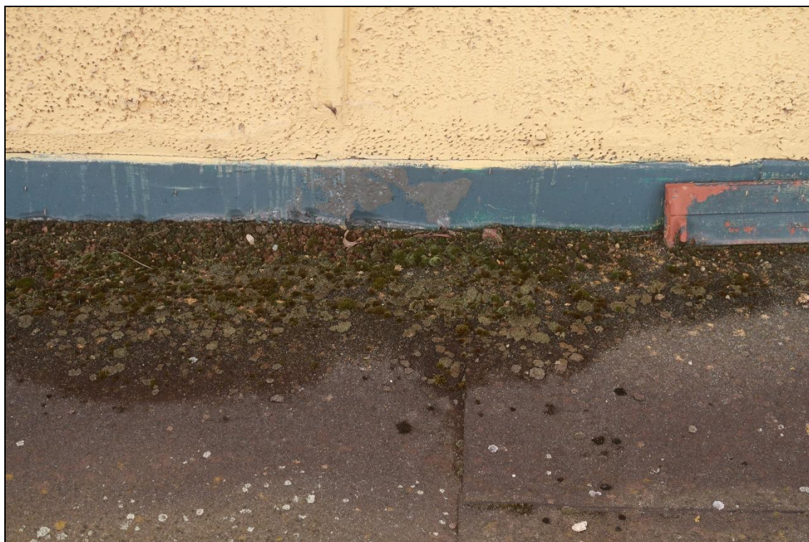
Foto 68: Detail hydroizolace pokryté mechem
