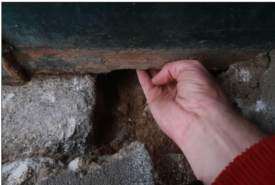
Foto 42: Pohled na vzpěru mezi sloupy v sondě 2, vzpěra byla částečně podkopána, pod terénem je dřevo vlhké - detail
