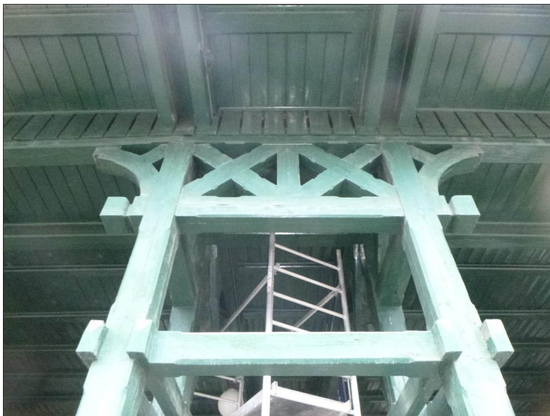
Foto 15: Vnější plná vazba E-F – bez poškození
