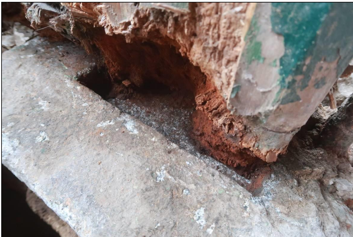
Foto 30: Detail sloupu v patě, sonda 1, sonda po odsátí materiálu, rozsáhlé oslabení průřezu, pata sloupu osazena v kamenné patce
