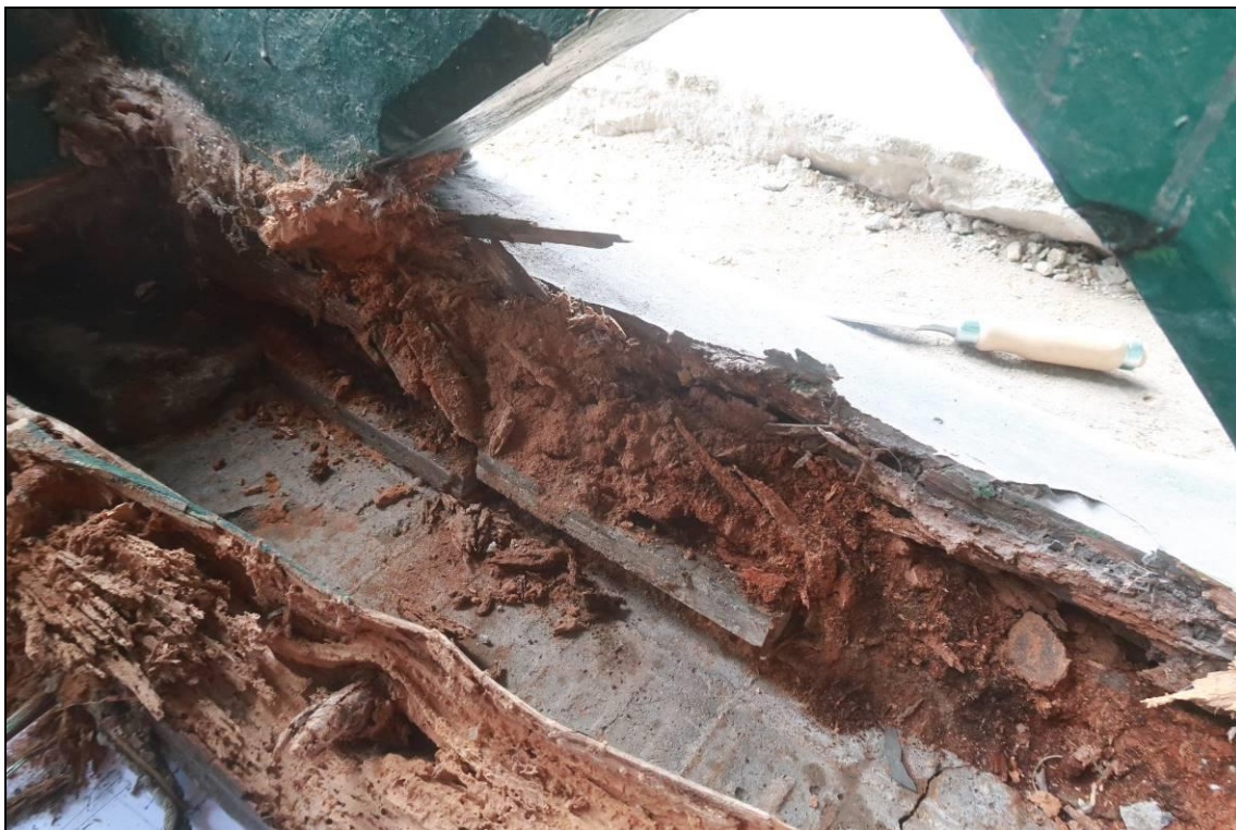
Foto 36: Pohled na rozpadlou vzpěru mezi sloupy, degradace je primárně způsobena dřevokaznou houbou a dřevokazným hmyzem (z prvku odebrán vzorek VZ3)
