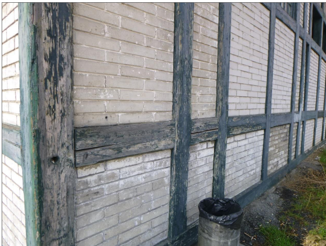
Foto 41: Severní strana – vodorovná výsušná trhlina
