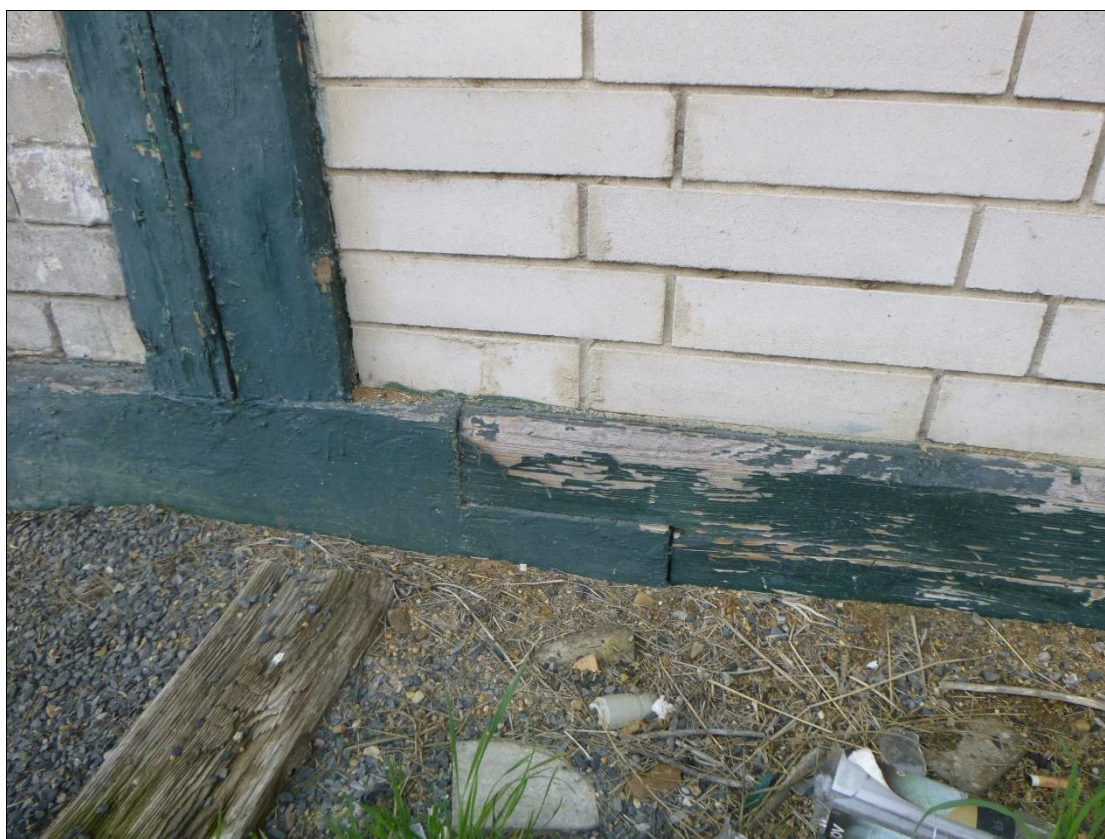
Foto 38: Vazný trám a sloupek severní strana – svislá výsušná trhлина
