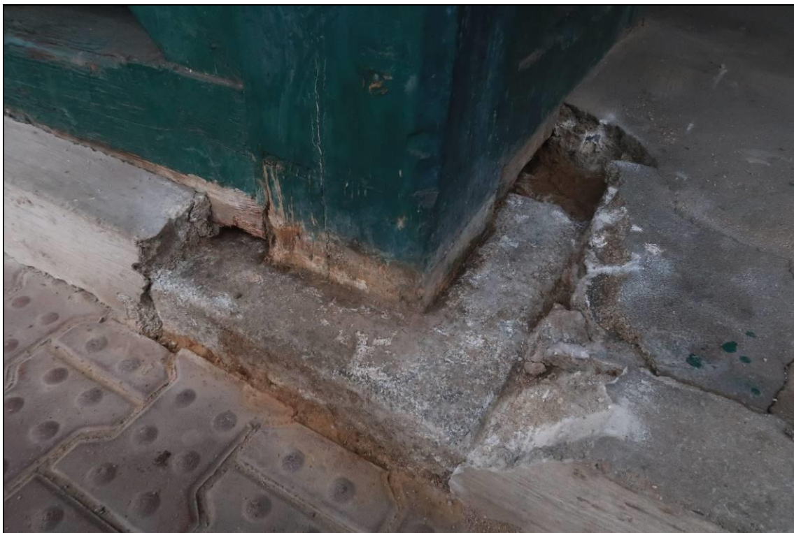
Foto 40: Pata sloupu vpravo, osazena v patce, dřevo sloupu pevné, bez známek většího poškození, mírně vlhké z důvodu absence izolační vrstvy
