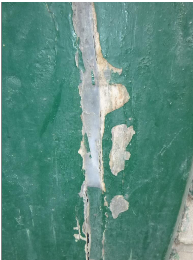
Foto 53: Svislá výsušná trhлина – nevhodná oprava detail
