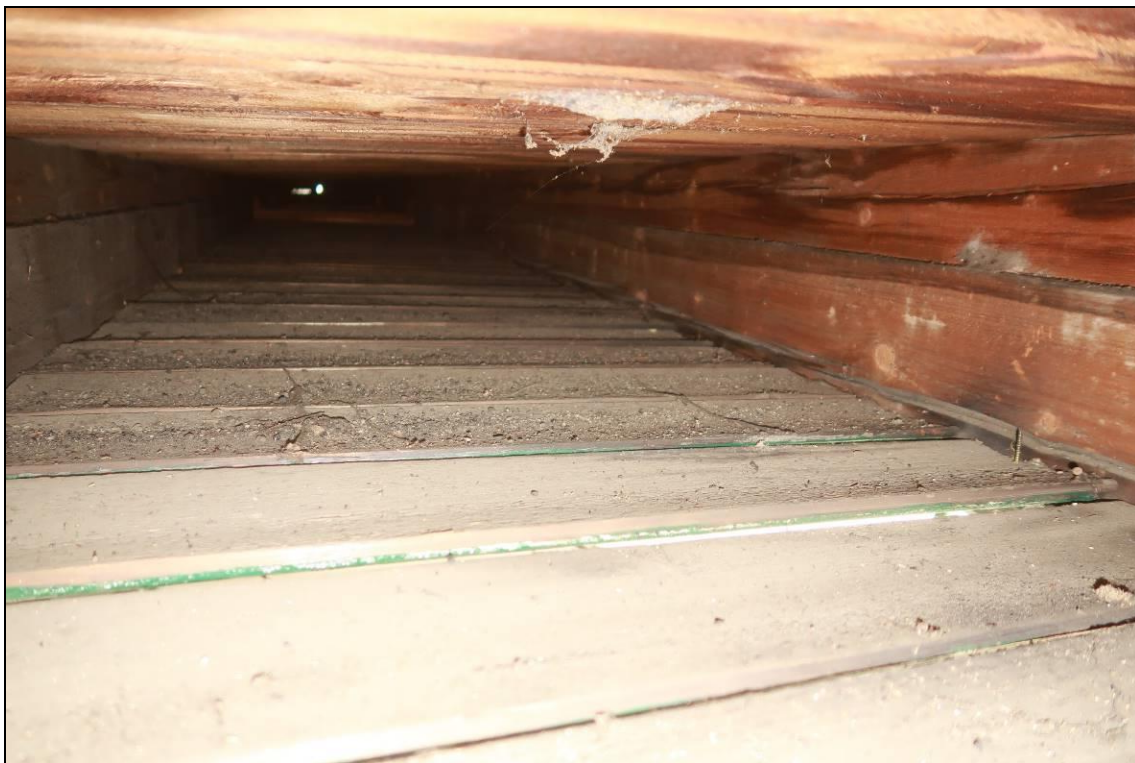
Foto 17: Pohled do sondy S3, dřevo aktuálně suché, na nosném trámu a záklopu jsou patrné známky staršího zatečení, bez viditelného poškození H či DH
