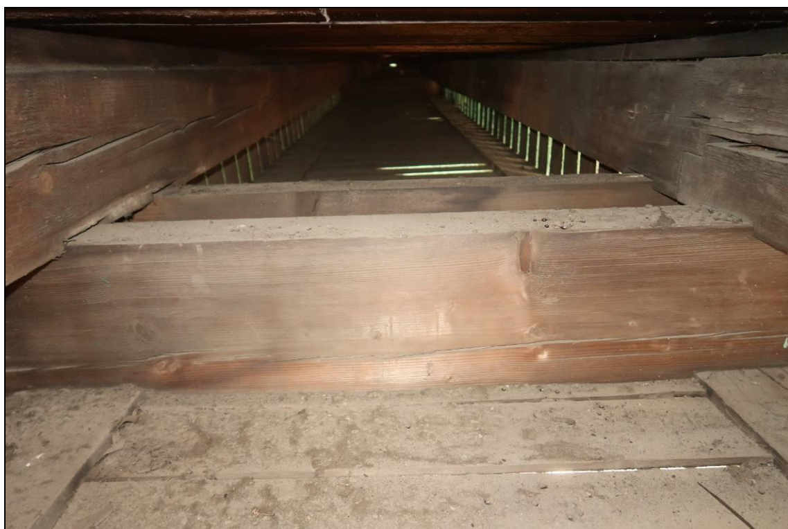
Foto 4: Pohled do sondy S1, dřevo suché, bez viditelného poškození H či DH
