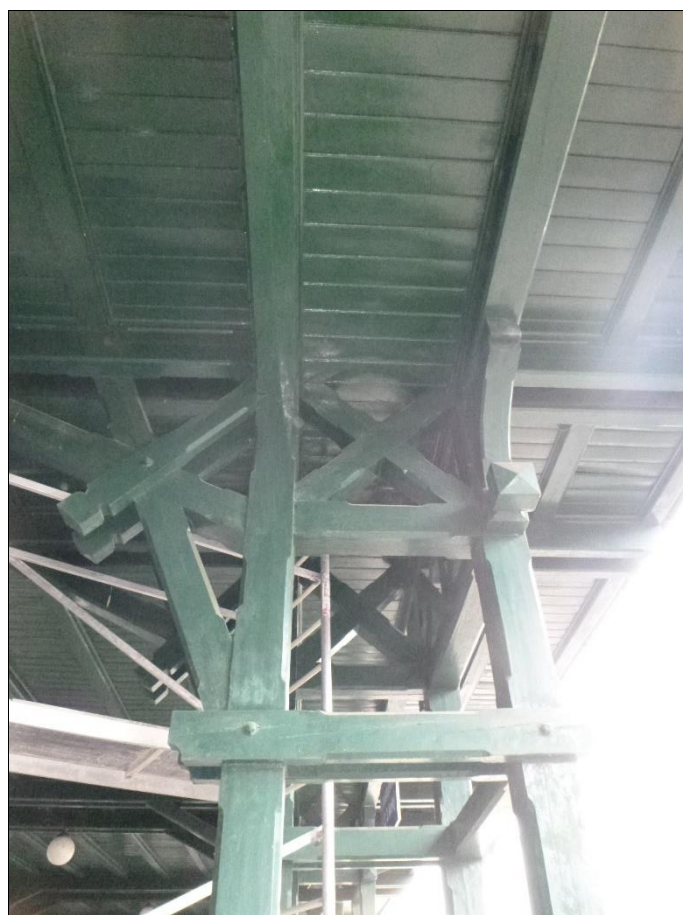
Foto 16: Vnější plná vazba E-F – bez poškození
