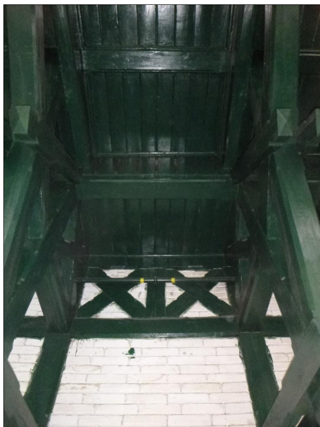
Foto 14: Vnitřní plná vazba C-D – bez poškození
