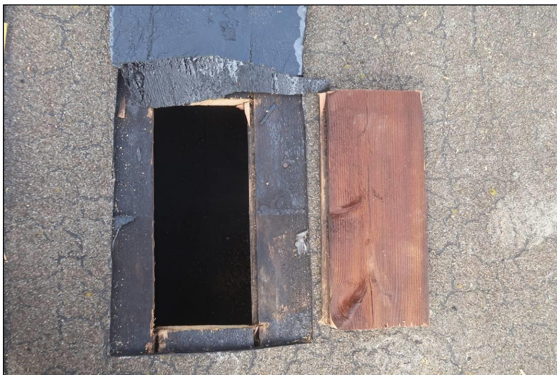
Foto 2: Pohled na provedenou sondu S1 po otevření hydroizolační vrstvy a dřevěného záklopu
