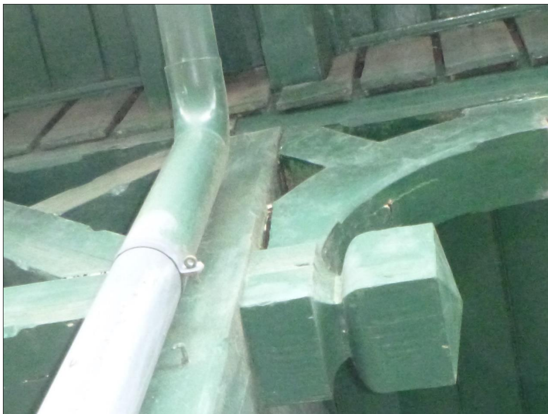
Foto 25: Vnější plná vazba G-H - rozestoupení spojů
