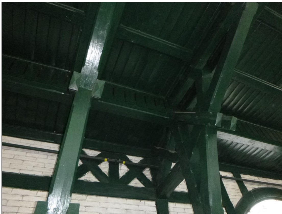
Foto 18: Vnitřní plná vazba E-F – bez poškození
