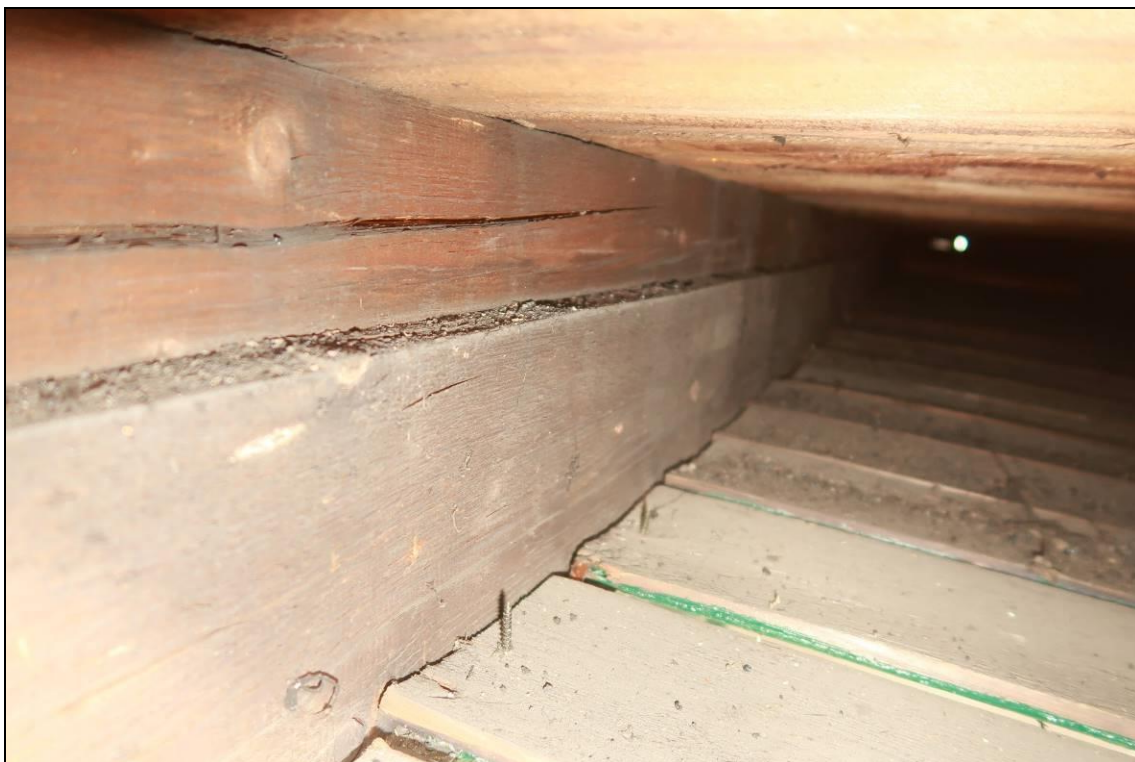
Foto 18: Pohled do sondy S3, dřevo aktuálně suché, na nosném trámu a záklopu jsou patrné známky staršího zatečení, bez viditelného poškození H či DH
