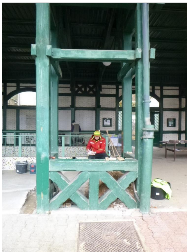
Foto 10: Vnější plná vazba C-D – sonda založení, vysoké poškození (H i DH) na úrovni terénu i těsně pod ním
