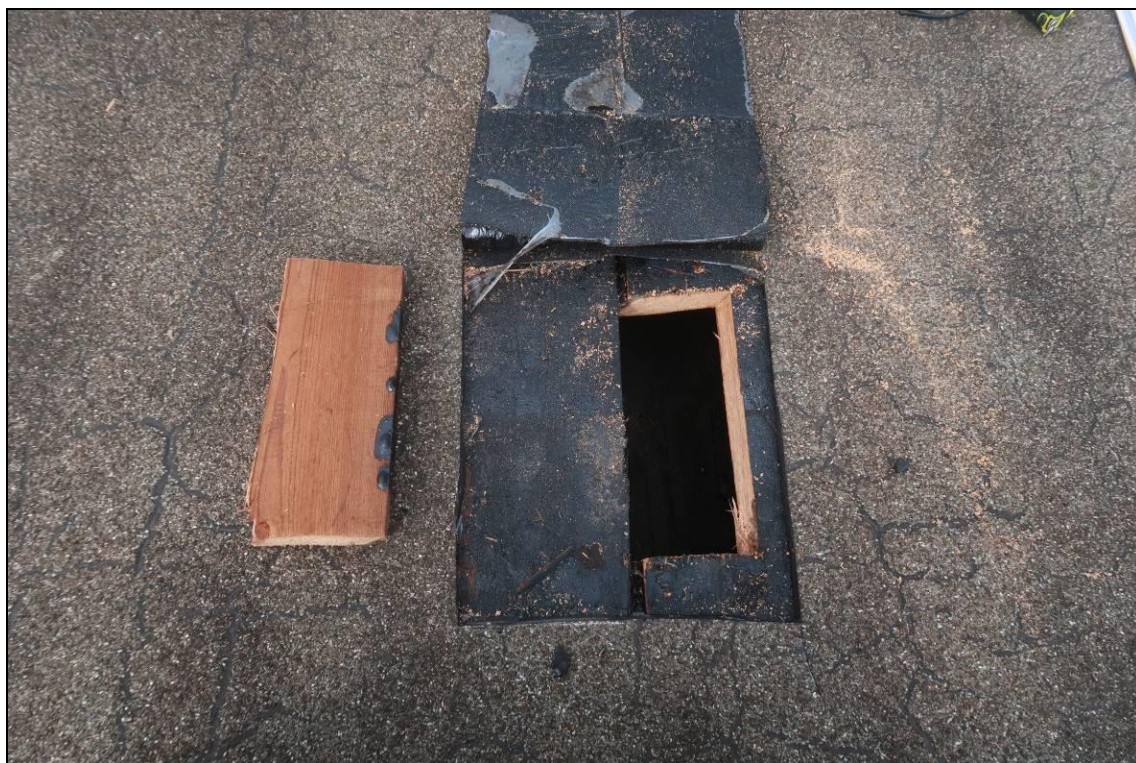
Foto 19: Pohled na provedenou sondu S4 po otevření hydroizolační vrstvy a dřevěného záklopu
