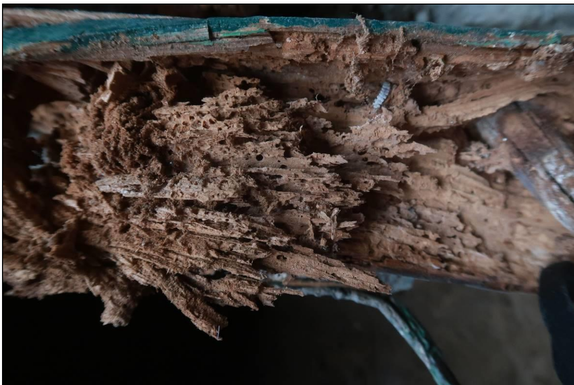
Foto 37: Detail z přecházející fotografie, dle druhu napadení se jedná o hmyz z čeledi červotočovitých
