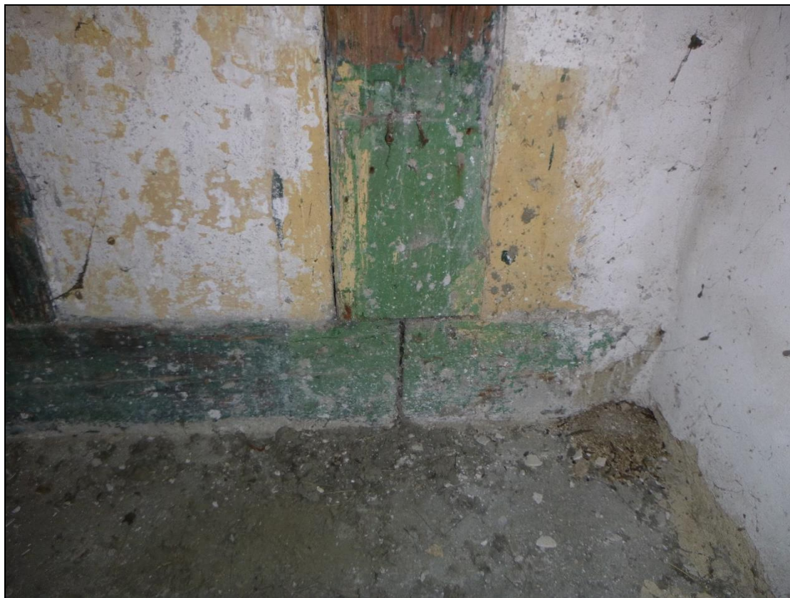
Foto 35: Tupý spoj vazného trámu a sloupu ve zděné části – bez poškození
