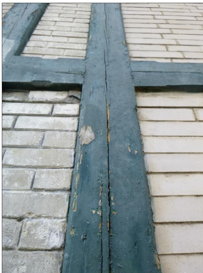
Foto 40: Severní strana – svislá výsušná trhлина (celkový pohled)
