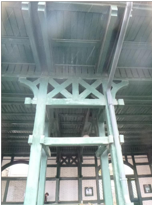
Foto 9: Vnější plná vazba C-D – bez poškození
