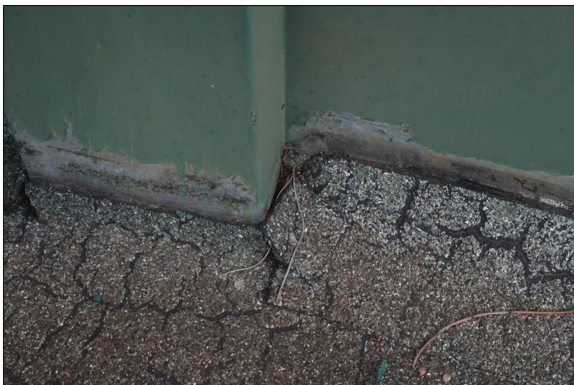
Foto 66: Detail napojení hydroizolace na oplechování u kraje střechy – detail, spoj není těsný, hrozí nebezpečí zatékání
