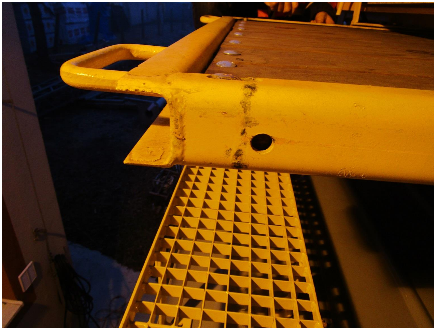
Příloha 8_zajištění plošiny 068
