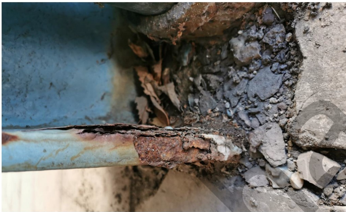
Obrázek č. 2 - Detail koroze nosné ocelové konstrukce
