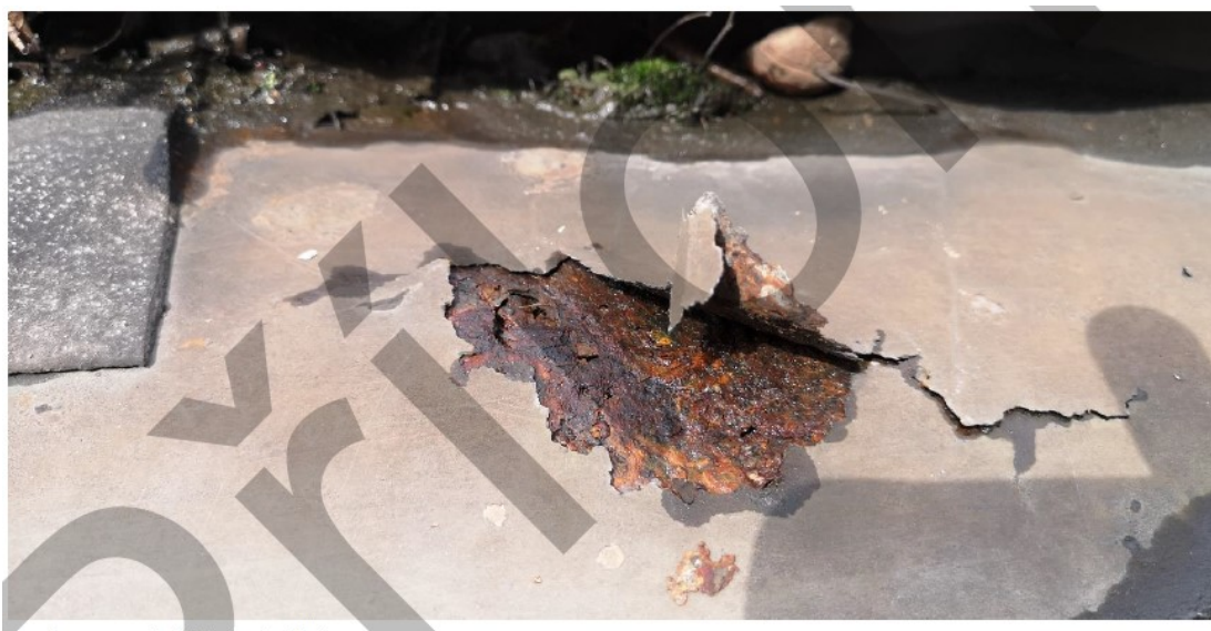
Obrázek č. 4 - Detail zkorodovaného plechového žlabu
