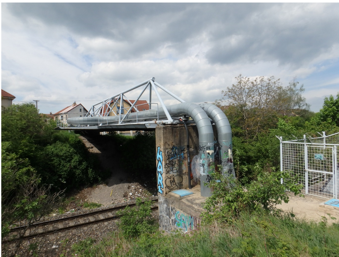
Pohled na přemostění drážního tělesa, v popředí je strop šachty Šp7, po pravé straně kraj oplocení pro uzavěry odbočky do zahrádkářské kolonie
