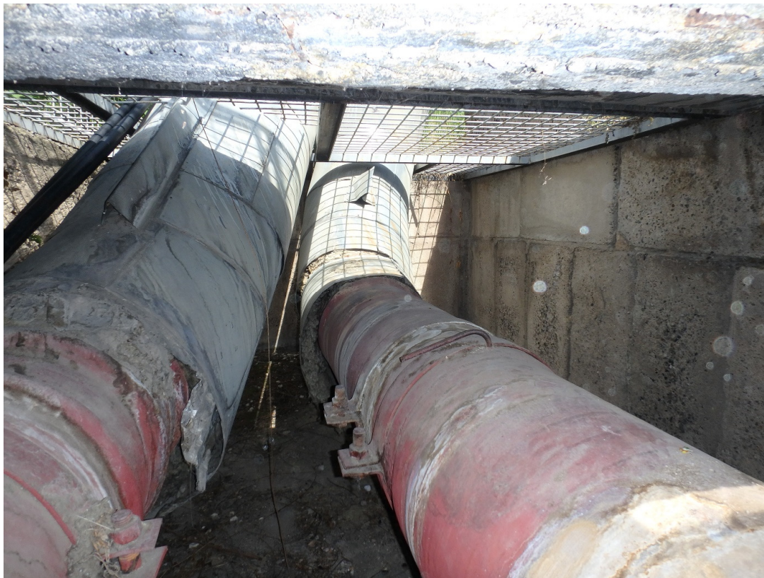
Výstup potrubí 2xDN500 z Šp7
