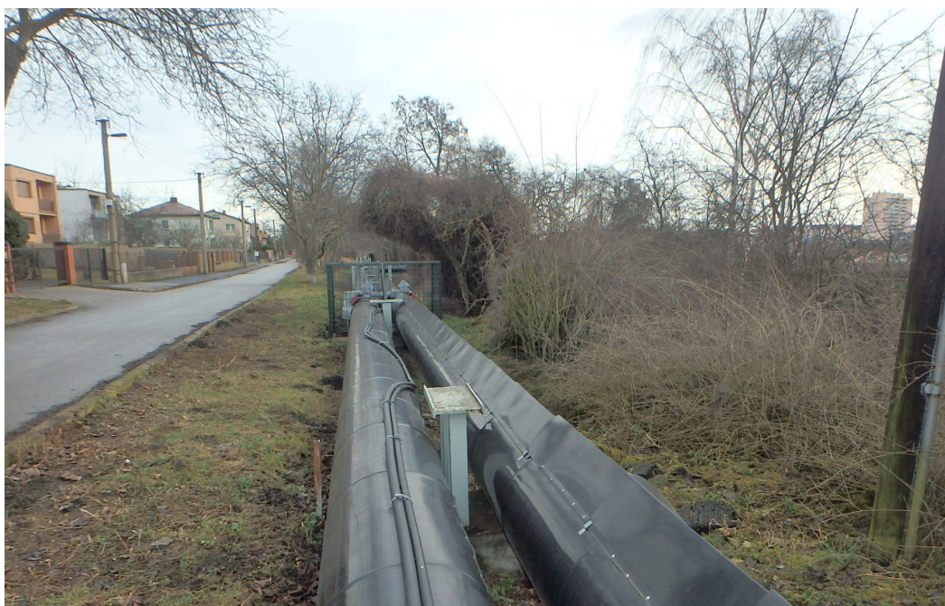
Stávající nadzemní vedení s pohledem na sekční uzávěry
