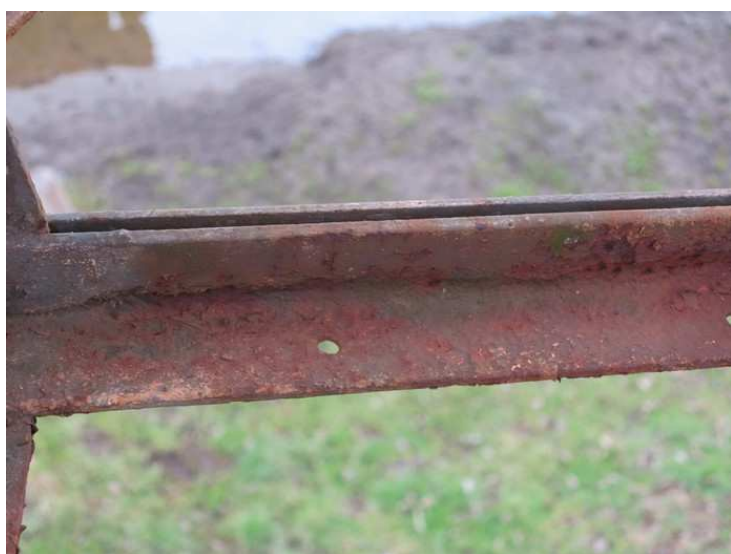
Foto č. 6 K 02 - dolní příčné ztužení, oslabení korozí konců úhelníků
