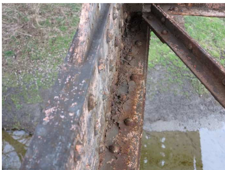
Foto č. 4 K 02 - dolní úhelníky, oslabení korozí
