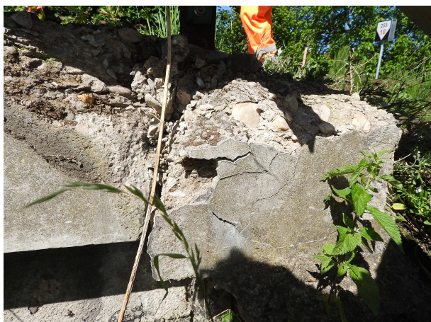
obr. 4: O 01 křídlo vlevo, 1. sloupek - degradovaný beton
