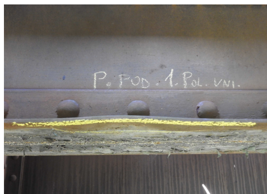
obr. 3: K 01 deformace P podélník 1. pole vni
