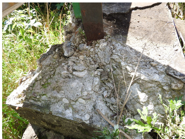
obr. 5: O 01 křídlo vlevo, degradovaný beton římsy
