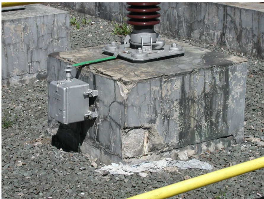
Patka sloupu v rozvodně – značně pokročilá povrchová destrukce betonu zasahující do hlubších vrstev konstrukce
