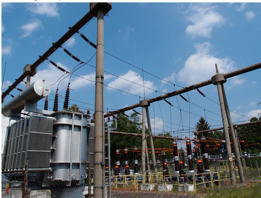
Obr. 12 Transformátor T102 - 110/23 kV TNS Týniště n/O. s převěsy a připojením průchodek 110 kV
