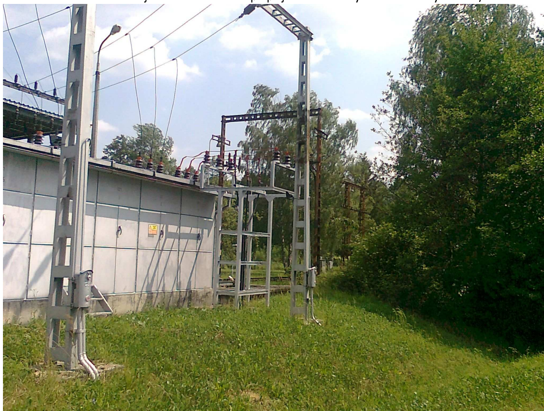
Obr. 13 Přívod kabelů 22 kV od transformátoru T101 k přívodu 1 rozvodny 22 kV
