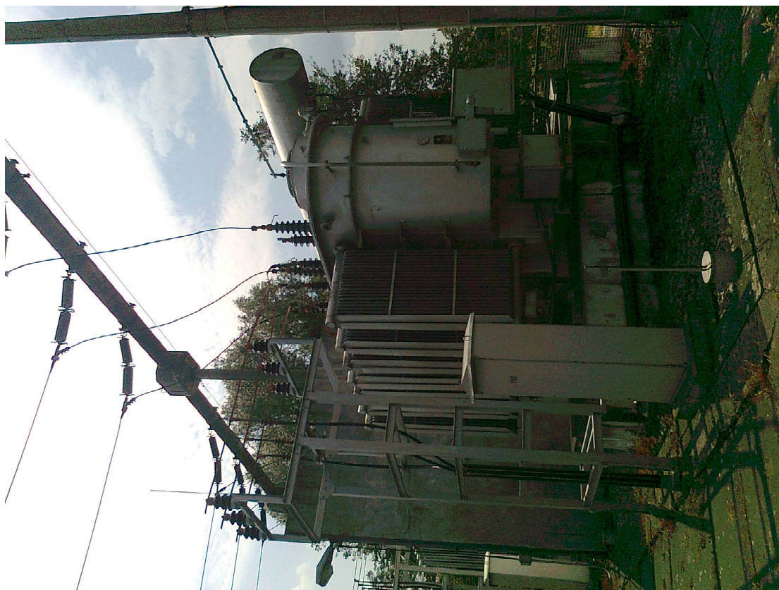
Obr. 11 Transformátory T101 - 110/23 kV TNS Týniště n/O s připojením převěsů na průchodky 110 kV, ocelová konstrukce s pasovým vedením na podpěrkách 22 kV pro kabely 22 kV, ovládací skříň transformátoru a svorkovnicová skříň a skříň pro regulaci napětí umístěné na nádobě transformátoru
