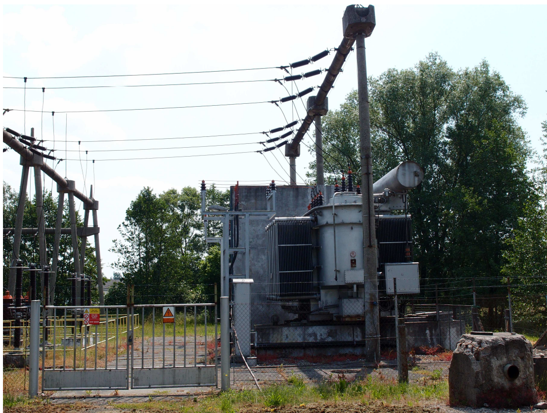
Obr. 9 Převěsy mezi rozvodnou 110 kV a stanovišti transformátorů 110/23 kV s ocelovou konstrukcí pro kabely 22 kV TNS Týniště n/O.
