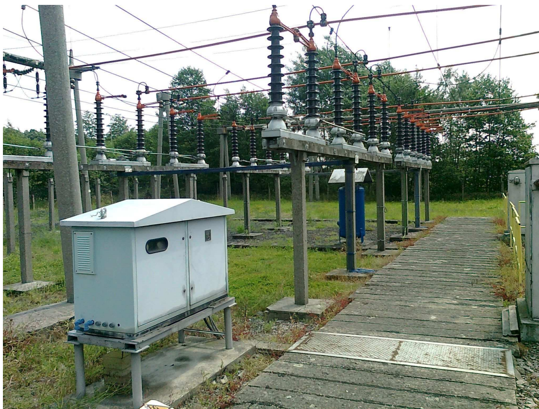
Obr. 5 Odpojovače 110 kV, autonomní kompresorová stanice (AKS), kabelový kanál a tlakovzdušný vzduchojem v rozvodně 110 kV TNS Týniště n/O.
