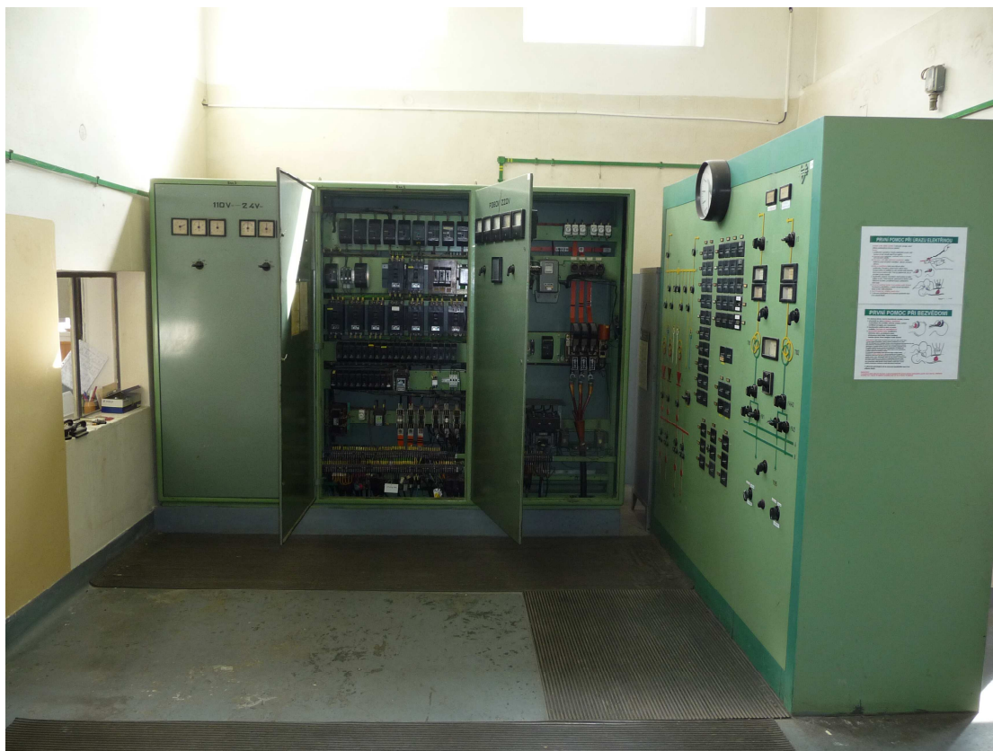
Obr. 19 Rozvaděč vlastní spotřeby a manipulační rozvaděč , vlevo místnost dozorný v provozní budově TNS Týniště n/O.
