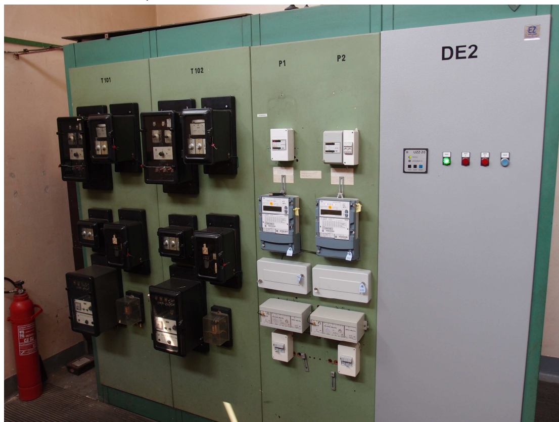
Obr. 19 Rozvaděč vlastní spotřeby a manipulační rozvaděč , vlevo místnost dozorný v provozní budově TNS Týniště n/O.
