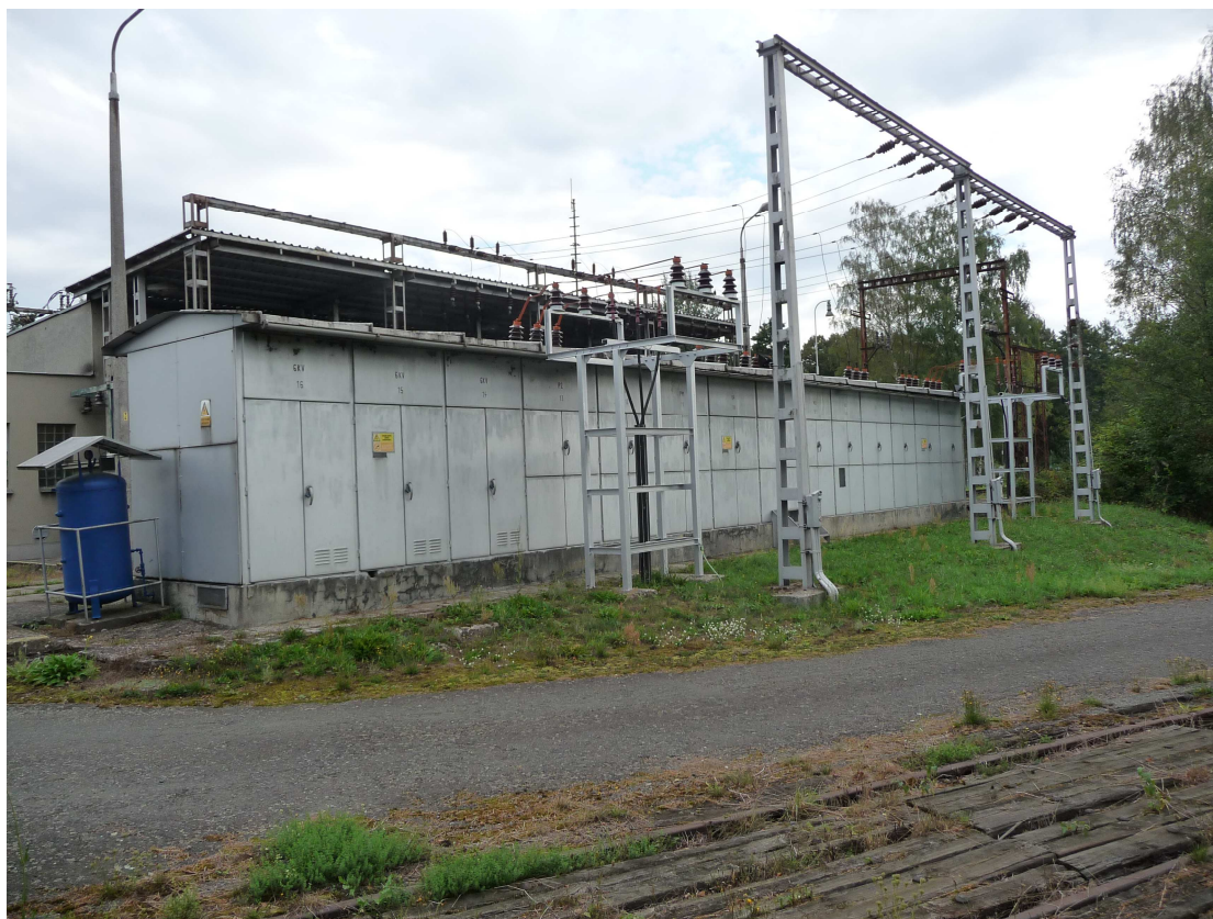
Obr. 15 Celkový zadní pohled na rozvodnu 22 kV s kabelovými přívody
