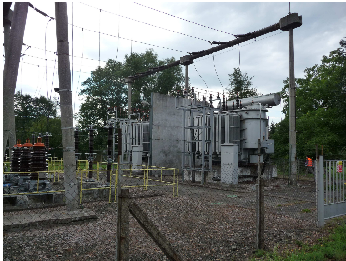
Obr. 9 Převěsy mezi rozvodnou 110 kV a stanovišti transformátorů 110/23 kV s ocelovou konstrukcí pro kabely 22 kV TNS Týniště n/O.
