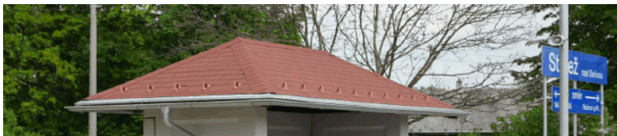
Obrázek 2: Provedení střešní krytiny - Kanadský šindel
