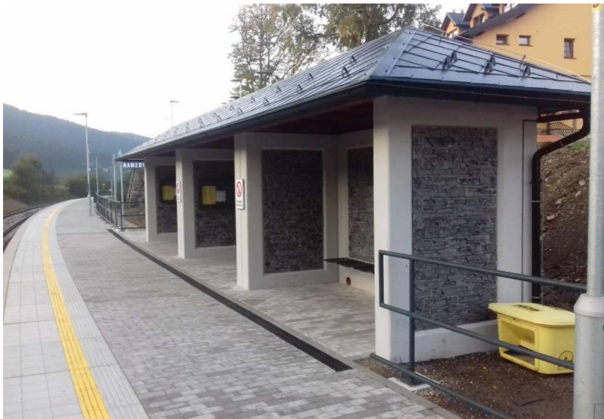
Obrázek 1: přístřešek tvaru „U“ s valbovou střechou; Provedení střešní krytiny - Plechové šablony
