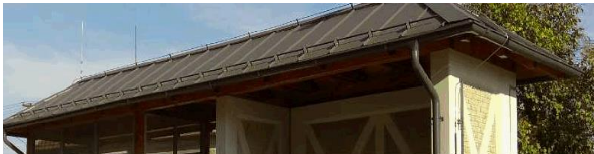
Obrázek 3: Provedení střešní krytiny - Falcovaný plech
