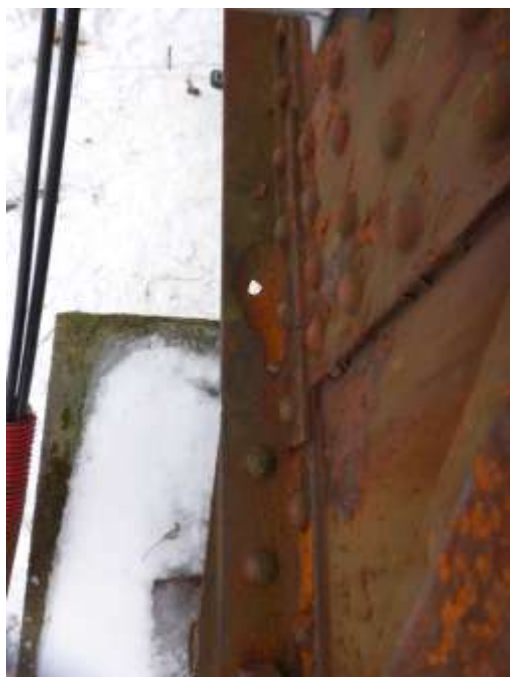
DETAIL A11 (foto 15 až 19 - styk rámu 11 a spodního pasu pole11)
