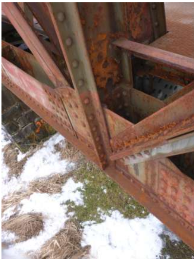
DETAIL B10 (foto 35 až 38 - styk rámu 10 a spodního pasu pole 10 a 11)
