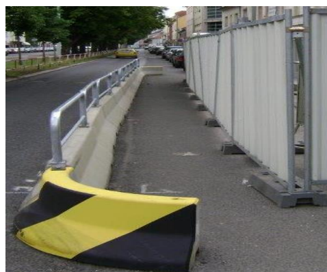
Obr. 10 - Vymezení od silniční dopravy svodidly (betonové/plastové s vodou), patky oplocení nezasahující do provizorní komunikace pro pěší
