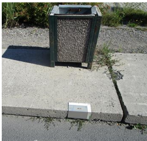
Obr. 2 - Zakrytí úchytů a prostupů betonových panelů (například, provizorní zastávky ND/NAD)
