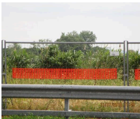
Obr. 12 - Zábrany a oplocení je možné/žádoucí doplnit stavební sítí vhodné barvy (totožné s barvou dočasného orientačního systému) pro lepší orientaci cestujících na staveništi k příchodu/odchodu na/do nástupiště/budovy železniční stanice/zastávky, NAD
