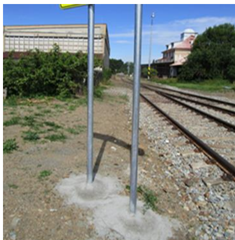
Obr. 5 - Stanovené pevné upevnění výstražné tabule – dočasného (provizorního) přechodu přes koleje
