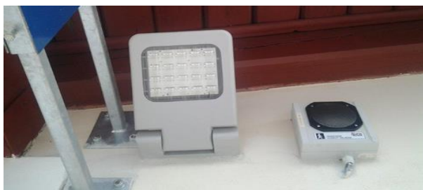
Obr. 13 - Příklad LED svítidla vhodného venkovního prostředí
