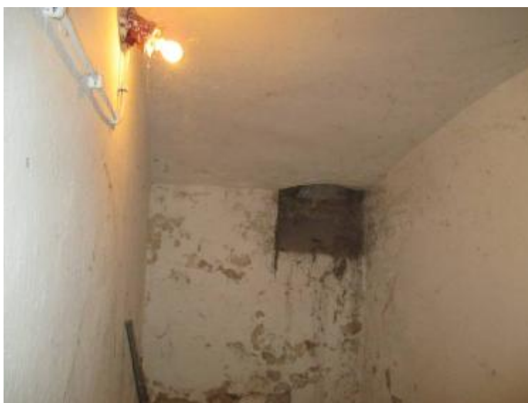
Poškozená omítka ve sklepě
