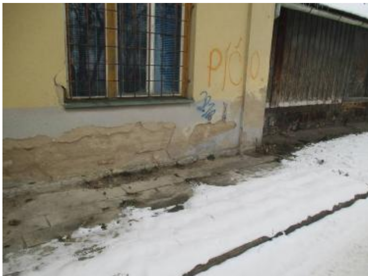
Fasádní omítky poškozené vlhkostí
