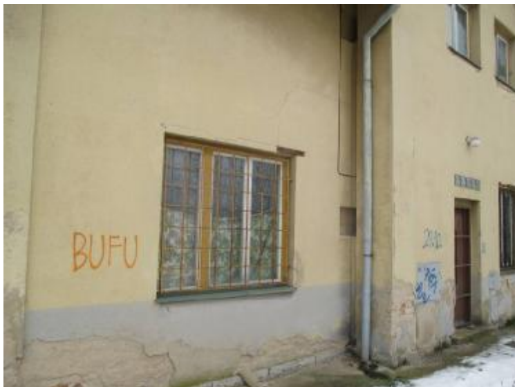
Trhliny u překladu a ve zdivu
