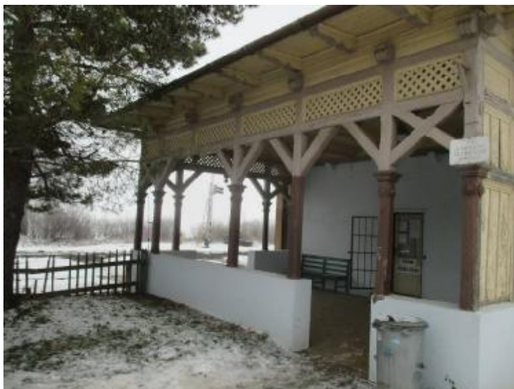
Zazděné dřevěné sloupky přístřešku
