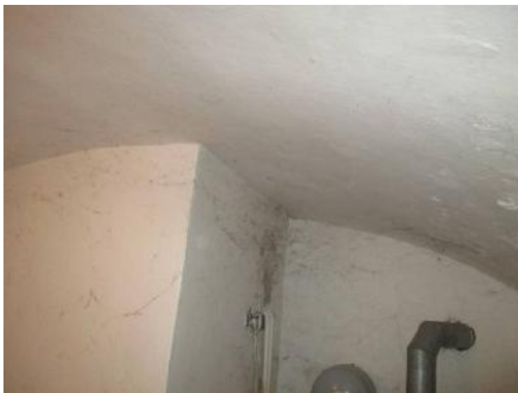
Valená klenba nad sklepem, v rohu sklípek
