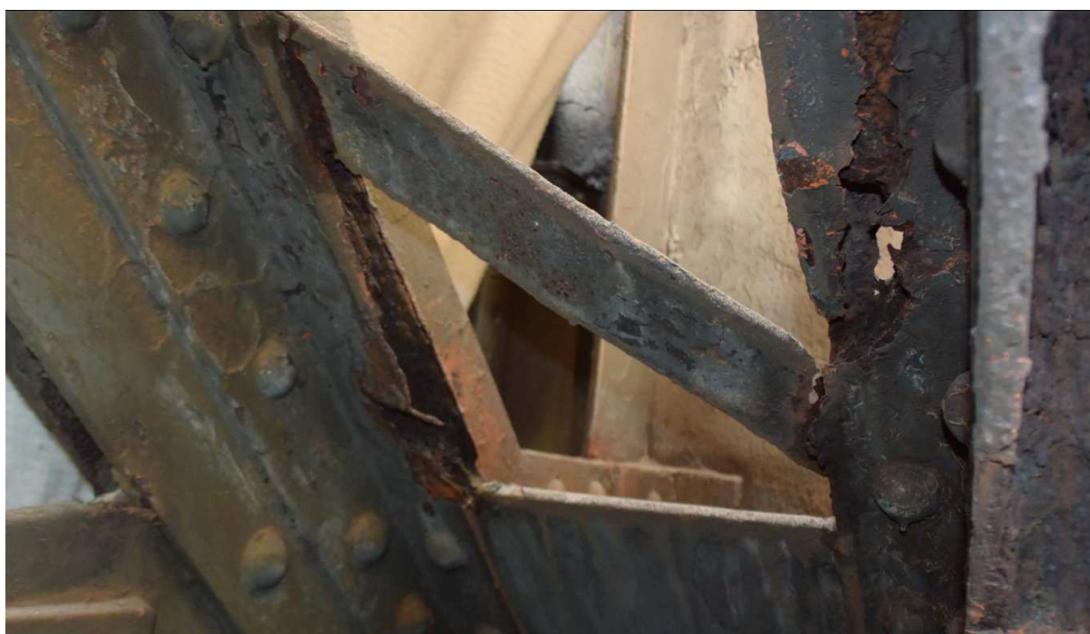
Obr. 10 Typická koroze členěných průřezů svislic
