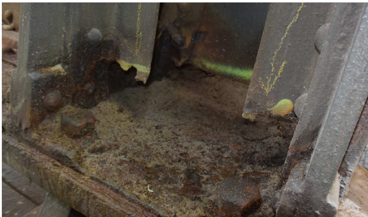
Obr. 19 Typická koroze pod koncovou svislicí – NK2-L-S16
