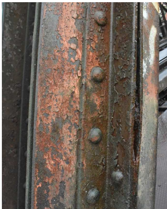
Obr. 1 Typická povrchová koroze
