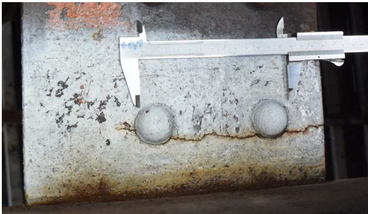
Obr. 21 Trhlina v podélníku– NK1-L2
