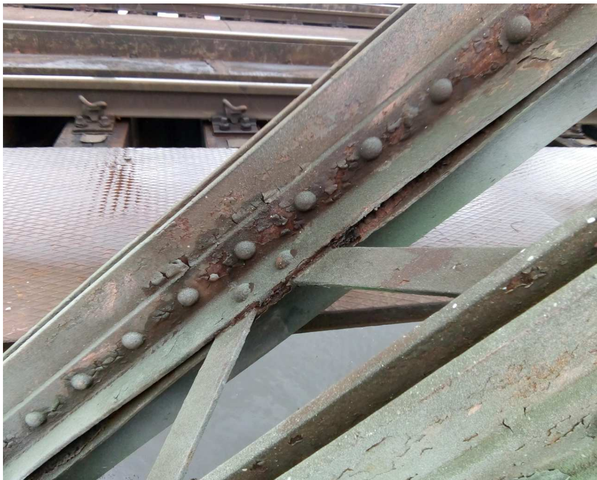
Obr. 8 Typická šěrbinová koroze diagonály
