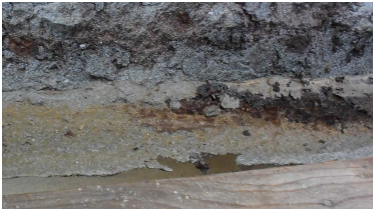
Obr. 13 Typická koroze dolní pás – NK1-L-U1
