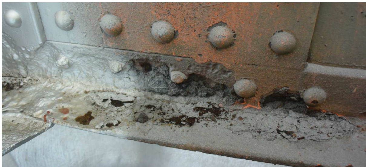
Obr. 17 Typická koroze dolní pas – NK2-L-U15
