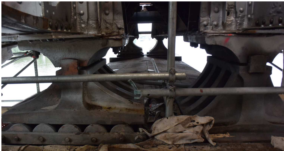
Obr. 23 Mostní ložiska – NK2-L (vpravo), NK3-L (vlevo)
