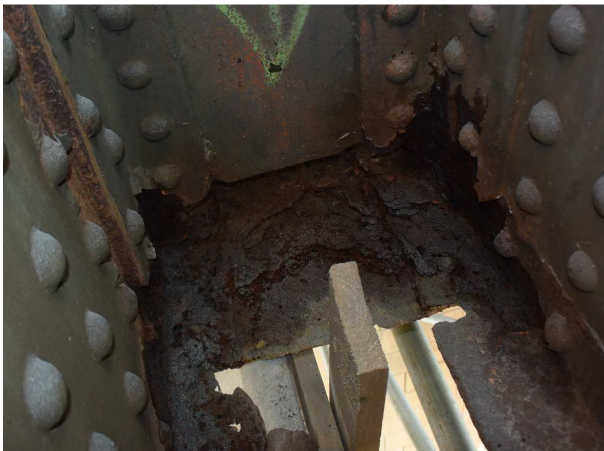
Obr. 18 Typická koroze dolní pas pod svislicí – NK2-L-S15?
