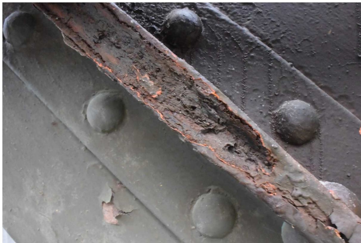
Obr. 2 Typická šterbinová koroze diagonály
