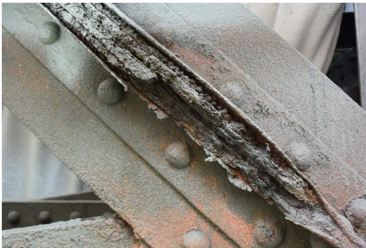
Obr. 6 Typická koroze diagonály – NK1-L-D15
