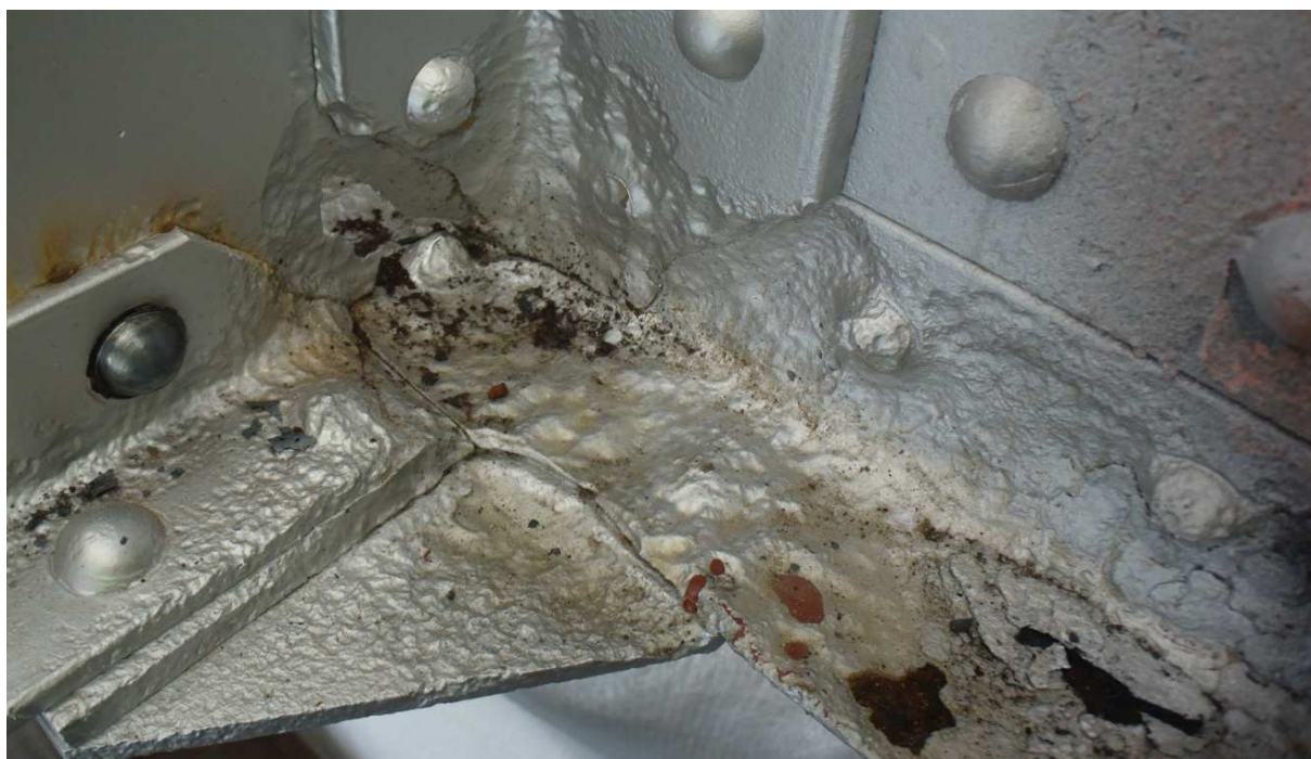
Obr. 16 Typická koroze dolní pas v místě napojení lávky – NK2-L-U15
