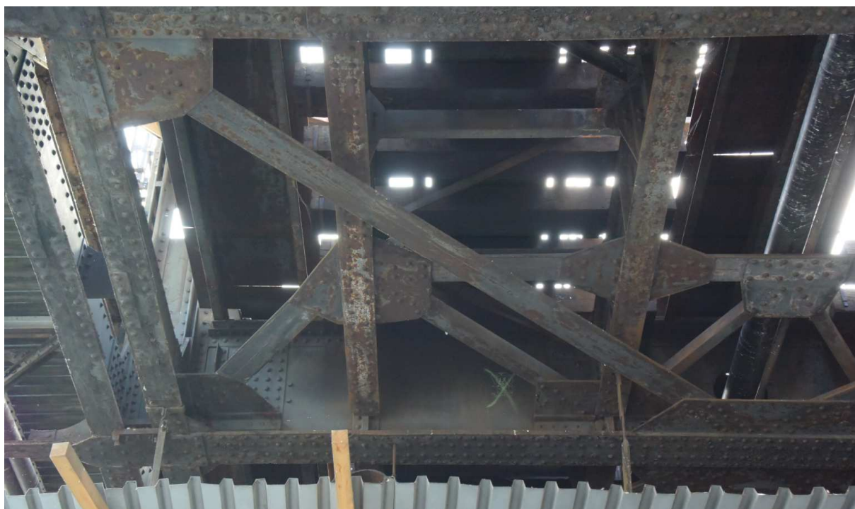
Obr. 32 Pohled z Náplavky na spodní stranu mostu – ztužidla – koncový příčník
