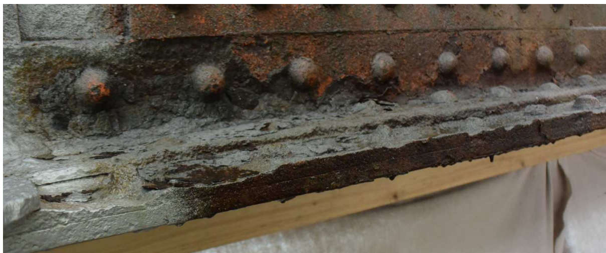
Obr. 15 Typická koroze dolní pas – NK2-L-U13
