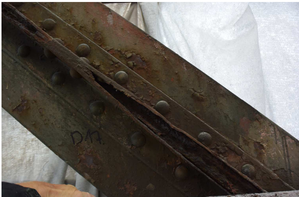
Obr. 5 Typická koroze diagonály – NK1-L-D17
