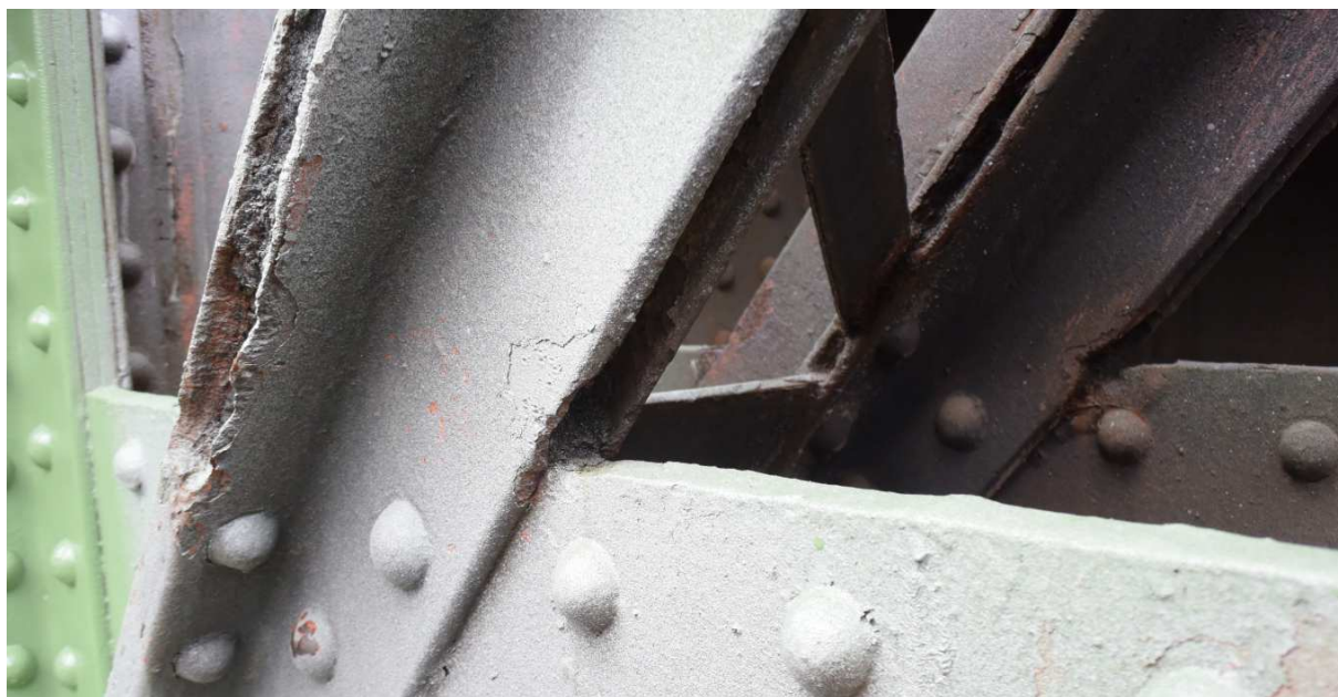
Obr. 7 Typická koroze napojení diagonály na dolní pás – NK3-L-D
