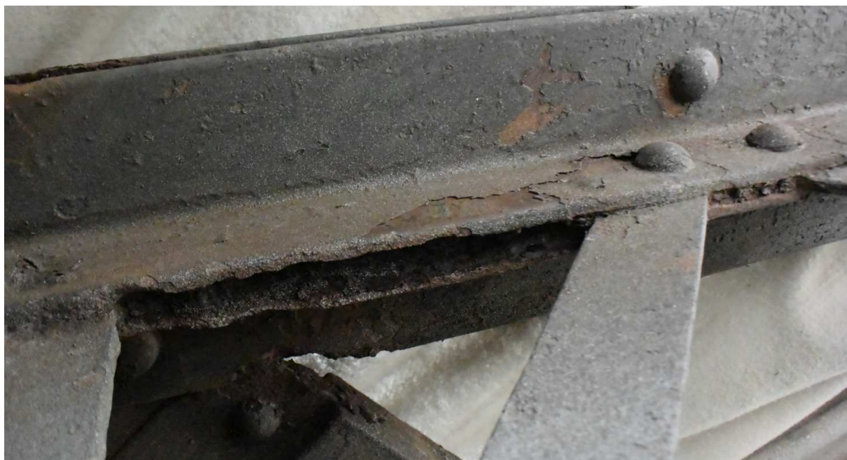
Obr. 9 Typická koroze svislice – NK1-L-S7
