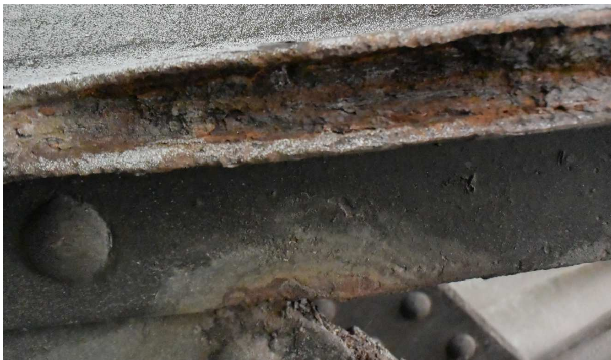
Obr. 3 Typická koroze diagonály – NK1-L-D7 v napojení na dolní pas
