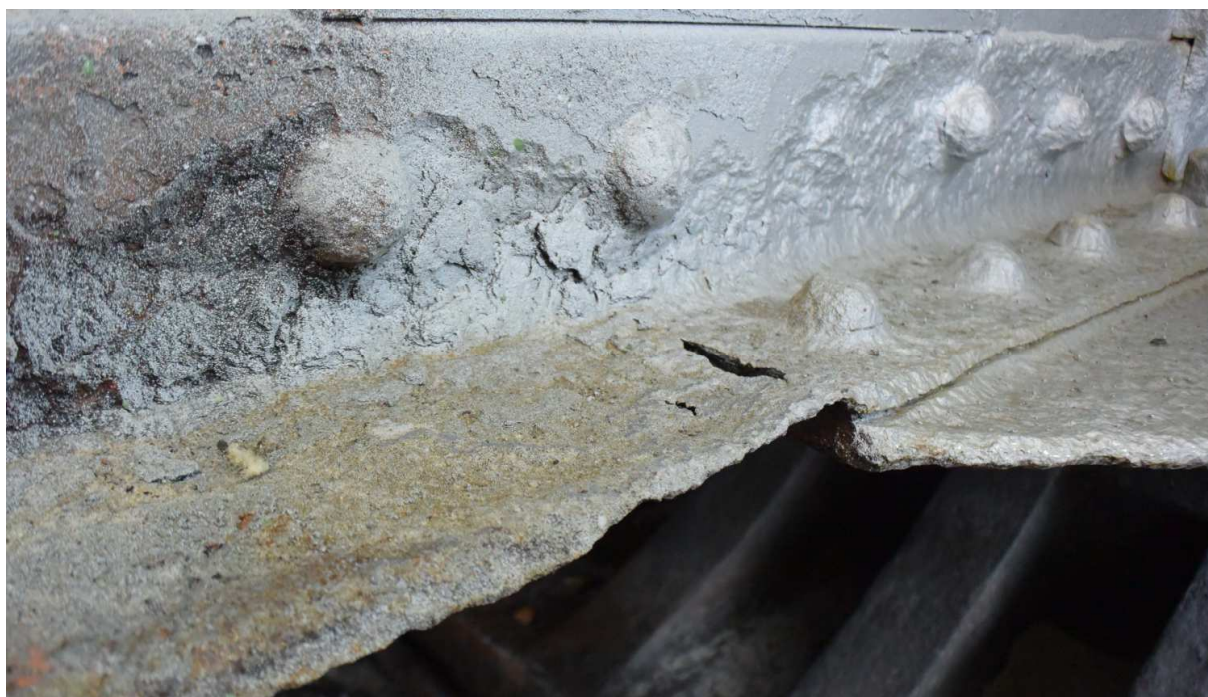
Obr. 12 Typická koroze dolní pás – NK1-L-U1
