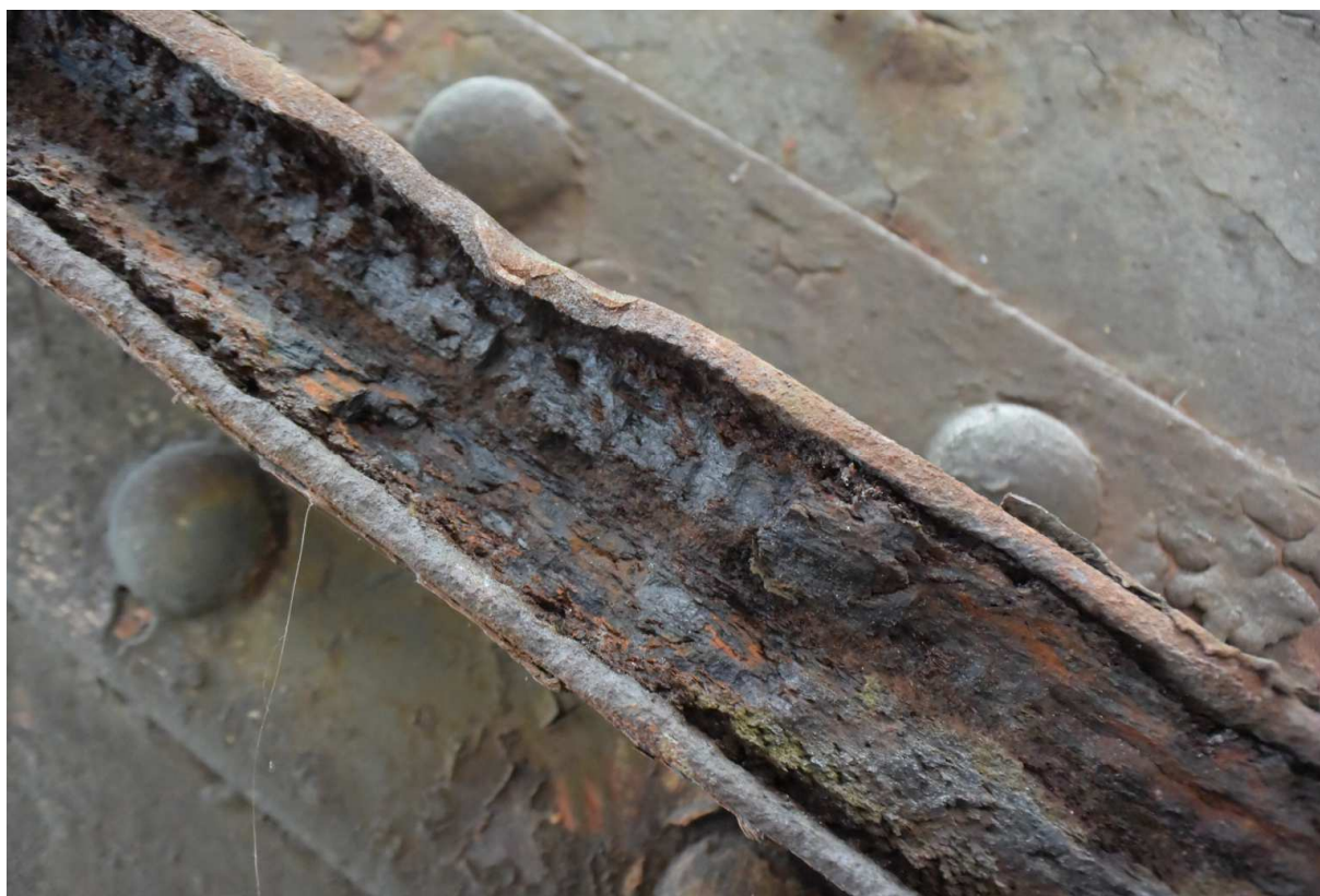
Obr. 4 Typická koroze diagonály – NK1-L-D17
