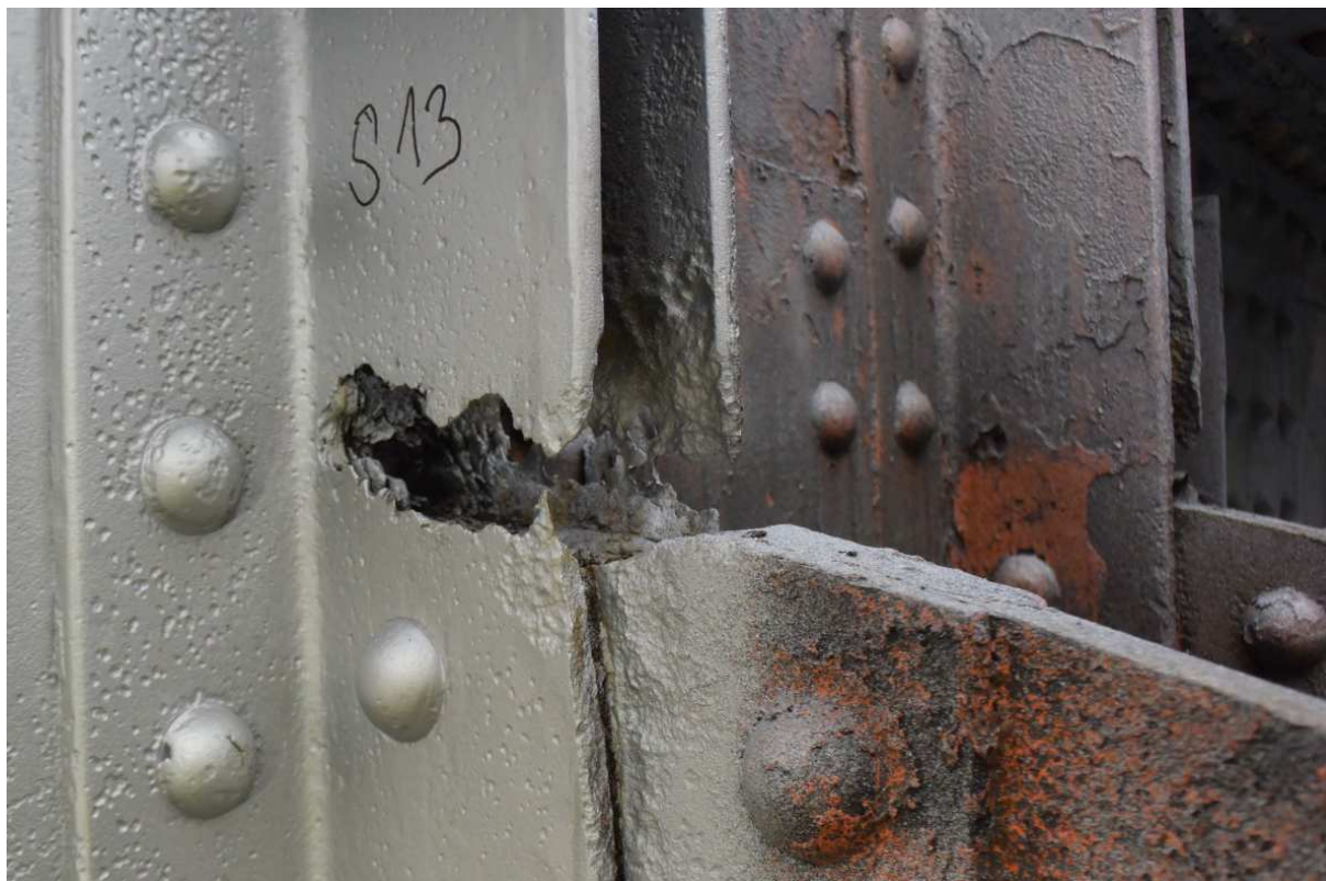
Obr. 11 Typická koroze v místě napojení svislice na dolní pás – NK1-L-S13
