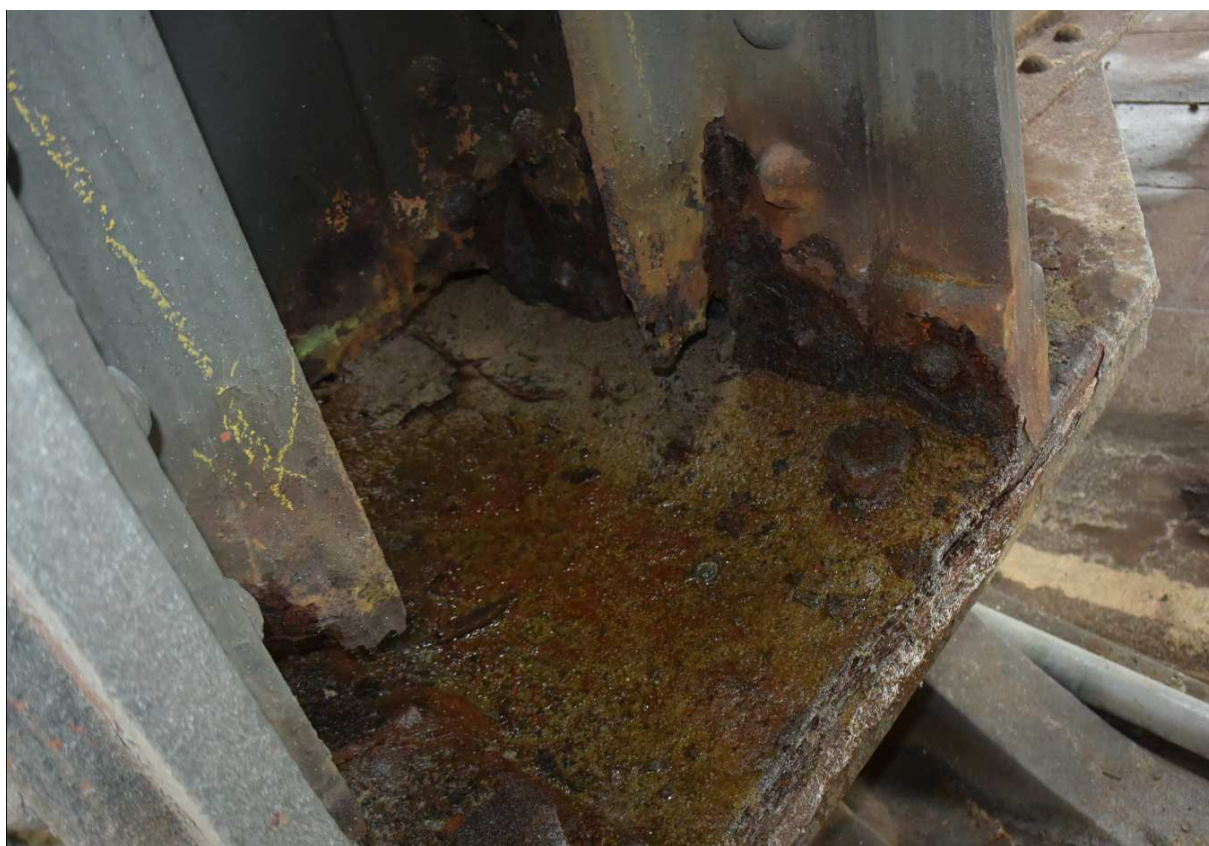
Obr. 20 Typická koroze pod koncovou svislicí – NK3-L-S0
