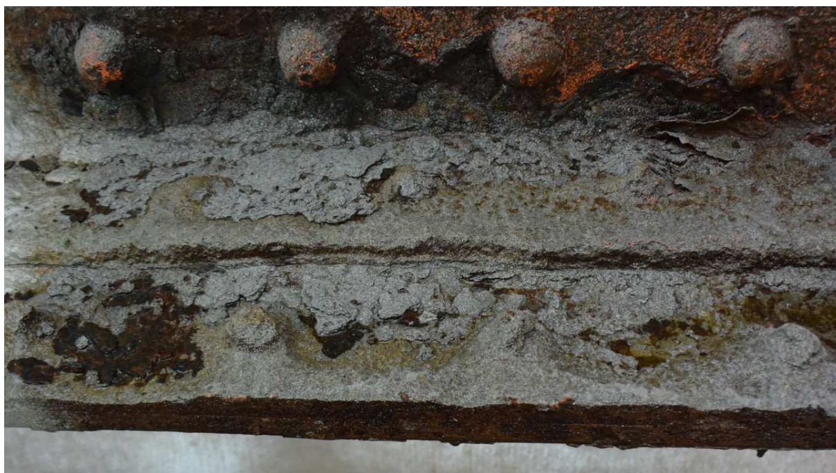
Obr. 14 Typická koroze dolní pás – NK2-L-U13
