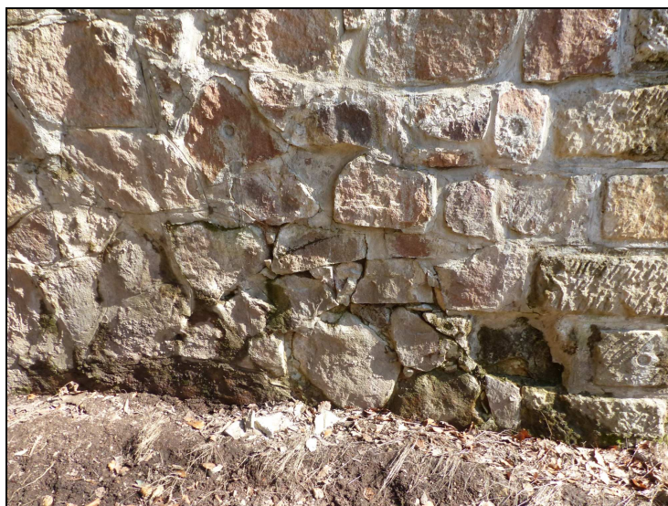
Foto č. 6 O 02 Opěra Průsaky a degradace zdiva v patní části opěry vpravo
