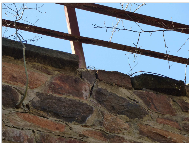
Foto č. 5 Konstrukce K 03 - odlomená římsa na pravé straně u pátého zábradelního sloupku
