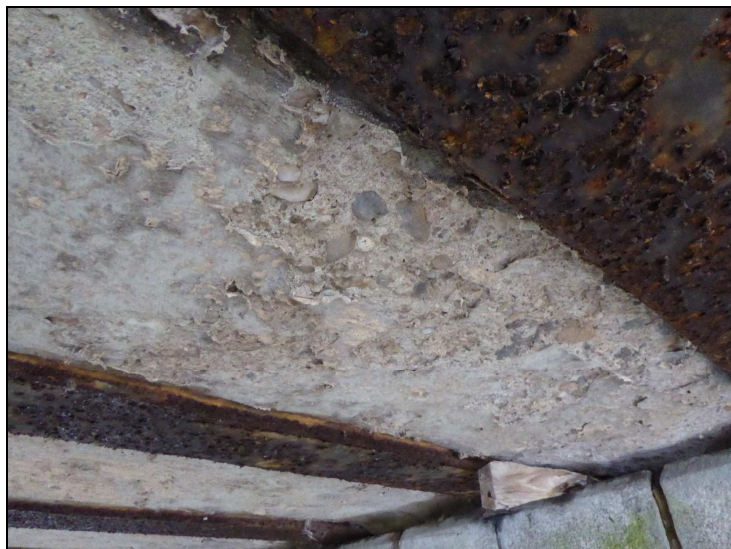
1. K 01 – degradace betonu z podhledu mezi ZN
