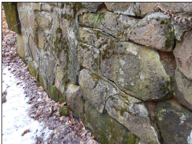
5. O 01 křídlo vpravo – vysunutí zdiva v dolní části
