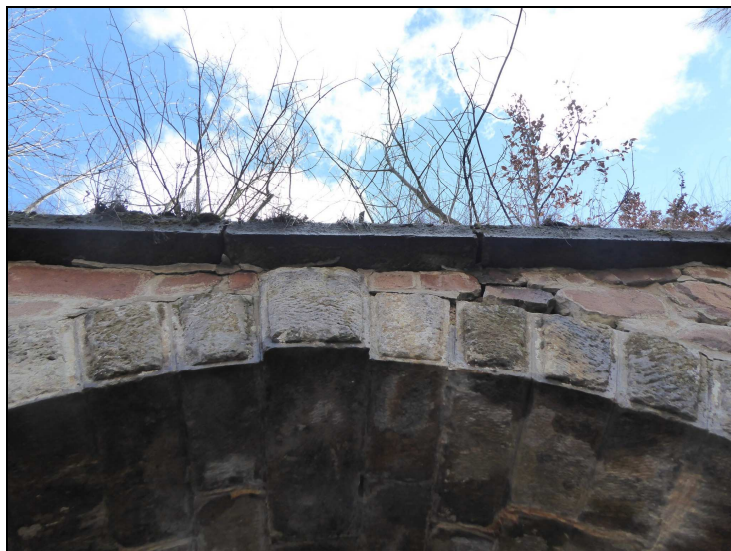
4. K 01 římsa vlevo – vysunutí v celé délce
