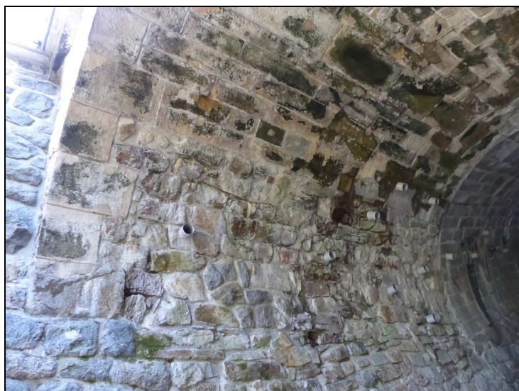
Foto č. 2 Konstrukce K 01 Průsaky vody a výluhy pojiva v konstrukci K 01 nad O 02 díl 1.
