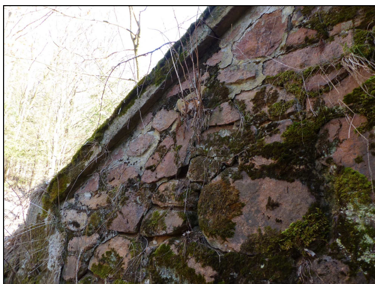
Foto č. 3 O 02 křídlo opěry vlevo Stupňovitá trhlina po spárách s vypadaným spárováním.
