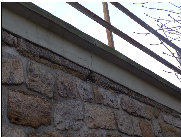
Obr. č. 1 – K 01 římsa vlevo nad vrcholem klenby – rozvětvená trhliny
