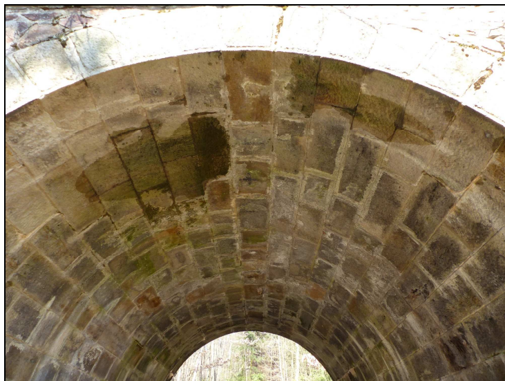
Foto č. 1 Konstrukce K 01 Průsaky s výluky pojiva
