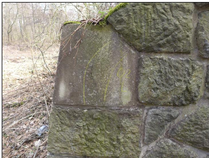
5. O 02 křídlo vlevo – prasklý betonový patní kámen
