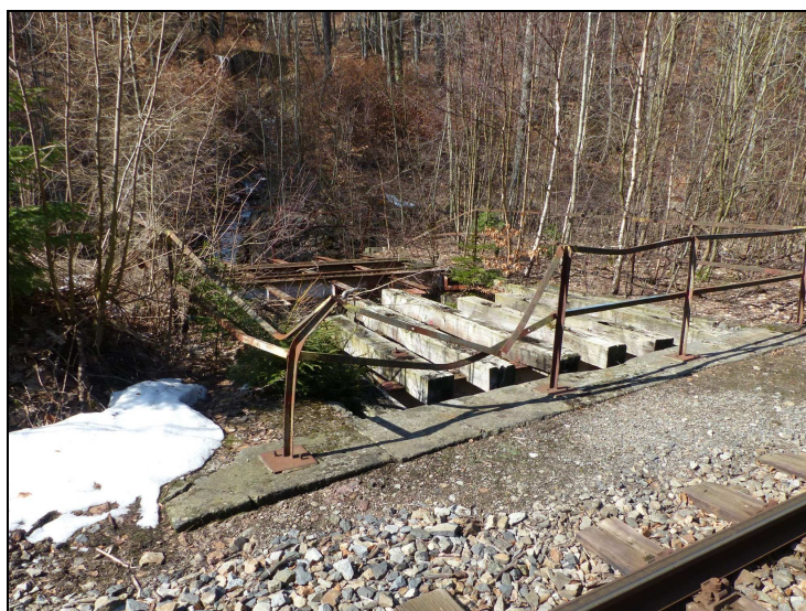
Foto č. 6 K 03 zábradlí vlevo – deformace prvního sloupku, madla a příčle v prvním poli a madla v druhém zábradelním poli
