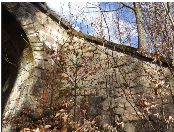
6. O 02 křídlo vpravo – stupňovité trhliny pod římsou
