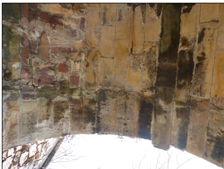
Foto č. 1 Konstrukce K 01 – Podélná trhлина za věncem klenby vpravo přecházející do O 02
