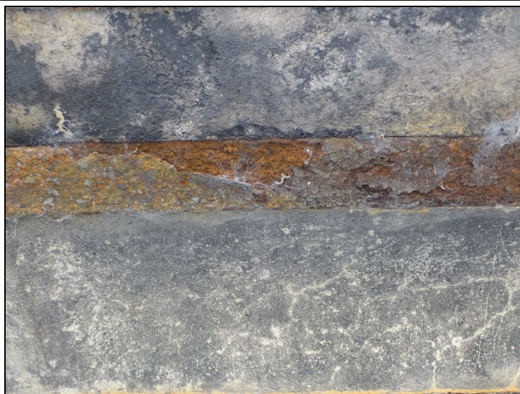
3. K 01 podhled – nárůst koroze dolních přírub ZN
