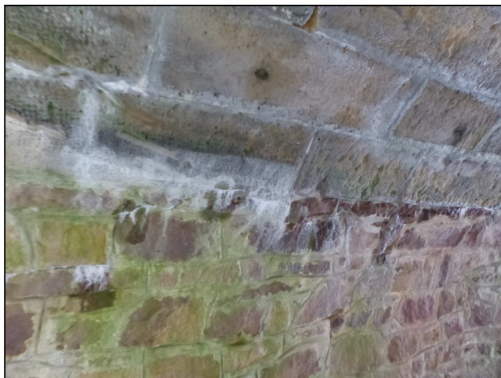
Foto č. 4 Konstrukce K 03 - průsaky vody s výluhy pojiva nad O04 (vlevo)
