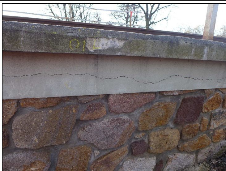
Obr. č. 2 – K 01 římsa vlevo nad O 01 – vodorovná trhлина z čela
