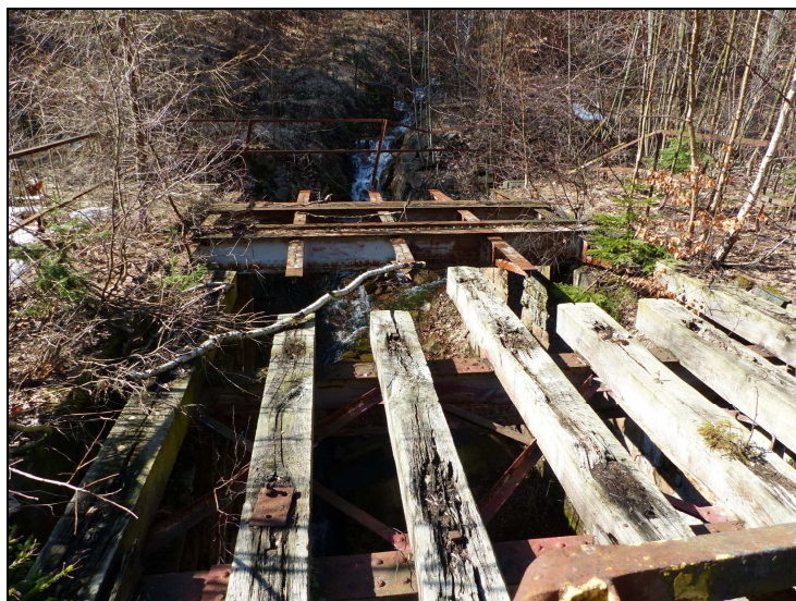
Foto č. 1 Konstrukce K 01 a K 02 – chybějící koleje a podlahy, hniloba mostnic K 02
