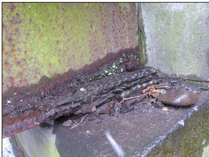
2. K 01 – silně orezivé ložisko na O 01 vlevo
