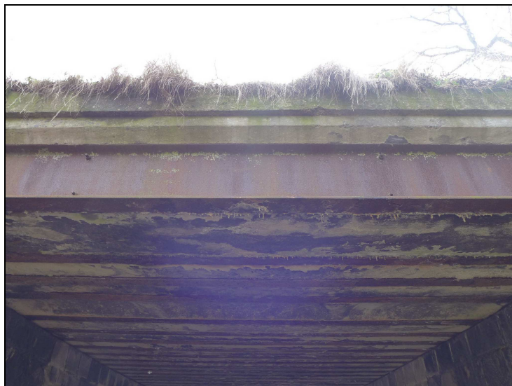
1. K 01 vlevo – průsaky vody s tvorbou krápníčků
