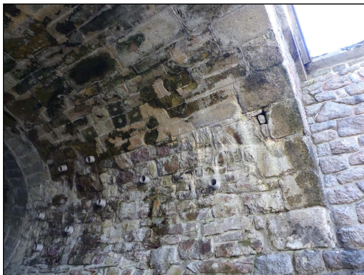
Foto č. 1 Konstrukce K 01 Průsaky vody a výluhy pojiva v konstrukci K 01 nad O 01 díl 1.
