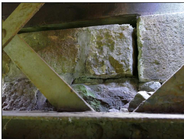
Obr. č. 5 – Opěra O 02 – závěrná zeď – vypadané spárování
