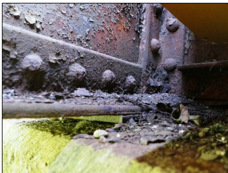
Obr. č. 2 – Konstrukce K 01 – korozní oslabení dolního vnitřního krčního úhelníku pravého hlavního nosníku na začátku
