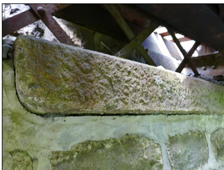
Obr. č. 6 – Opěra O 02 – úložný práh – uvolněný kvádr
