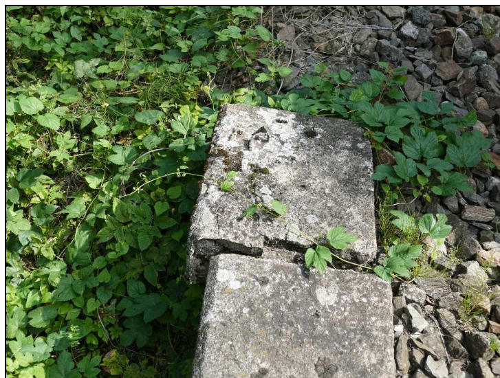
Obr. č. 4 – Opěra O 01 – křídlo vpravo – vysunutý římsový kvádr
