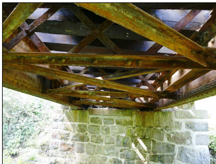
Obr. č. 1 – Konstrukce K 01 – porušená PKO, koroze
