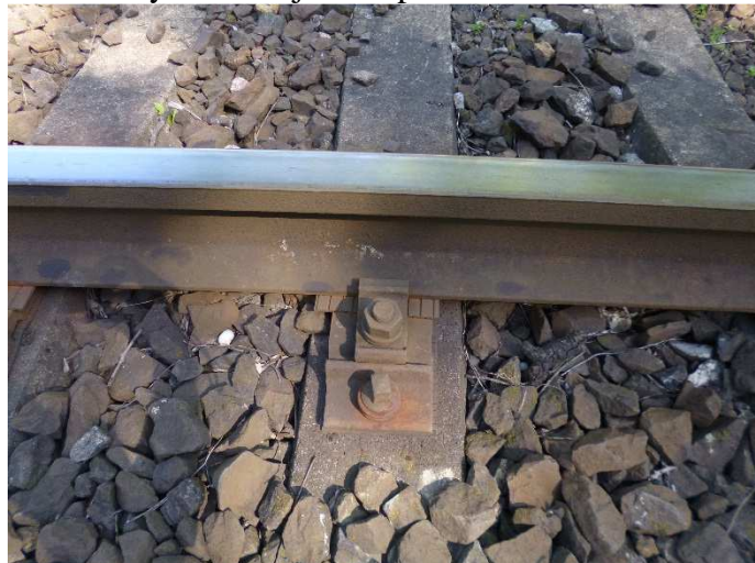
Obrázek č. 16: Pohled na uchycení kolejnice v profilu místa měření M3
