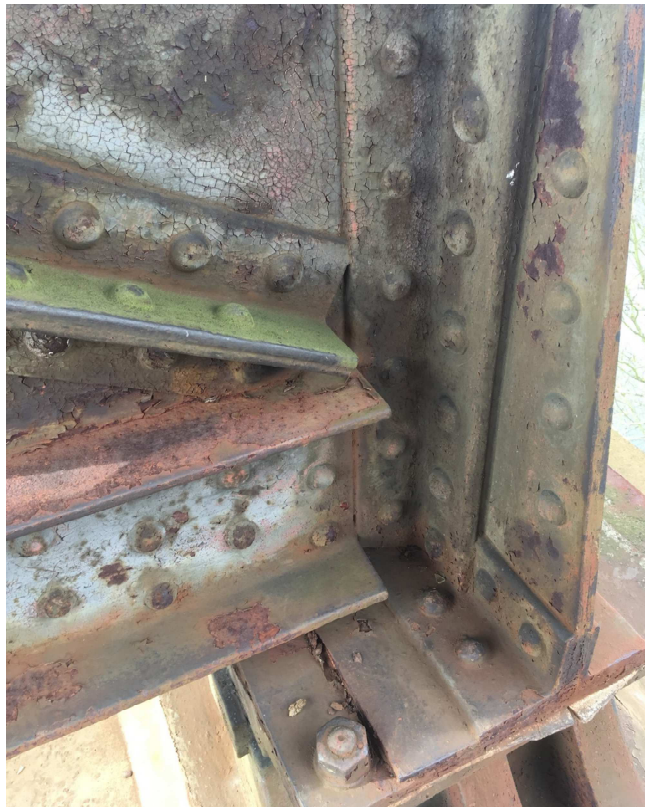
Obrázek 29 Detail pevného ložiska a ocelové konstrukce na pilíři P2
