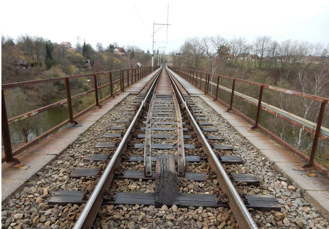
Obrázek 4 Konec pojistných úhelníků za závěrnou zdí na pilíři P3
