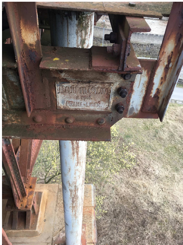
Obrázek 30 Pohled na pilíř P2, zde lze vidět pevné ložisko, sloup trakčního vedení a označení výrobce, detail uložení chodníkového plechu a detail uchycení zábradlí
