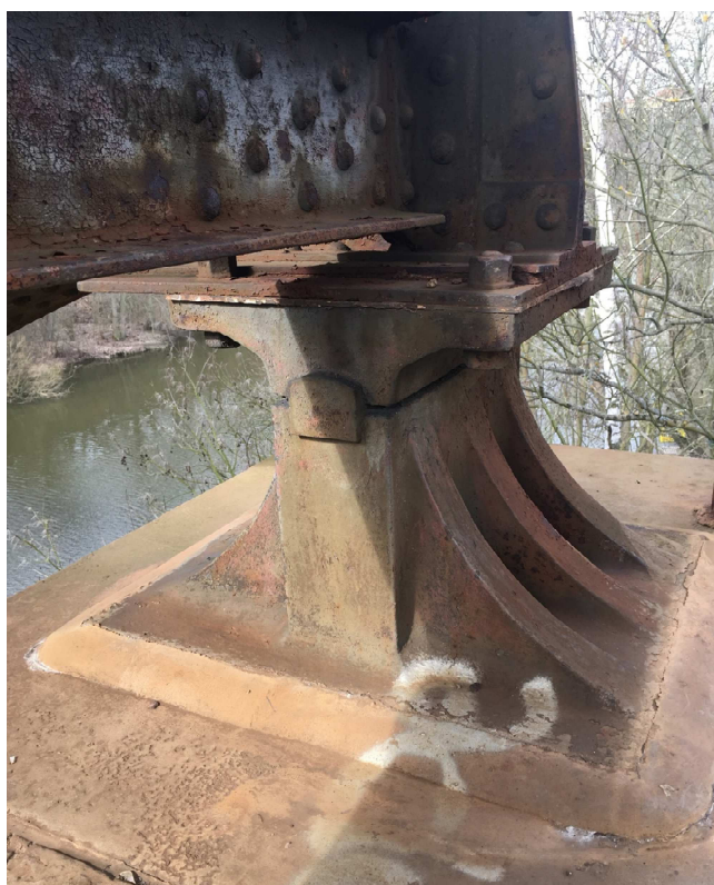
Obrázek 28 Pohled na pevné ložisko uložené na pilíři P2 a jeho dobrý stav
