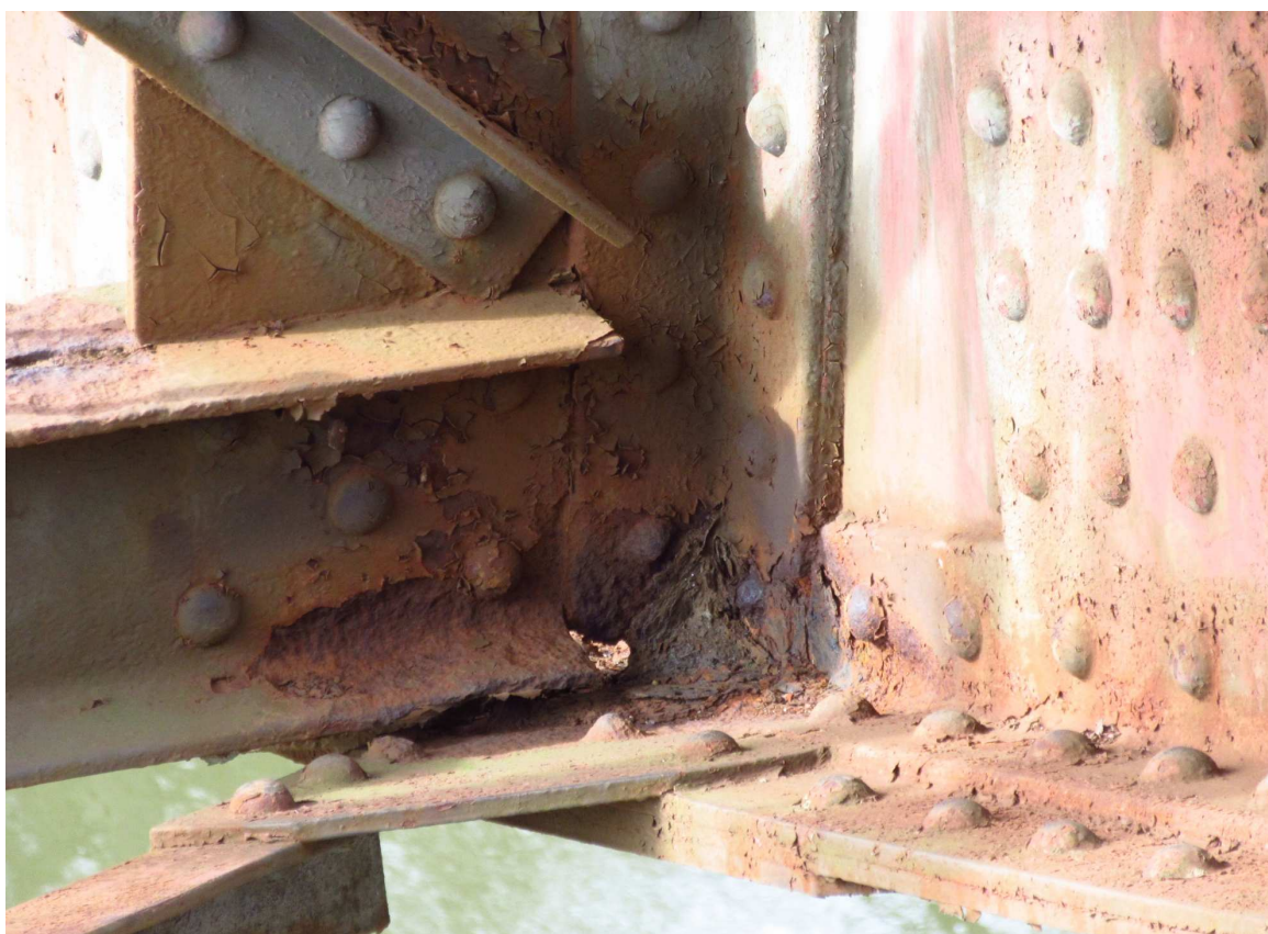
Obrázek 22 Detail dolního styčnicku ocelové konstrukce K03 při pohledu z pilíře P3, na kterém je patrná značná koroze
