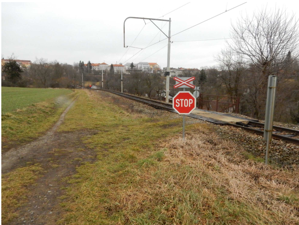
Obrázek 11 Křížení trati s účelovou komunikací v km 1,463 (P6296) zabezpečené výstražným křížem
