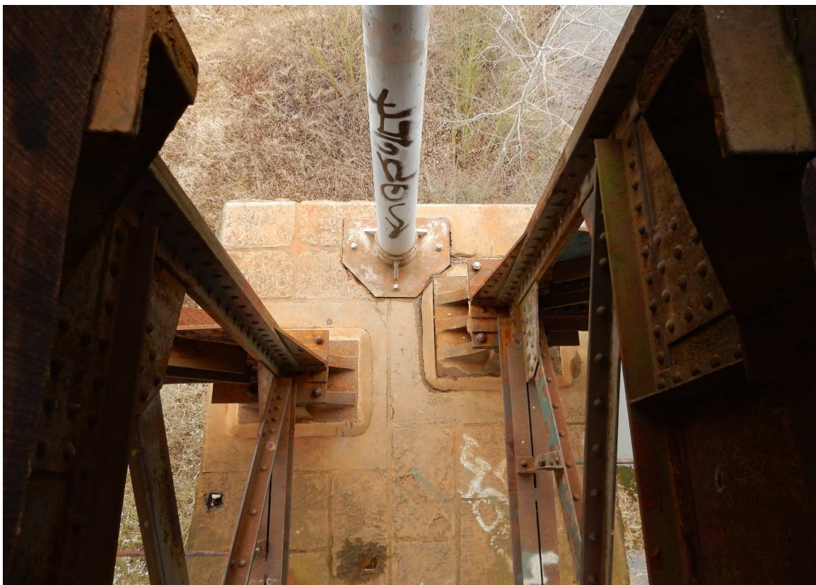
Obrázek 6 Pohled na pevná ložiska obou ocelových konstrukcí, která se nacházejí na pilíři P2. Dále je zde vidět ukotvení stožáru trakčního vedení pilíři
