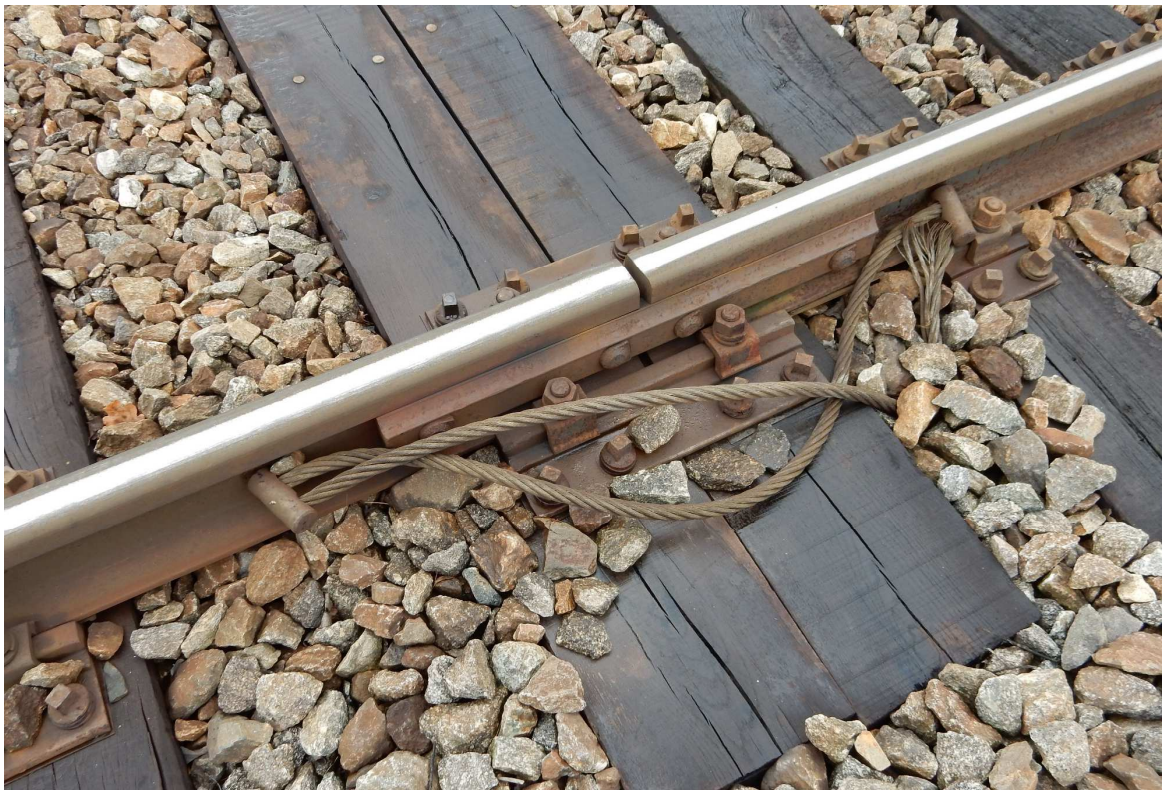
Obrázek 10 Pohled na dilatační styk kolejnic. Zde je použito upevnění sestavy KS na dřevěném pražci
