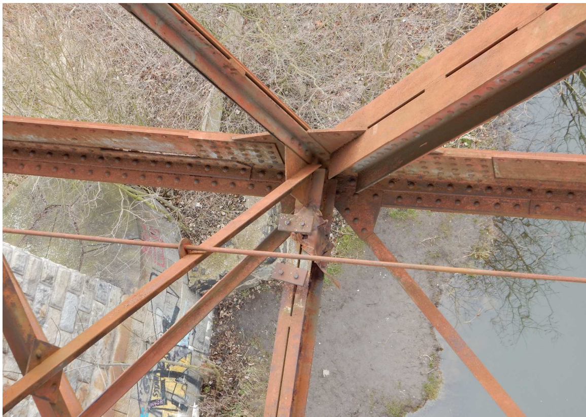
Obrázek 25 Detail spoje ocelové příhradové konstrukce v blízkosti pilíře P2; na příčniku jsou patrné zbytky původní dřevěné revizní lávky
