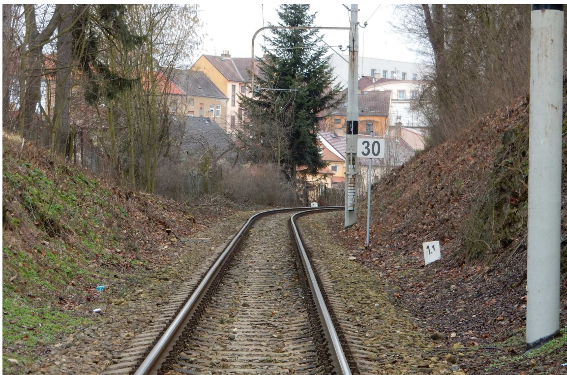
Obrázek 19 Pohled na trať od mostu směrem k žst. Tábor a na sloupy trakčního vedení (koncový kotevní stožár č.13 pro úsek TV za mostem)
