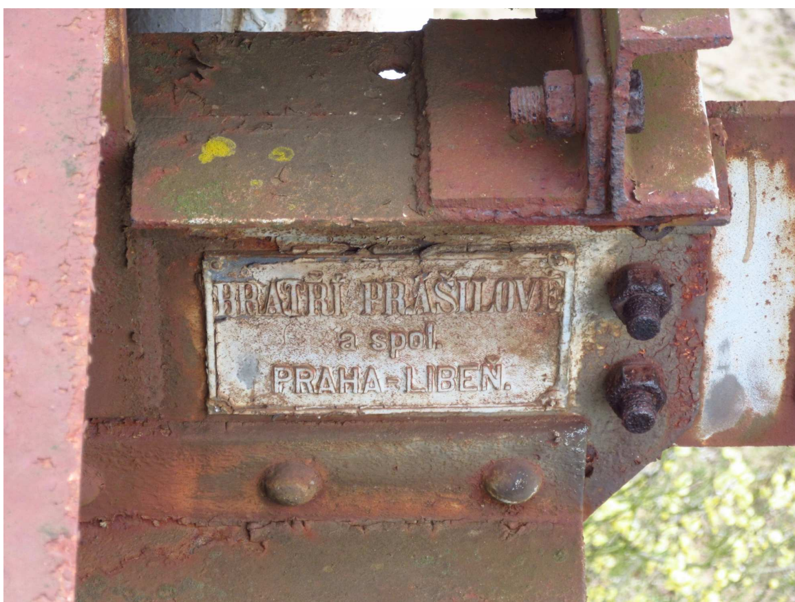
Obrázek 244 Detail označení výrobce na ocelové konstrukci včetně uchycení zábradlí
