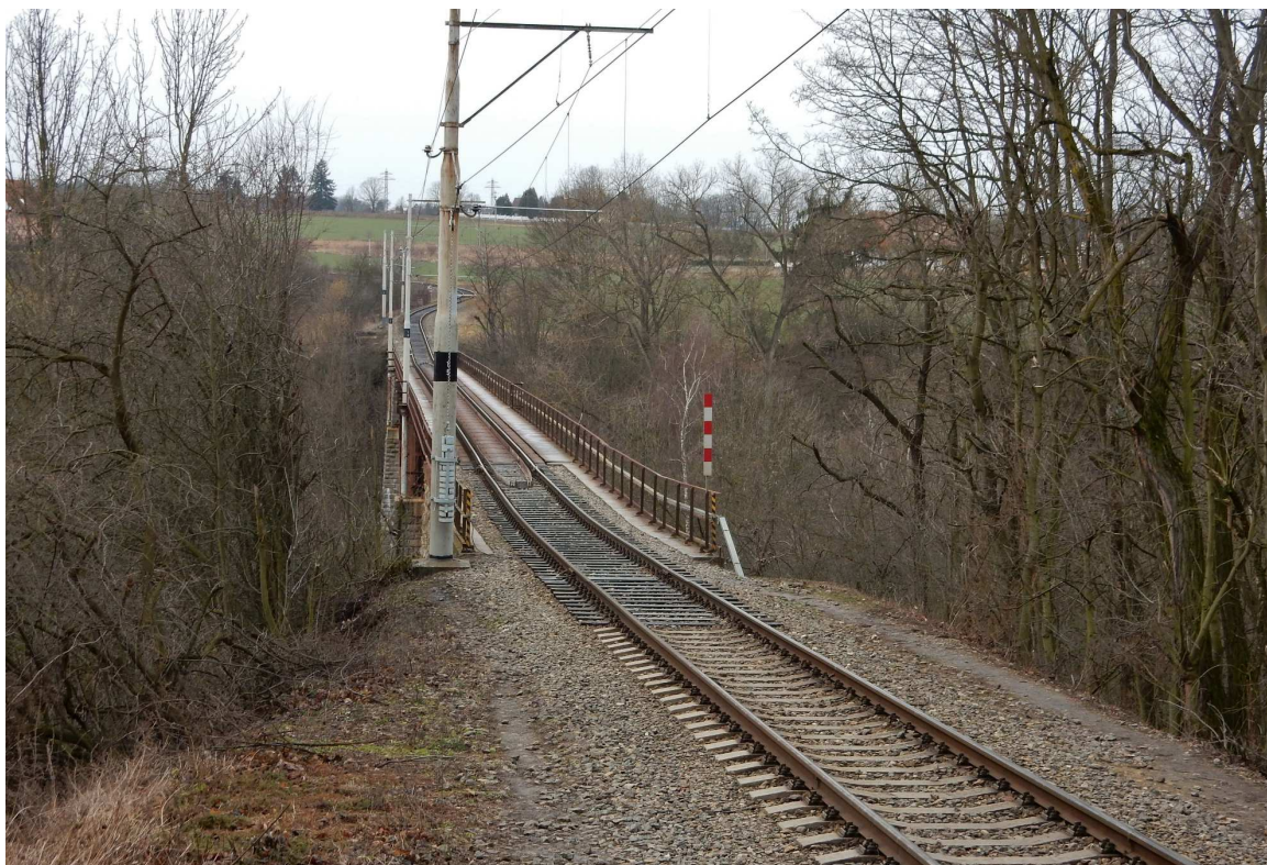
Obrázek 3 Pohled na most od žst. Tábor. Patrný je zde předěl mezi betonovými pražci SB5 a dřevěnými pražci
