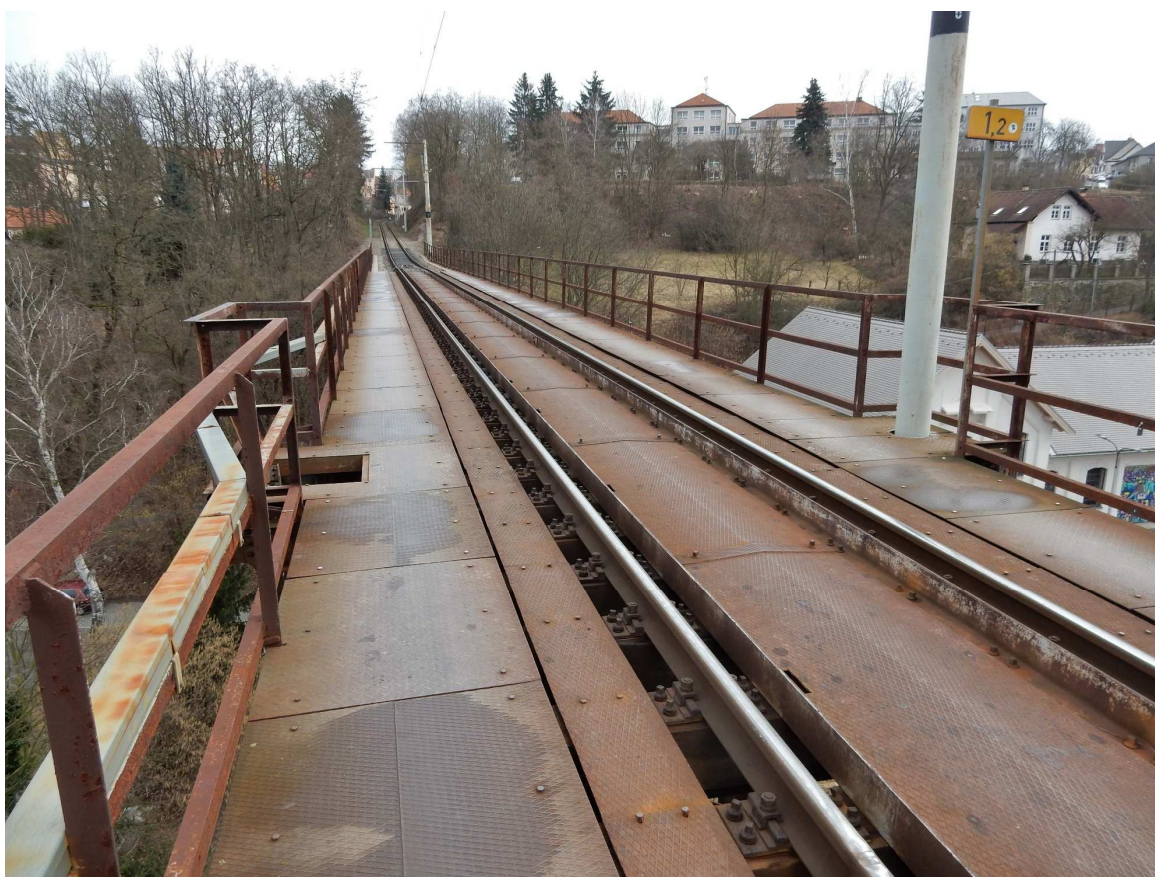
Obrázek 8 Revizní přístup na pilíř P2
