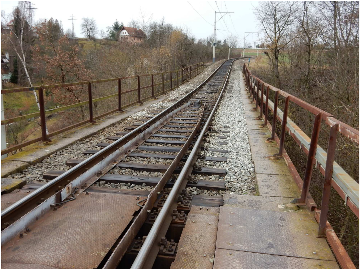
Obrázek 9 Konec pojistných úhelníků, pohled směr Bechyně
