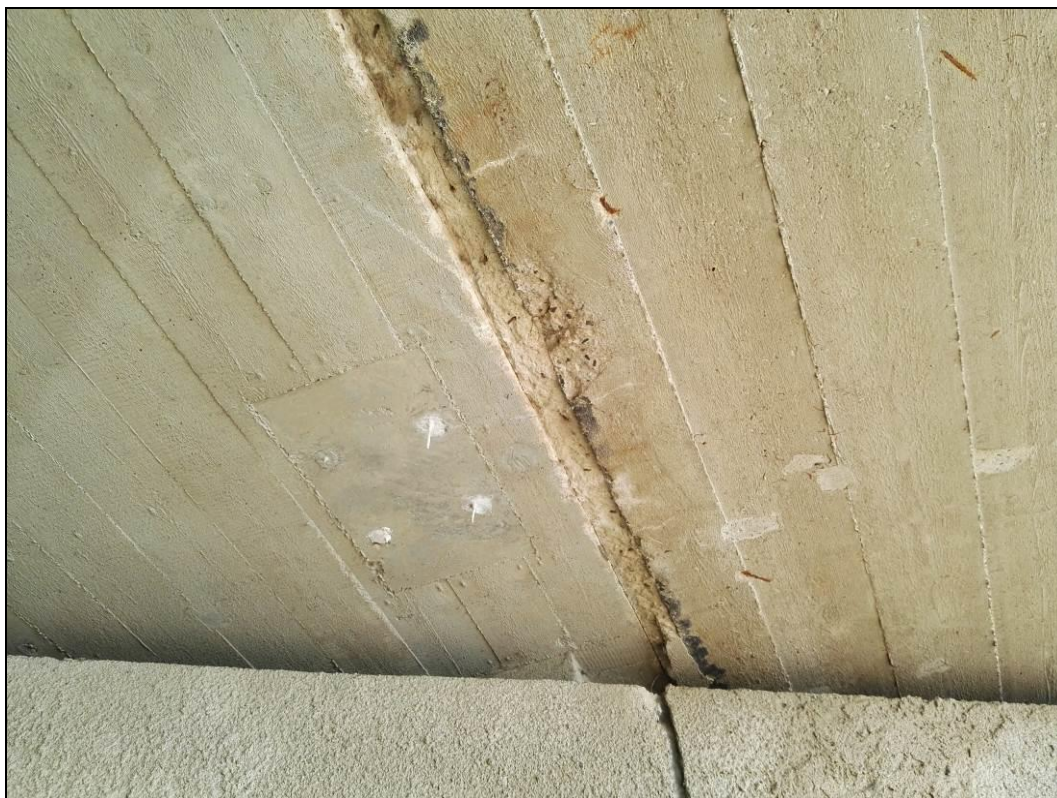
Obr. č. 10 - pohled na dilatační spáru NK.
