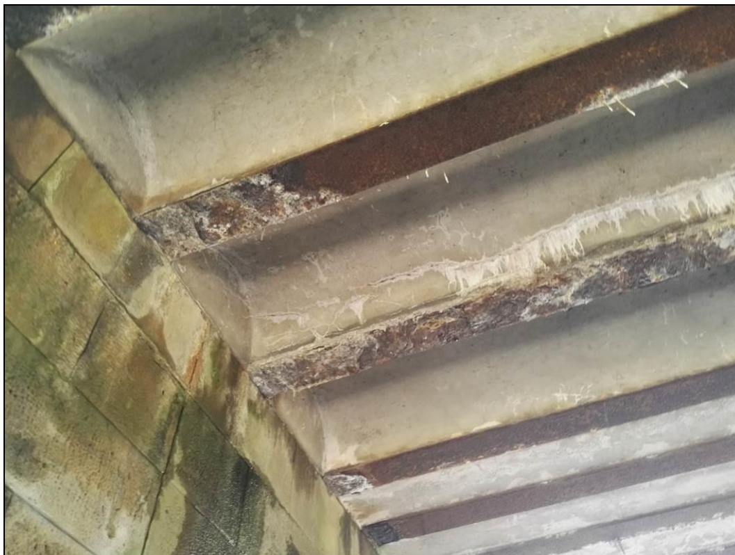
Obr. č. 15 - charakteristický pohled na hloubkovou korozi ocelových nosníků.
