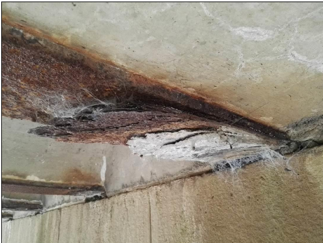
Obr. č. 14 - charakteristický pohled na hloubkovou korozi ocelových nosníků.
