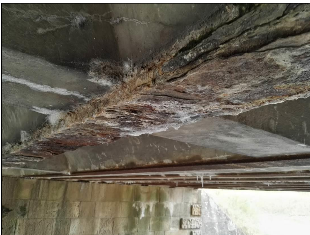
Obr. č. 12 - charakteristický pohled na hloubkovou korozi ocelových nosníků.
