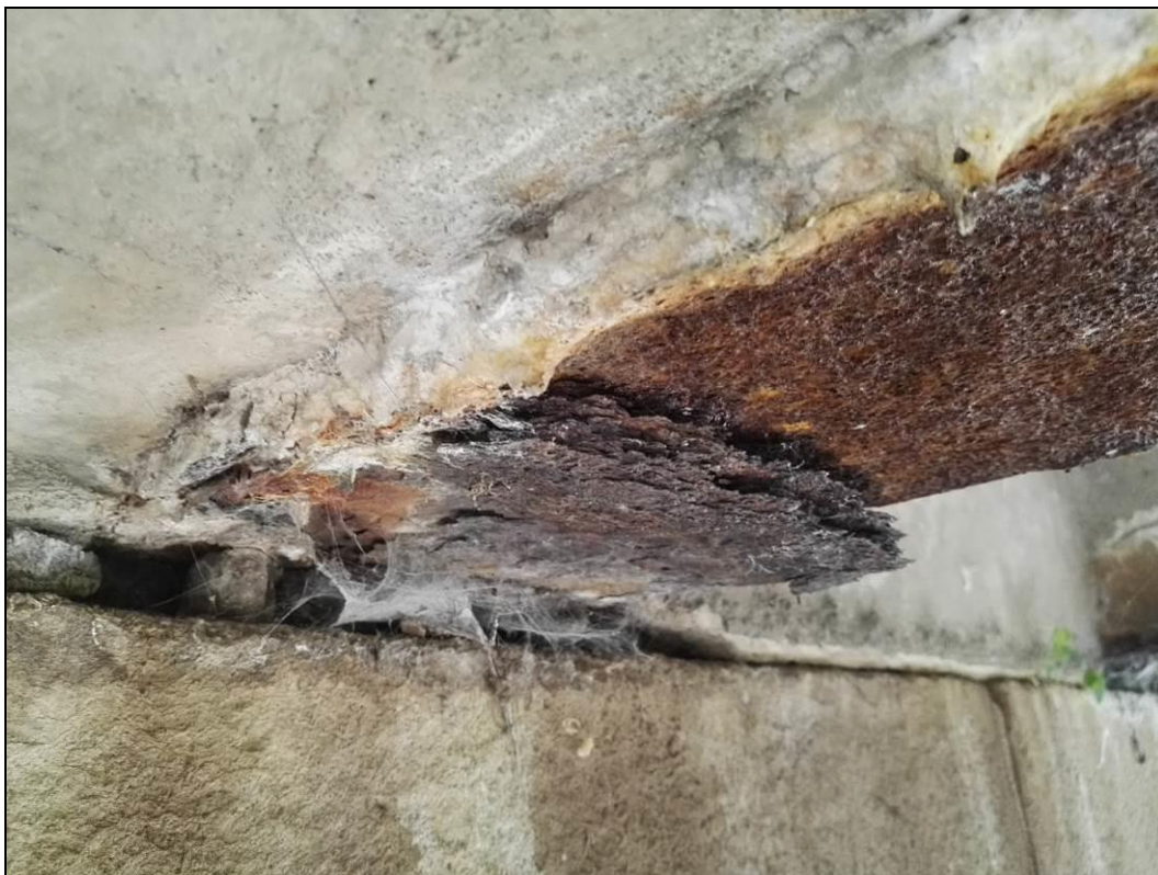
Obr. č. 13 - charakteristický pohled na hloubkovou korozi ocelových nosníků.
