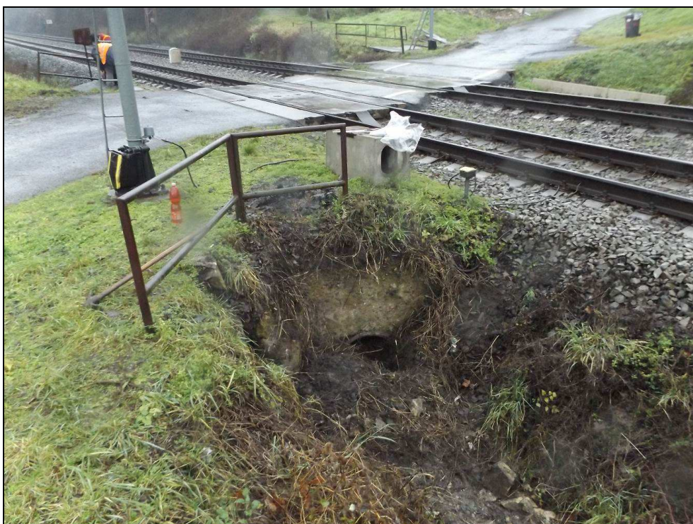
Obr. č. 12 - pohled do šachty č. 3 (ve skutečnosti se jedná pouze o příkop se zídrou v čele) ve směru rostoucího staničení. V čele je patrná zídka a v ní přítok od šachty č. 1
