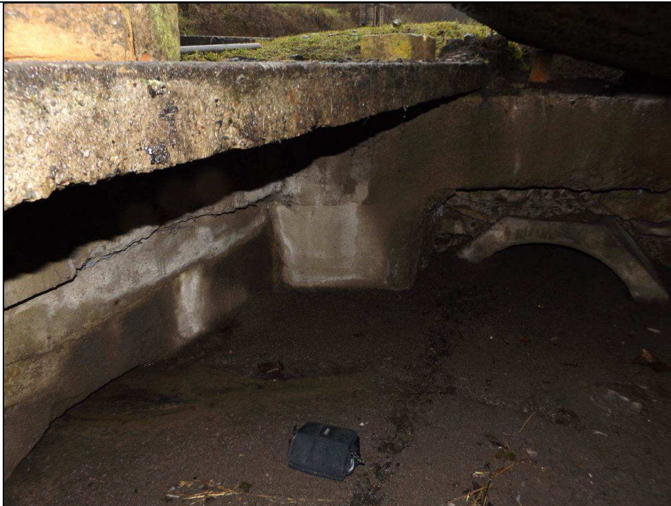
Obr. č. 5 - pohled do šachty č. 1 proti směru staničení. V čele odtok ze šachty k šachtě č. 3. Vlevo přítok od šachty č. 2. Šachta je na hloubku cca 0,4 - 0,5 m zaplavena blátem
