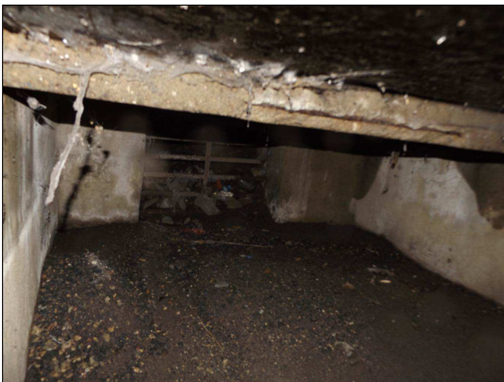
Obr. č. 10 - pohled do šachty č. 2 ve směru od kolejí. V čele je zamřížovaný přítok do šachty z příkopu podél silnice (mříže tvoří hrubé česle).
