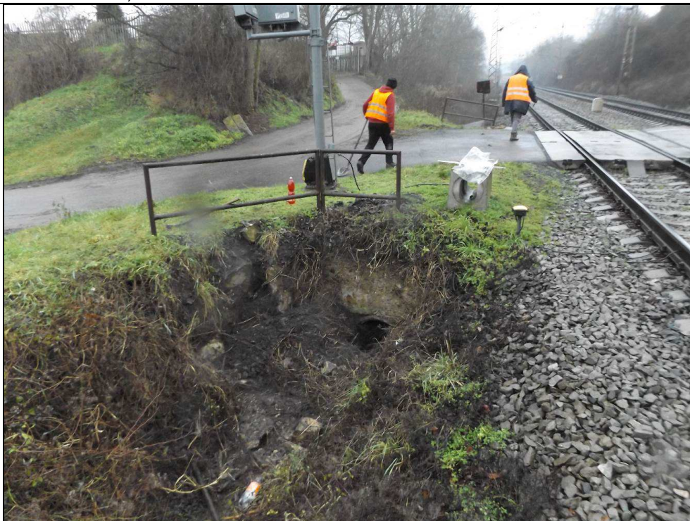
Obr. č. 3 - pohled na šachtu š. 3 před přejezdem vlevo trati
