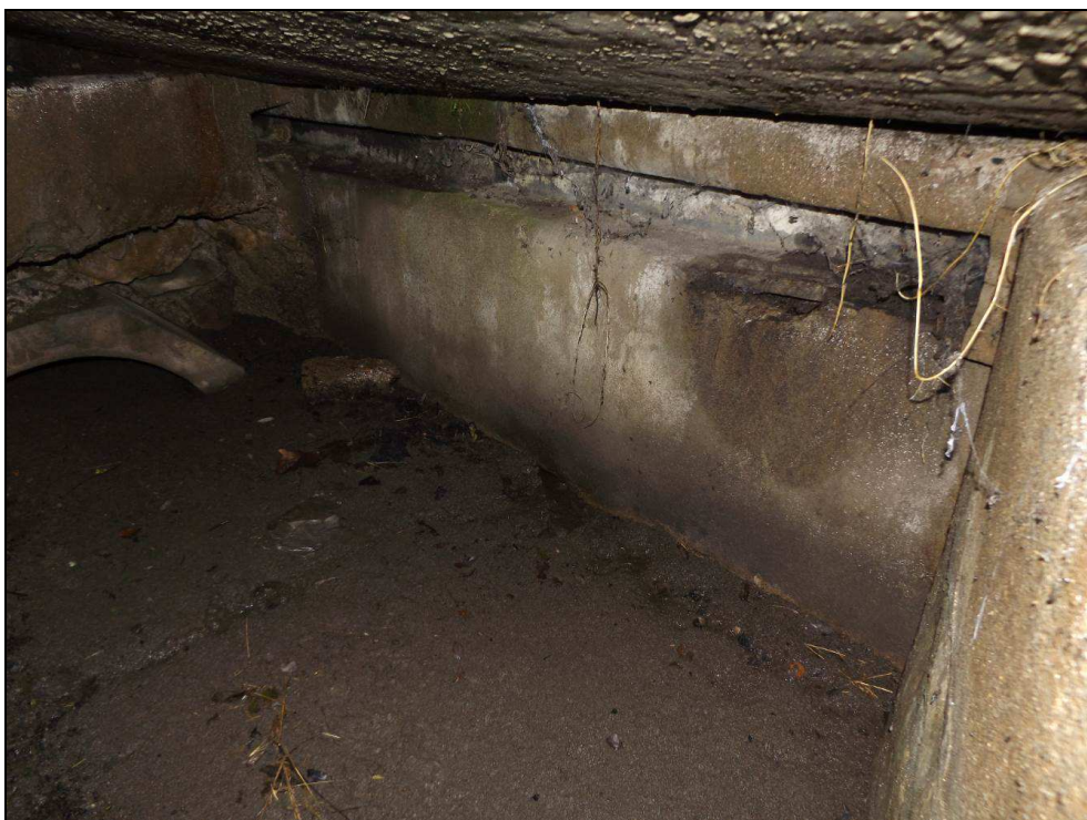
Obr. č. 6 - pohled do šachty č. 1 proti směru staničení. V čele (vlevo na obrázku) odtok ze šachty k šachtě č. 3. Vpravo je pak stěna šachty dále od trati ve které není žádný odtok.
