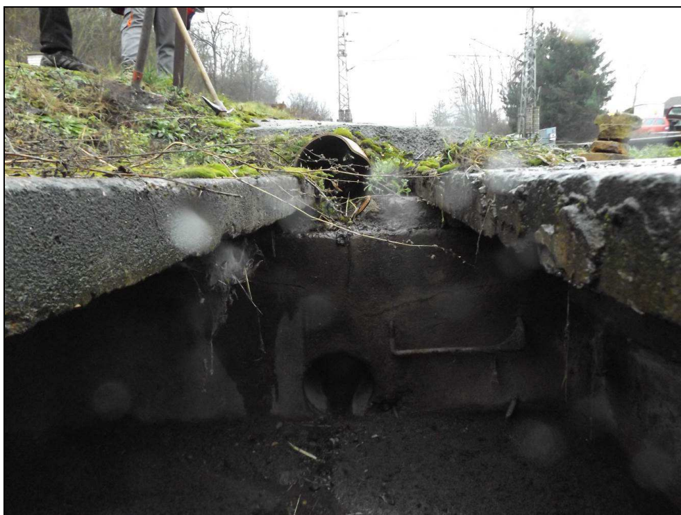
Obr. č. 8 - pohled do šachty č. 2 proti směru staničení. V čele přítok do šachty z příkopu podél trati (trouba je vedena pod silnicí). Nad hranou šachty je přítok z odvodnění komunikace těsně před přejezdem.
