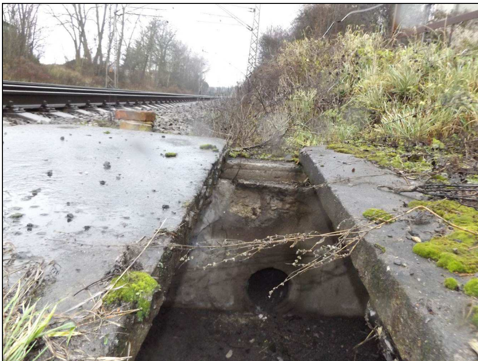
Obr. č. 9 - pohled do šachty č. 2 ve směru staničení. V čele přítok do šachty z příkopu podél trati.
