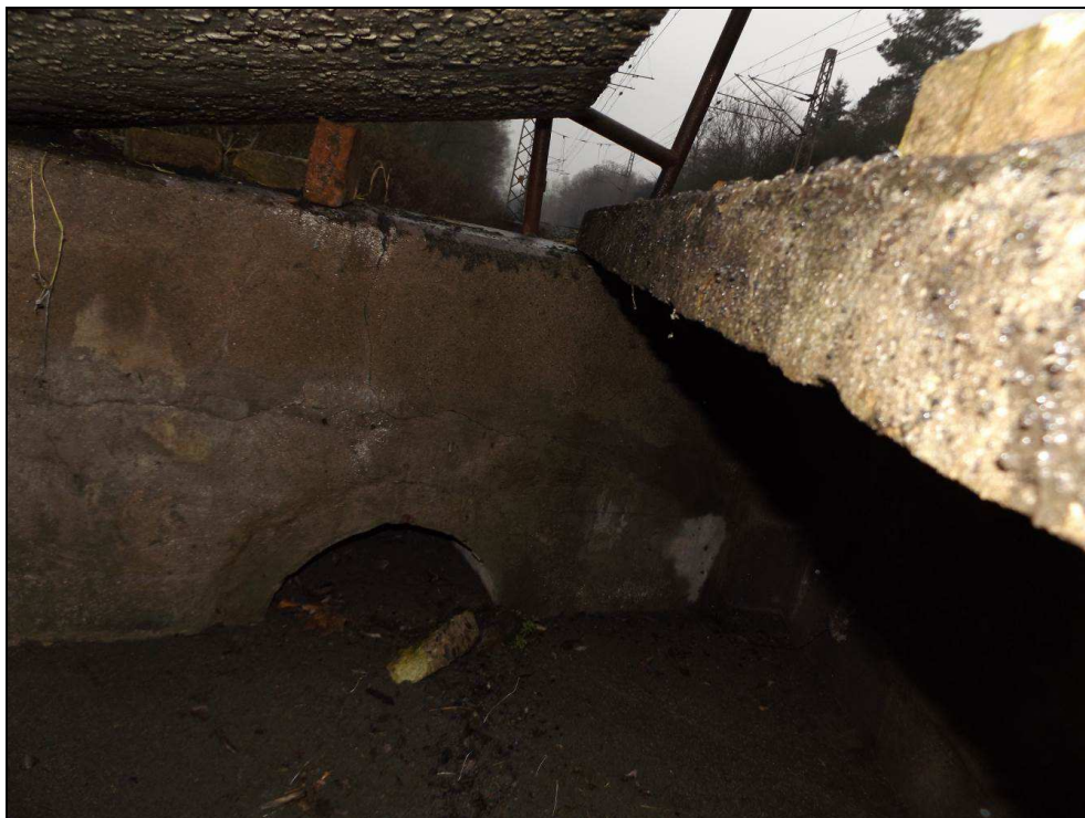
Obr. č. 7 - pohled do šachty č. 1 ve směru staničení. V čele přítok do šachty z příkopu podél trati.
