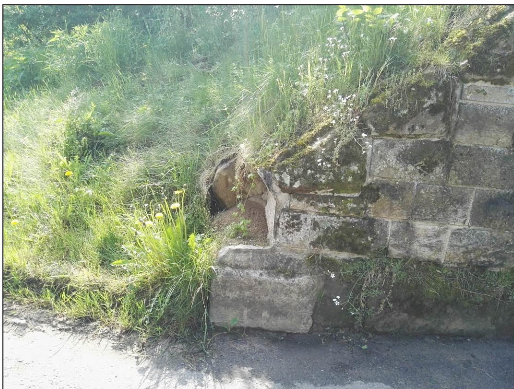
Obr. č. 10 - detailní pohled na poškození pravého křídla opěry Mělník.
