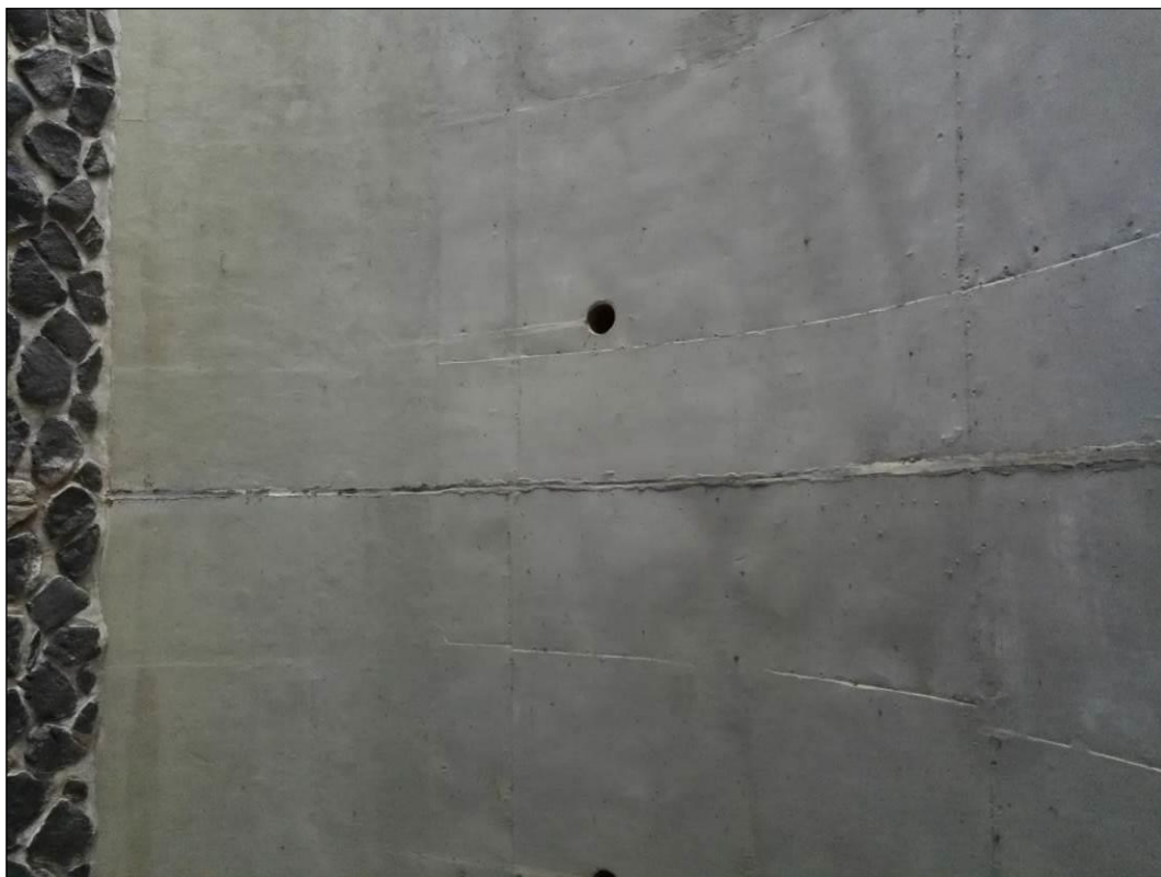
Obr. č. 5 - charakteristický pohled na jednu z dilatačních spár objektu.
