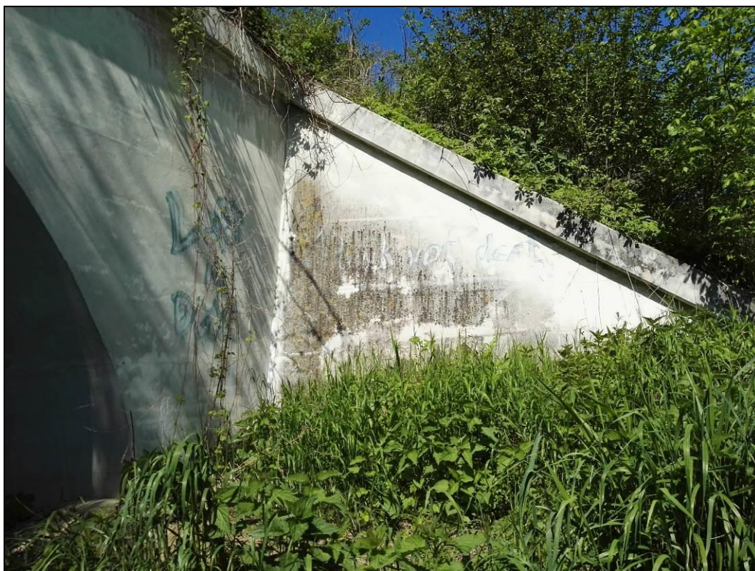
Obr. č. 9 - pohled na pravé křídlo opěry Litoměřice.
