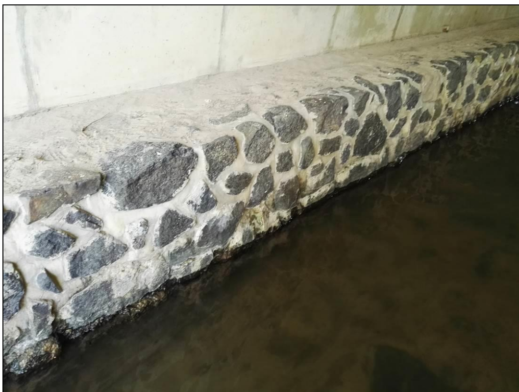
Obr. č. 6 - pohled na pravé opevnění břehu pod mostem.
