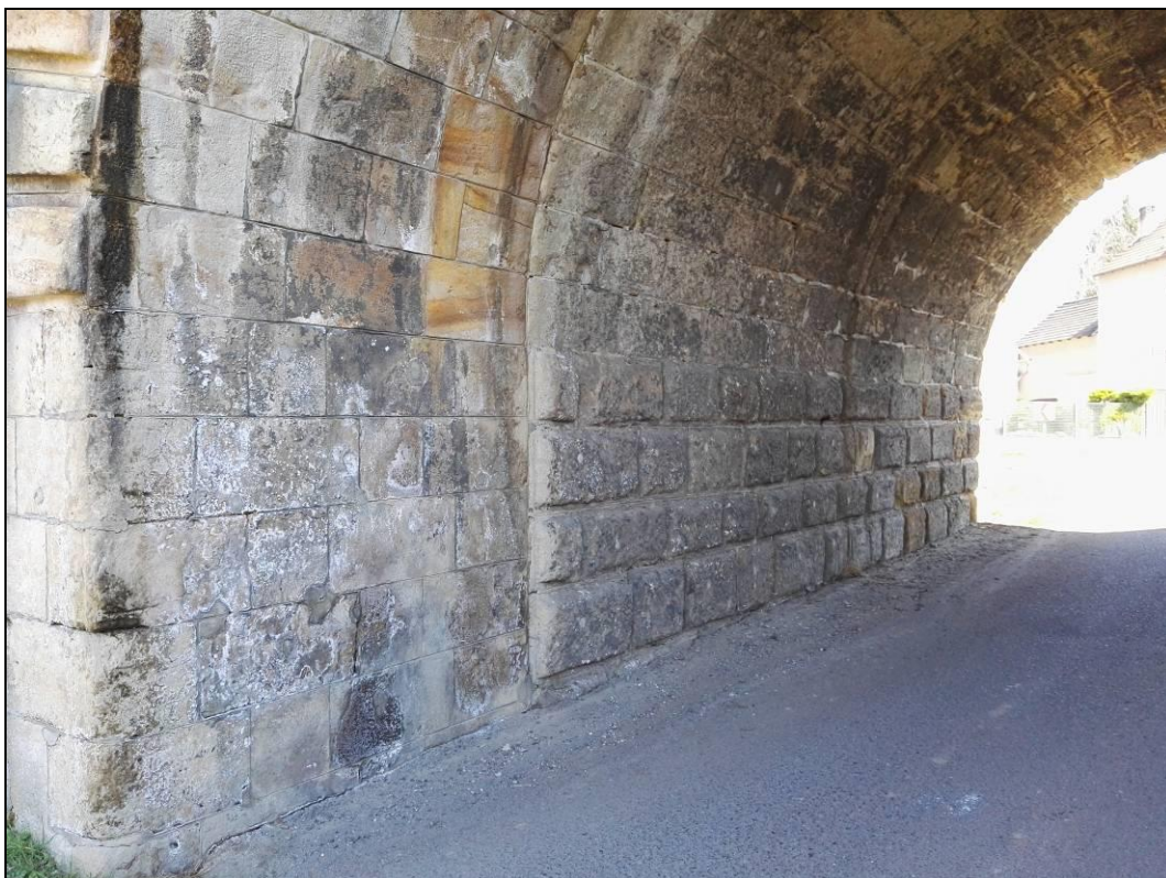
Obr. č. 7 - pohled na původní (vzadu) a levostrannou přístavbu (vpředu) opěry Litoměřice
