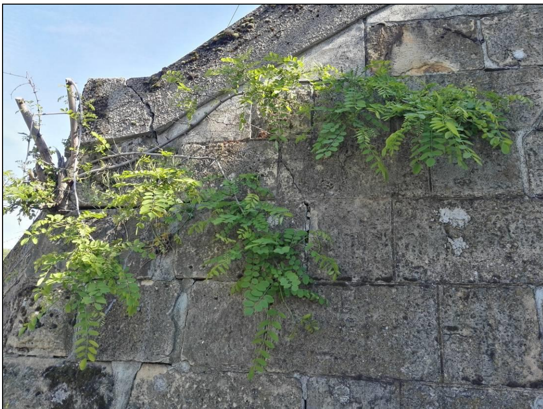
Obr. č. 5 - pohled na levé křídlo opěry Litoměřice - ve spárování jsou uchyceny náletové rostliny
