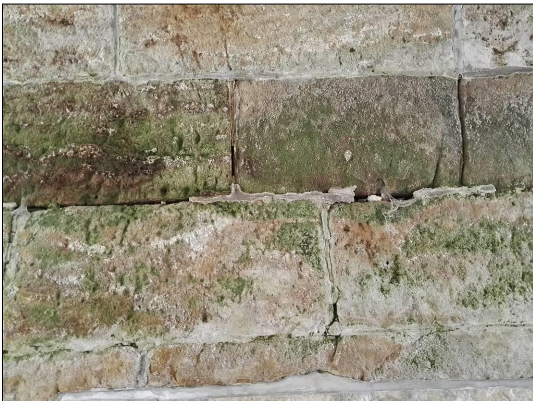
Obr. č. 15 - popraskané a vypadané spárování - původní opěra Mělník
