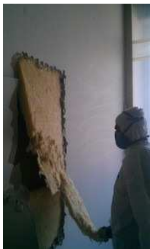
Demontáž minerální izolace
