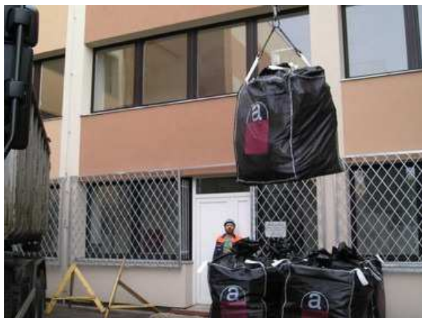
Nakládání speciálních obalů pro azbestové odpady
