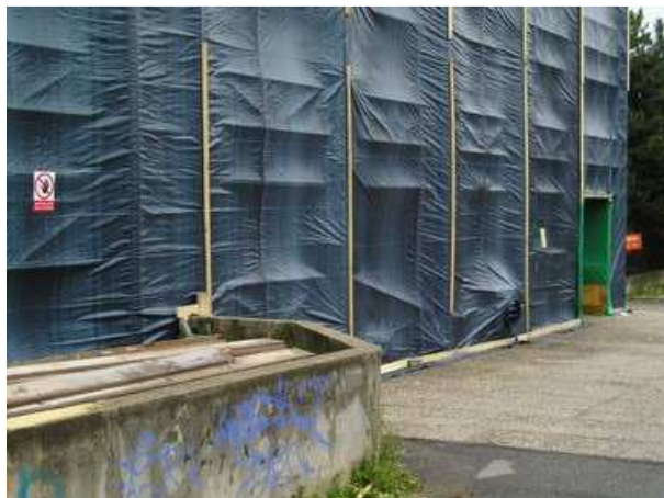
Venkovní plachta při vytvořeném podtlaku
