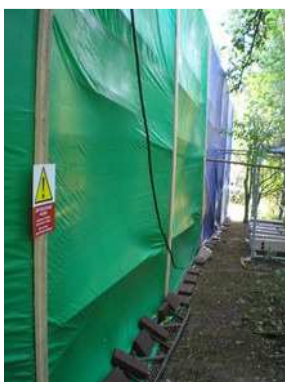
Vtažení venkovní plachty na pomocnou konstrukci vlivem podtlaku
