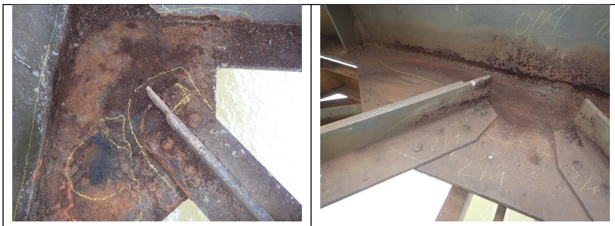
Obr. 7.7 Korozní oslabení podélného ztužení
