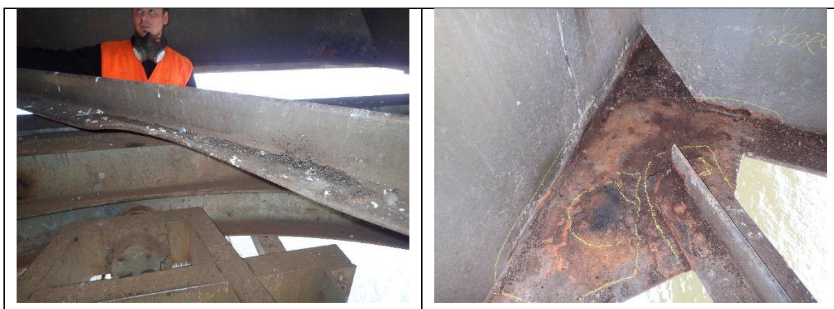
Obr. 5.7 Poškození vodorovného ztužení hlavních nosníků
