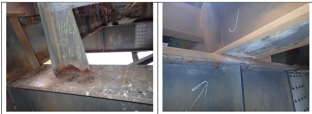
Obr. 7.10 Korozní oslabení horní příruby příčníku
