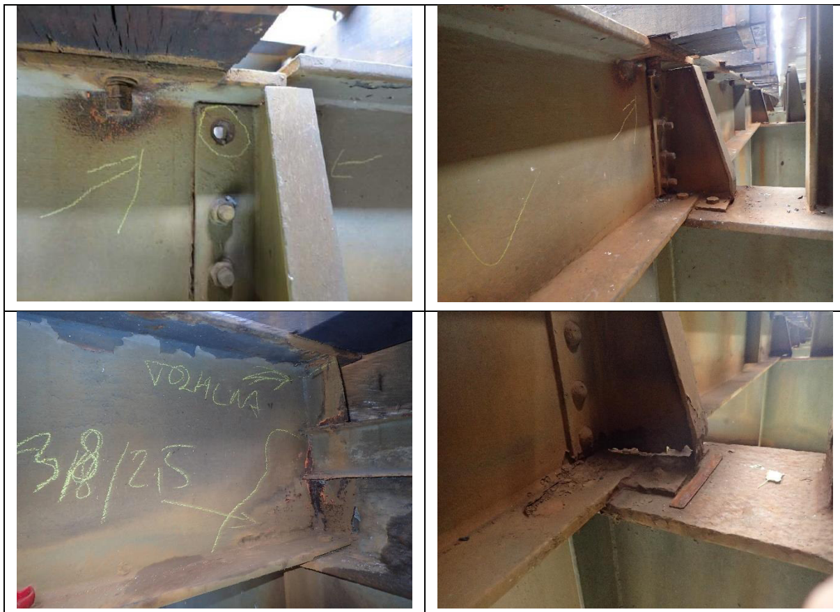
Obr. 5.13 Chybějící šrouby na stycích podélníku a příčnicku a další závady a poruchy podélníků
