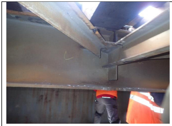
Obr. 5.14 Deformovaná podélná výztuha podélníku
