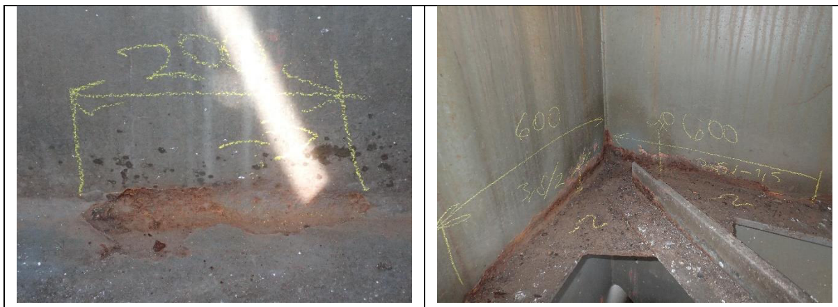
Obr. 7.4 Korozní oslabení stojiny v místě styku s vodorovným plechem
