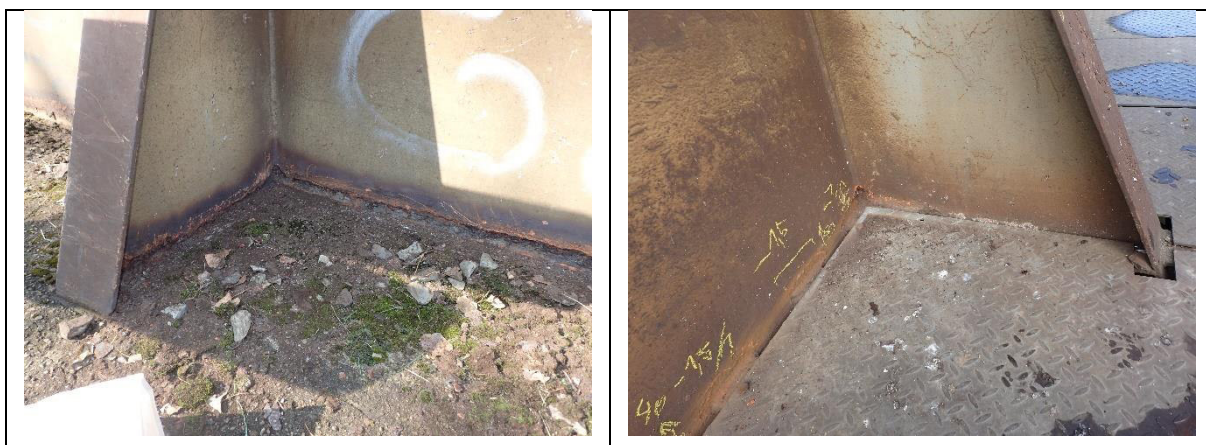
Obr. 7.3 Korozní oslabení stojiny nad pochozími plechy a betonovou deskou
