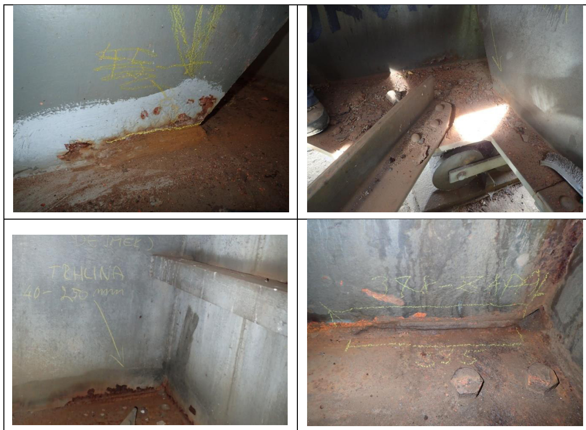
Obr. 5.2 Trhliny ve svazech stojiny a dolní příruby zárodků příčnicku
