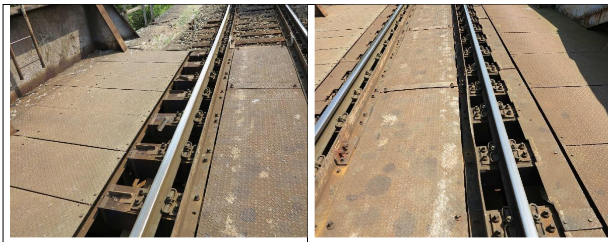
Obr. 5.15 Pojistné úhelníky a pochozí plechy
