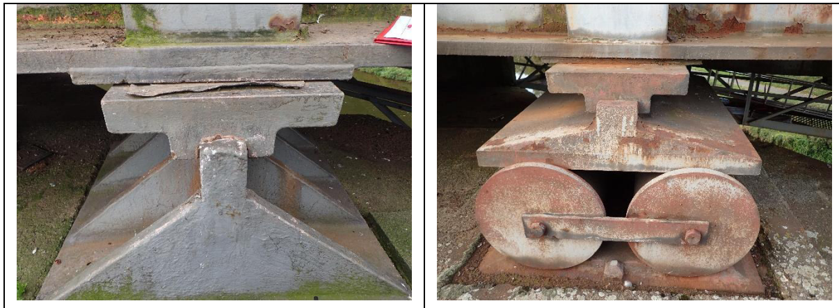
Obr. 5.10 Detail pevného a posuvného vahadlového ložiska
