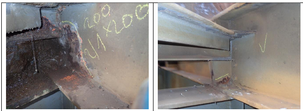
Obr. 7.13 Korozní oslabení stojiny podélníku
