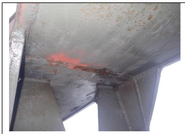
Obr. 5.5 Detail přípoje svislice na oblouk
