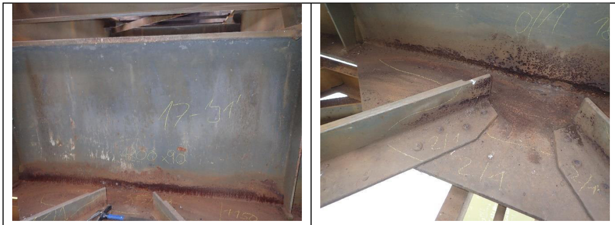
Obr. 7.9 Korozní oslabení stojiny a dolní příruby příčníku
