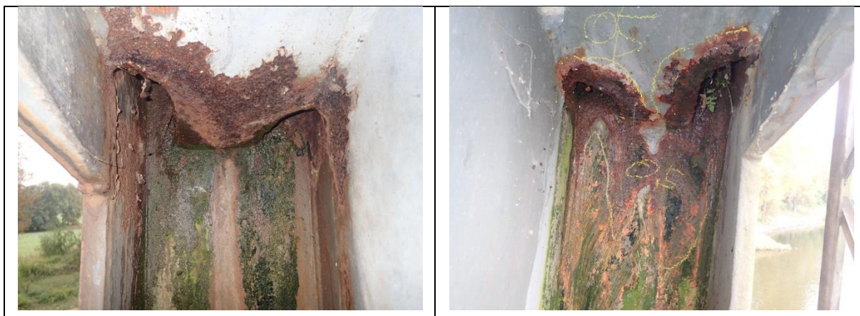
Obr. 5.4 Detail přípoje oblouku na hlavní nosník s přítomností vegetace
