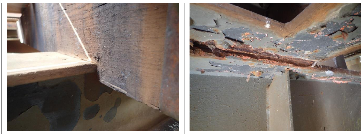
Obr. 7.12 Korozní oslabení přírub podélníku
