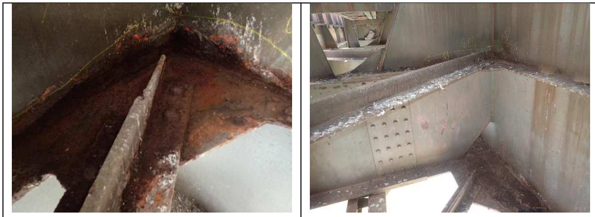
Obr. 5.8 Detail prvku brzdného ztužidla
