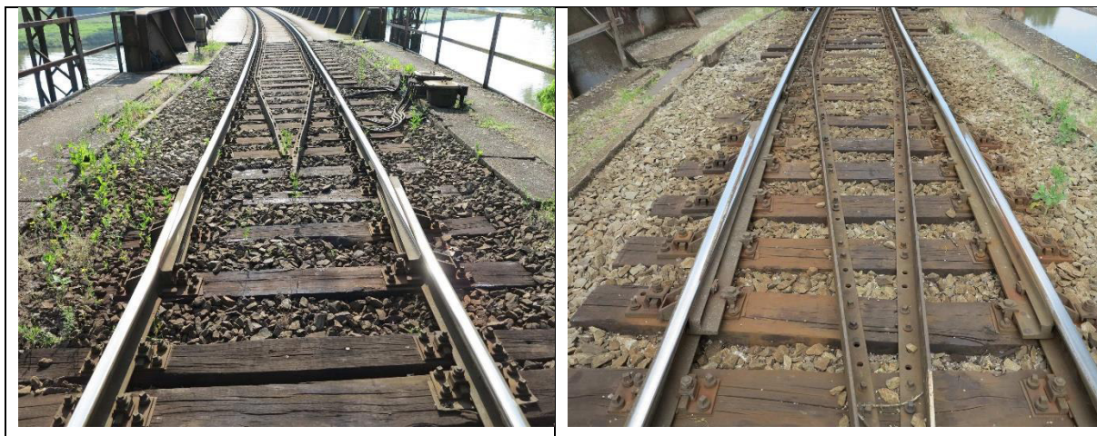
Obr. 5.17 Kolejové dilatační zařízení na konstrukci K01 a K03
