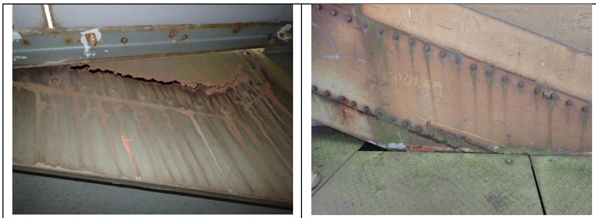
Obr. 5.3 Trhliny v krycím plechu servisního otvoru uzavřeného průřezu oblouku
