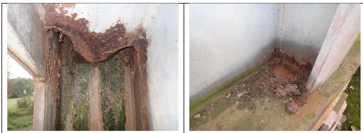
Obr. 7.6 Korozní oslabení hlavního nosníku z vnější strany
