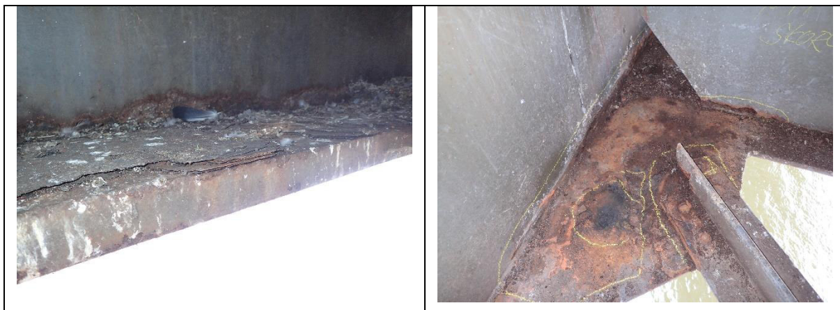
Obr. 7.2 Korozní oslabení dolní příruby hlavního nosníku
