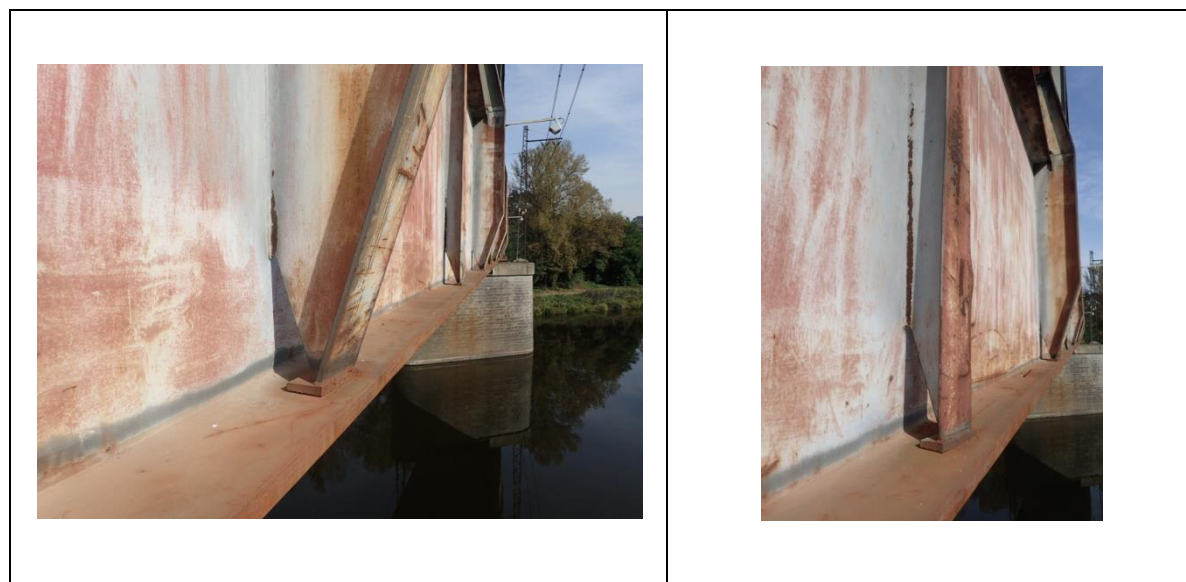
Obr. 5.1 Deformované svislé výztuhy v osách 23 a 24 pravého nosníku
