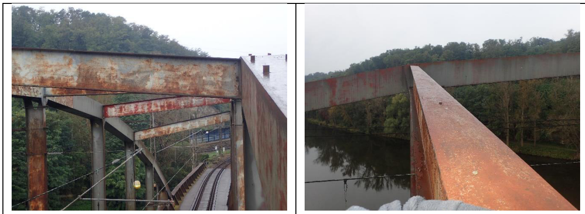
Obr. 5.6 Foto horních příčlí a jejich uspořádání
