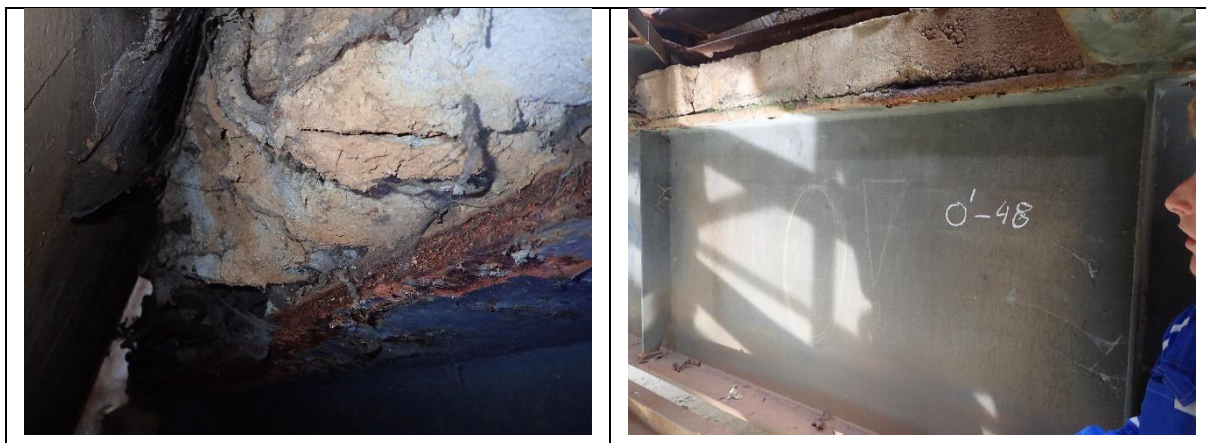
Obr. 7.11 Korozní oslabení v místě styku s betonovou deskou
