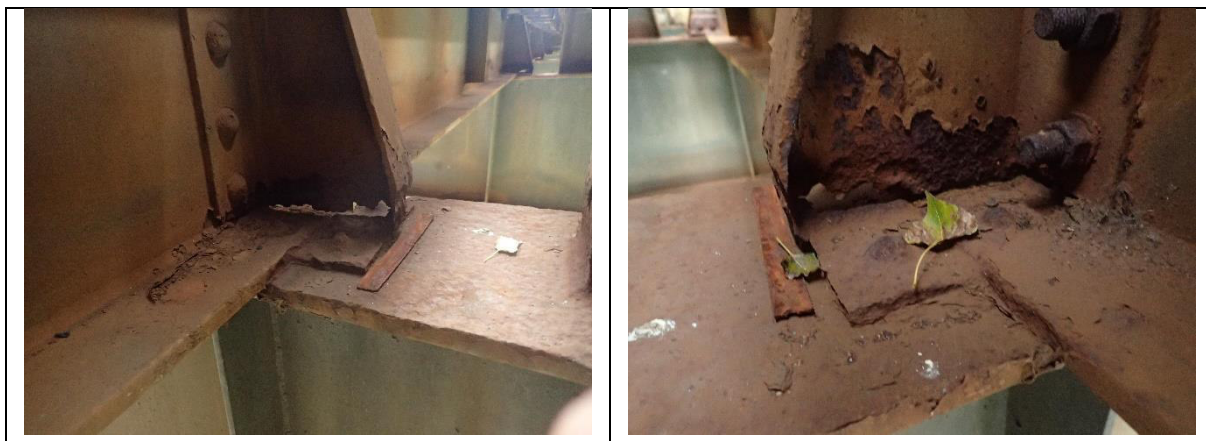
Obr. 7.14 Korozní oslabení ukotvení podélníku na příčník
