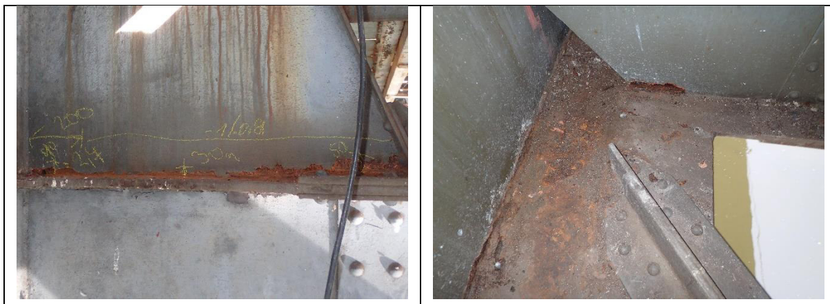
Obr. 7.5 Korozní oslabení svislé výztuhy a zárodku příčníku
