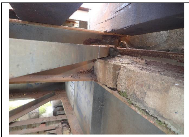
Obr. 7.15 Korozní oslabení koncových vodorovných ztužidel podélníku
