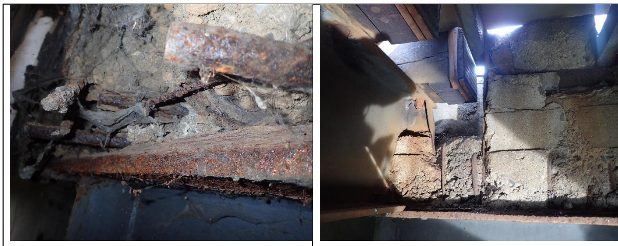
Obr. 5.9 Defekty přechodové desky mezi konstrukcí K02 a přilehlými konstrukcemi
