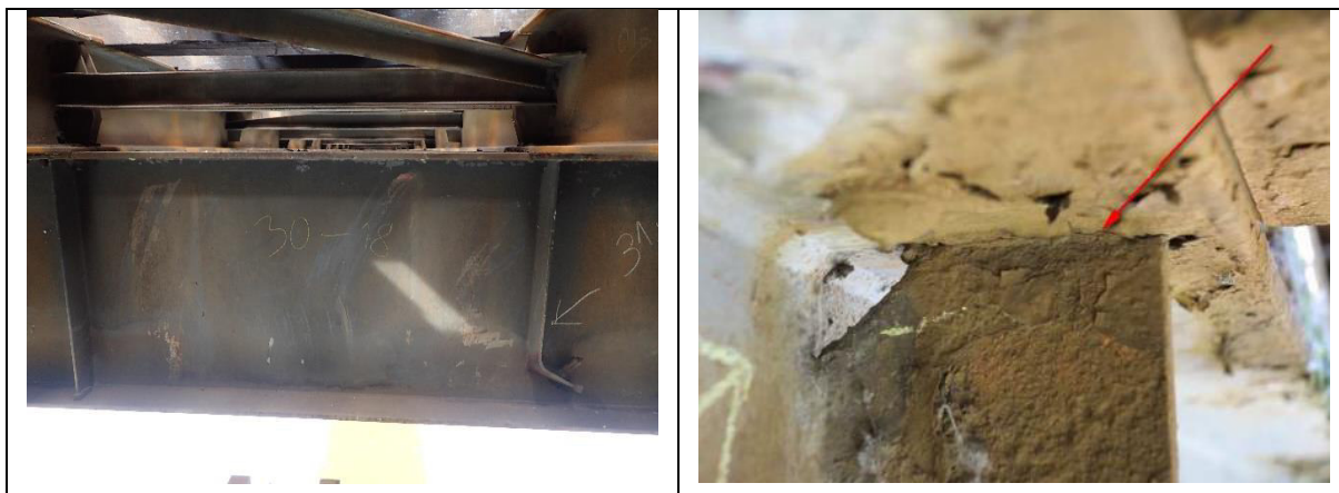
Obr. 5.11 Detail poškození svislých výztuh na příčnicích
