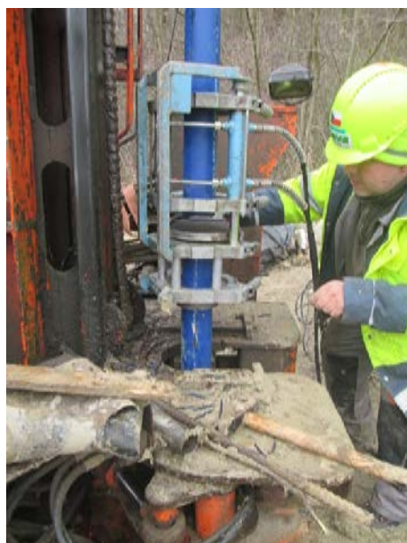
Obrázek č. 2 Svařování HDPE pažnic DN 90, souprava HANJIN POWER 4000 na vrtu HG-C1
