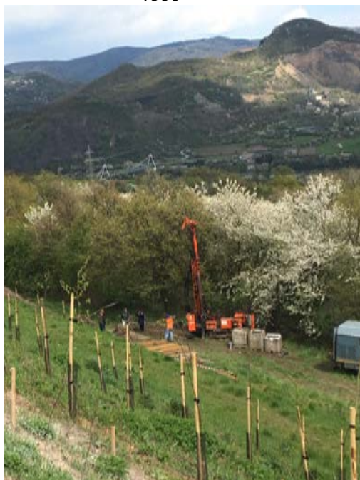
Obrázek č. 13 Vrt IK-C25 s pozitivní výtlačnou úrovní křídové zvodně, souprava HANJIN POWER 4000
