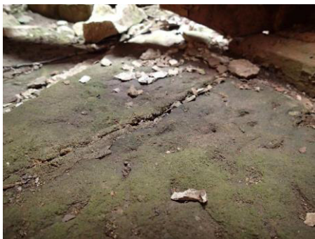
O 02 Prasklý blok podružného ložiska vpravo
