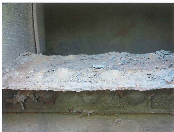
Foto č. 5 – K 03, silně zkorodovaná horní pásnice a hlavy nýtů podélníku.
