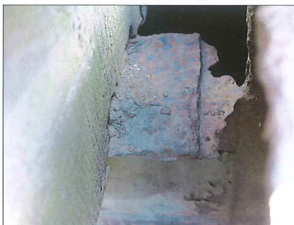
Foto č. 6 – K 03, silně zkorodované horní úhelníky podélníku v místě napojení na příčníky.
