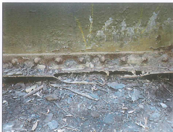
Foto č. 4 – K 03, zkorodovaný dolní úhelník 1. příčniku.
