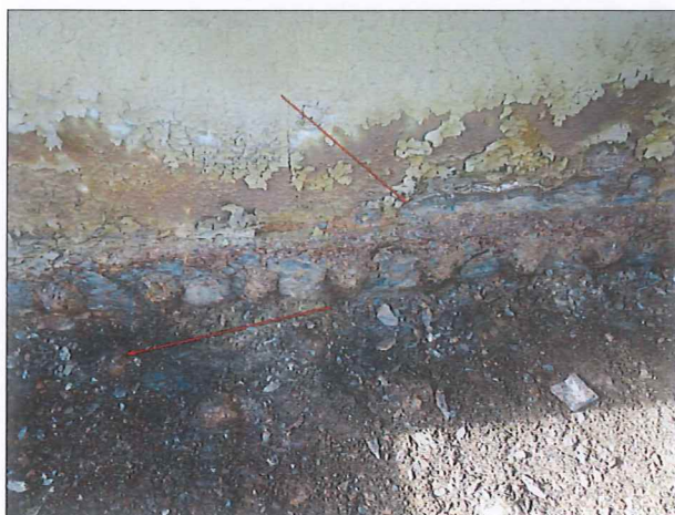
Foto č. 1 – K 03, silně oslabené stojiny hlavních nosníků s nárůstem plátkové koroze a zkorodované hlavy nýtů na dolních pásnicích.
