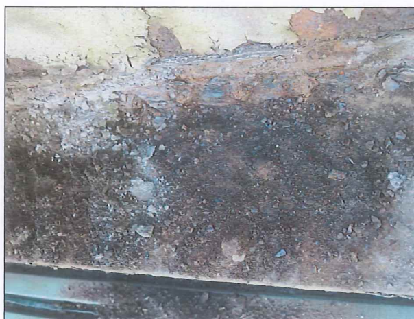
Foto č. 2 – K 03, koroze dolních pasových úhelníků
