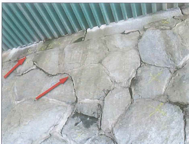
Foto č. 7 - O 02, pod levým úložným kvádrem K 03, uvolněné kameny a kvádry zdíva.
