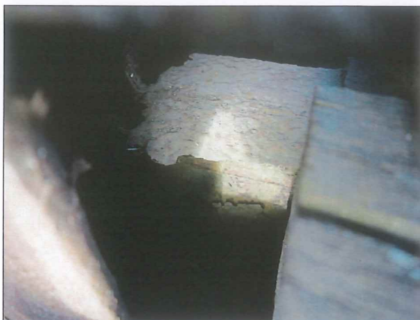
Foto č. 3 – K 03, silně zkorodované horní úhelníky příčníků v místě napojení na hlavní nosníky.
