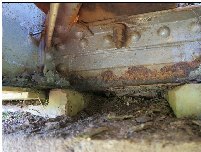
Foto č. 4 - K 01, stolička č. 08 vlevo po očištění koroze, chybějící spodní části úhelníku
