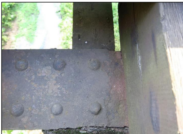
K01 - hlavní nosník vlevo - oslabení horní pásnice u mostnice č. 15
