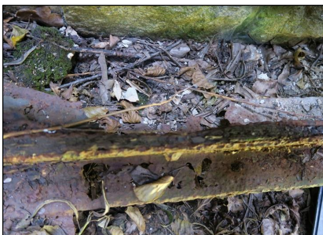
K01 - příčné ztužení č. 7 vlevo - korozní oslabení
