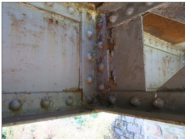
Foto č. 5 - K 01, příčné ztužení č. 02, olupání ochranného nátěru, koroze
