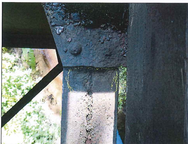
Foto č. 3 - K 01, oslabení úhelníků příčného ztužení č. 06 shora.
