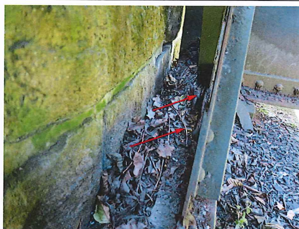
Foto č. 4 - K 01, chybějící část dolního úhelníku 7. příčného ztužení nad O 02 vlevo.
