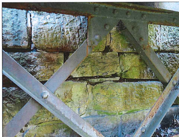
Foto č. 8 - O 02, hloubkově vypadané spárování a vytlačení horní řady kvádrů závěrné zdi.
