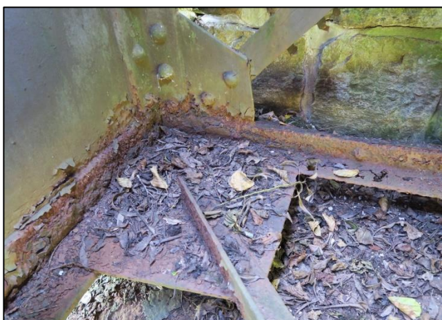
K01 - styčník nad uložením na O02 vlevo - korozní oslabení
