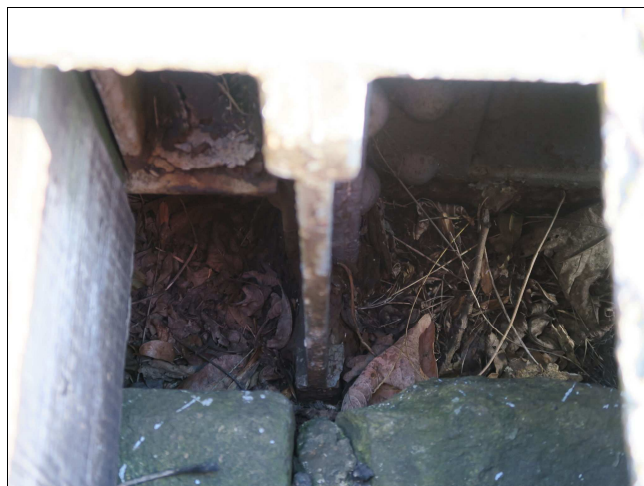
Foto č. 2 - K 01, pravý hlavní nosník č.03, silné znečištění nad opěrou O02
