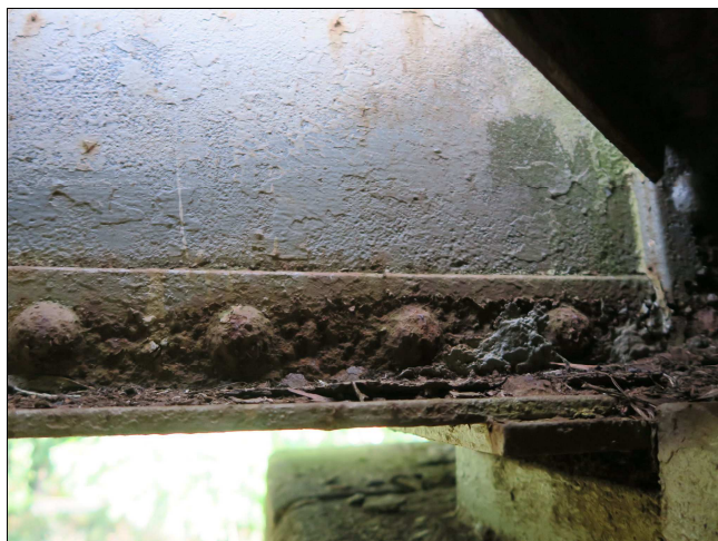
Foto č. 1 - K 01, pravý hlavní nosník č.04, koroze dolních úhelníků
