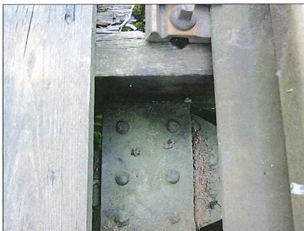
Foto č. 1 - K 01, zapření levého hlavního nosníku do závěrné zdi O 02
