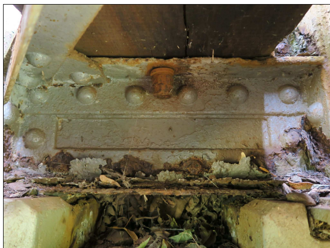
Foto č. 3 - K 01, stolička č. 01 vpravo, plátková koroze.
