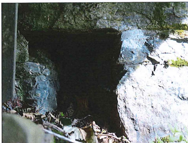
Foto č. 7 - O 01, vypadlý kus kamene ze závěrné zdi u levého nosíku..
