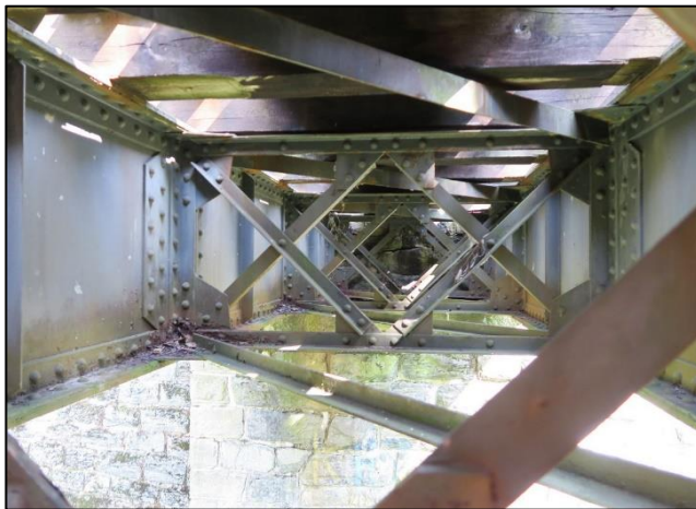
K01 - příčné ztužení / pohled do konstrukce
