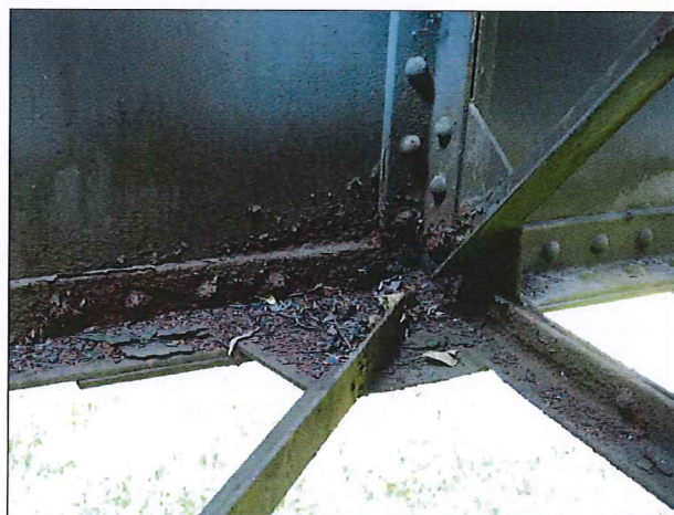
Foto č. 6 - K 01, zkorodovaný úhelník dolního podélného ztužení u 6. příčníku vpravo.
