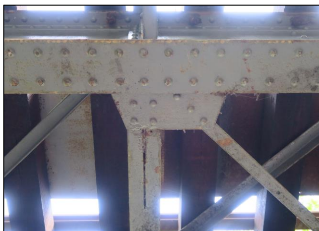
K01 - styčník pravý hlavní nosník / příčné ztužení č.5
