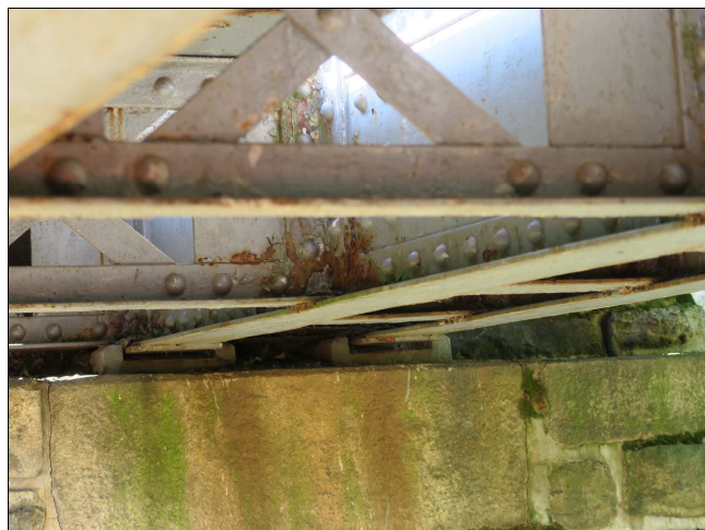
Foto č. 6 - K 01, příčné ztužení č. 02, nárůst plátkové koroze v rozích upevnění
