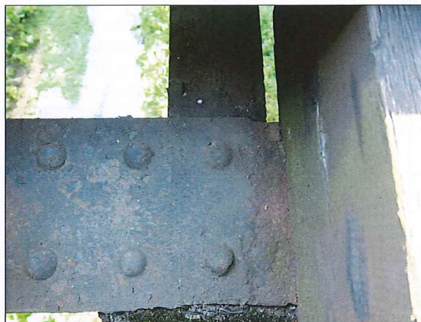
Foto č. 2 - K 01, oslabení horní pásnice levého hlavního nosníku u mostnice č. 15.
