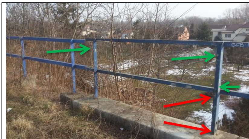
Obrázek 4: Most km 131,236 (pravá strana) • částečná koroze zábradlí (červeně) • porušený nátěr (zeleně)
