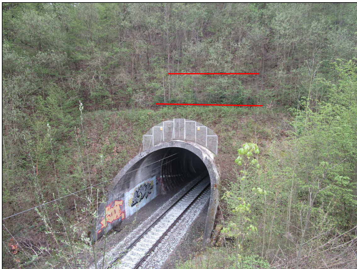
Obr. č. 35 – výjezdový portál tunelu č. 8.2, za ním svah bez skalních výchozů, horninové prostředí je zde tvořeno mylonity (místy charakteru jílovitých zemin), červenou čarou jsou znázorněny betonové zdi (viz. níže) – součást sanačních opatření v rámci výstavby tunelu
