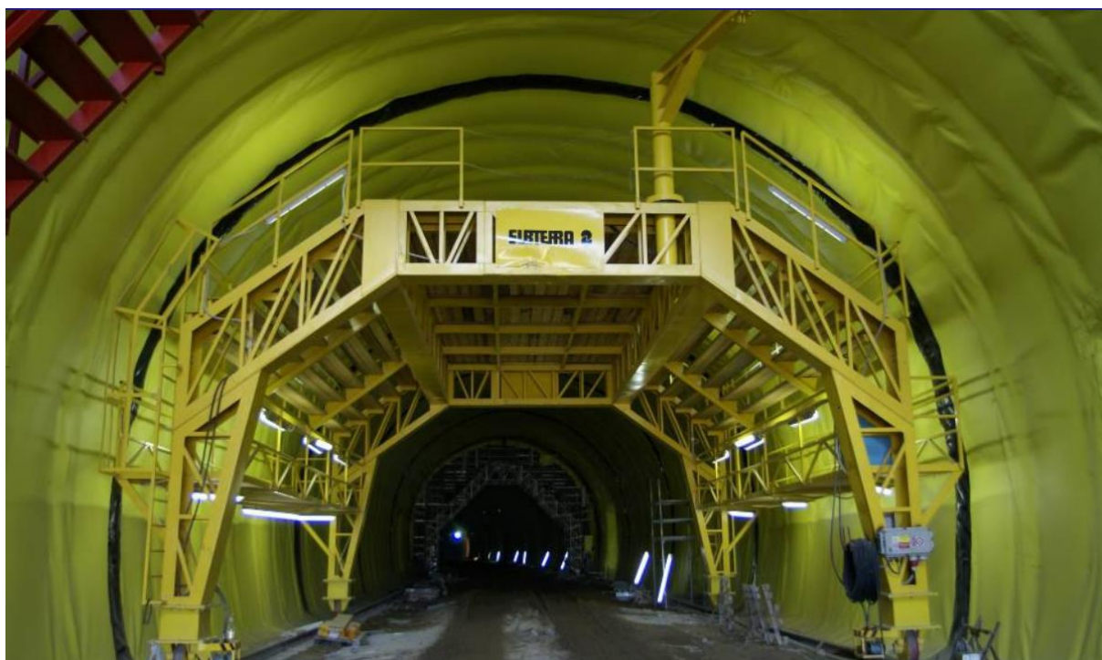
Obrázek 11: Plošina pro izolování tunelu
