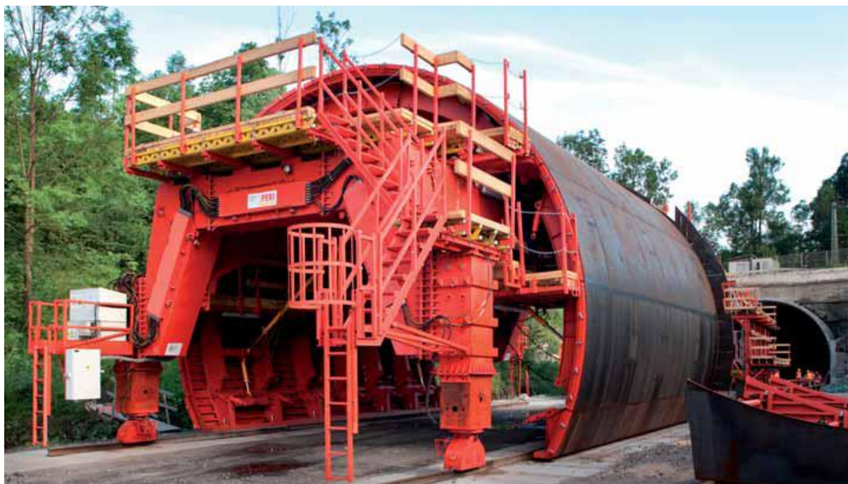
Obrázek 5: Bednicí vůz pro provádění sekundárního ostění
