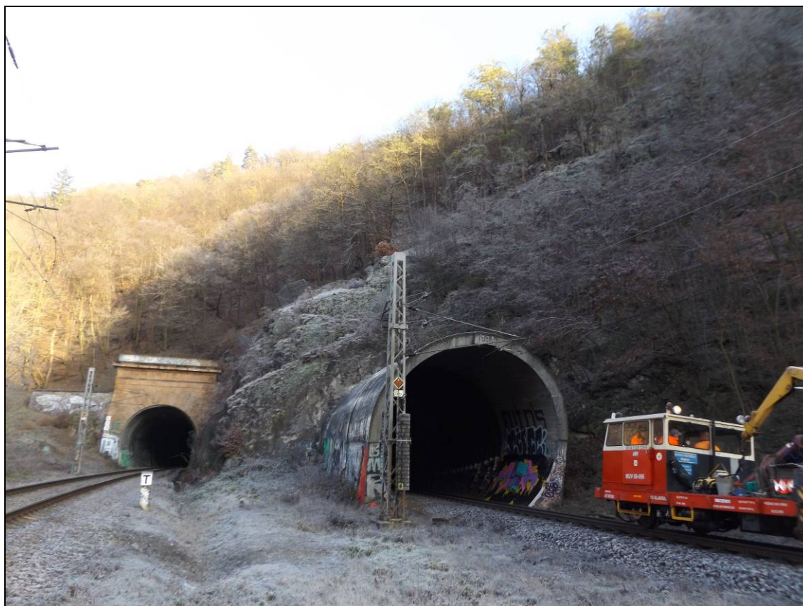
Obr. č. 33 – vjezdové portály starého tunelu 8.1 (vlevo) a nového tunelu 8.2 (vpravo), skalní masív je budován zdravým až navětralým granodioritem
