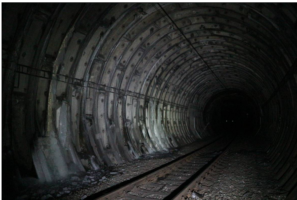
Obr. č. 45 – pohled na levou část TP65-66, ledopády a rampouchy na ostění tunelu
