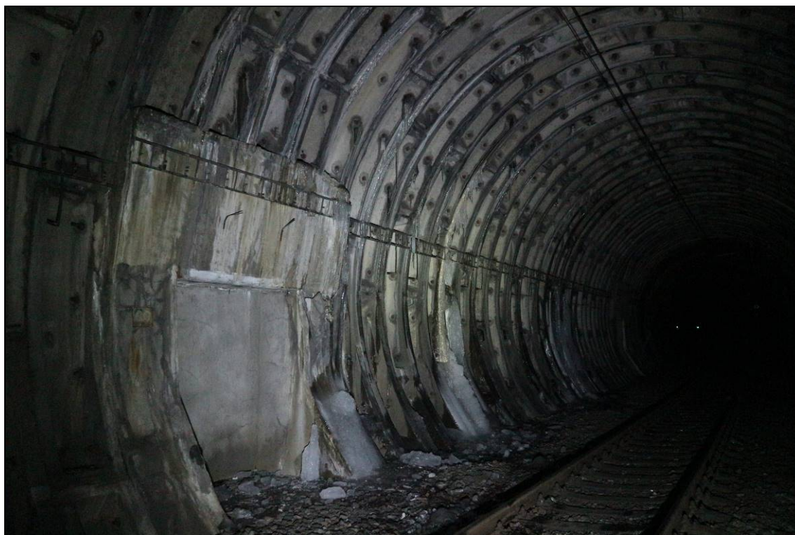
Obr. č. 44 – pohled na levou část TP63-64, silné průsaky zkrze ostění, degradace omítky a zdiva výklenku vlivem mrazových účinků
