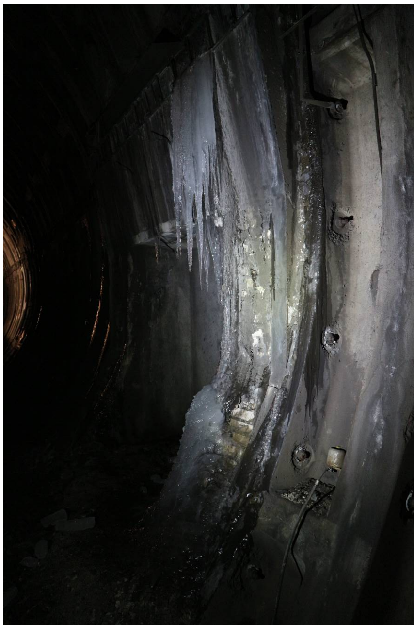
Obr. č. 41 – středně silné průsaky vlevo v TP 36 nad výklenkem, degradace betonu a zdiva výklenku. vlivem stékající vody a mrazových účinků
