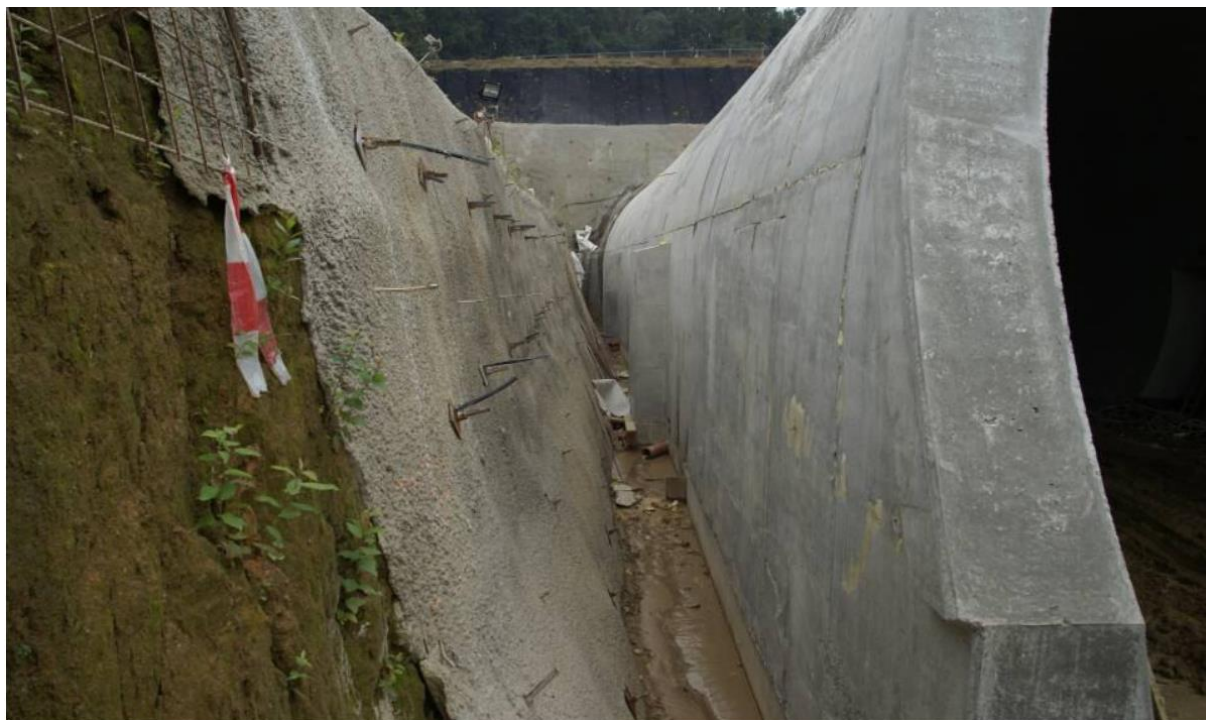
Obrázek 8: Povrch betonu po odstranění rubového bednění
