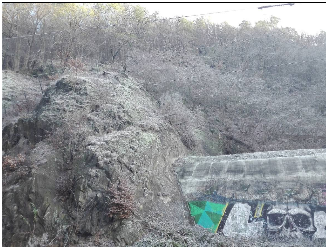
Obr. č. 34 – vjezdový portál - tubus tunelu č. 8.2 je vytažený ze skalního masívu, chrání tak kolej č. 2 před pádem úlomků, vlevo nahoře záchytné ploty na horní hraně skalního zářezu nad kolejí č. 1
