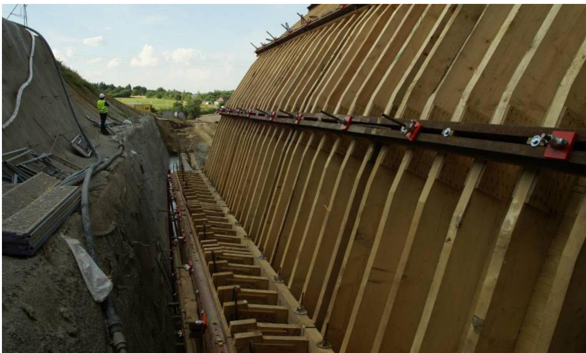
Obrázek 7: Vnější (rubové) bednění hloubeného tunelu
