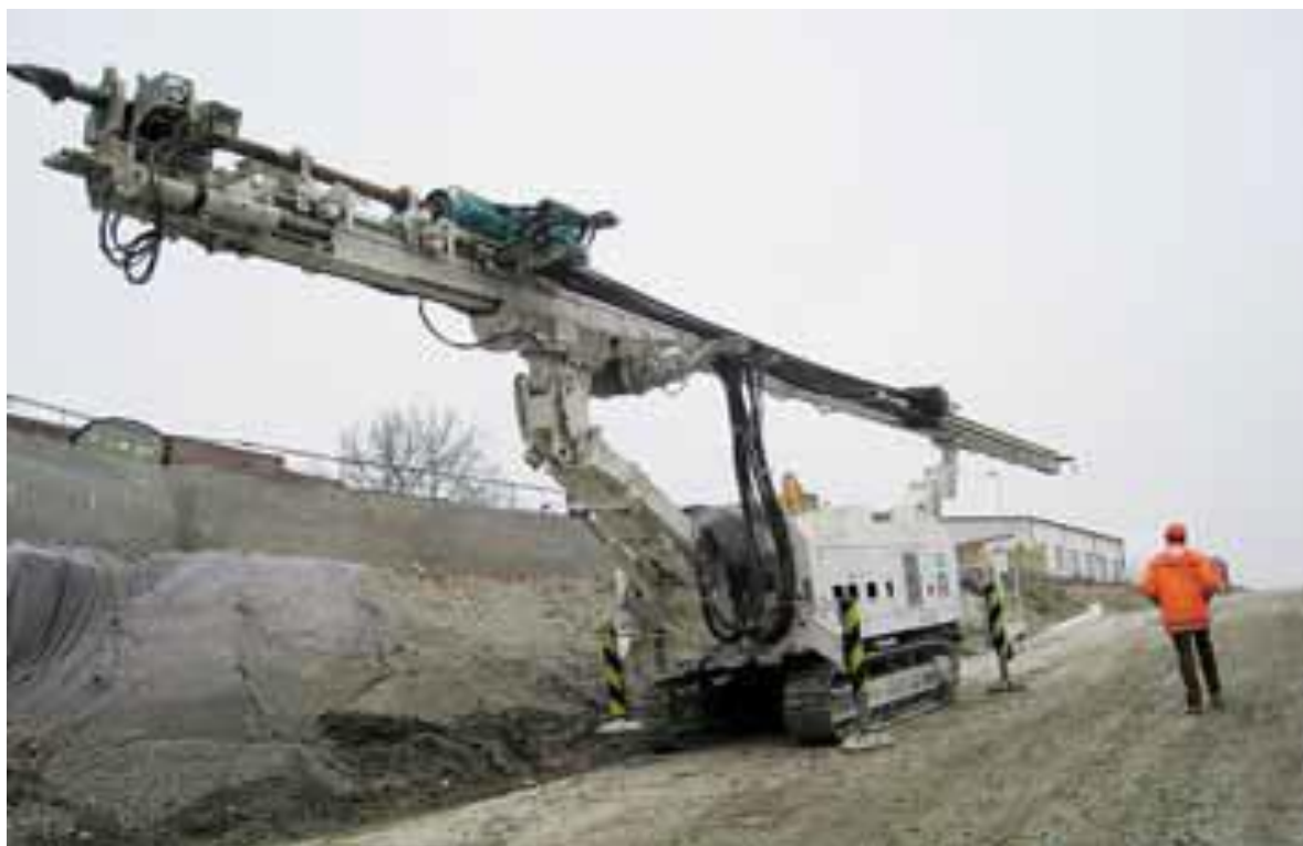
Obrázek 3 Souprava pro provádění deštníků z mikropilot
