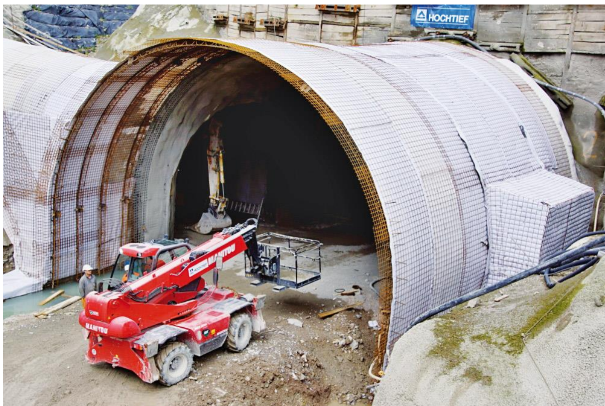
Obrázek 9: Falešné primární ostění
