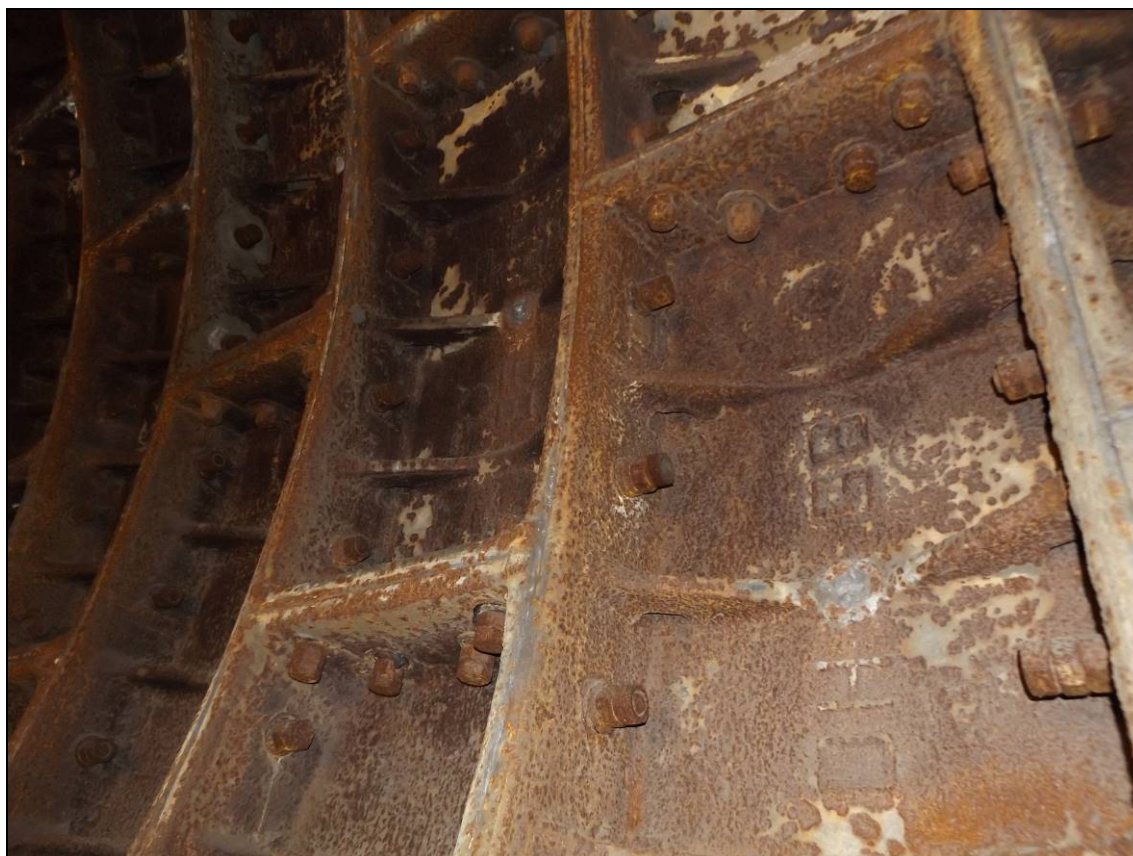
Obr. č. 37 – detail spojení ocelových tybinků
