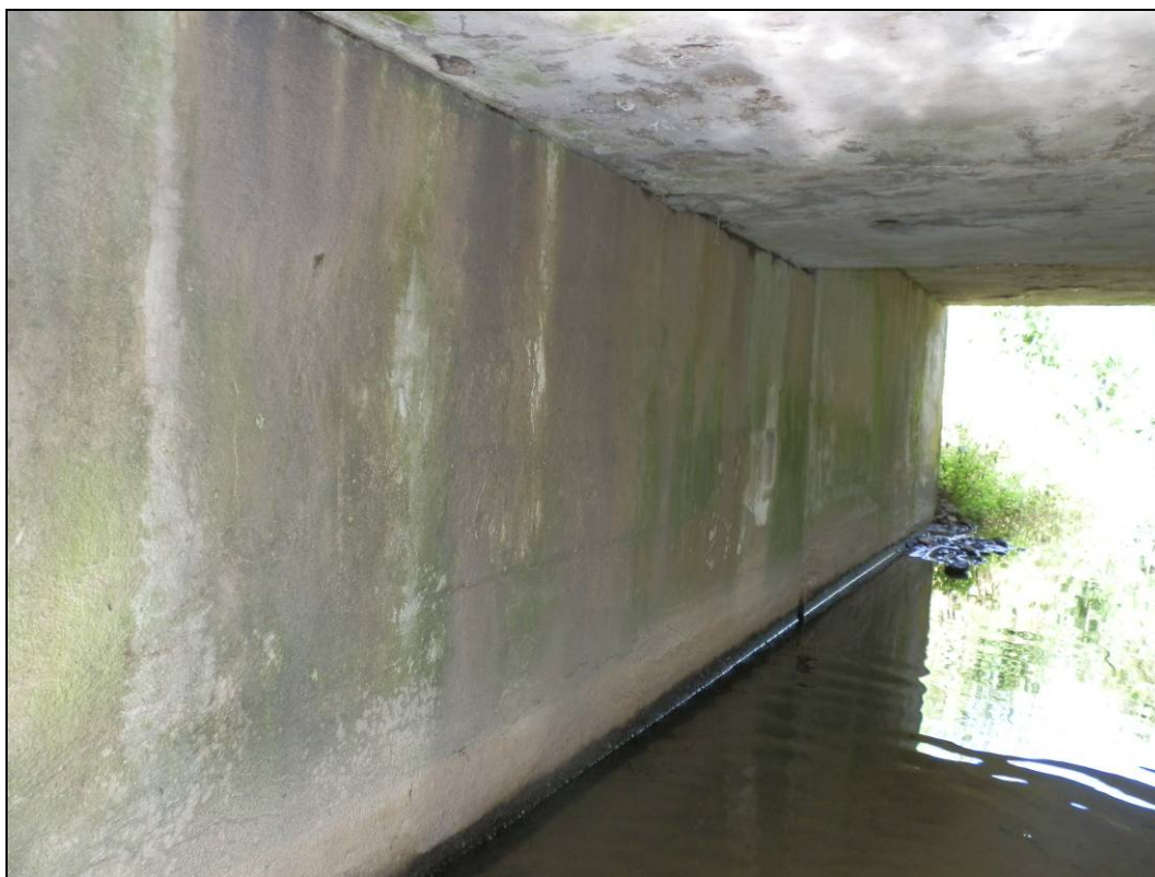
Obr. č. 5 - opěra Hustopeče, povrch opěry je bez větších poruch
