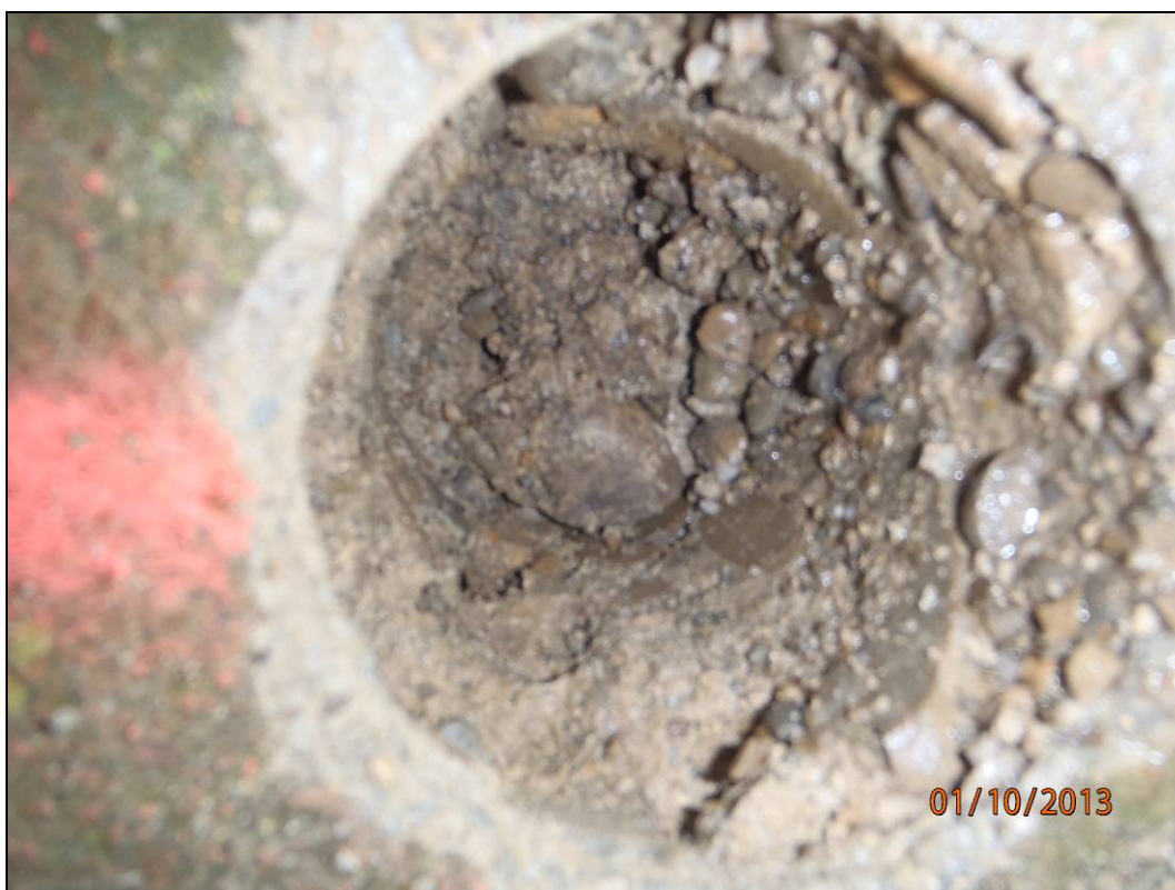
Obr. č. 3 - pohled do návrťu N1. Stěny vrtu jsou pevné, drží tvar, beton je však silně nehomogenní, s četnými dutinami a póry a s malým obsahem pojiva
