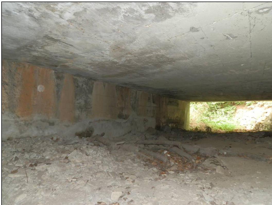
Obr. č. 4 - opěra Hustopeče, povrch opěry je bez poruch
