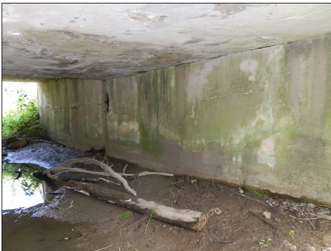
Obr. č. 5 - opěra Valašské Meziříčí, povrch opěry je bez větších poruch, lokálně je beton vypadaný do hloubky
