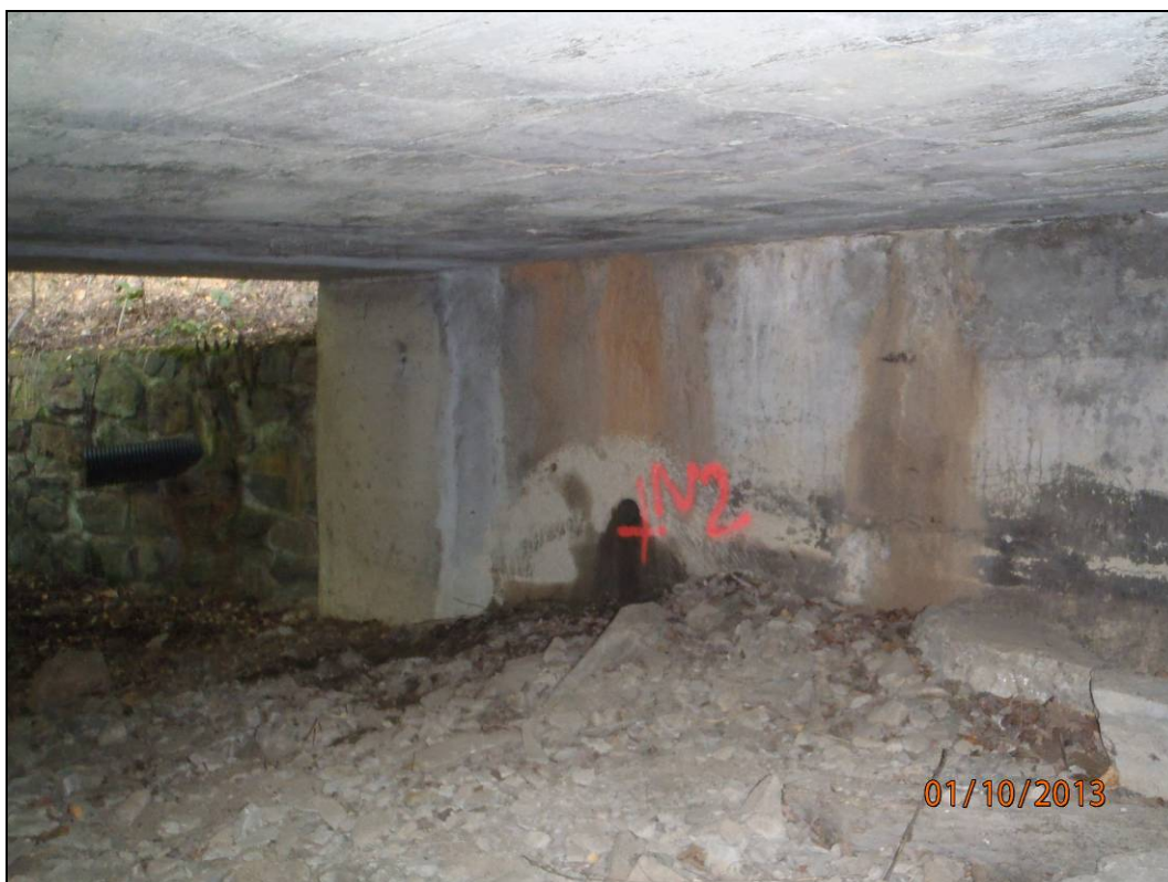
Obr. č. 5 - opěra Valašské Meziříčí, povrch opěry je bez poruch
