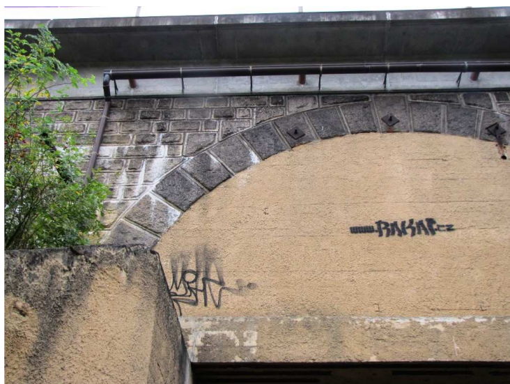
Konstrukce K 01 – vpravo, výluhy pojiva z čela
