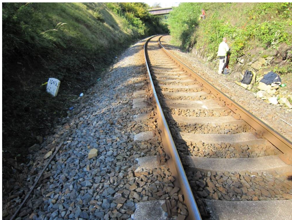
Celkový pohled na zářez v km 154,530 - 154,660 (vpravo vymrzlá a sesutá kamenná zárubní zeď)
