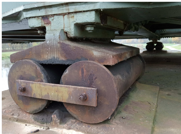
Obr 11. Pohyblivé ložisko na pilíři sP03
