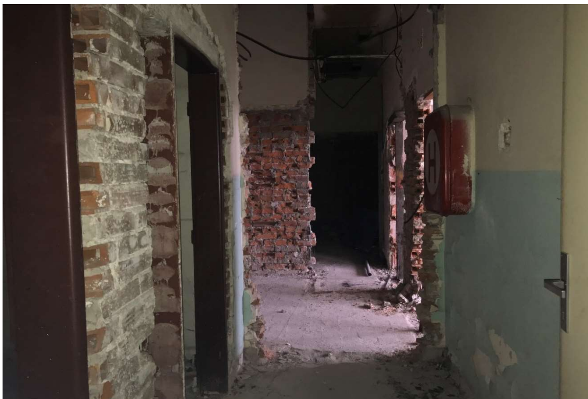
Obrázek 22 Chodba 2.NP Část objektu po neodborně provedených demoličních pracích. Konstrukce mnohdy nezajištěné a životu nebezpečné. Rozvody v objektu zničené nebo ukradené.
