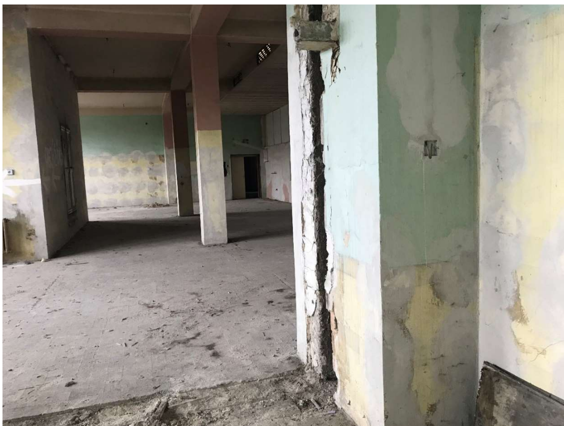
Obrázek 23 Bývalá restaurace ve 2.NP Povrchy místnosti jsou poškozené, místy chybějící. Rozvody místy vytrhané. Nefunkční, bez osvětlení. Poškozené nebo chybějící ovládací prvky.
