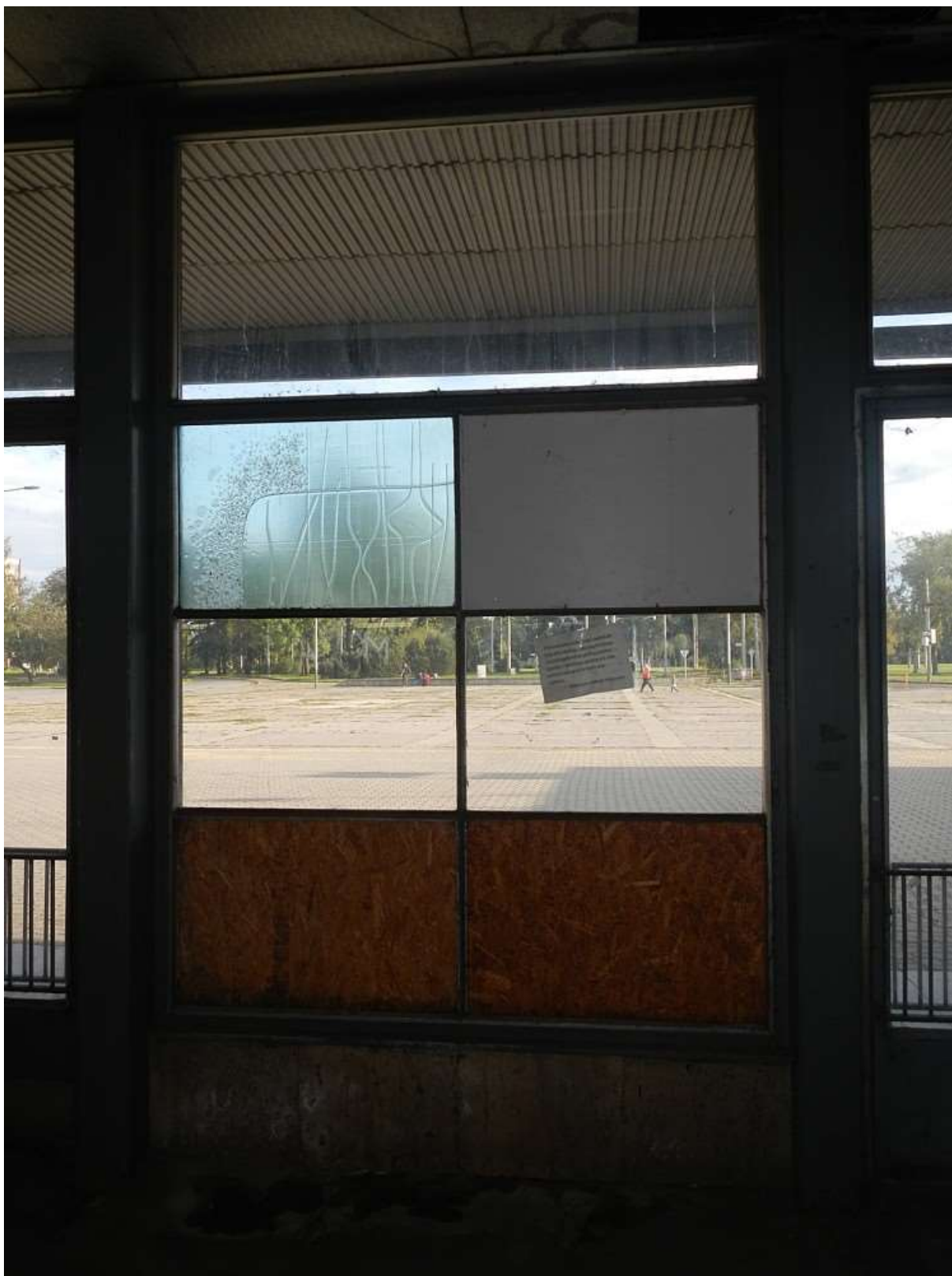
Obrázek 15 1. NP Pohled na přednádraží prostor z vestibulu – hlavní vstup. Vstup uzavřen, nebezpečný havarijný stav konstrukce přístřešku a prosklené výplně za hranicí životnosti. Poškozené výplně nahrazeny napřed čirými tabule, následně provizorní výplně.
