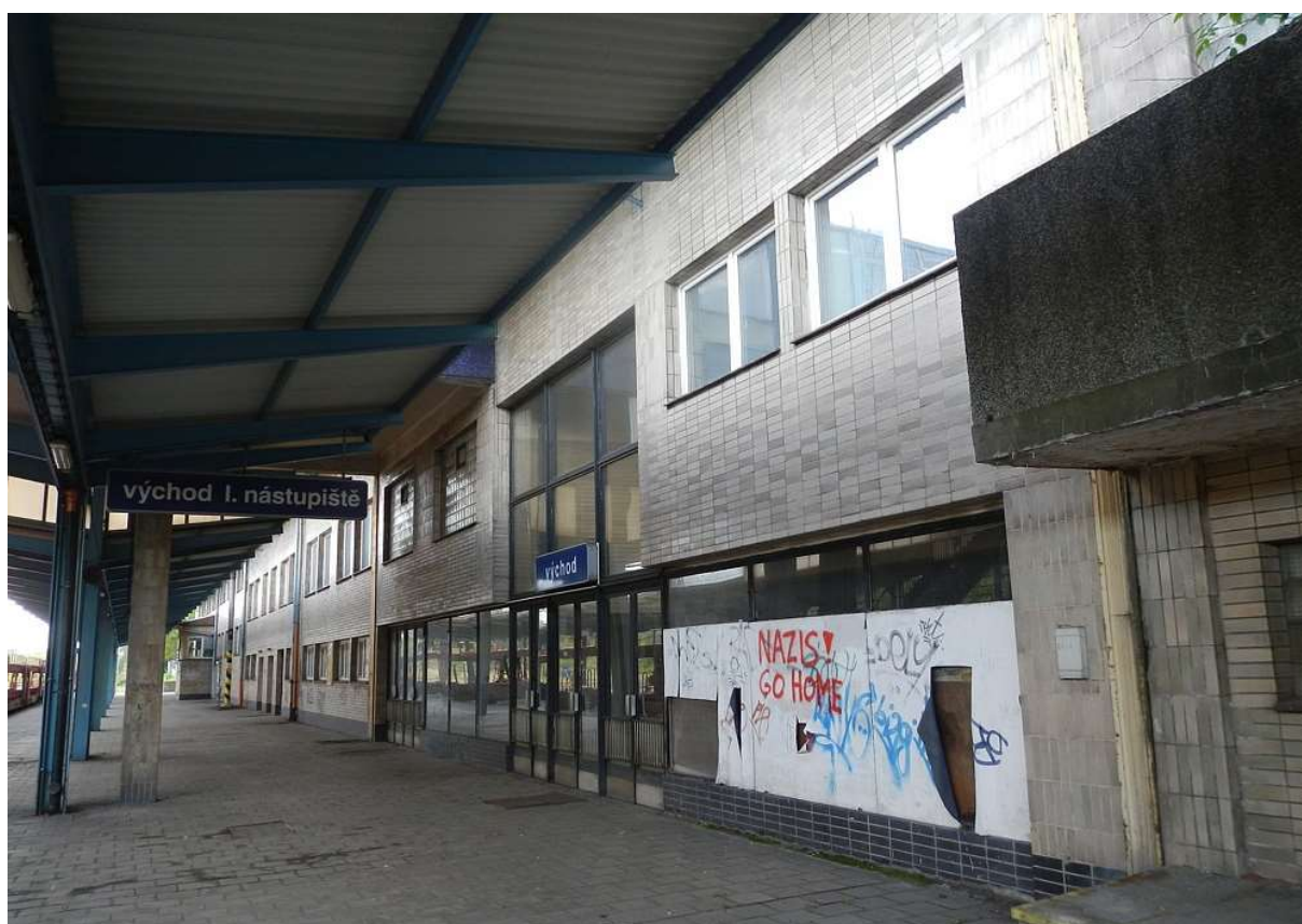
Obrázek 3 Pohled na I. nástupiště Prosklené konstrukce za hranicí životnosti, poškozené a zaslepené. Osvětlení vstupů neadekvátní. Neexistující orientační systém pro cestující. Neexistující bezbariérový přístup na úroveň nástupiště z výpravní budovy. Povrch nástupiště nerovný.
