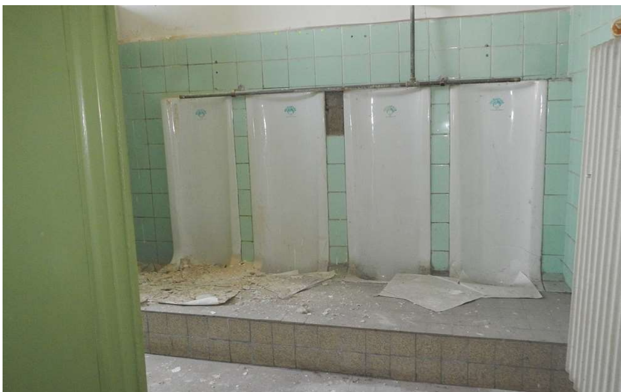
Obrázek 20 Toaleta ve 2.NP Toalety v nevyužívaných prostorech nejsou funkční – nefunkční rozvody. Obklady poničené, nejsou bezbariérové.
