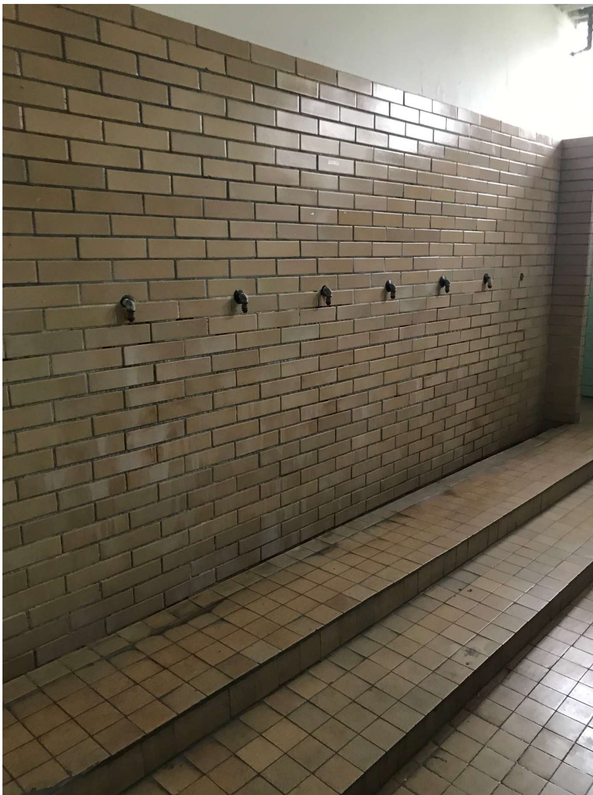
Obrázek 18 1.NP Písoárová stěna WC muži – veřejnost Nevyhovující, není bezbariérové WC, bez splachování.
