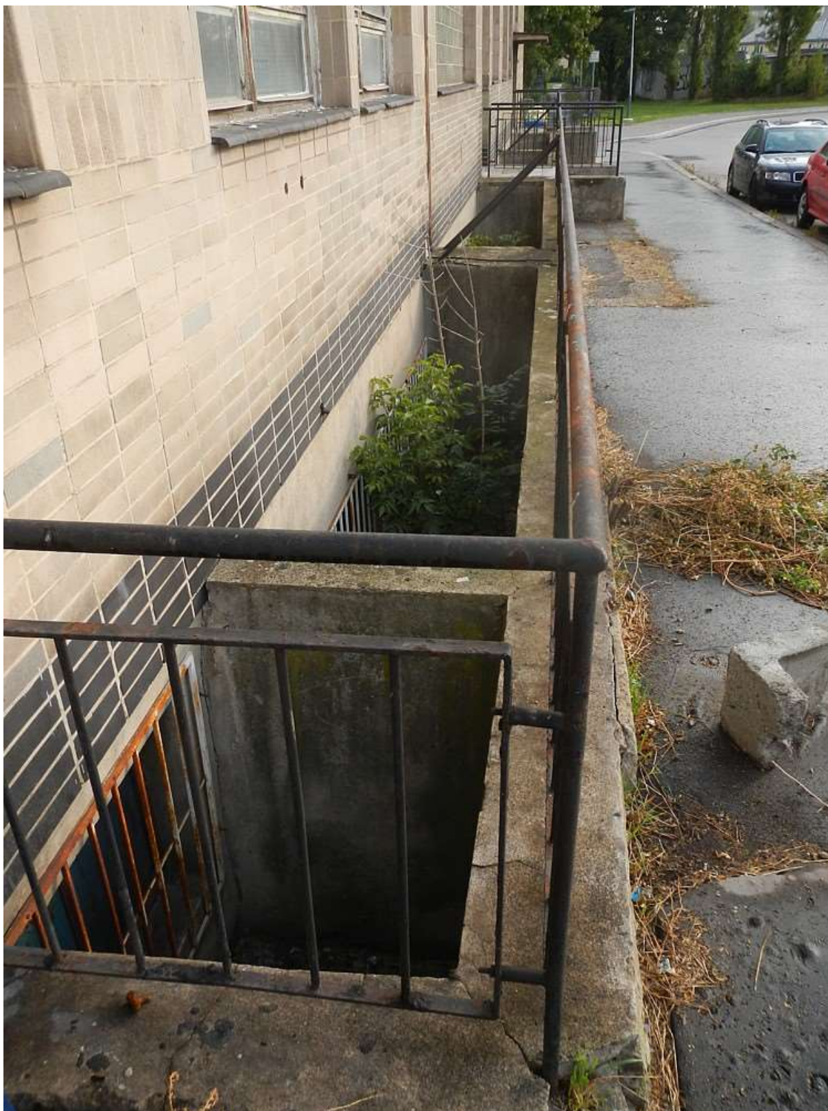
Obrázek 8 Exteriér výpravní budovy 2 Anglické dvorky na jižní fasádě. Degradované konstrukce zábradlí, náletová zeleň. Poškození konstrukce v místě dilatací. Vandalismus.
