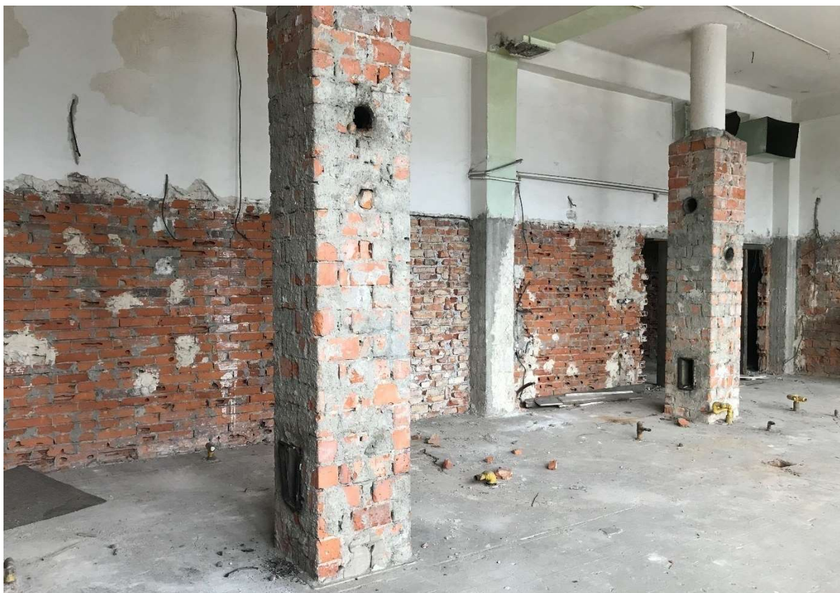
Obrázek 24 Prostor bývalé restaurace 2.NP Strhané obklady, chybějící nášlapná vrstva podlahy, nefunkční rozvody, chybějící osvětlení.
