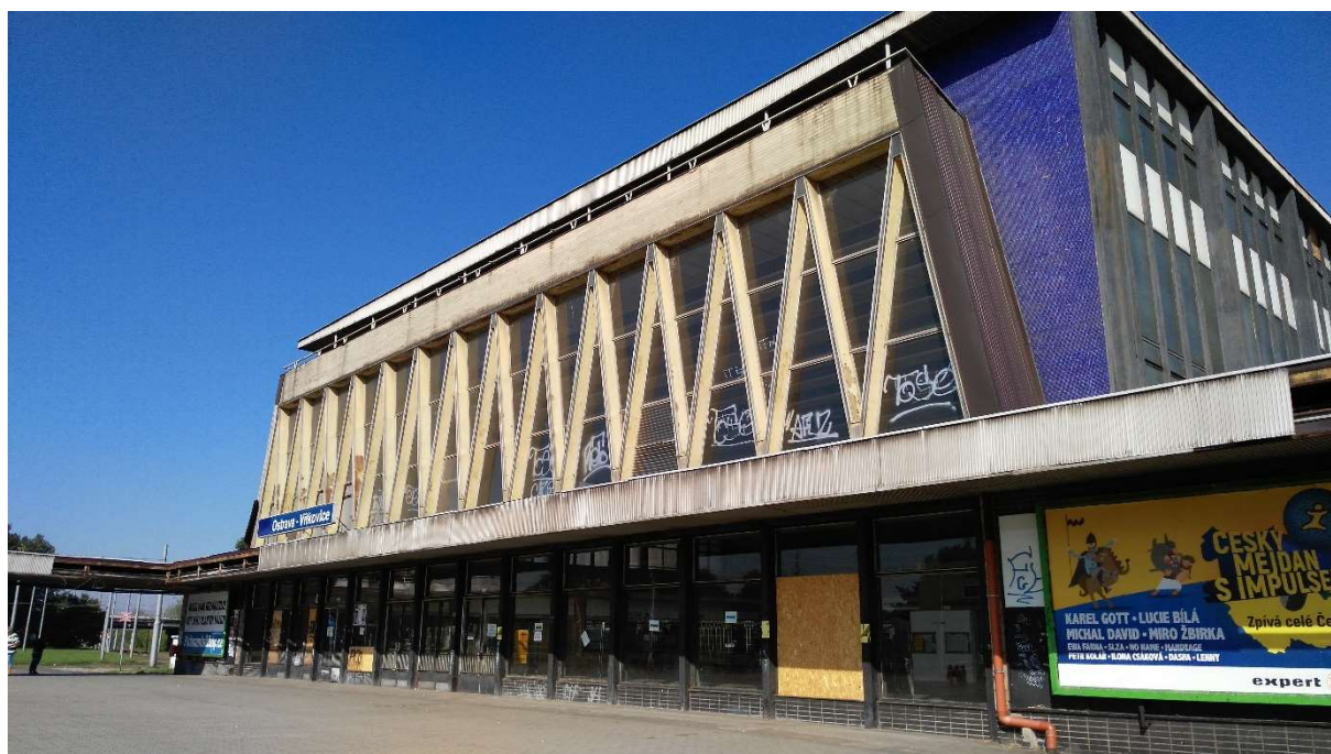
Obrázek 1 Pohled na vstupní část budovy Nosná konstrukce přístřešku v havarijním stavu. Prosklené výplně na hranici životnosti, řešení kanalizace střešních svodů je provizorní. Neexistující orientační systém pro cestující.. Nefunkční hlavní vstup pro cestující z důvodu rizika tříštění skleněných výplní.
