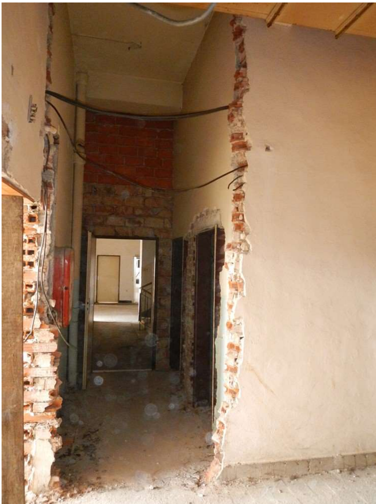
Obrázek 21 Provozní chodba ve 2.NP Část objektu po neodborně provedených demoličních pracích. Konstrukce mnohdy nezajištěné a životu nebezpečné. Rozvody v objektu zničené či ukradené.
