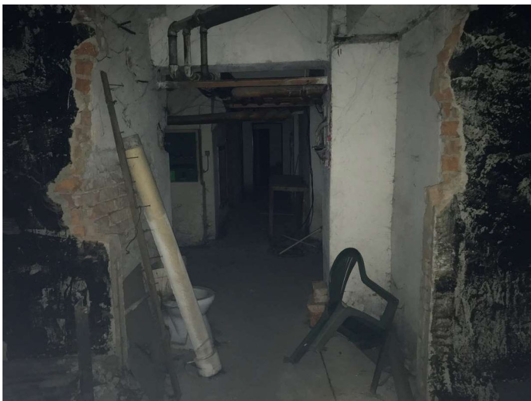
Obrázek 12 1. PP – suterén Místnosti poškozené, neodborné bourací práce, nefunkční osvětlení. Místy lokální problémy s izolací spodní stavby.
