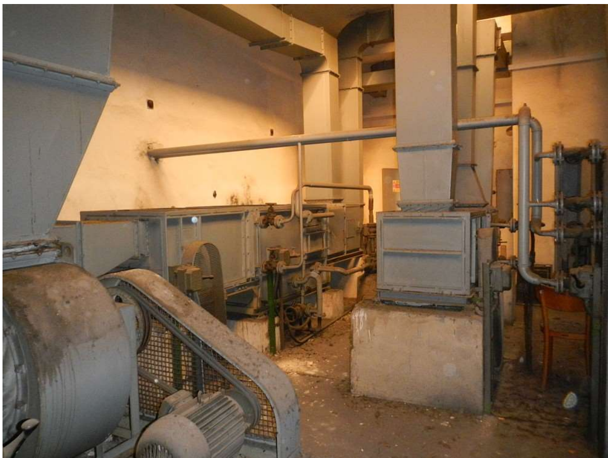
Obrázek 13 1.PP Strojovna vzduchotechniky Strojovna vzduchotechniky v administrační a restaurační části budovy. Neužívaná, rozvody zanedbané, místy chybějící – zničené.
