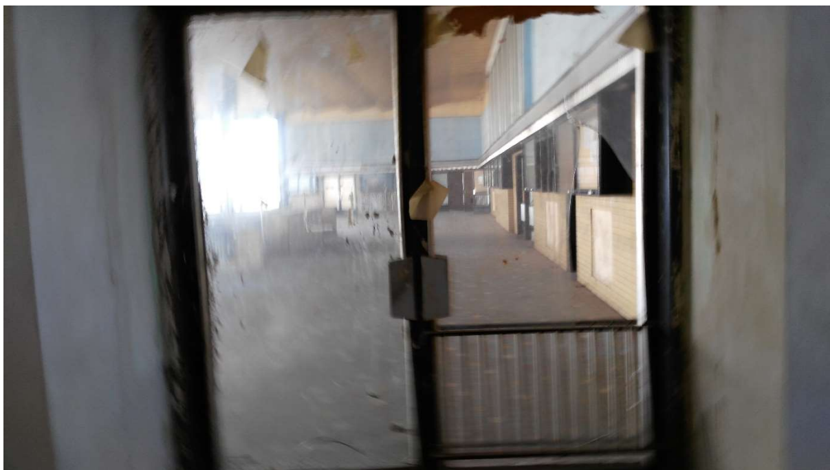
Obrázek 26 Ochoz 2.NP Poškozené a nezajištěné výplně otvorů. Neudržované prostory, poškozená dlažba..
