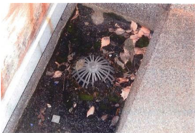
Foto 18 (3949): Zanesená vpust' střešního pláště
