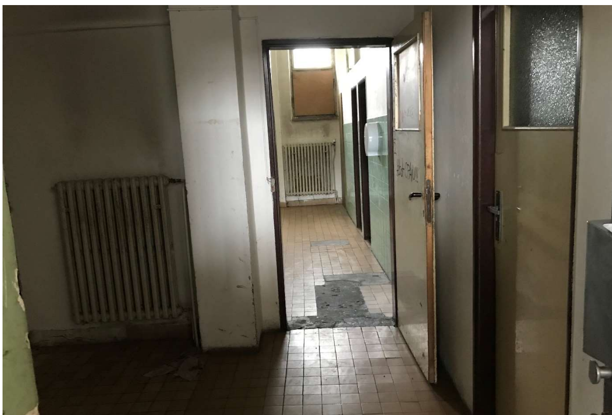
Obrázek 17 1.NP WC muži – veřejnost WC Muži pro cestující – předsíň – nevyhovující osvětlení, hygiena, poškozená a místy chybějící povrchová krytina. Neodpovídající kapacita.
