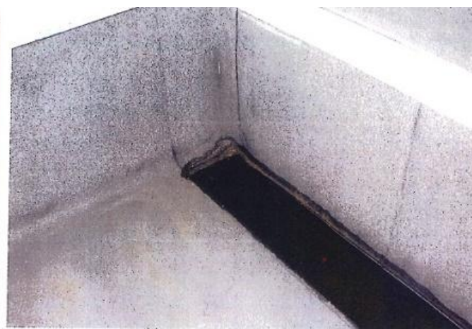
Foto 19 (3959): Neprůchodná vpust', voda ve žlabu
