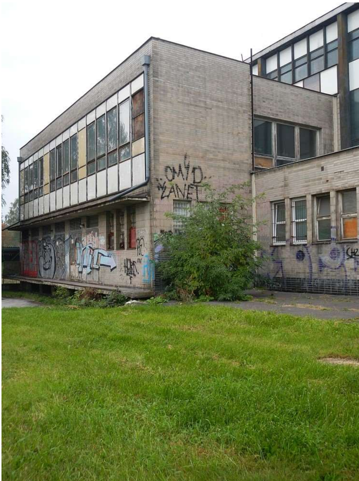
Obrázek 6 Pohled na západní část budovy a objekt nefunkční trafostanice Neadekvátně řešené odvodnění střech, zanedbaná údržba zeleně a následná degradace izolace proti zemní vlhkosti kořenovým systémem. Neadekvátní tepelné parametry výplní. Vandalismus na fasádě budovy.
