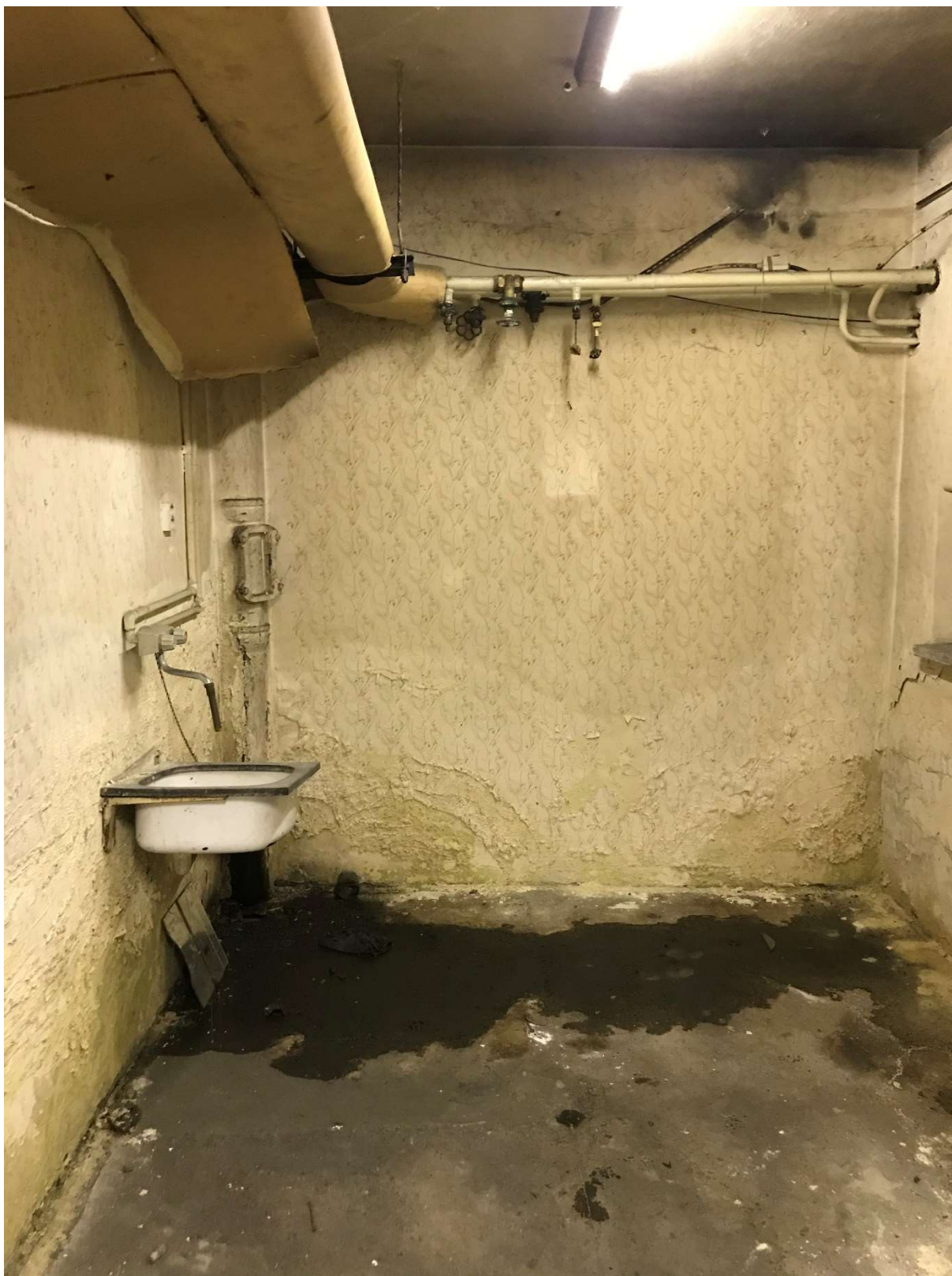
Obrázek 10 1. PP – suterén Nevyužívané prostory, napadeny vlhkostí, zemní izolace poškozená.
