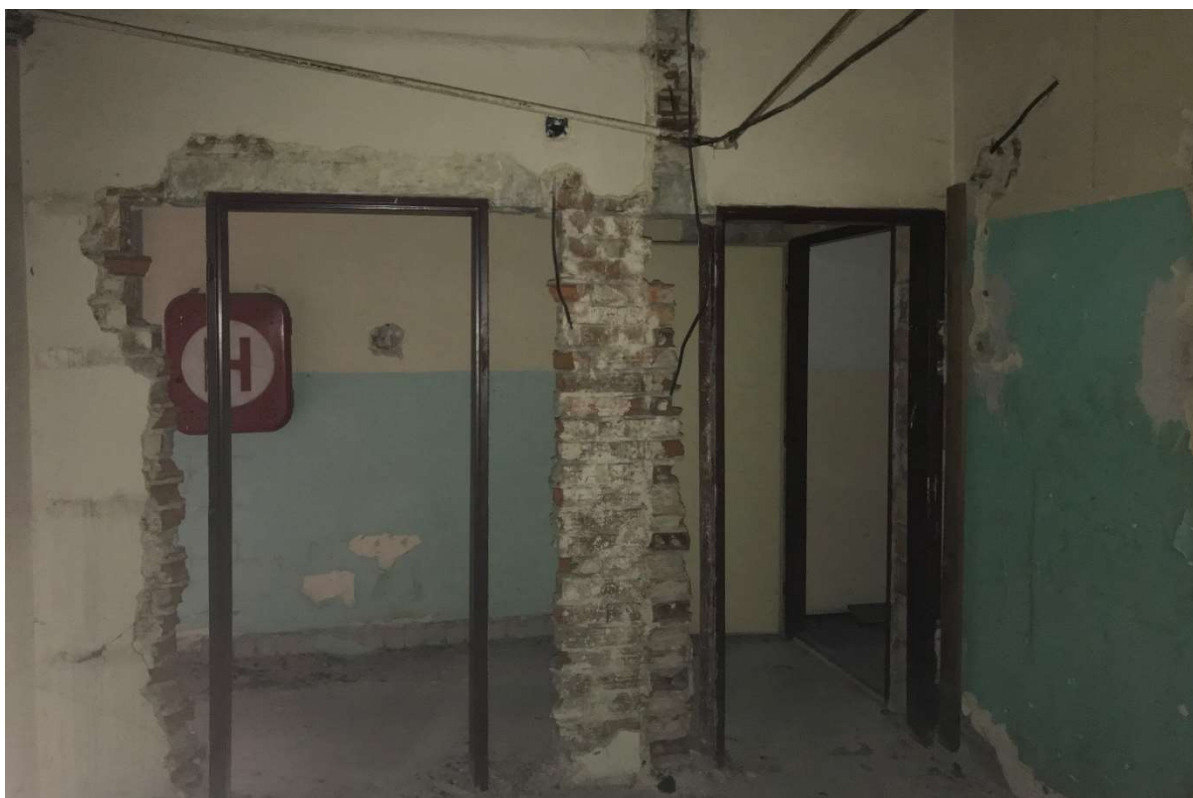
Obrázek 25 2.NP nevyužívané místnosti Neodborně zajištěné bourací práce ohrožující zdraví. Chybějící rozvody osvětlení, poškozené podlahové vrstvy, poškozené omítky.
