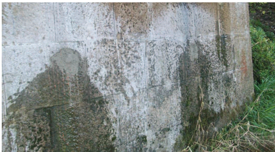
Zapravené otvory po vrtech 3 a 4 po ukončení zkoušek
