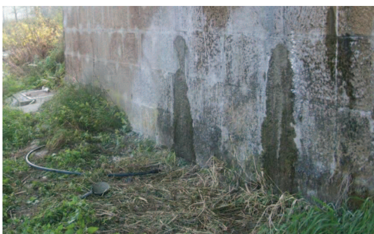
Zapravené otvory po ukončení zkoušek
