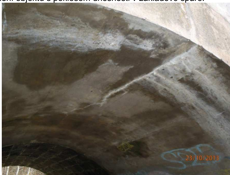
Obr.č. 1 Pohled na trhlinu v betonové klenbě mostního objektu v km 227,178. Průsaky a výluhy s spojené s degradací betonu.
