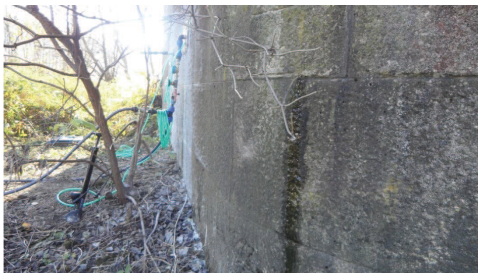
Průsaky spárami zdiva v průběhu zkoušky
