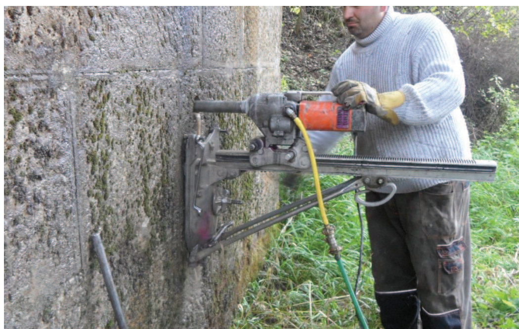
Jádrové vrtání s výplachem
