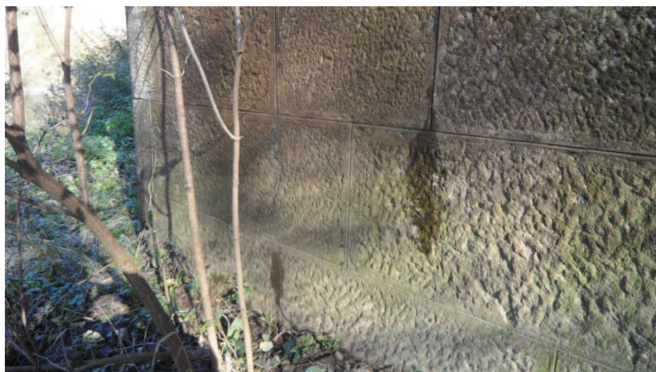
Průsaky spárami zdiva z návodní strany v průběhu zkoušky
