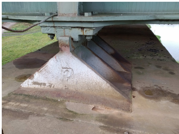
Obr 10. Pevné ložisko na pilíři sP01
