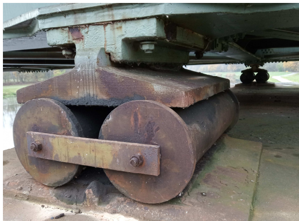
Obr 11. Pohyblivé ložisko na pilíři sP03
