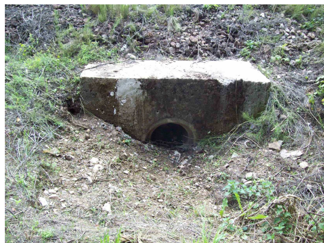
Pohled na vtokové čelo trubního propustku
