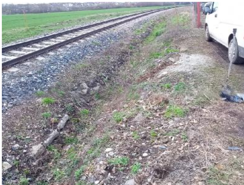
Obr. 3 Pohled na zanesený otevřený zpevněný příkop podél paty odřezu (pro odláždění byla použita spongilitická opuka)
