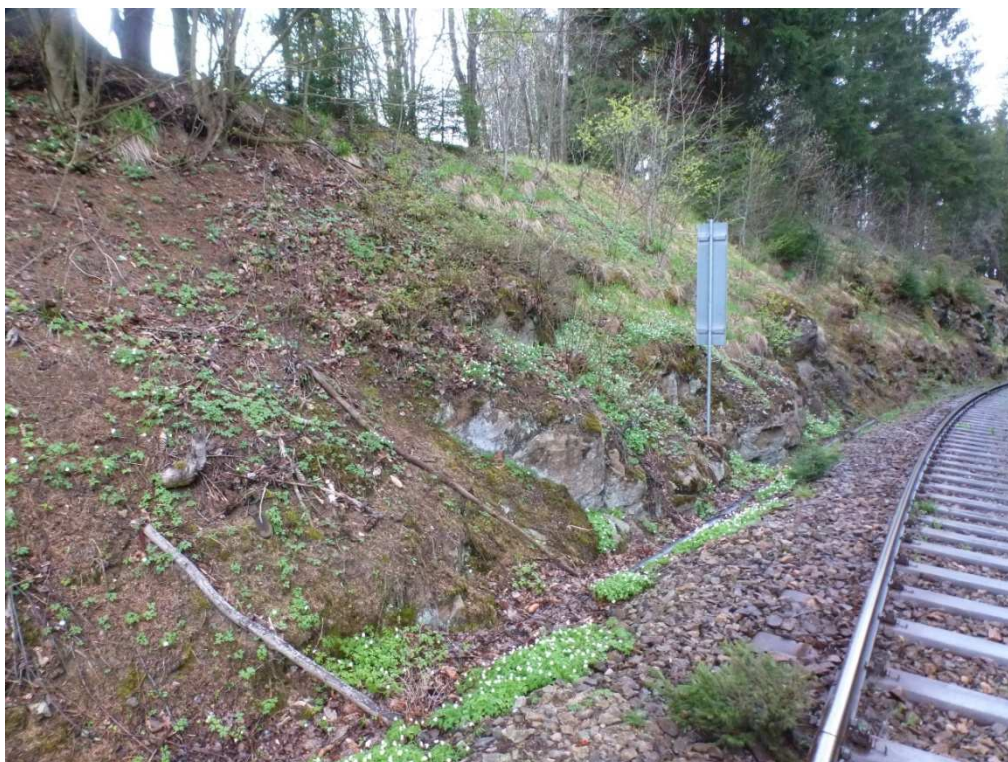
Po očištění a odstranění náletu bude instal. oc. síť 60 x 80 mm s georohoží.
