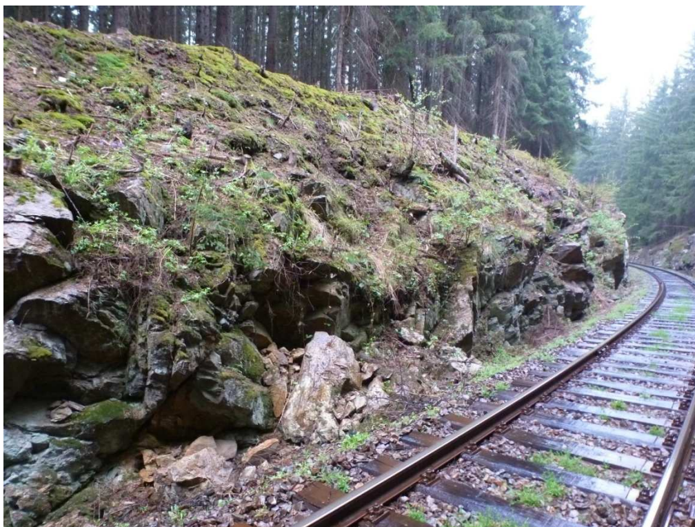
Aku. prostor bude vyčištěný a skal. svah zajištěný ocelovou sítí 60 x 80 mm.
