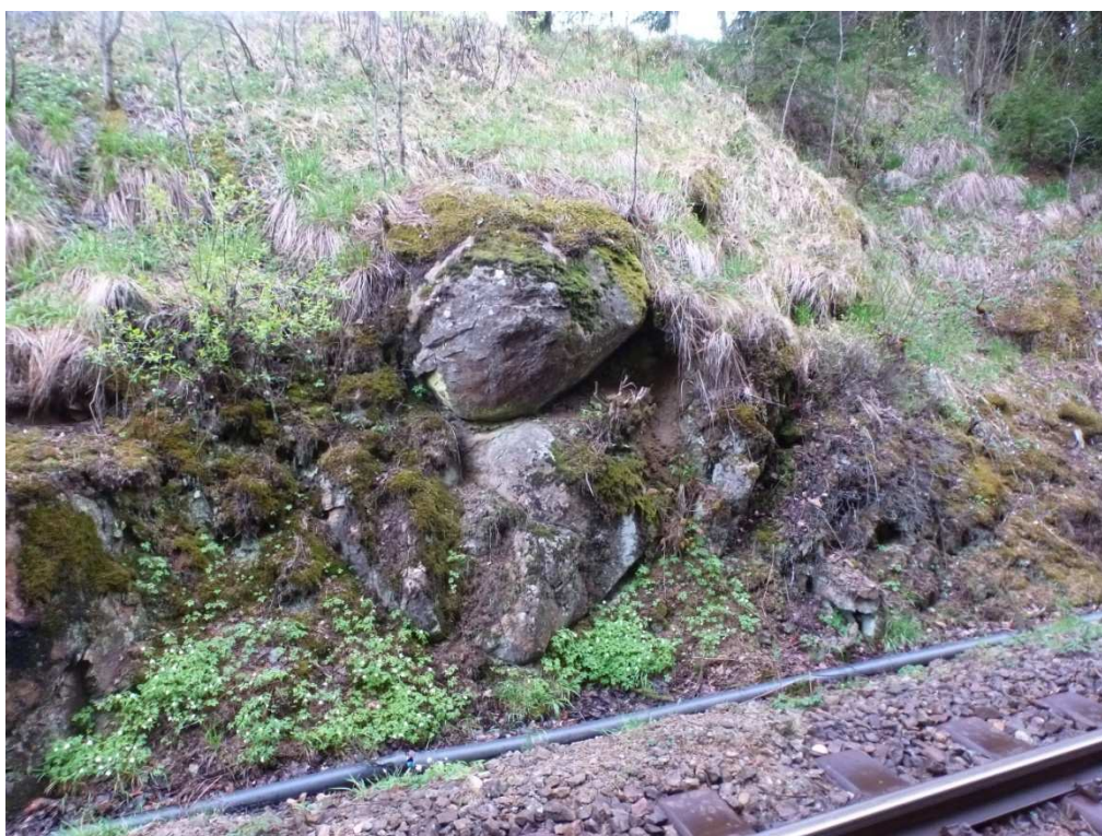
Nestabil. bloky budou odtěženy a bude inst. oc. síť 60 x 80 mm s georohoží.
