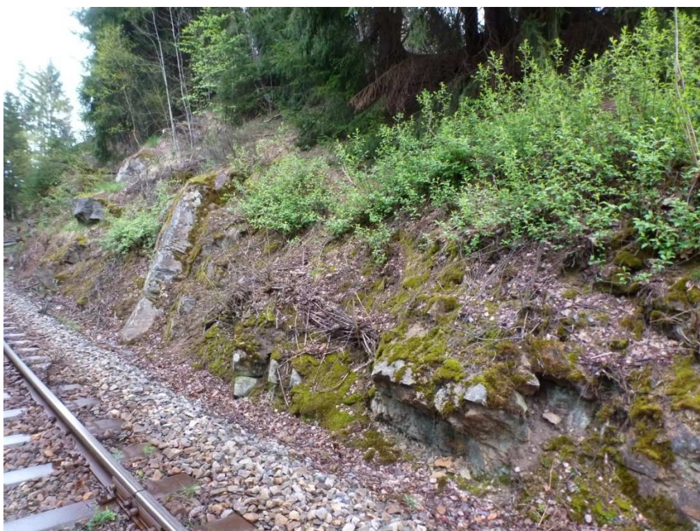
Levá strana skal. svahu bude také zajištěna oc. sítí 60 x 80 mm s georohoží.
