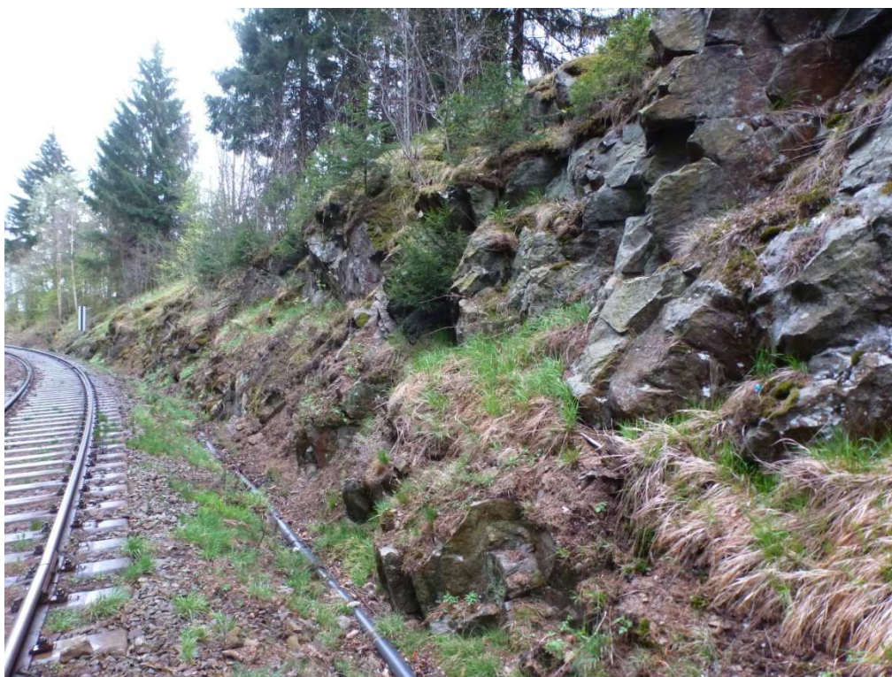
Část skal. svahu, která bude zajištěna kotvenou ocel. sítí 300 x 300 mm.
