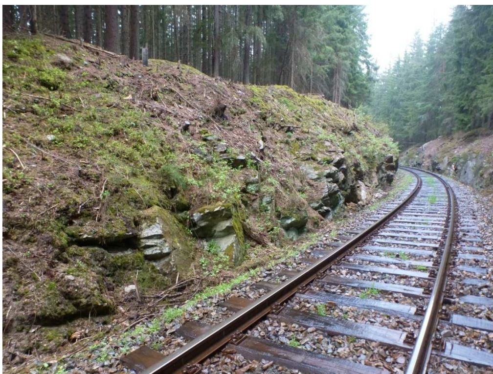
Skal. svah na konci úseku bude očištěný od volných a nestabilních bloků.
