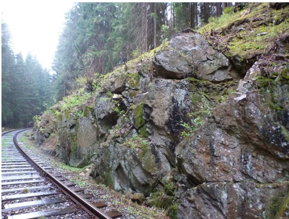
Část skal. svahu, která bude zajištěna kotvenou ocelovou sítí 60 x 80 mm.
