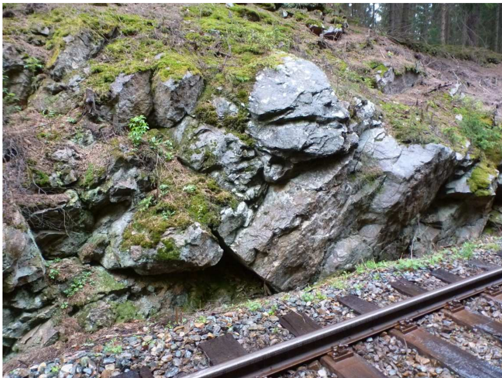
Skal. svah na začátku úseku bude očištěný od volných a nestabilních bloků.
