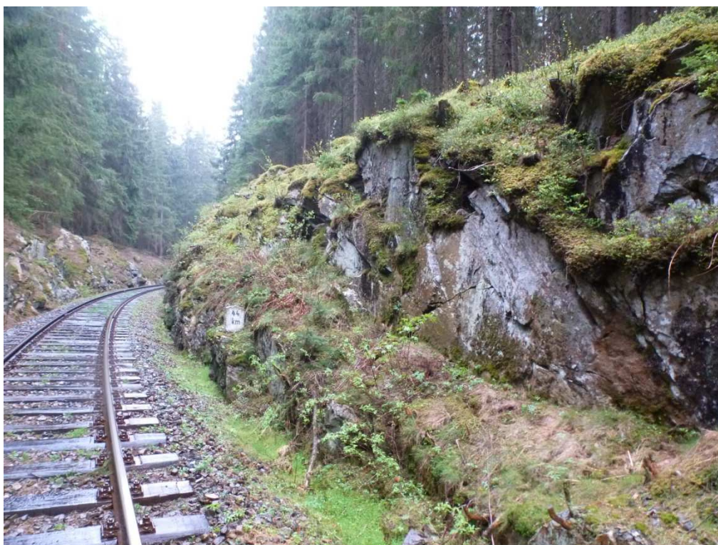
Akumulační prostor bude vyčištěný od napadávek a úlomků skalní horniny.
