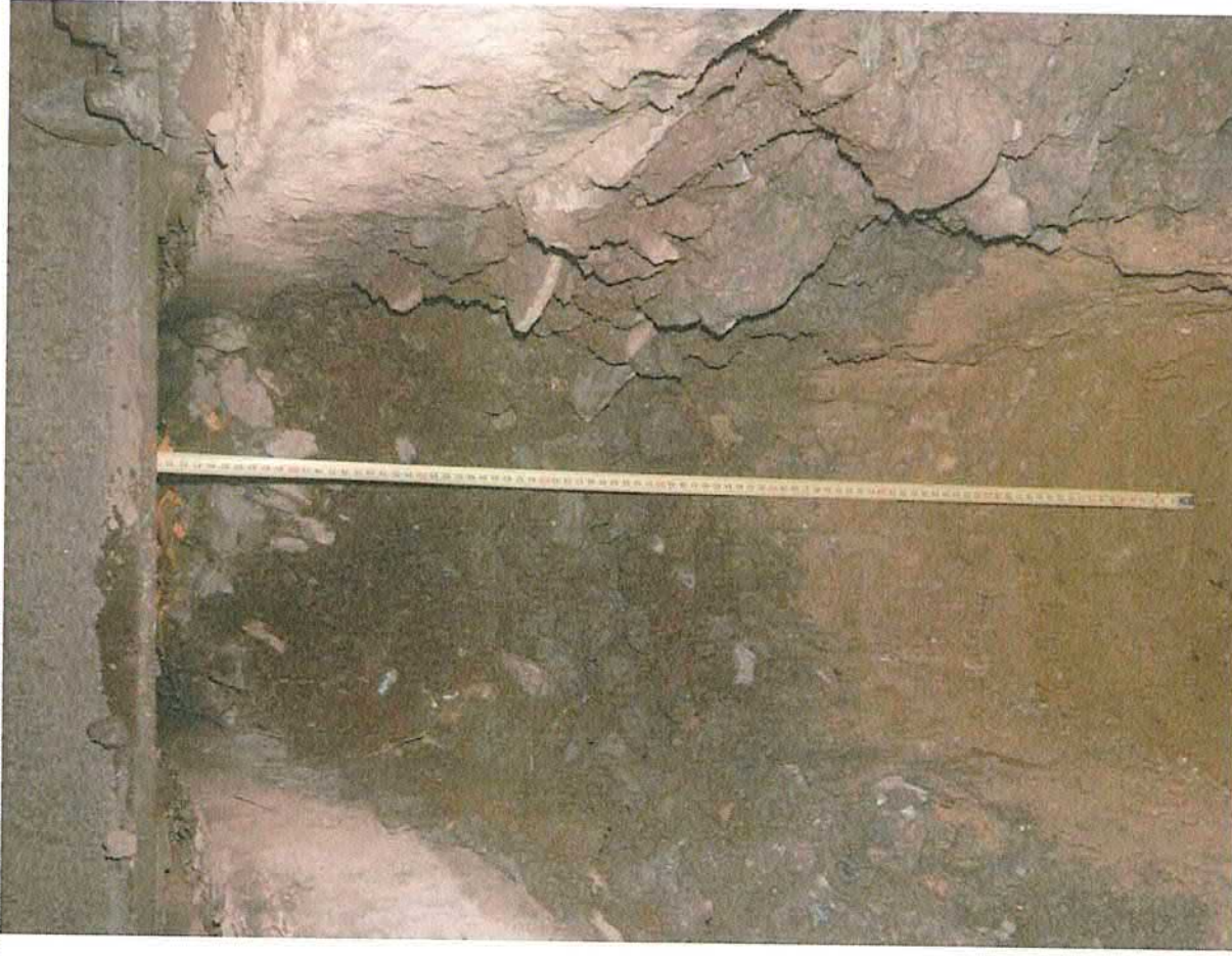
Foto č. 11 – Detail tloušťky konstrukčních vrstev sondy S2
