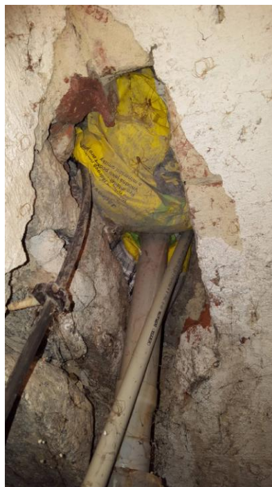
Č.10 – prostup klenbou pro vodovod a kanalizaci
