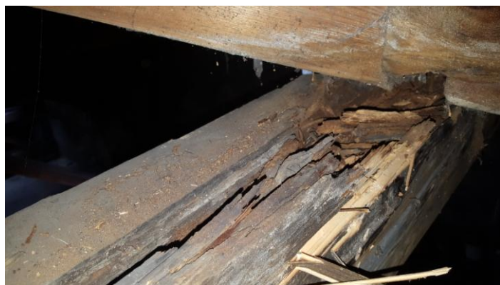
Č.29 - odebraný vzorek dřevní hmoty, odesláno k laboratornímu rozboru mykologem
