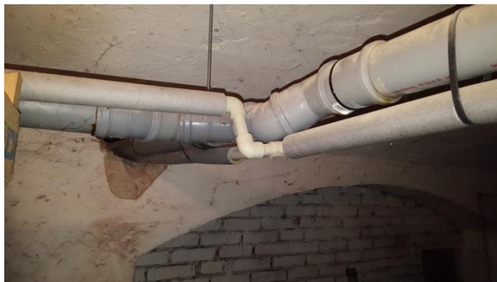
Č.9 – průměr ležatého kanalizačního vedení je DN75
