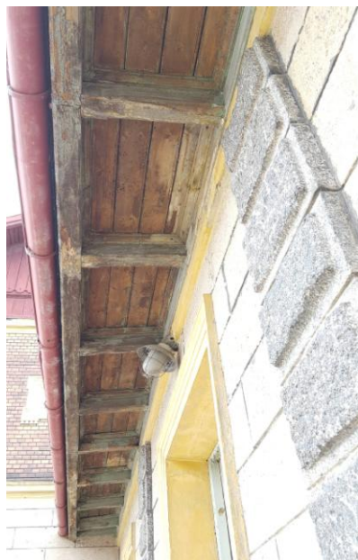
Č.46 – přesah střešní konstrukce
