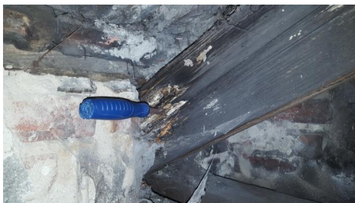
Č.26 – poškození dřevěné krokve
