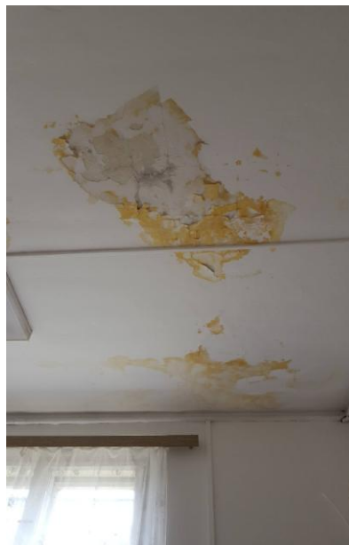
Č.19 – zatékání srážkových vod
