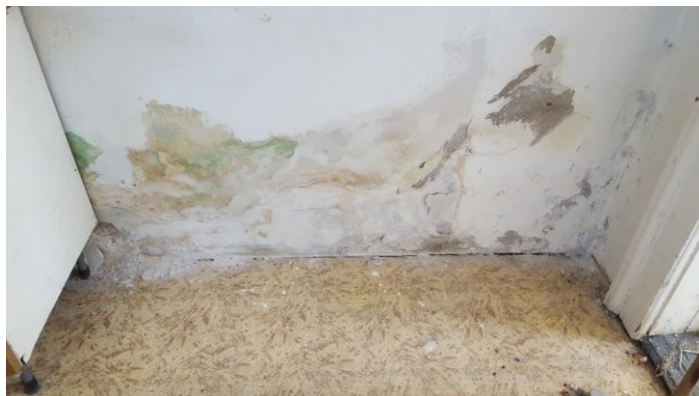
Č.14 – degradovaná vnitřní omítka (vlhkost 5,6%)
