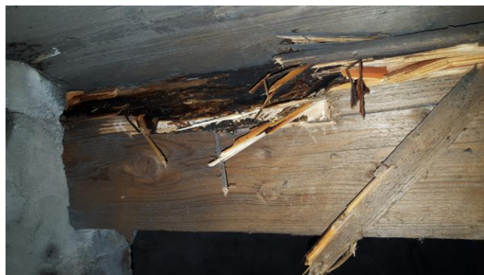
Č.31 – způsobené hloubkové poškození
