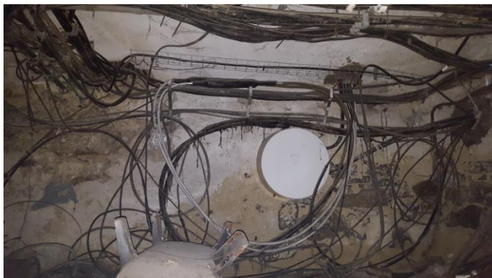
Č.11 – drážní kabelové vedení
