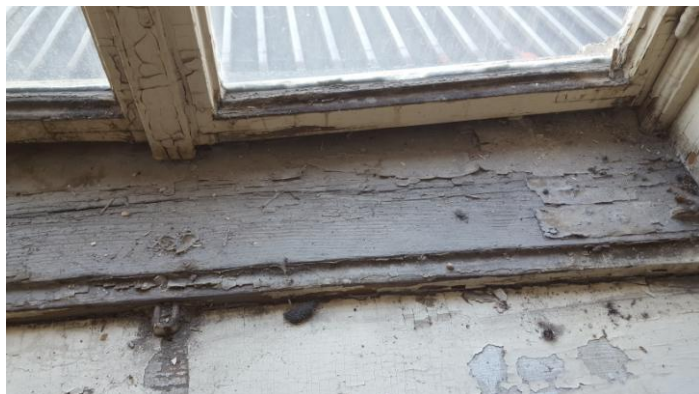
Č.25 – nevyhovující okenní výplň
