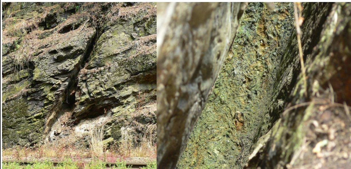
Obr. 3 - Porucha na severovýchodní straně zářezu, směr 322°/65° a rozevření do 30 cm a detail výplně poruchy
