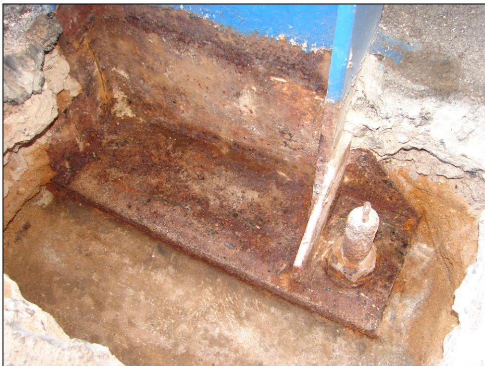
Obr. 64: Sloupy zastřešení nástupišť, 4. nástupiště, sloup 13; detail kotvení sloupu
