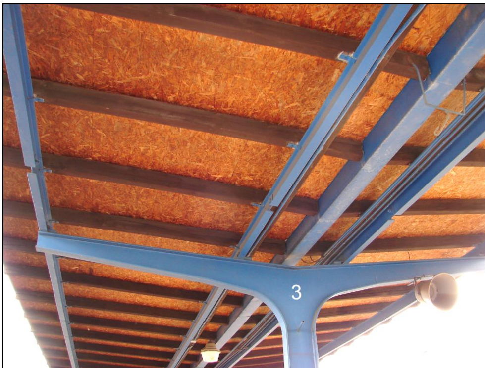
Foto 3: 2. nástupiště, ocelová konstrukce zastřešení v oblasti sloupu 3; bez zjevných známek zasažení koroze
