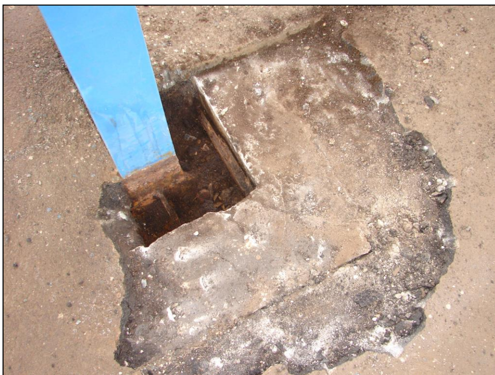
Obr. 40: Sloupy zastřešení nástupišť, 2. nástupiště, sloup 13; po odstranění živičného svršku je patrná betonová obruba, kotevní prvky sloupu byly zasypány pískem a zeminou (značně vlhkou)
