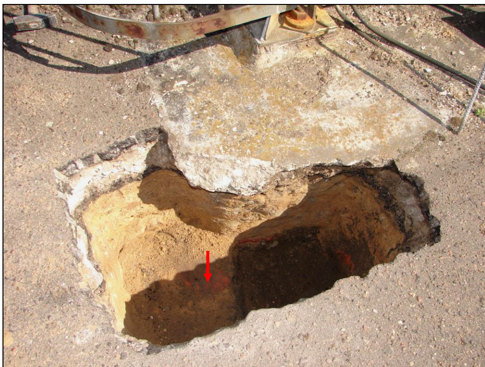
Obr. 19: Sloupy trakčního vedení, sloup 63; vedení sítí kryté cihlami zastřižené v místě vyznačeném na obr. 17 červenou šipkou (zásyp proveden pískem)
