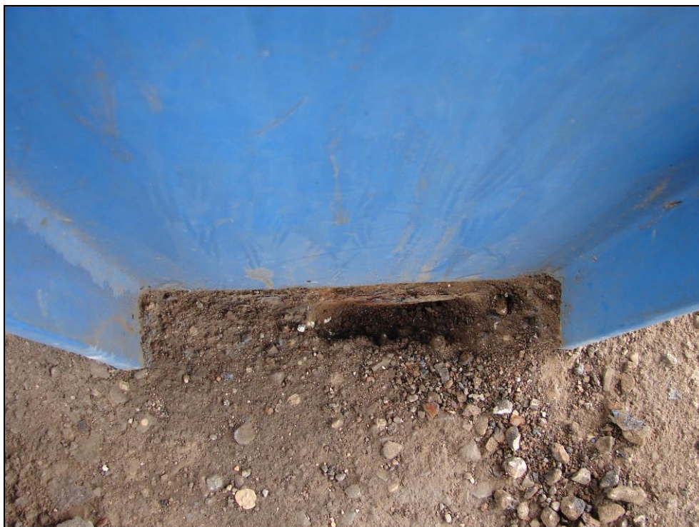
Obr. 54: Sloupy zastřešení nástupišť, 3. nástupiště, sloup 4; pohled na korozní zplodiny z obr. 52 a 53
