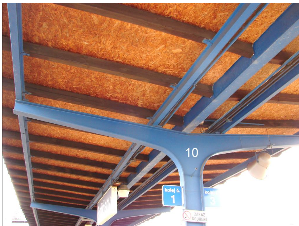
Foto 8: 2. nástupiště, ocelová konstrukce zastřešení v oblasti sloupu 10; bez zjevných známek zasažení korozi
