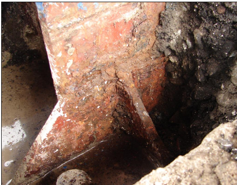
Obr. 58: Sloupy zastřešení nástupišť, 3. nástupiště, sloup 4; pásnice a výztuhy (patrna je voda po provedení jádrového vývrtu)
