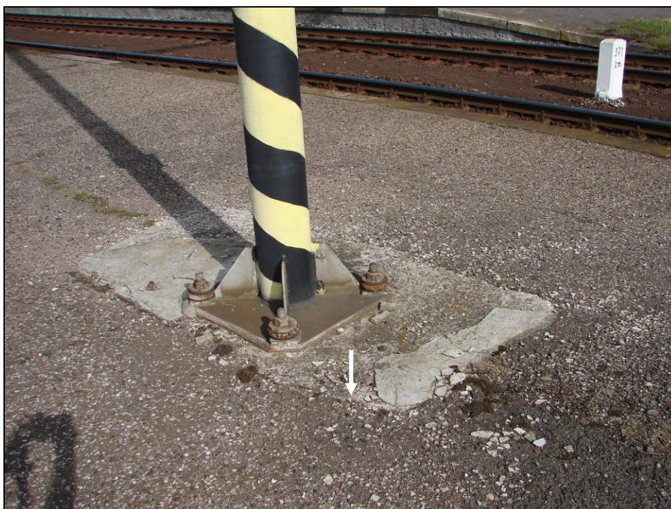
Obr. 28: Sloupy trakčního vedení, sloup 56A; šipkou je vyznačeno místo sondy
