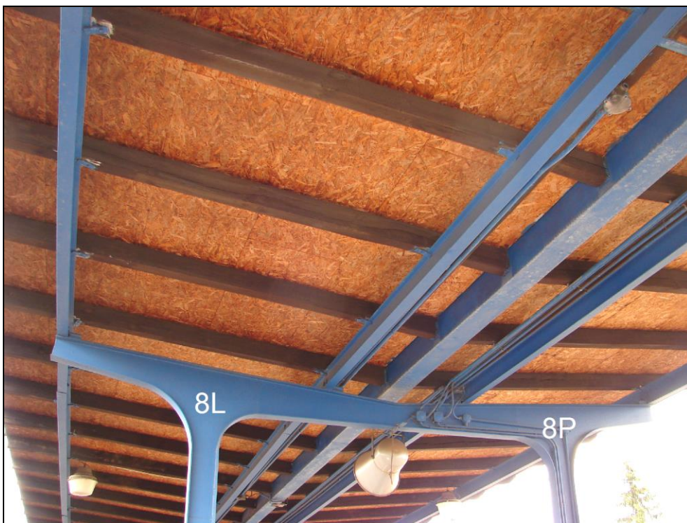
Foto 6: 2. nástupiště, ocelová konstrukce zastřešení v oblasti sloupů 8L a 8P; bez zjevných známek zasažení koroze
