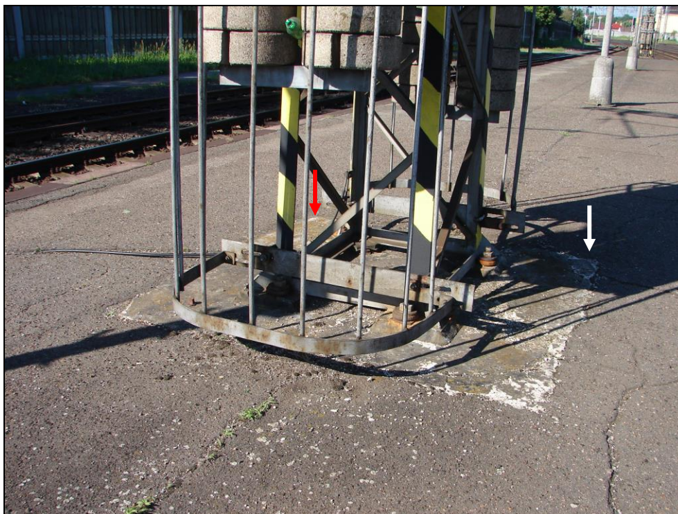
Obr. 17: Sloupy trakčního vedení, sloup 63; v místě vyznačeném bílou šipkou zastiženo vedení sítí (obr. 18), z tohoto důvodu byla v tomto místě sonda ukončena a provedena v místě vyznačeném červenou šipkou
