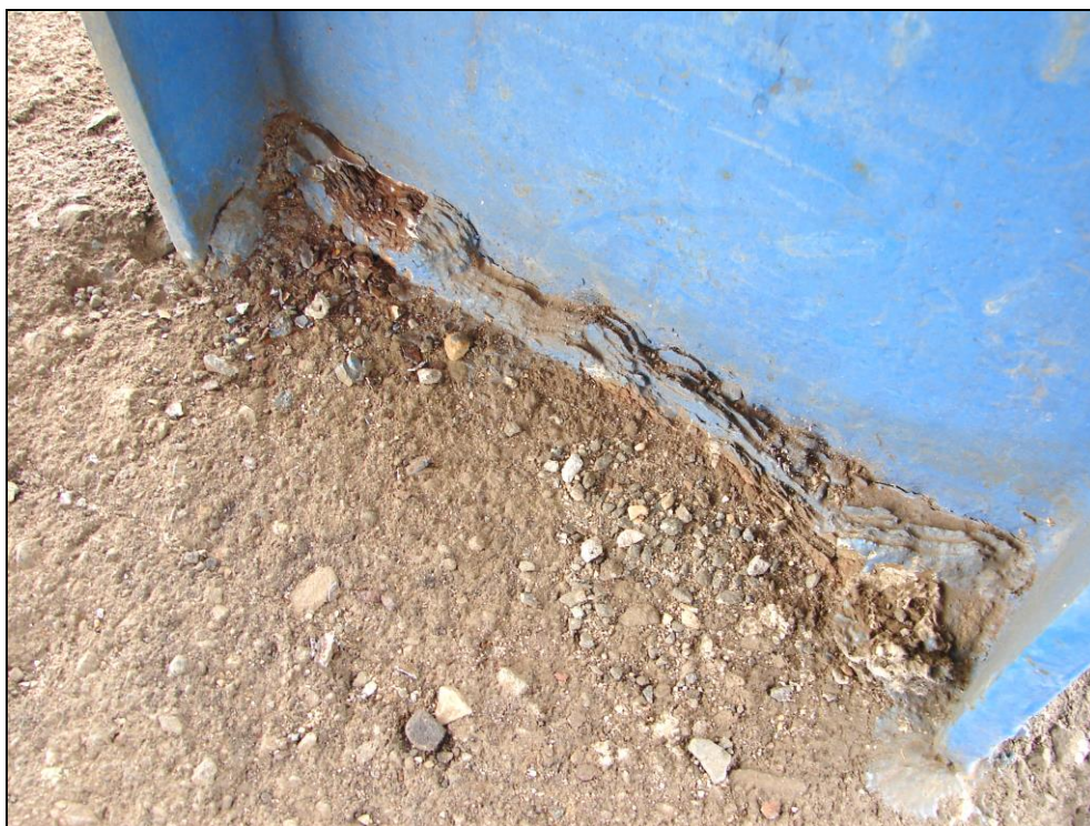
Foto 16: 3. nástupiště, sloup 4 (pohled z druhé strany oproti foto 15); zjevně patrné korozní zplodiny v patě sloupu
