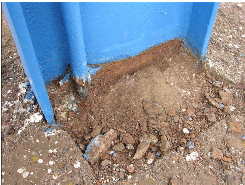
Foto 1: 2. nástupiště, sloup 1; zjevně patrné korozní zplodiny v patě sloupu, lze očekávat korozní úbytky v oblasti kotvení
