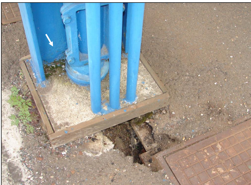
Foto 30: 4. nástupiště, sloup 14; v patě sloupu pod barvou patrné dřívější zasažení korozi (šipka), lze očekávat korozní úbytky v oblasti kotvení parný je i lokální propad svršku nástupiště
