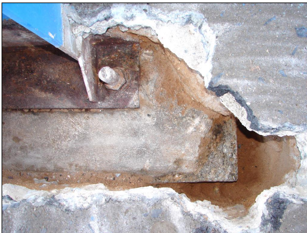
Obr. 66: Sloupy zastřešení nástupišť, 4. nástupiště, sloup 13; patrné hrany horního stupně patky
