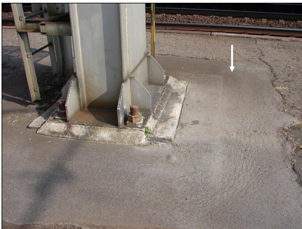
Obr. 4: Návěstidlo Lc1; šipkou je vyznačeno místo sondy, pod živичným svrškem se prokresluje hrana stupňovité patky
