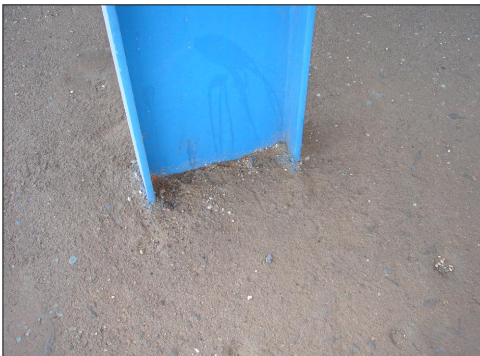
Foto 28: 4. nástupiště, sloup 13; pata sloupu s lokální povrchovou korozí bez tvorby korozních zplodin, sondou nebyly zjištěny korozní úbytky v oblasti kotvení (Příloha 3)
