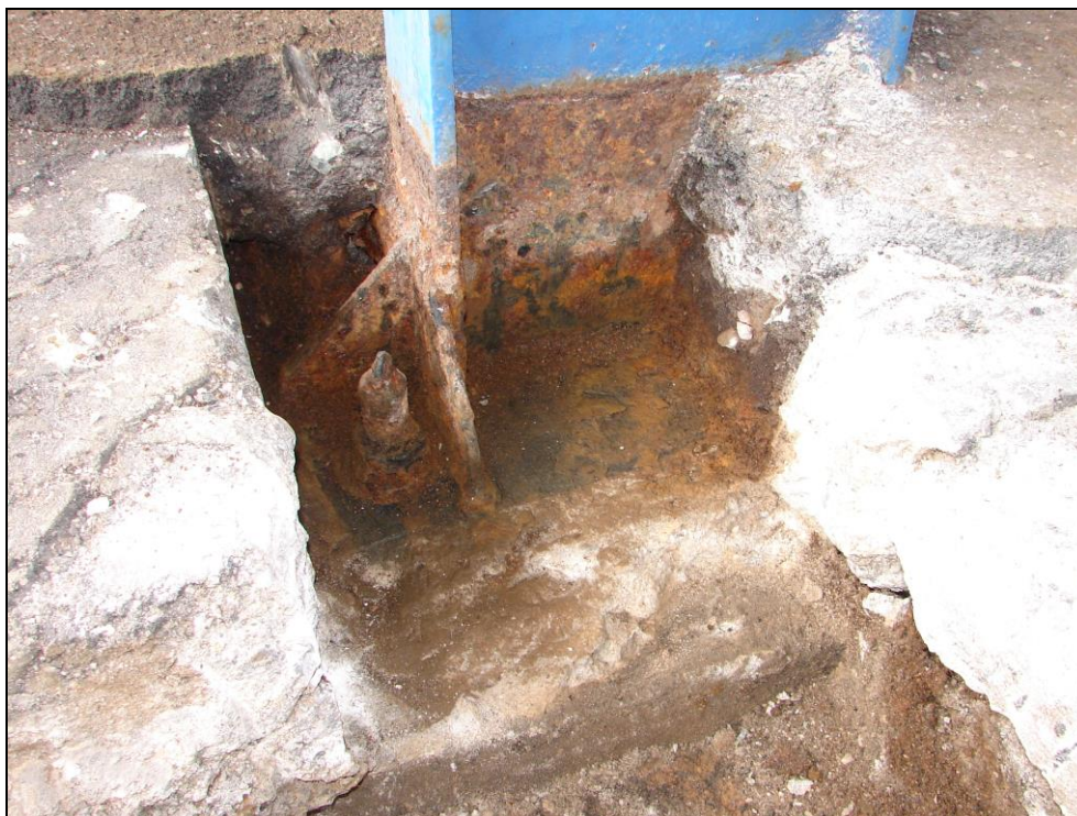
Obr. 46: Sloupy zastřešení nástupišť, 2. nástupiště, sloup 13; detail z obr. 45, patrná je základová patka a způsob kotvení sloupu
