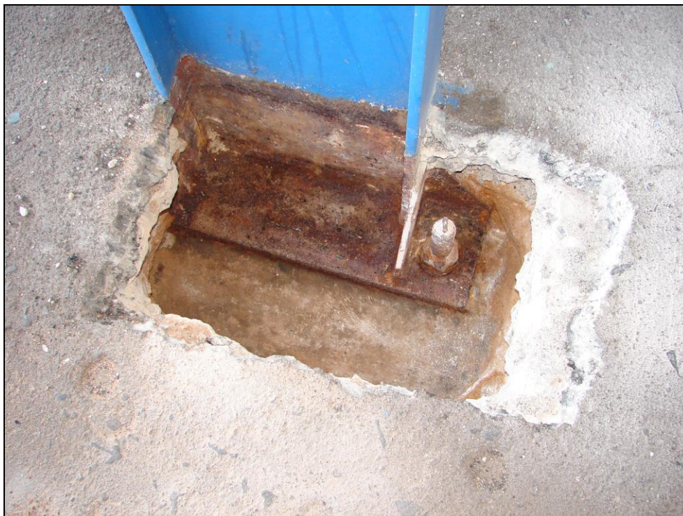
Obr. 63: Sloupy zastřešení nástupišť, 4. nástupiště, sloup 13; sloup nemá kolem kotvení betonovou ohrubu (na rozdíl od předchozích sloupů), pod živičným svrškem je nad kotvením vrstva betonu, kotevní prvky jsou zasypány pískem
