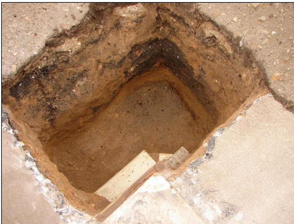
Obr. 8: Návěstidlo Lc1; na dně kopané sondy je patrný horní líc spodního stupně patky, patrné jsou i hrany spodního stupně
