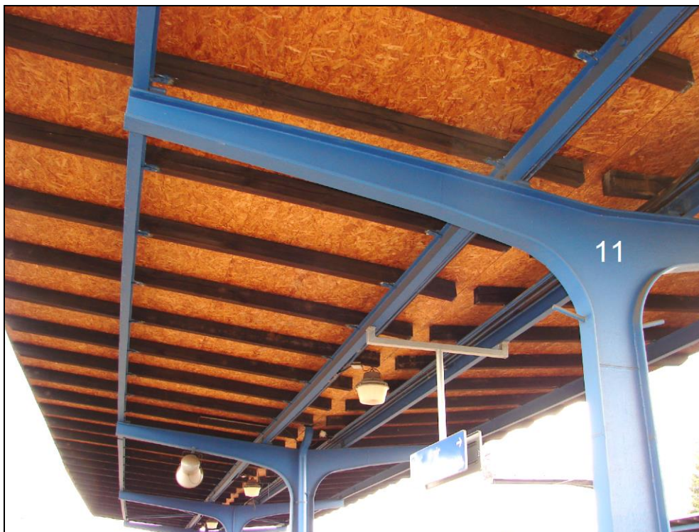
Foto 19: 3. nástupiště, ocelová konstrukce zastřešení v oblasti sloupu 11; bez zjevných známek zasažení koroze
