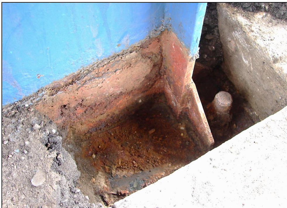
Obr. 56: Sloupy zastřešení nástupišť, 3. nástupiště, sloup 4; korozní zplodiny zejména na stojině sloupu
