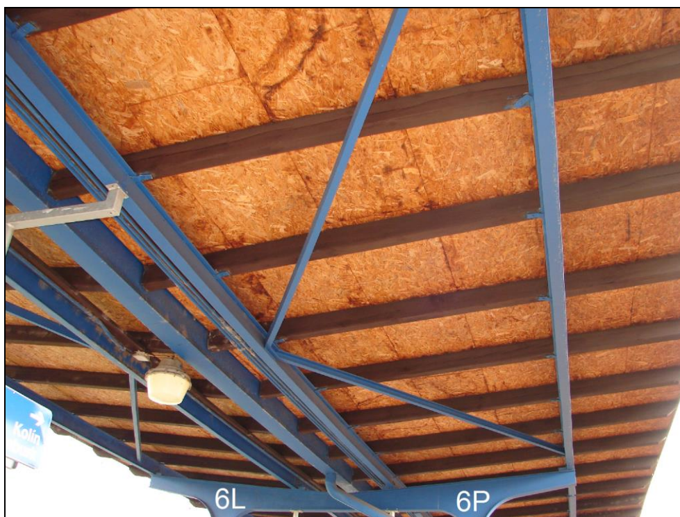
Foto 23: 4. nástupiště, ocelová konstrukce zastřešení v oblasti sloupů 6L a 6P; bez zjevných známek zasažení koroze
