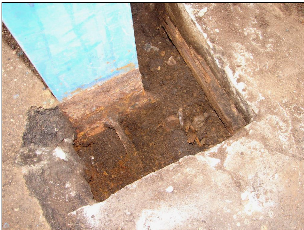
Obr. 41: Sloupy zastřešení nástupišť, 2. nástupišť, sloup 13; kotevní prvky sloupu byly zasypány pískem a zeminou, patrný je i zbytek šalování obruby
