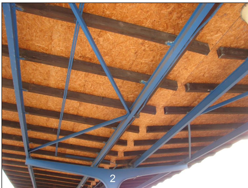
Foto 13: 3. nástupiště, ocelová konstrukce zastřešení v oblasti sloupu 2; bez zjevných známek zasažení korozí
