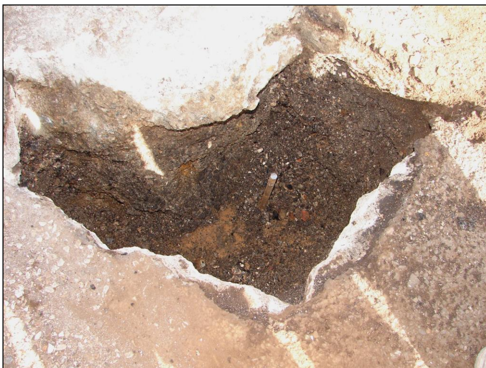
Obr. 30: Sloupy trakčního vedení, sloup 56A; patrná je ocelová tyč zaražená do hl. > 2,0 m pro zjištění příp. ozubu (rozšířeného stupně) patky, zásyp proveden škvárou, pod níž je písek, patka betonována do výkopu
