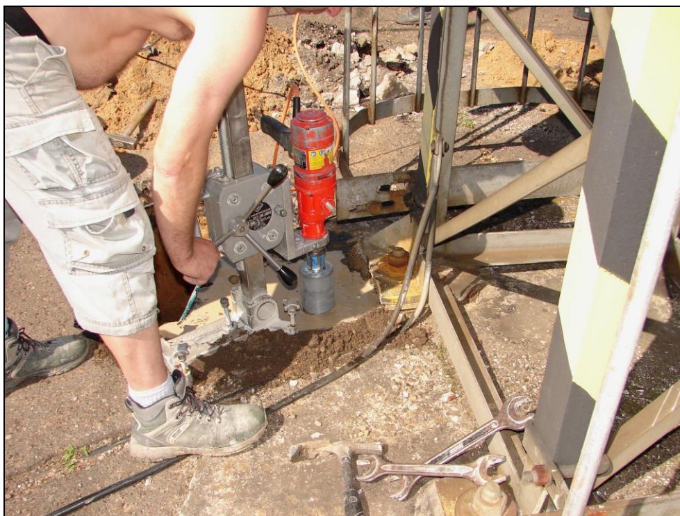
Obr. 23: Sloupy trakčního vedení, sloup 63; provádění jádrového vývrtu Ø 80 mm pro zjištění hloubky založení
