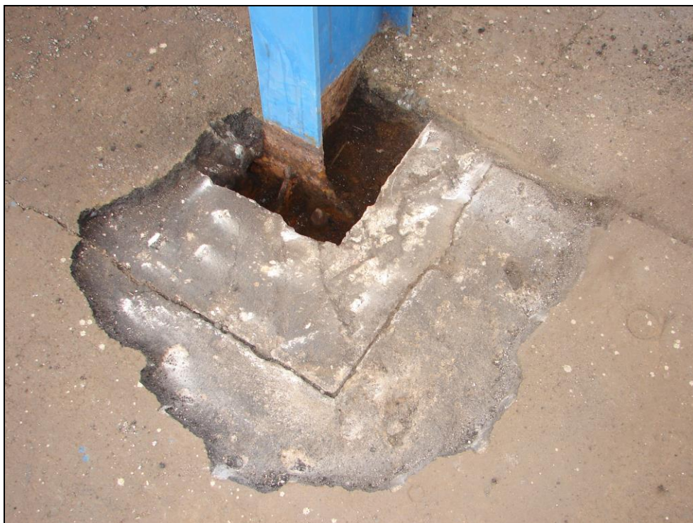
Obr. 43: Sloupy zastřešení nástupišť, 2. nástupiště, sloup 13; sonda po vyčištění oblasti kotvení sloupu
