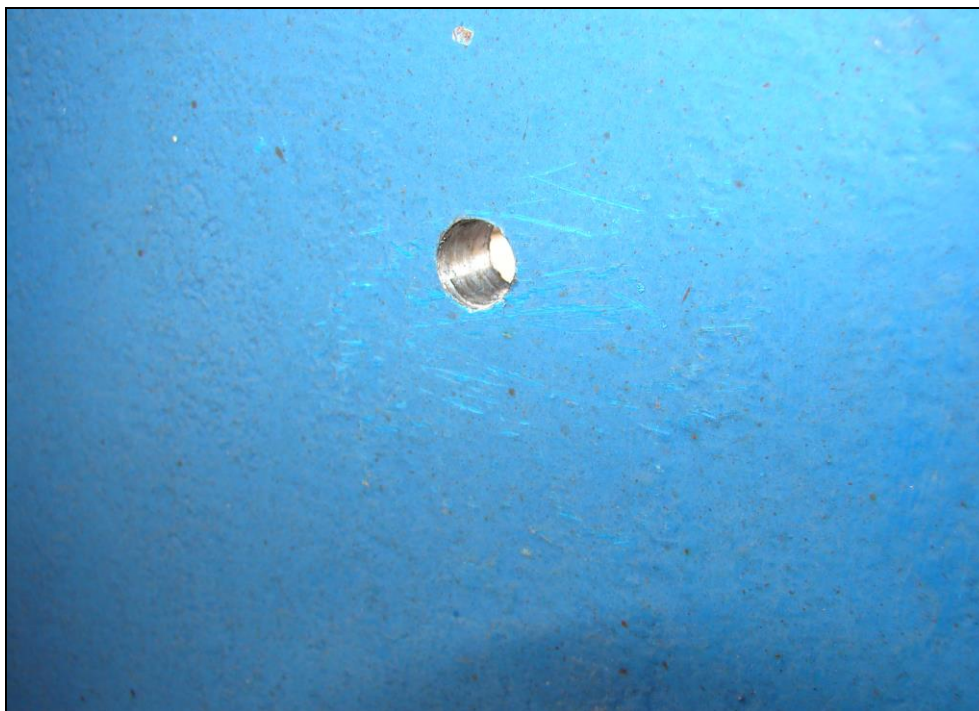
Obr. 59: Sloupy zastřešení nástupišť, 3. nástupiště, sloup 4; jmenovitá tloušťka plechu stojiny sloupu (10 mm) zjištěna provrtáním
