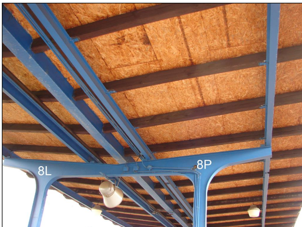
Foto 26: 4. nástupiště, ocelová konstrukce zastřešení v oblasti sloupů 8L a 8P; bez zjevných známek zasažení korozi
