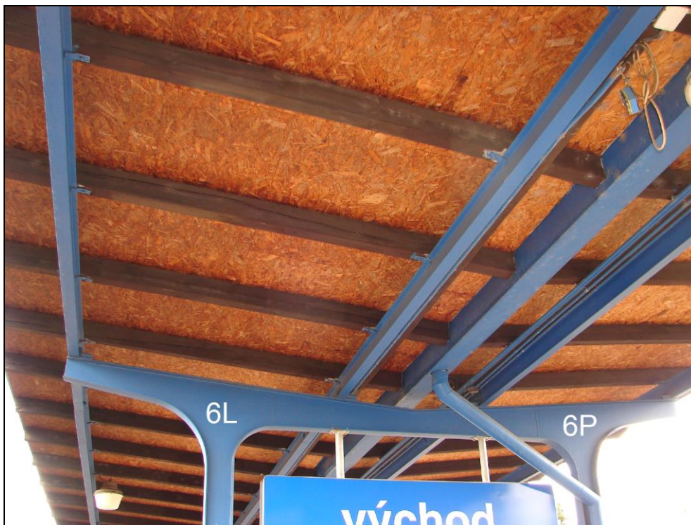
Foto 5: 2. nástupiště, ocelová konstrukce zastřešení v oblasti sloupů 6L a 6P; bez zjevných známek zasažení koroze
