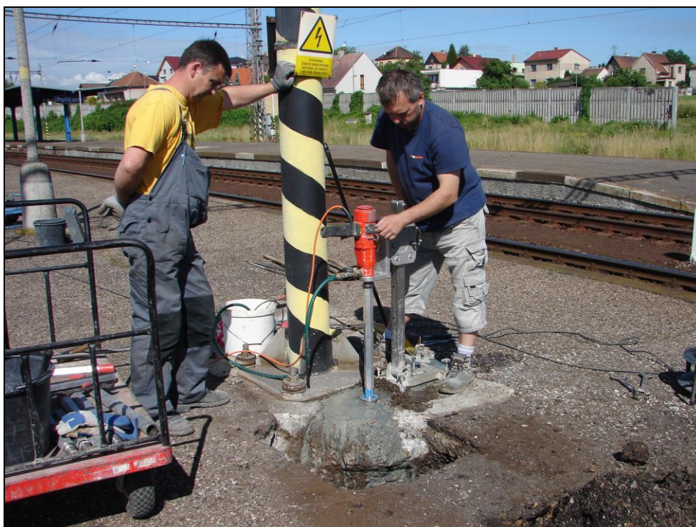
Obr. 31: Sloupy trakčního vedení, sloup 56A; provádění jádrového vývrtu Ø 80 mm pro zjištění hloubky založení
