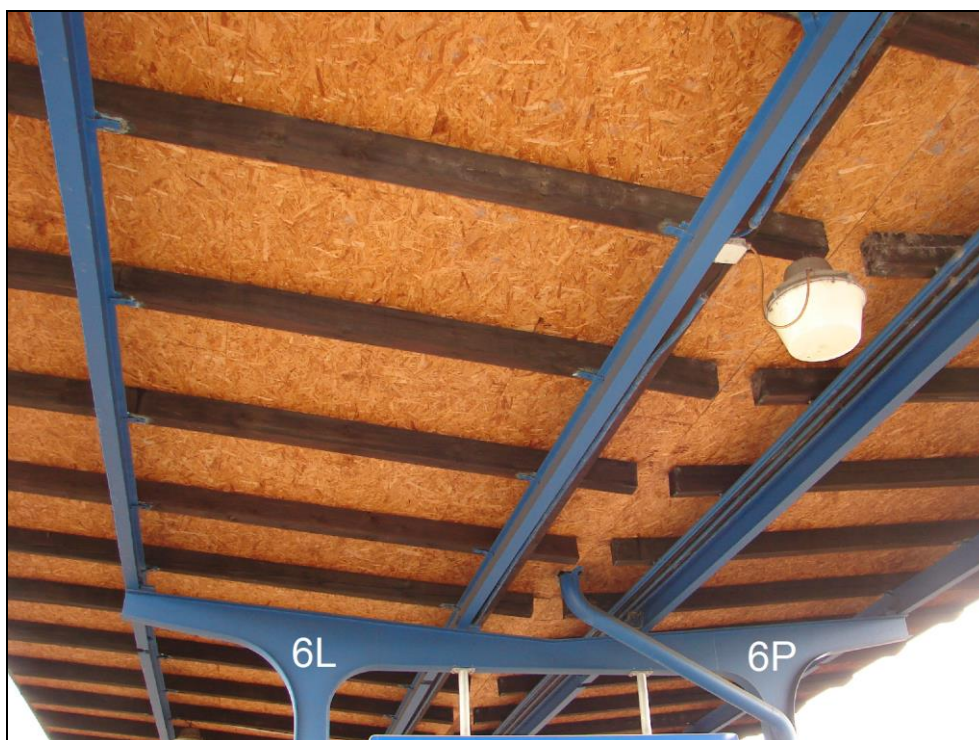
Foto 17: 3. nástupiště, ocelová konstrukce zastřešení v oblasti sloupů 6L a 6P; bez zjevných známek zasažení korozi
