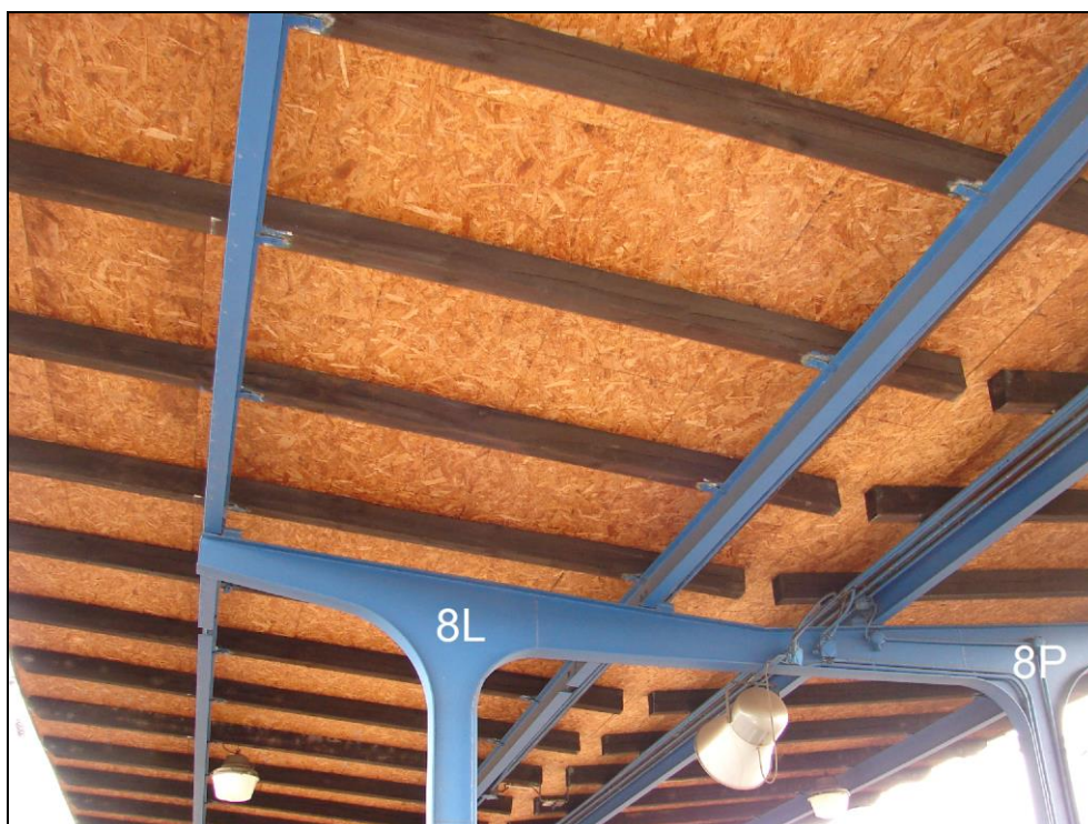
Foto 18: 3. nástupiště, ocelová konstrukce zastřešení v oblasti sloupů 8L a 8P; bez zjevných známek zasažení korozi
