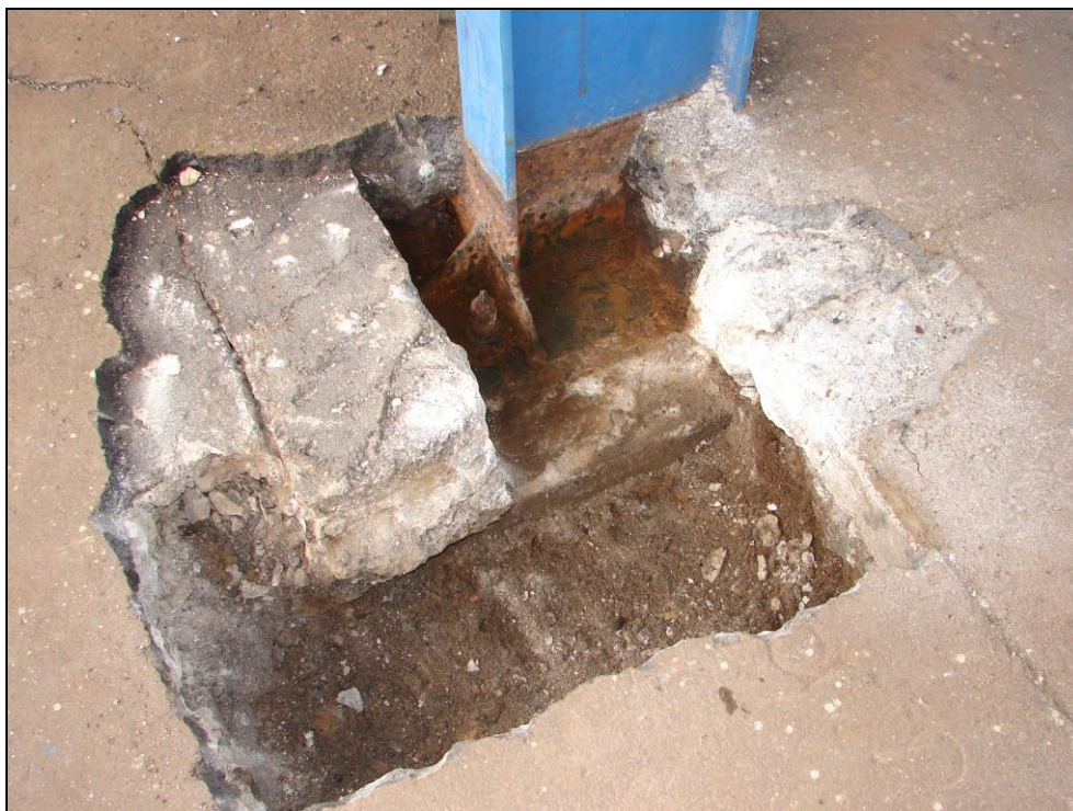
Obr. 45: Sloupy zastřešení nástupišť, 2. nástupiště, sloup 13; částečně vybouraná betonová obruba, patrná je základová patka
