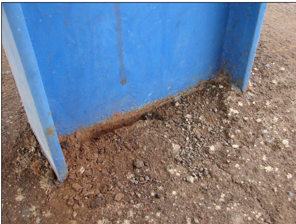
Obr. 39: Sloupy zastřešení nástupišť, 2. nástupiště, sloup 13; v úrovni nástupiště je patrna koroze s tvorbou korozních zplodin
