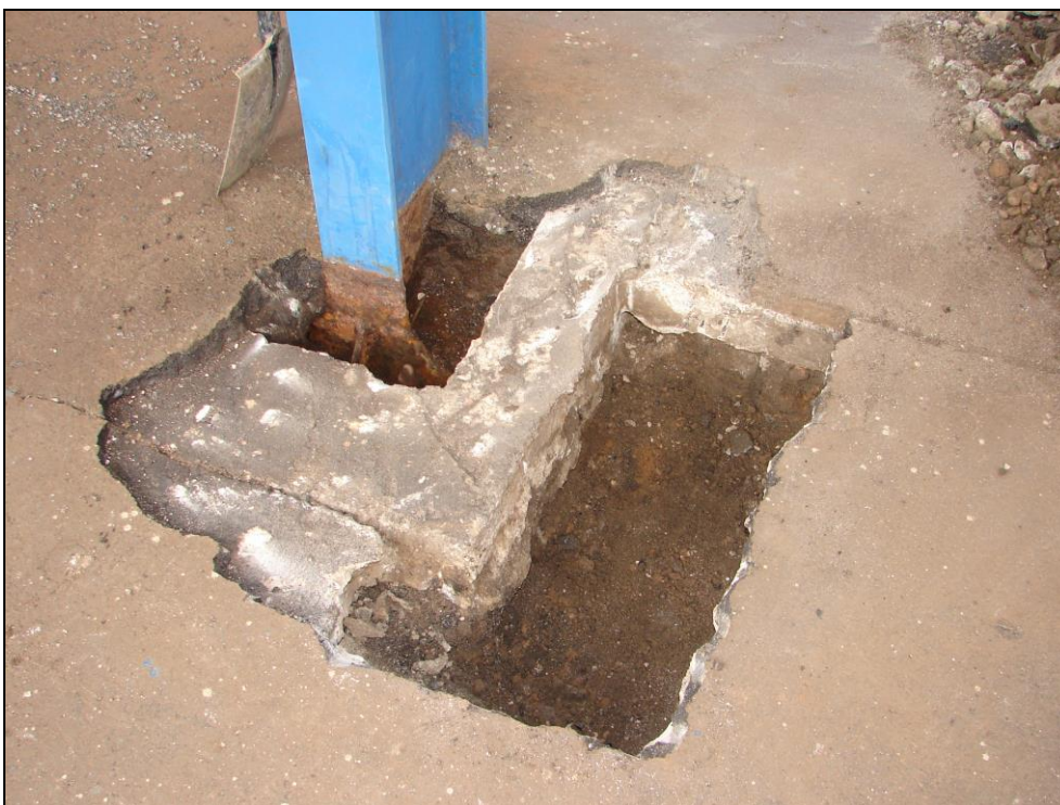
Obr. 44: Sloupy zastřešení nástupišť, 2. nástupiště, sloup 13; následně byla sonda rozšířena za betonovou obrubu
