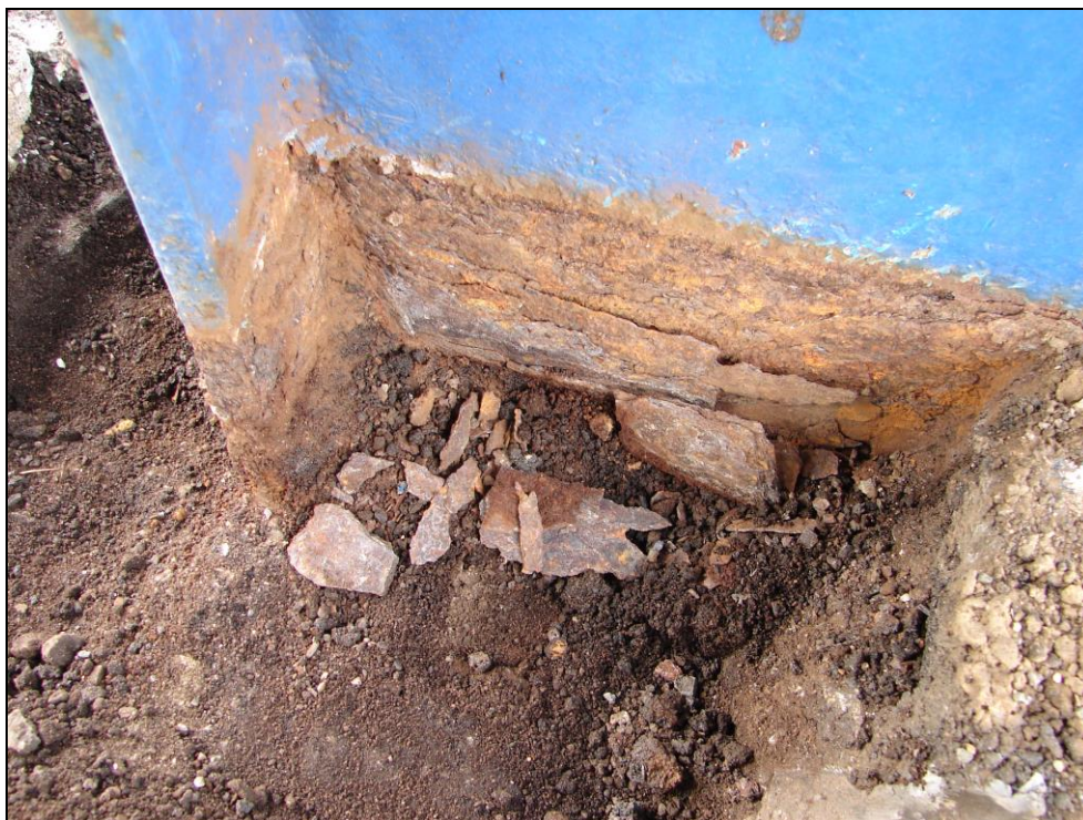
Obr. 42: Sloupy zastřešení nástupišť, 2. nástupišť, sloup 13; odlupování korozních zplodin (zejména ze stojiny průřezu), podrobně obr. 48
