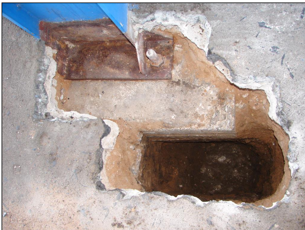
Obr. 67: Sloupy zastřešení nástupišť, 4. nástupiště, sloup 13; na dně sondy je patrný horní líc spodního stupně patky
