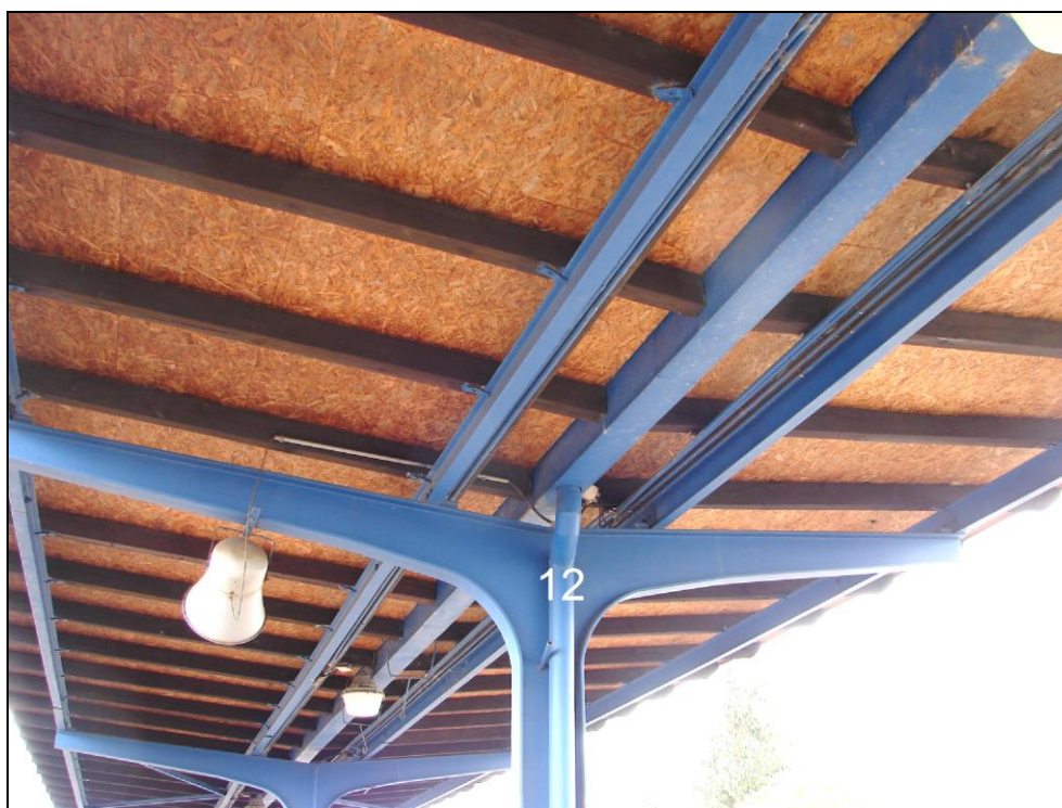
Foto 9: 2. nástupiště, ocelová konstrukce zastřešení v oblasti sloupu 12; bez zjevných známek zasažení koroze
