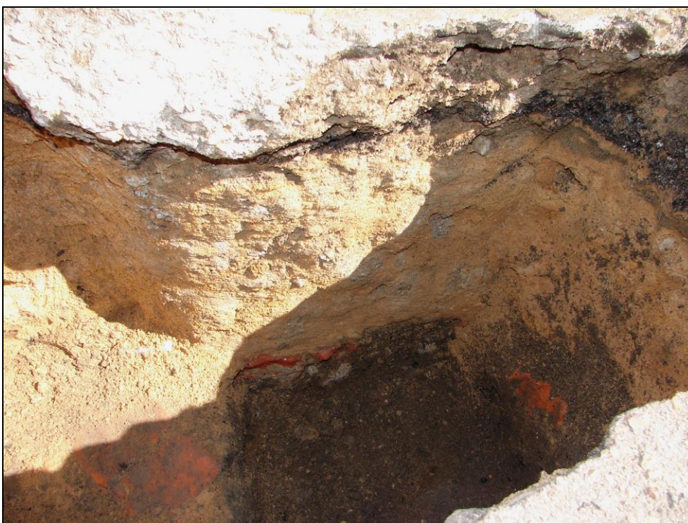
Obr. 20: Sloupy trakčního vedení, sloup 63; betonová patka sloupu betonovaná do výkopu, na dně sondy je patrna zemina
