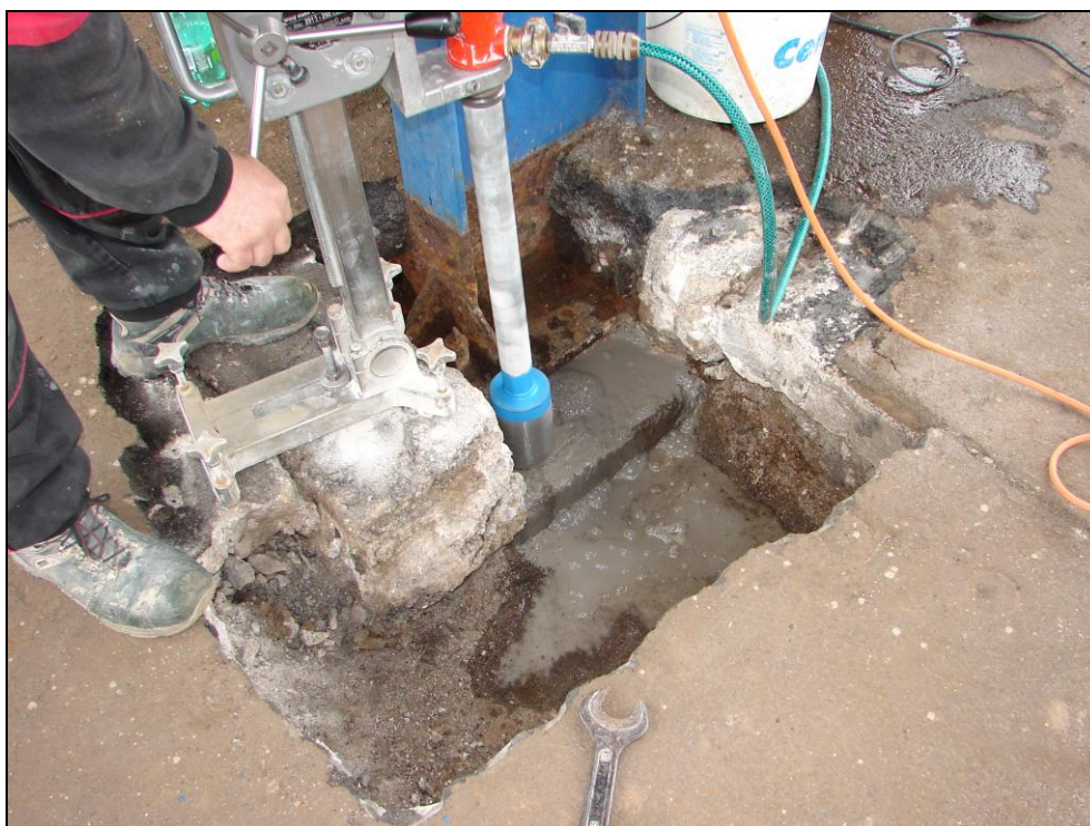
Obr. 49: Sloupy zastřešení nástupišť, 2. nástupiště, sloup 13; provádění jádrového vývrtu Ø 80 mm do patky pro zjištění hloubky založení, jádrový vývrt byl veden ve velmi mírném sklonu (cca 3°), jádrovým vývrtem byl zastižen boční líc patky u základové spáry (obr. 51), z toho lze usuzovat, že patka je jednostupňová
