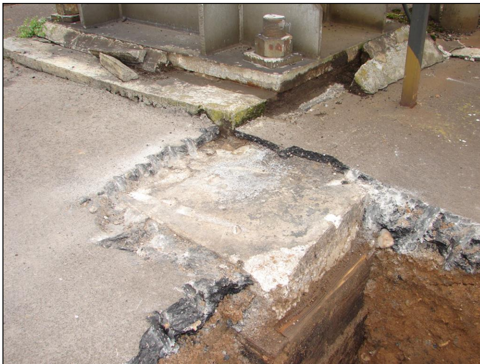
Obr. 7: Návěstidlo Lc1; pod patním plechem (jmenovité tl. cca 50 mm) je patka zvýšena o cca 70 mm (půdorys zvýšení 1200 x 1200 mm), patní plech má tvar obdélníka
