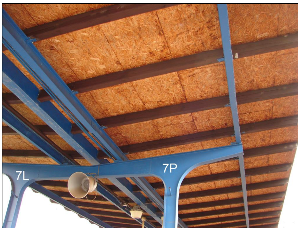
Foto 25: 4. nástupiště, ocelová konstrukce zastřešení v oblasti sloupů 7L a 7P; bez zjevných známek zasažení korozi
