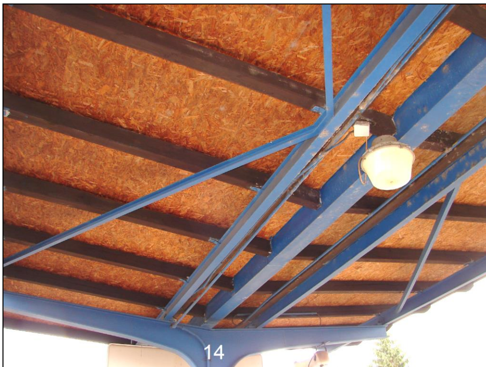
Foto 11: 2. nástupiště, ocelová konstrukce zastřešení v oblasti sloupu 14; lokální místa s počátkem povrchové koroze
