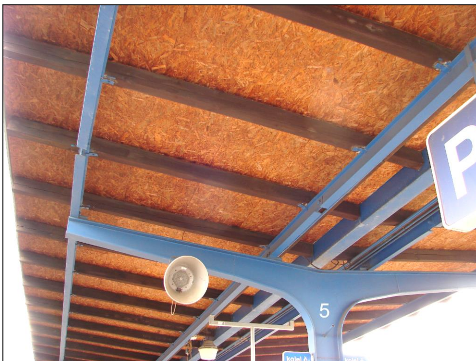
Foto 4: 2. nástupiště, ocelová konstrukce zastřešení v oblasti sloupu 5; bez zjevných známek zasažení koroze
