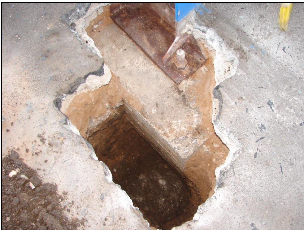
Obr. 68: Sloupy zastřešení nástupišť, 4. nástupiště, sloup 13; na dně sondy je patrný horní líc spodního stupně patky (pohled z jiného úhlu)
