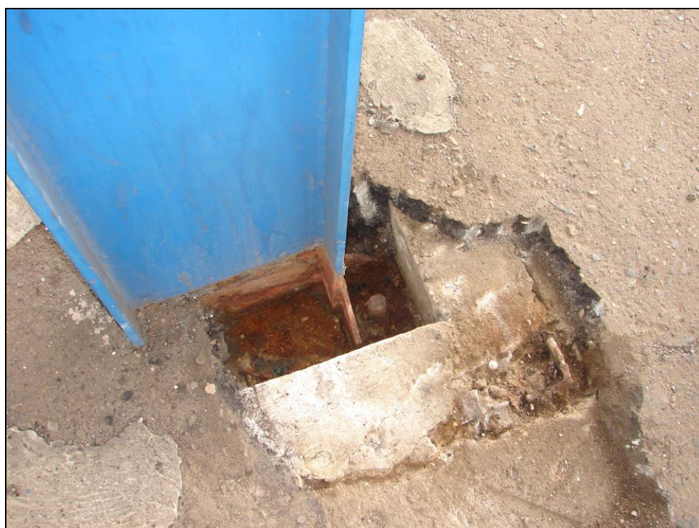
Obr. 55: Sloupy zastřešení nástupišť, 3. nástupiště, sloup 4; po odstranění živичného svršku je patrná betonová obruba, kotevní prvky sloupu byly zasypány pískem a zeminou (přirozeně vlhkou)
