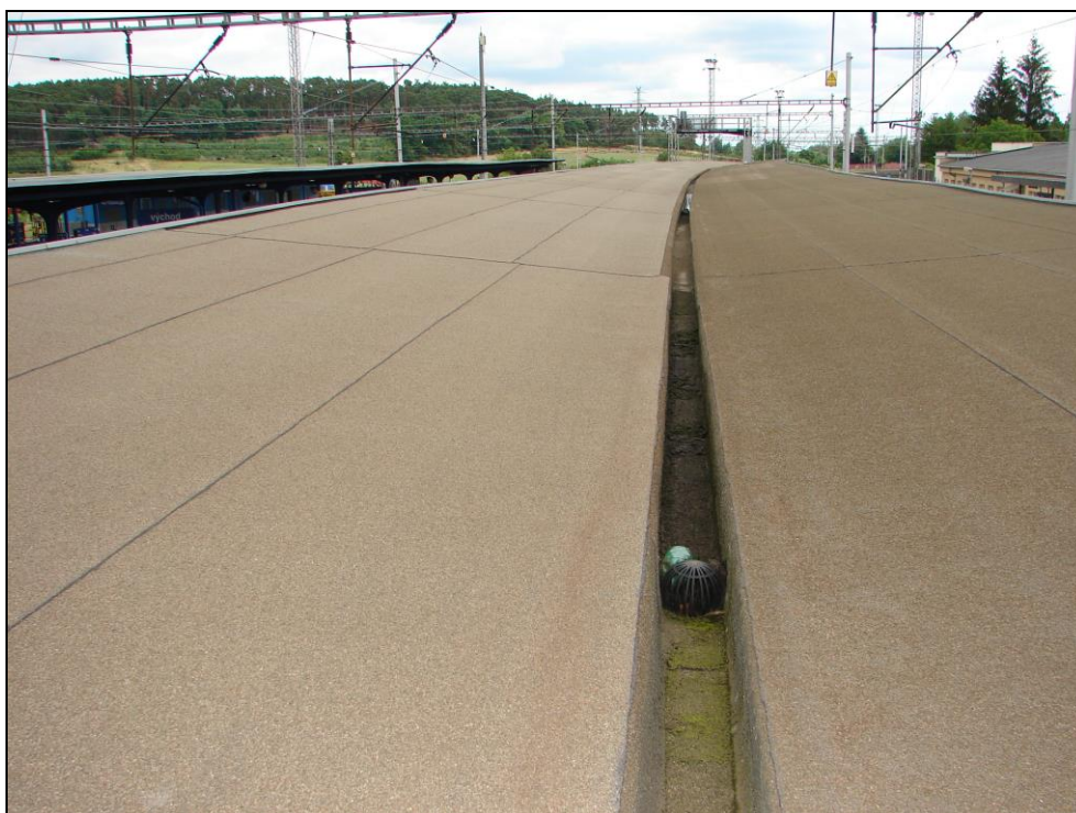
Foto 12: 2. nástupiště, střecha; středový okapní žlab, krytina asfaltové pásy, stejným způsobem je řešeno odvodnění zastřešení 4. nástupiště
