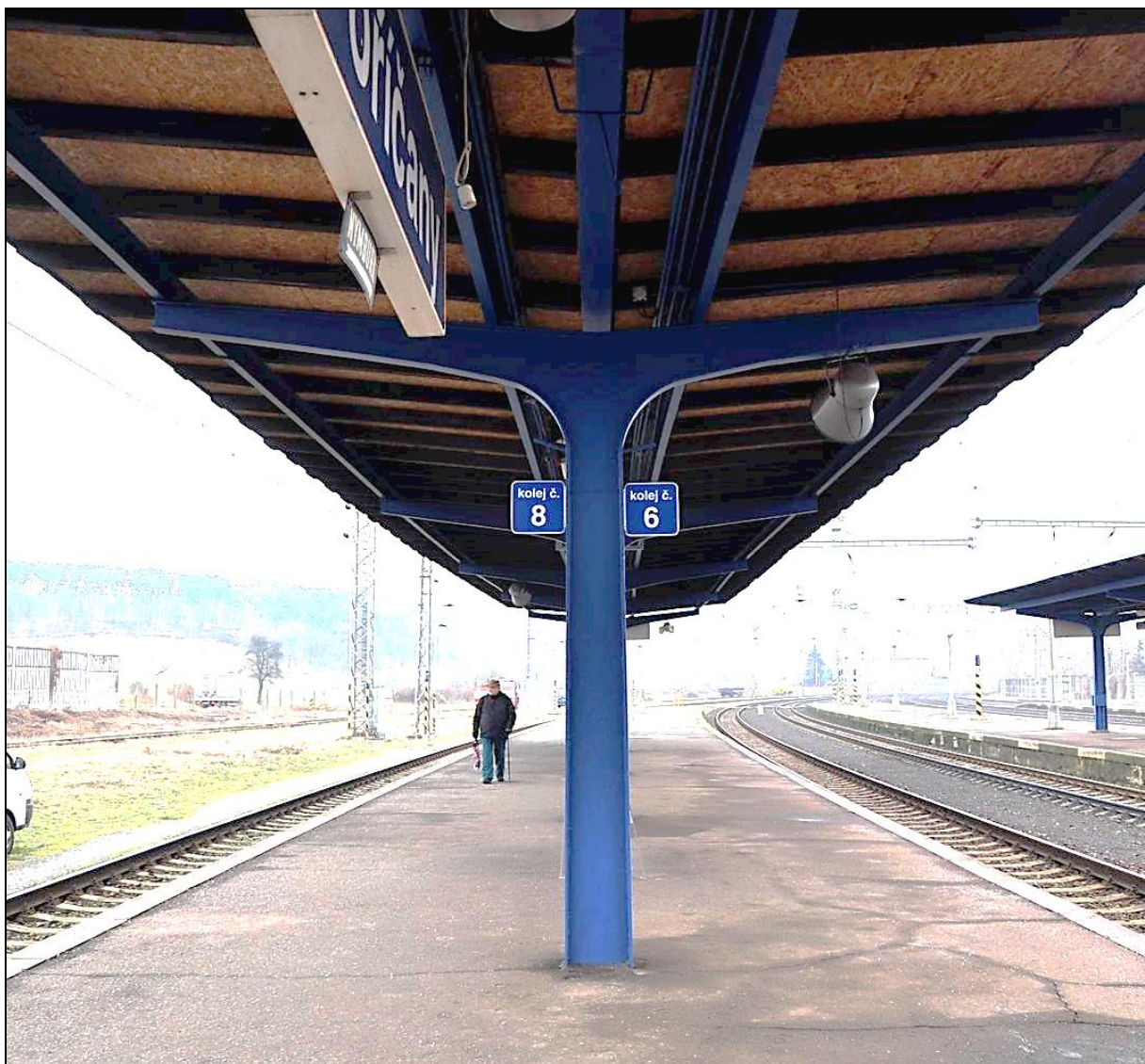
Obr. 34: Sloupy zastřešení nástupišť, kotvení sloupů; typický sloup zastřešení nástupiště
