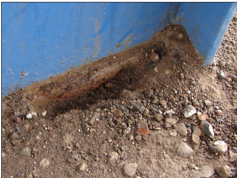
Obr. 53: Sloupy zastřešení nástupišť, 3. nástupiště, sloup 4; detail korozních zplodin z obr. 52
