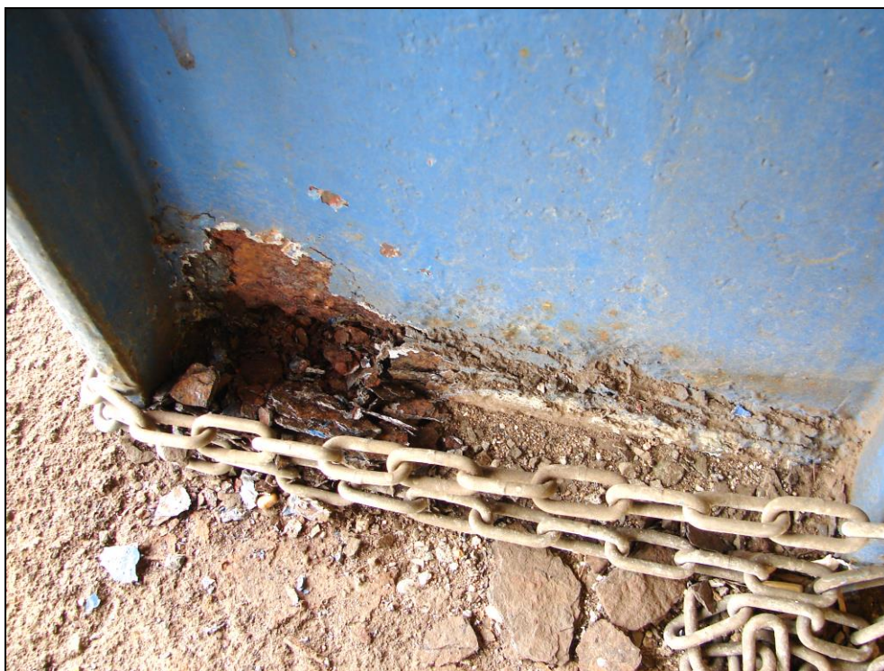
Foto 20: 3. nástupiště, sloup 11; zjevné korozní zplodiny v patě sloupu, lze očekávat korozní úbytky v oblasti kotvení
