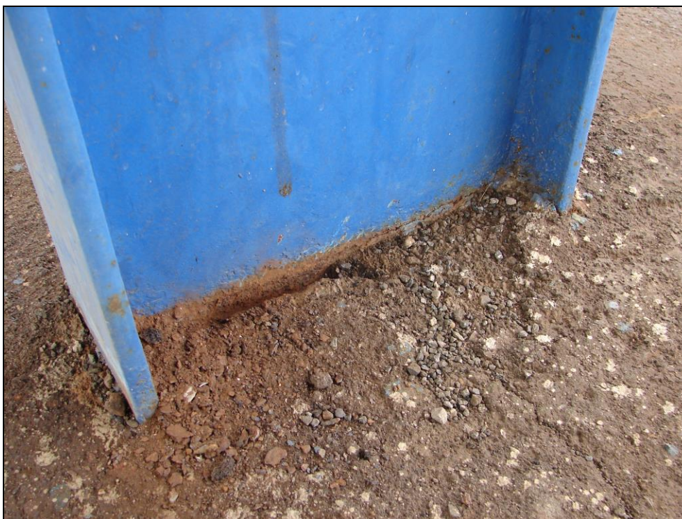
Foto 10: 2. nástupiště, sloup 13; zjevně patrné korozní zplodiny v patě sloupu, sondou zjištěny korozní úbytky v oblasti kotvení (Příloha 3)
