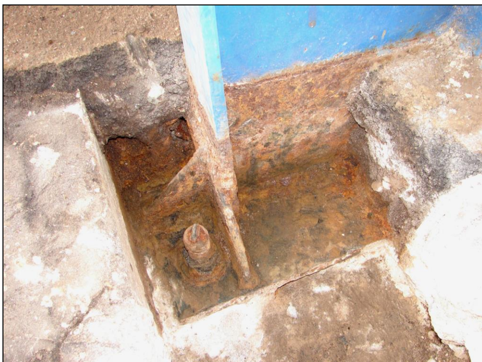
Obr. 48: Sloupy zastřešení nástupišť, 2. nástupiště, sloup 13; korozní úbytky tloušťek plechů (obr. 35): stojina sloupu 1 - 3 mm*; pásnice, výztuhy a patní plech 0,5 - 1 mm
