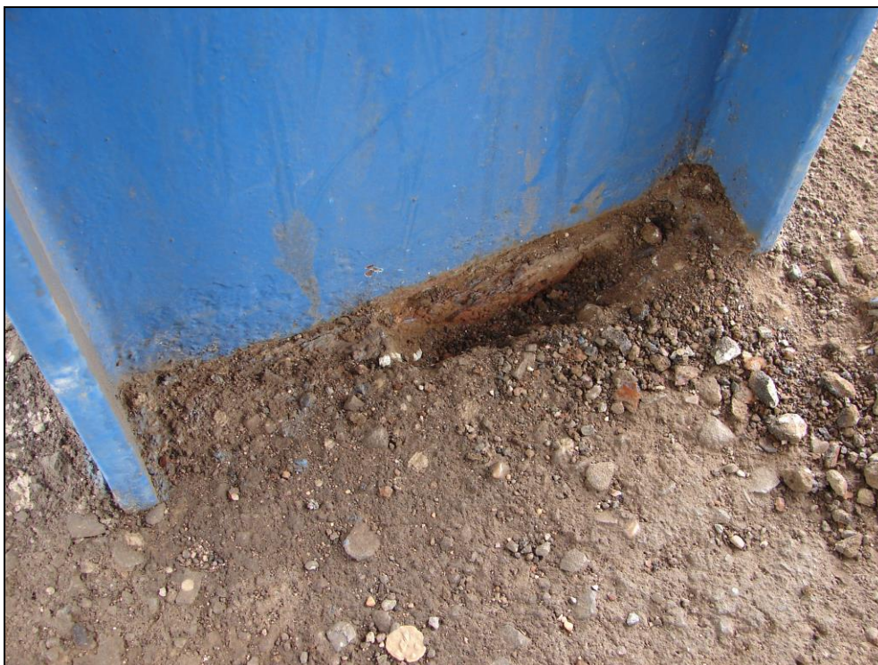
Foto 15: 3. nástupiště, sloup 4; zjevně patrné korozní zplodiny v patě sloupu, sondou zjištěny korozní úbytky v oblasti kotvení (Příloha 3)
