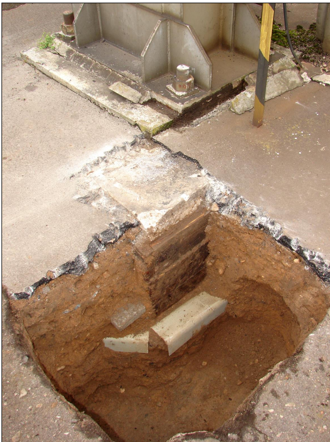
Obr. 6: Návestidlo Lc1; na dně kopané sondy je patrný horní líc spodního stupně patky, na bočním líci horního stupně patky je patrné šalování z prken, sondou zastiženy chráničky (pravděpodobně kabelu)
