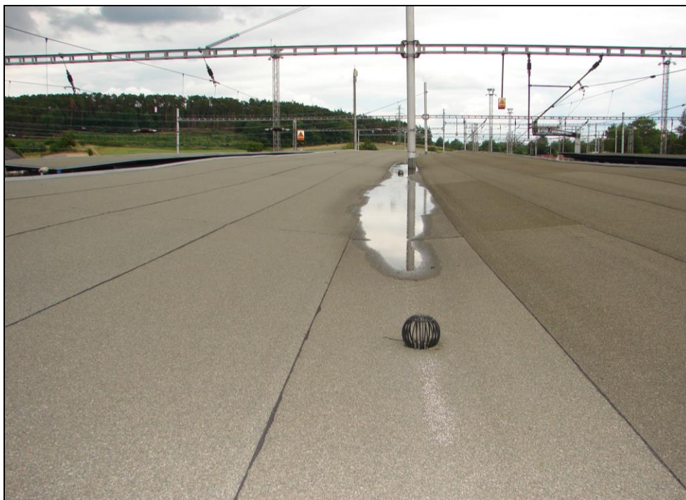
Foto 22: 3. nástupiště, střecha; není středový okapní žlab (pouze úžlabí), krytina asfaltové pásy
