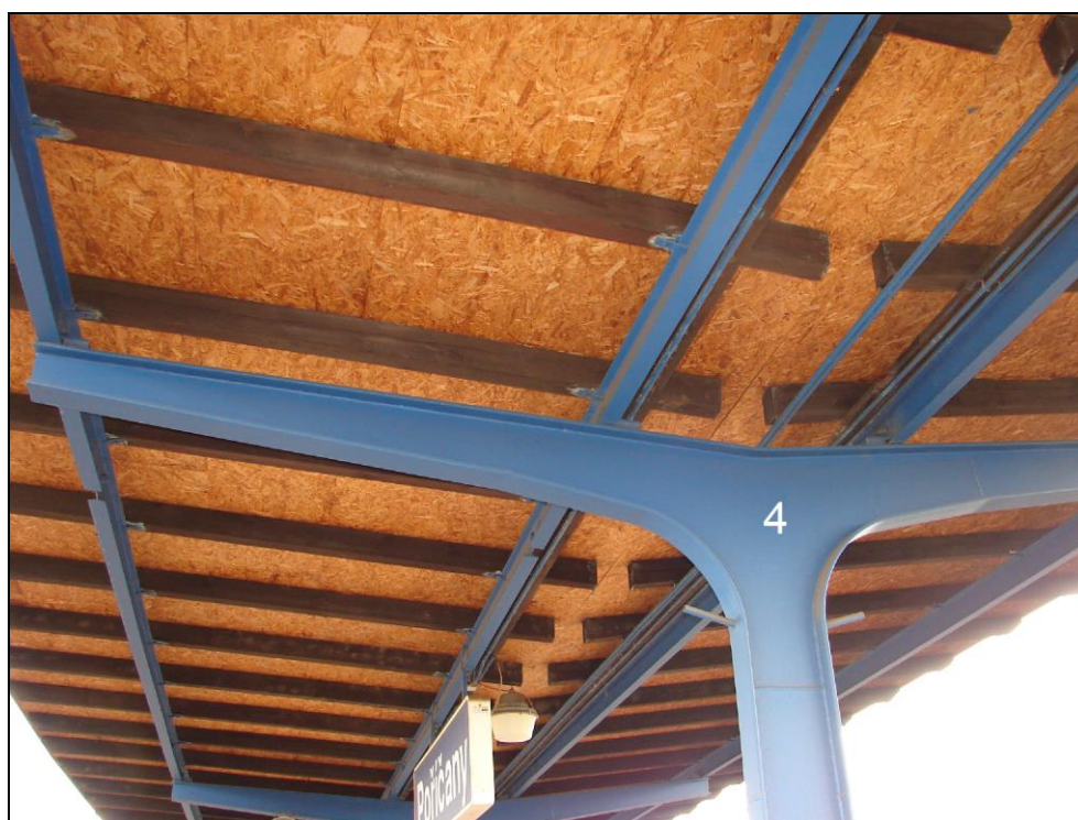
Foto 14: 3. nástupiště, ocelová konstrukce zastřešení v oblasti sloupu 4; bez zjevných známek zasažení korozí
