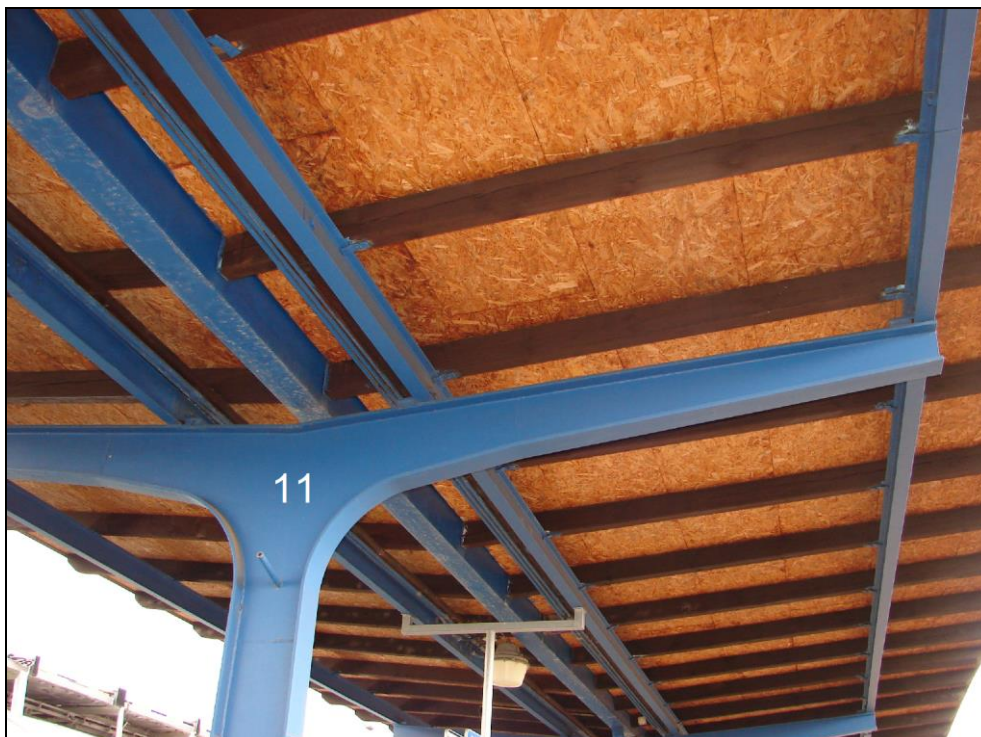
Foto 27: 4. nástupiště, ocelová konstrukce zastřešení v oblasti sloupu 11; bez zjevných známek zasažení korozi
