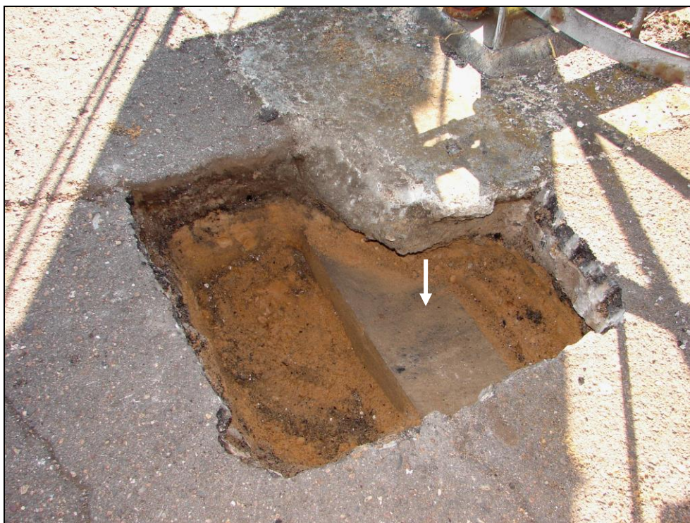
Obr. 18: Sloupy trakčního vedení, sloup 63; vedení sítí kryté betonovou chráničkou zastižené v místě vyznačeném na obr. 17 bílou šipkou (zásyp proveden pískem)
