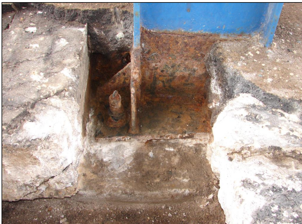
Obr. 47: Sloupy zastřešení nástupišť, 2. nástupiště, sloup 13; pohled na základovou patku a způsob kotvení sloupu z jiného úhlu
