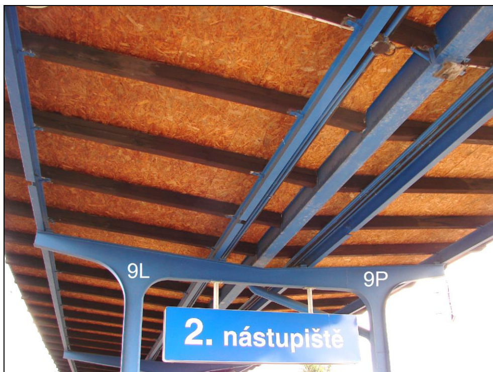
Foto 7: 2. nástupiště, ocelová konstrukce zastřešení v oblasti sloupů 9L a 9P; bez zjevných známek zasažení korozi
