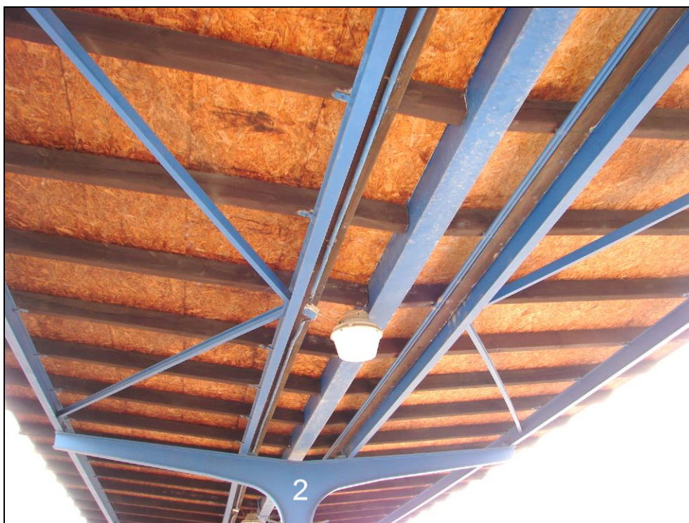
Foto 2: 2. nástupiště, ocelová konstrukce zastřešení v oblasti sloupu 2; bez zjevných známek zasažení korozí
