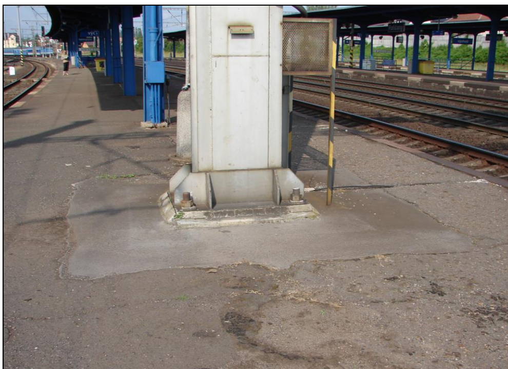
Obr. 2: Návěstidlo Lc1; pata návěstidla, stav před zahájením prací (pohled směrem k Praze)
