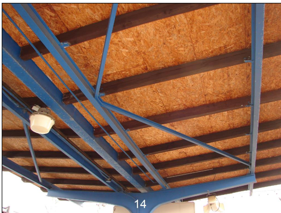
Foto 29: 4. nástupiště, ocelová konstrukce zastřešení v oblasti sloupu 14; bez zjevných známek zasažení korozi
