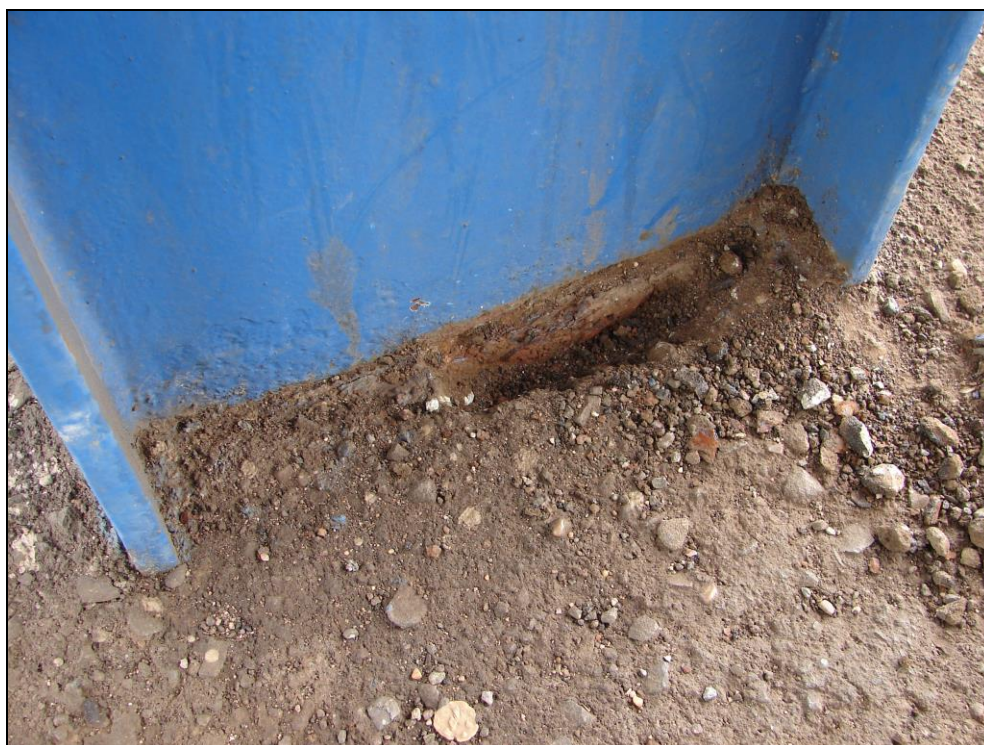
Obr. 52: Sloupy zastřešení nástupišť, 3. nástupiště, sloup 4; korozní zplodiny tl. cca 15 mm v oblasti stojiny sloupu, zplodiny byly vizuálně patrné bez proškrábnutí svršku nástupiště
