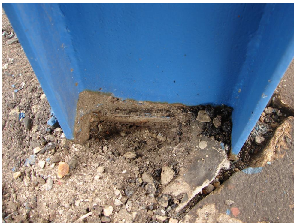
Foto 24: 4. nástupiště, sloup 6L; zjevně patrné korozní zplodiny v patě sloupu, lze očekávat korozní úbytky v oblasti kotvení
