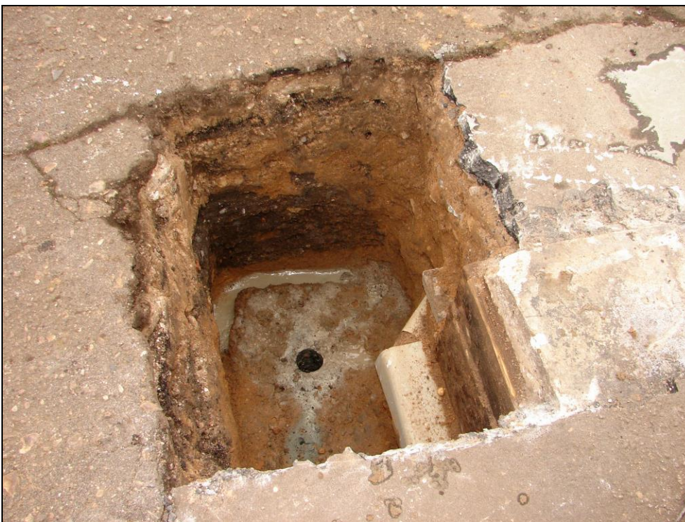
Obr. 10: Návestidlo Lc1; patka po ukončení jádrového vývrtu
