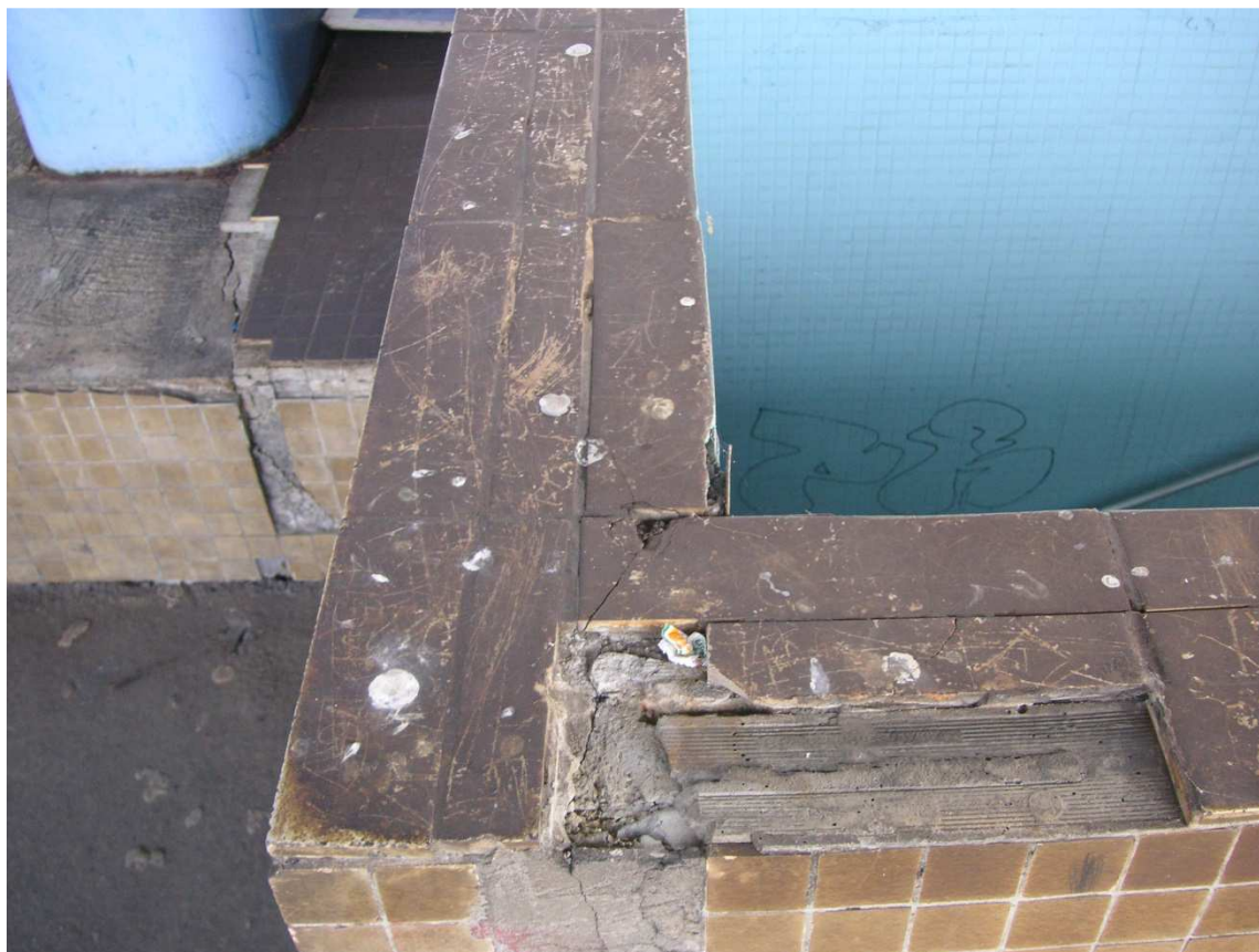
Obr. č. 7 Poškození obkladu a poruchy u schodišťových zdí na nástupišti
