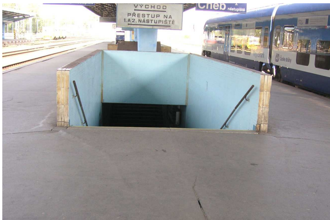
Obr. č. 8 Oklady u schodišťových zdí na nástupišti nejsou na všech plochách shodné.
