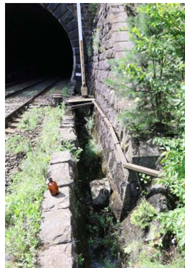
Stávající stav příkopových zídek v předportálových prostorech
